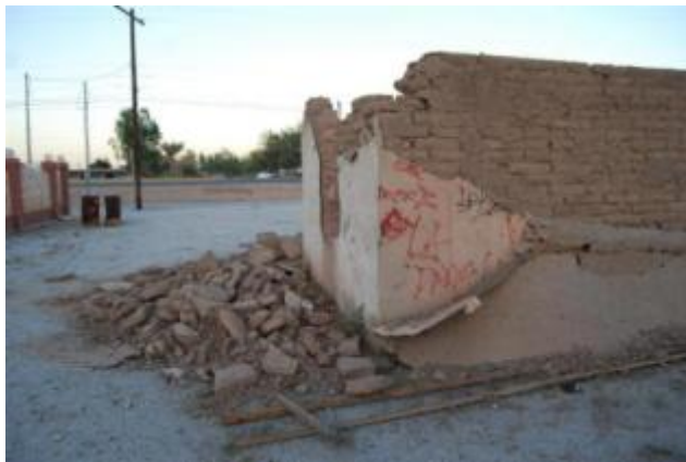
Todos los inmuebles dañados tenían fallas de diseño, de construcción o habían sido alterados
