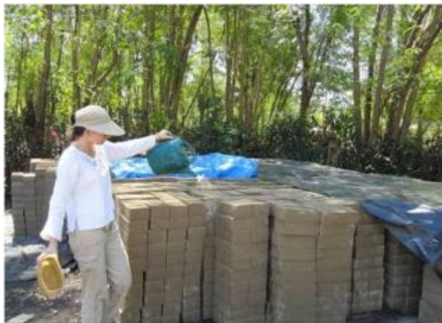
Curado de los bloques
