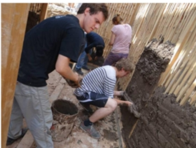
Visita a obra en quincha (Seminario Construcción 1 Ciclo 2013-1)
