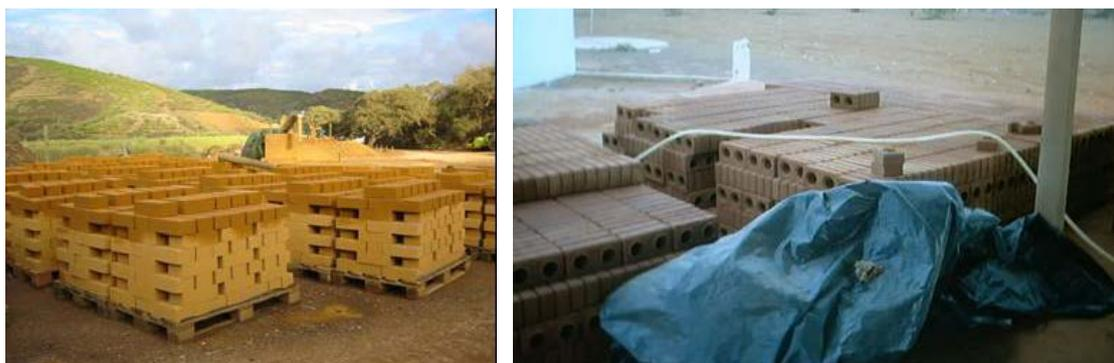
Figura 6 – Armazenamento dos BTC
