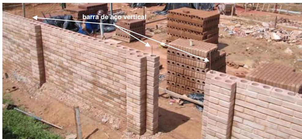
Figura 8 – Alvenaria de BTC com furos e junta de argamassa, notando-se as barras de aço verticais, para reforço da parede
