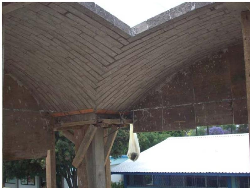
Figura 1 – Exemplo de abóbada de adobe, em execução
