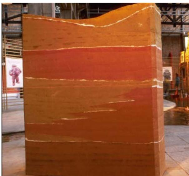
Figura 10 – Painel de taipa com diferentes cores de terra
