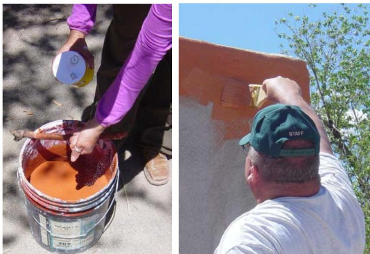
Figura 9 – Adição de fixador à cal pigmentada e aplicação da pintura na parede preparada
