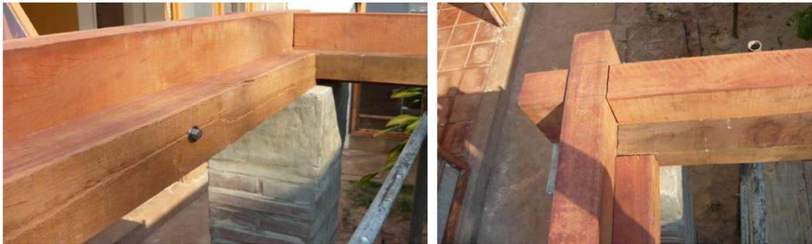
Figura 4 – Detalhes de um exemplo das vigas de início de uma abóbada
