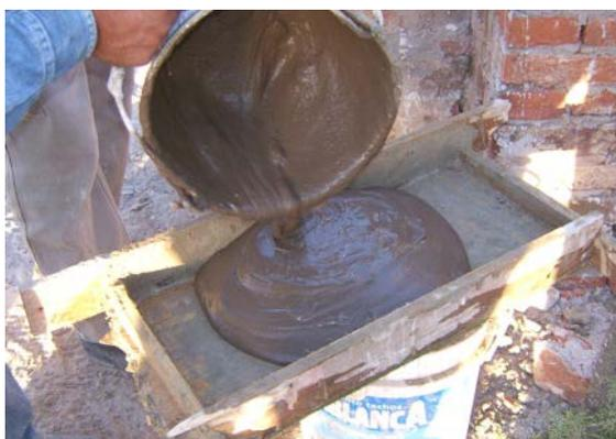
Figura 2 – Consistência da argamassa de assentamento
