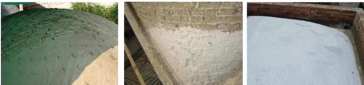
Figura 14 – Abóbada com leitada de cal e areia
