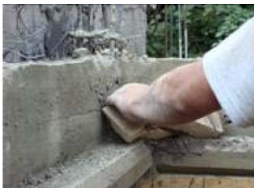
Figura 8 - Assentamento da segunda fiada de BTC
