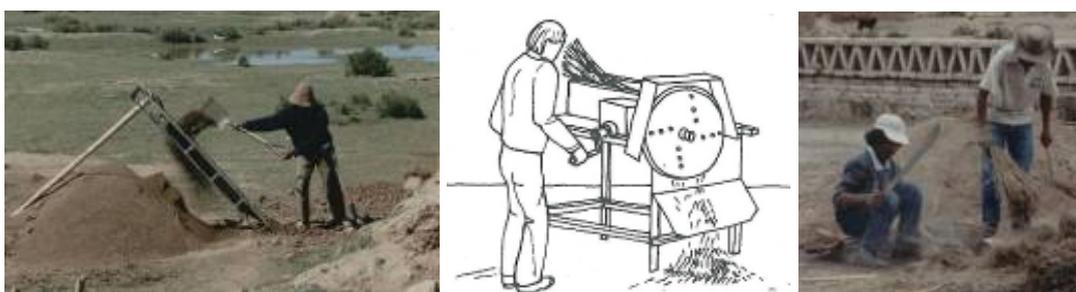
Figura 3 – Peneiramento da terra; tritramento mecânico e corte manual das fibras vegetais
