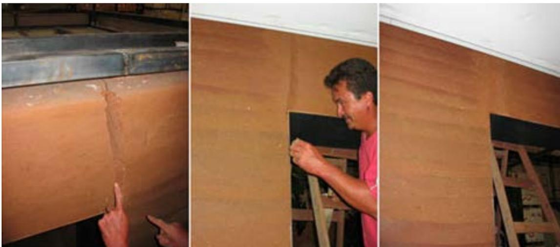
Figura 9 - Consolidação de trinca em painel monolítico
