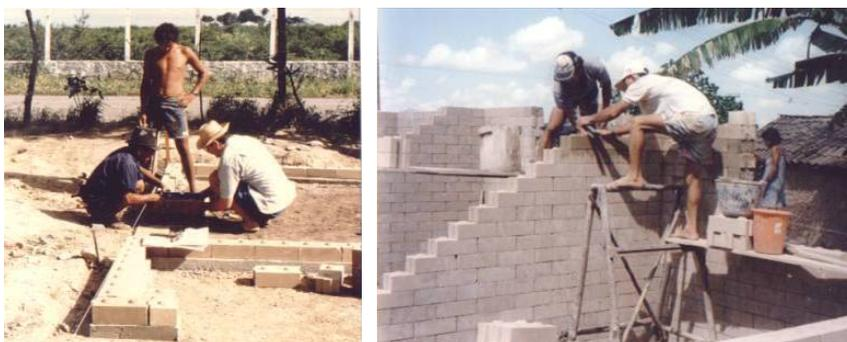
Figura 7 – Elevação de paredes com BTCs
