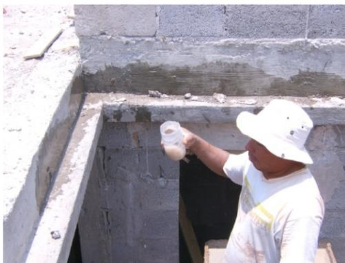
Figura 6 - Umedecimento da área de contato do BTC
