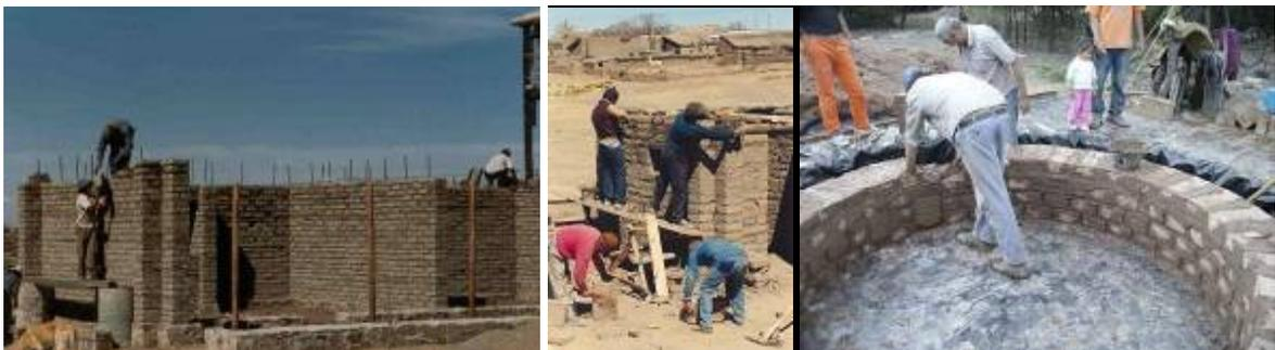
Figura 8 – Construcción de paredes de adobe (Rotondaro et al, 1998; 2009)
