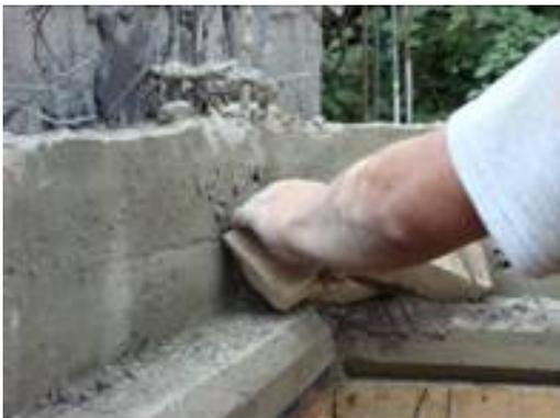
Figura 8 – Colocación de la segunda hilada de BTC
