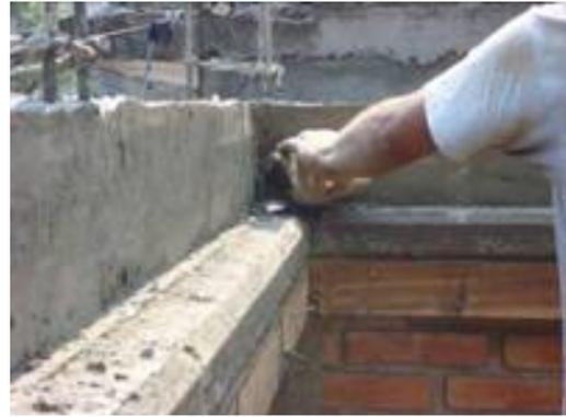
Figura 7 – Colocación del primer BTC
