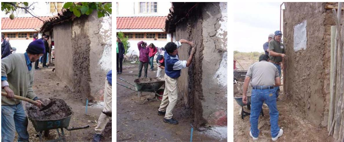
Figura 3 – Mezcla para revoque inicial de barro; aplicación del revoque a mano; aplicación del revoque con cuchara
