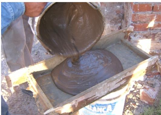
Figura 2 – Consistencia del mortero de colocación del BTC
