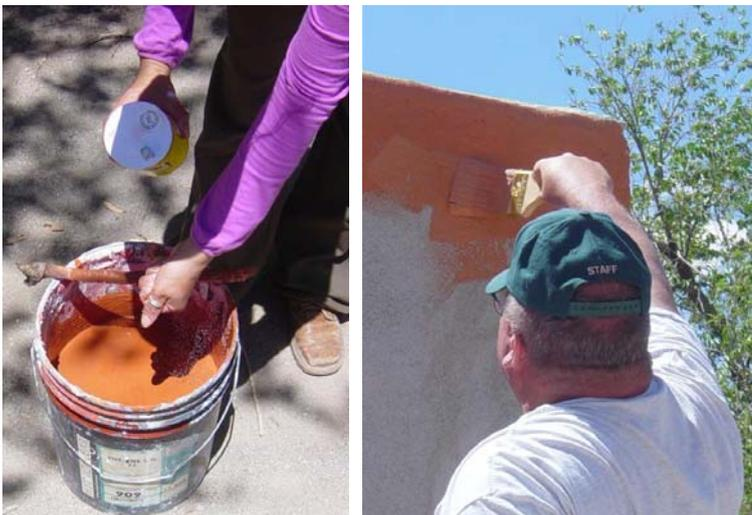
Figura 9 – Agregado de sal a la cal pigmentada y aplicación de la pintura en la pared preparada
