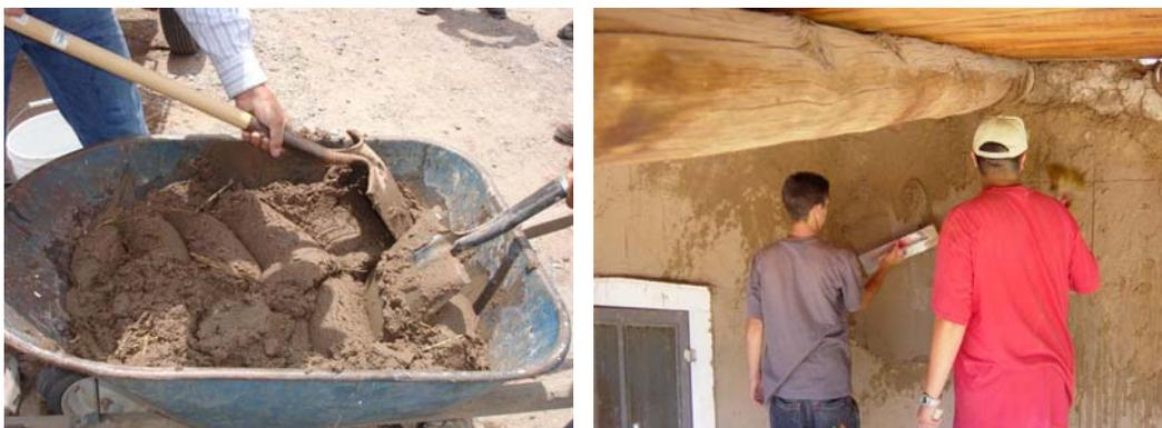
Figura 4 - Mezcla para revoque final de barro y su aplicación con la llana
