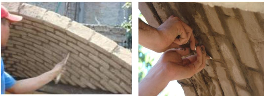
Figura 12 –Proceso de limpieza de las juntas de colocación, superficie y esquinas de la bóveda
