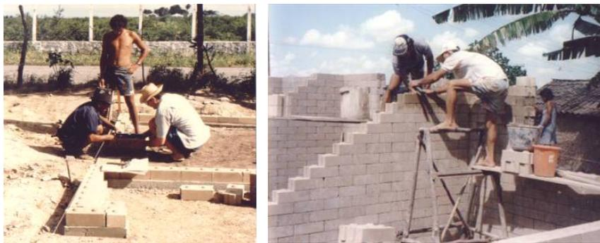
Figura 7 – Ejecución de paredes con BTCs
