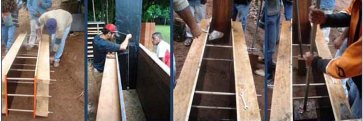
Figura 16 – Acciones para montar y aplomar el molde, desparramar y compactar la tierra
