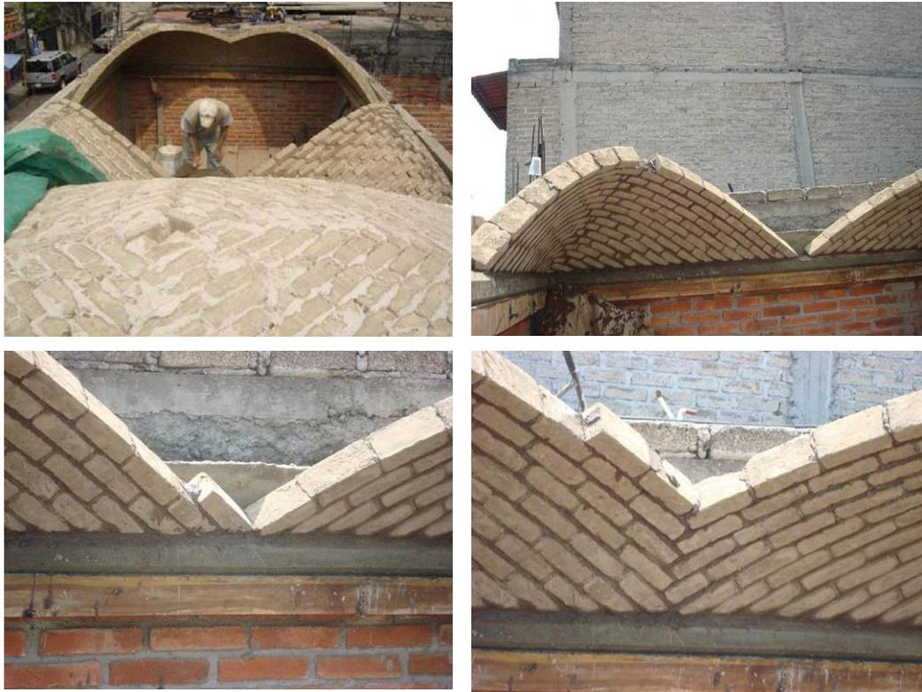
Figura 11 – Término de pechinas y cuatraneo de BTC para iniciar cerramiento de bóveda
