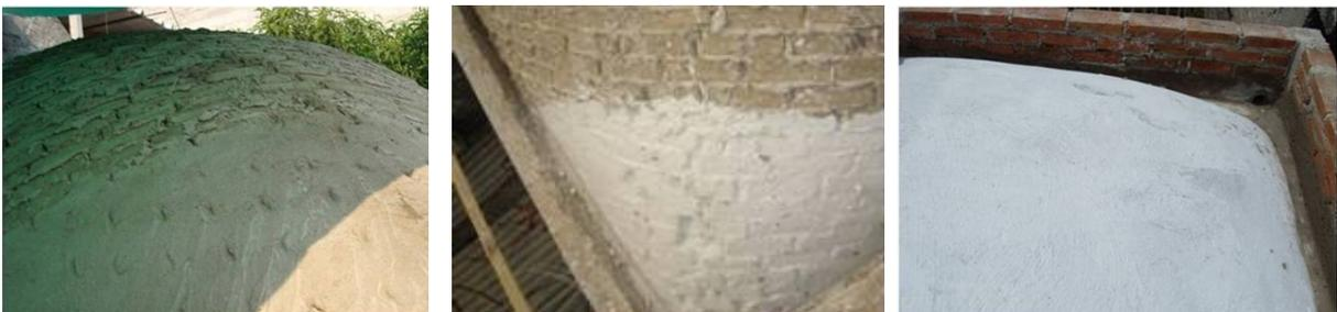
Figura 14 – Bóveda con lechada de cal y arena
