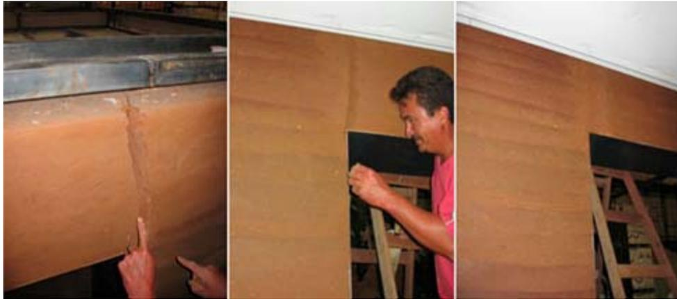
Figura 9 - Consolidación de grietas en el panel monolítico
