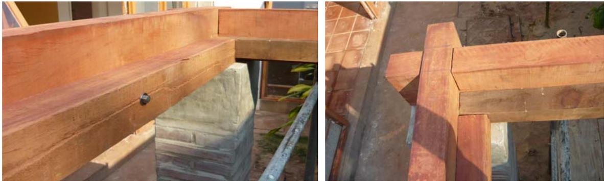
Figura 4 – Detalles de las vigas de inicio de una bóveda
