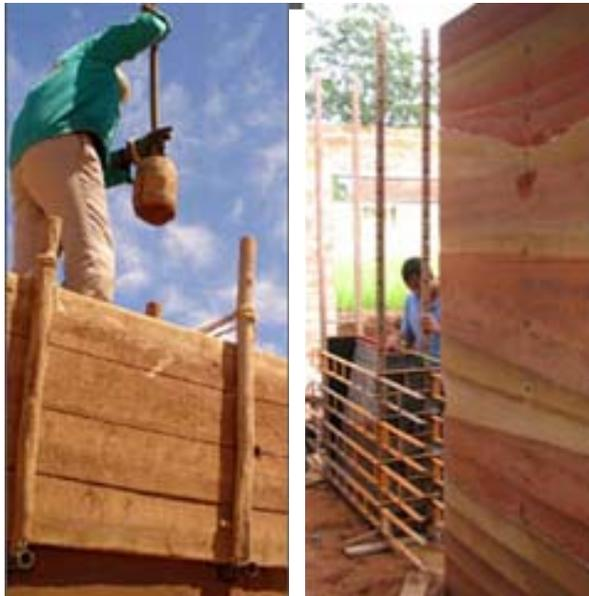
Figura 2 – Dos tipos de moldes para ejecución de la tapia: tapial tradicional (a la izquierda) y tapial metálico
