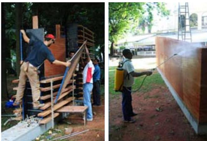
Figura 17 – Desmontaje y curado del panel de tapia estabilizada con cemento
