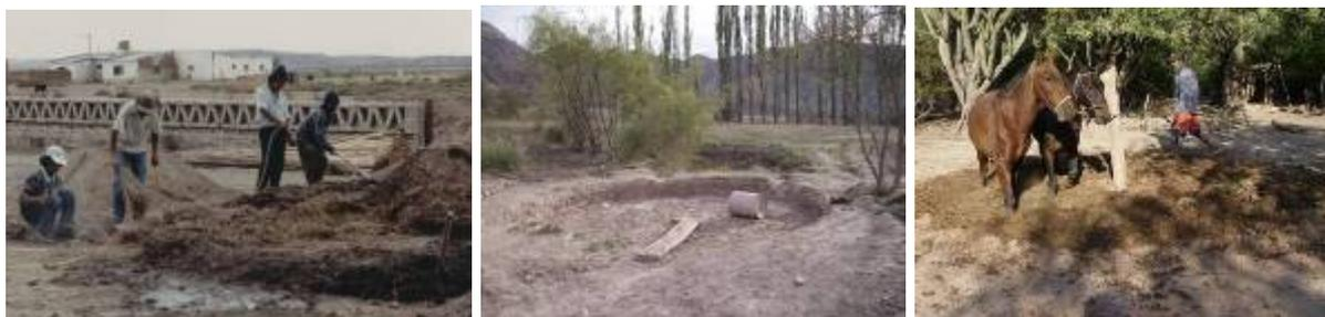
Figura 4 – Distintas formas de preparación del barro
