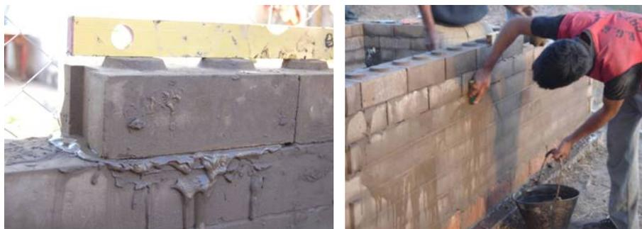
Figura 9 – Albañilería de bloque Mattone con mortero fluido y limpieza de la superficie
