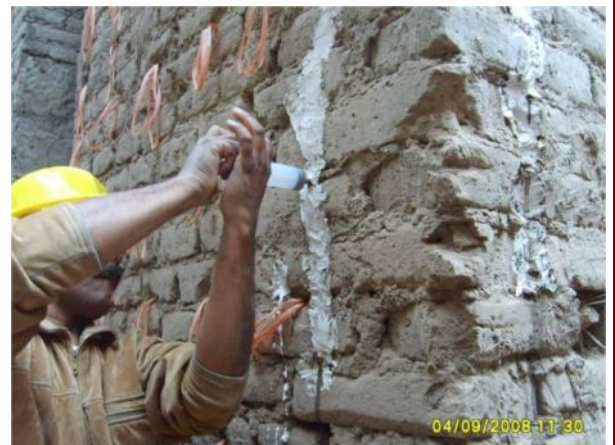
Figura 3. Reparación por inyección de grout de suelo tamizado diluido en agua, con sello de yeso, en una casona monumental de Barranco, Lima. Conservadores Sofia Rodríguez (Arquitecta) y Julio Vargas N. (Ingeniero)
