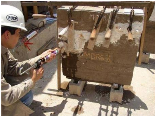
Figura 1. Reparación de muretes con grout de suelo: inyección de murete. Laboratorio de Estructuras, PUCP. Investigadores Julio Vargas y Marcial Blondet.
