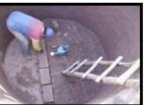
Vistas de la obra de muros, piso y primer revoque
