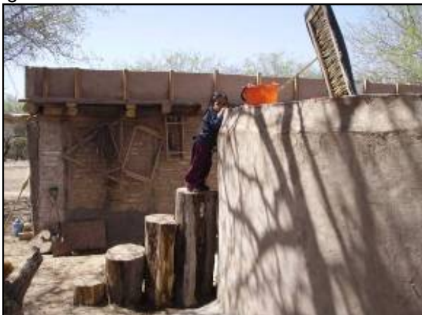
Vista de la tapa y la puerta del aljibe
