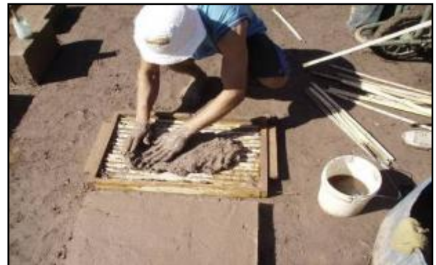
Fabricación de 60 placas de quincha (caña y barro)
