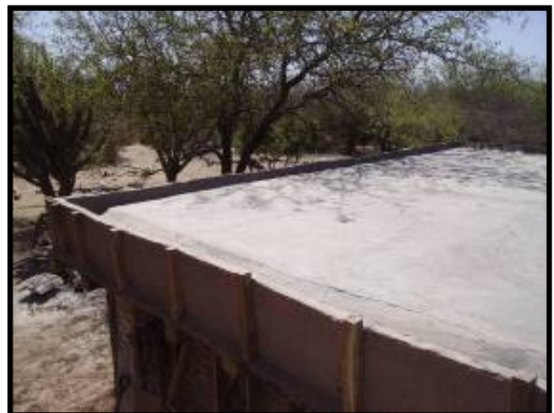
Vistas de la terminación del techo y sus bordes
