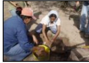
Fabricación del barro para los adobes (pisadero)
