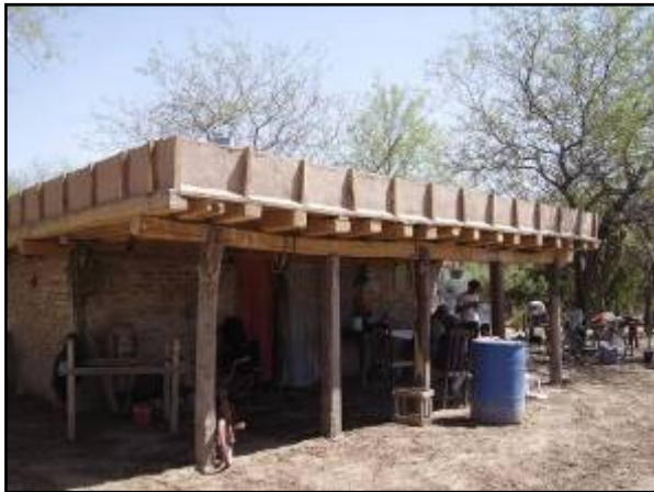
Vista general del sistema construido
