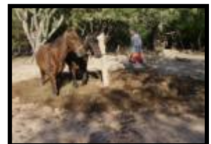
Fabricación del barro para los adobes (pisadero)
