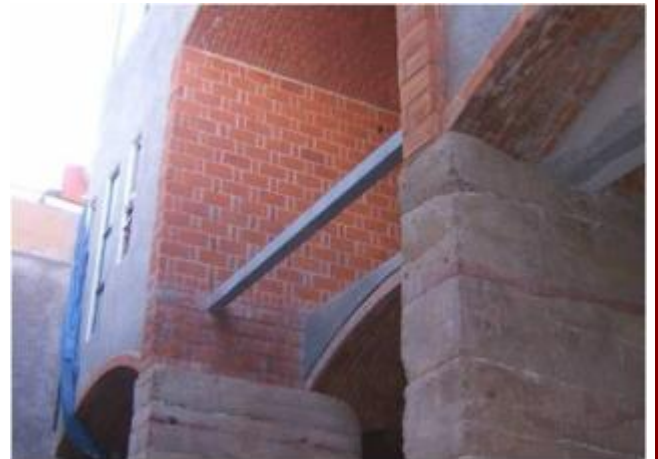
Vista posterior de la doble altura
