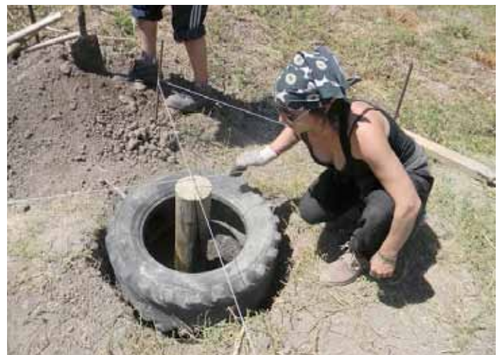
Ejecución de fundaciones con neumáticos
