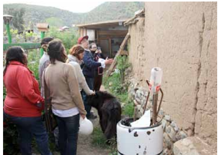
Diagnóstico de vivienda en adobe. Foto: ECoT.
