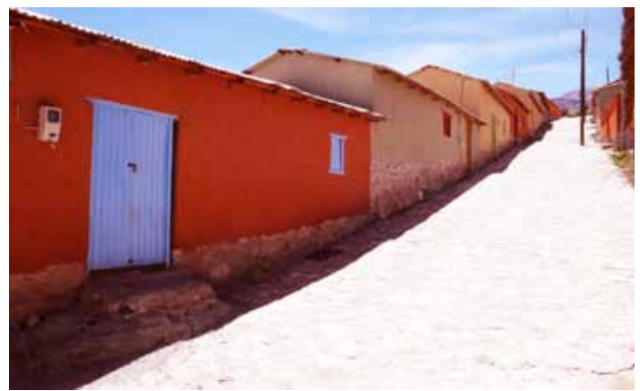
Fachadas restauradas. Foto: Camilo Giribas, 2016
