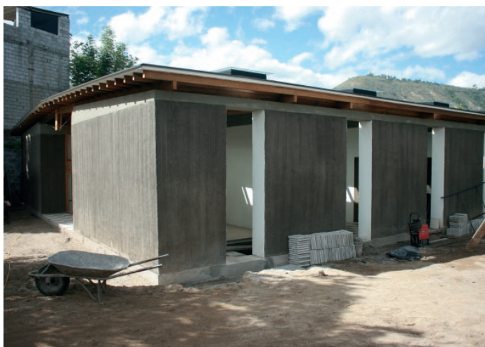
Casa Patch en fase de construcción.
