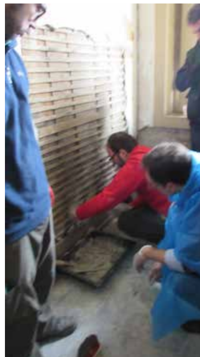
Oficina Prática de Rebocos e Argamassas Tradicionais Formador Ivo Ferin
