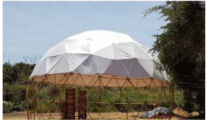
Figura 3 - Geodésica de bambu, na qual foram realizadas as oficinas de adobe, BTC e técnica mista (foto de Regis A. G. Filho)
