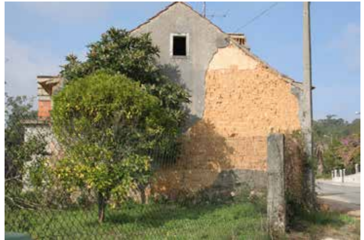
PConstrução com alvenaria de adobe na zona de Leiria
