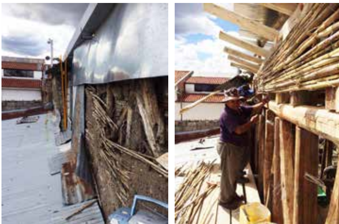
Pared medianera de bahareque antes de consolidar y durante la intervención (Créditos: Lourdes Abad)
