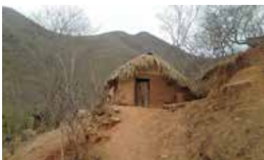
Foto de portada: Esvin Mayor Casa de bajareque en la Aldea el Chanrayo, Guatemala.
