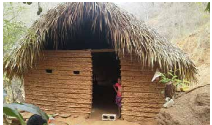
Casa de bajareque en la Aldea el Chanrayo, Municipio de San Agustín Acasaguastlán, Departamento de El Progreso, Guatemala (Créditos: Esvin Mayor)
