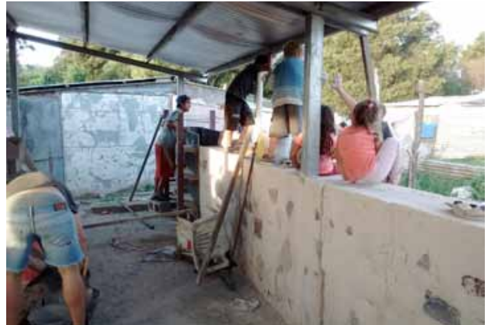
Fig.3. Muro de tierra vertida en Nuevo Golf, Mar del Plata
