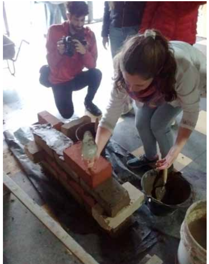
Fig.2. Construcción de murete de BTC con los alumnos
