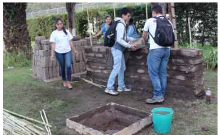
Construcción muro de adobe.
