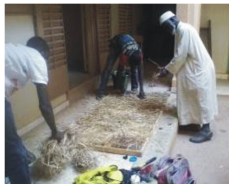
Estructura del panel en madera (marco) relleno total en paja, con malla + acabado de capa recubierta con tierra: preparación del marco, relleno con paja y cierre en ambos lados con malla
