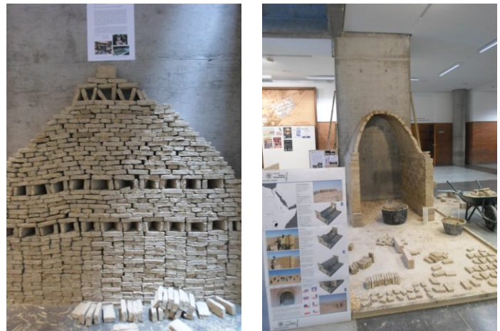
Figura 1.- Acopio de los adobes fabricados en los talleres. Figura 2.- Proceso de construcción de la bóveda Nubia PCUD/20153191 (Créditos de fotos: Félix Jové).
