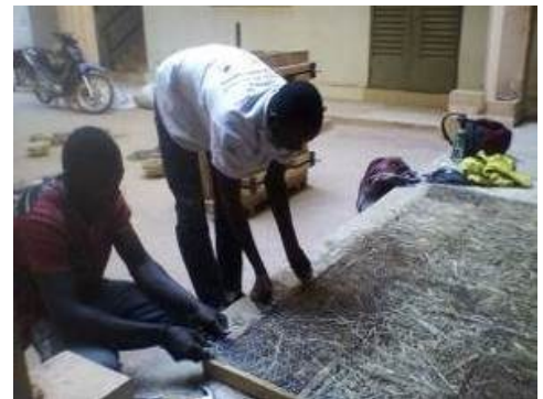
Estructura del panel en madera (marco) relleno total en paja, con malla + acabado de capa recubierta con tierra: preparación del marco, relleno con paja y cierre en ambos lados con malla
