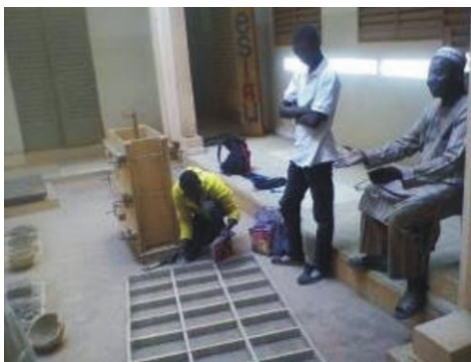
Estructura del panel en madera (marco) relleno total en paja, con malla + acabado de capa recubierta con tierra: preparación del marco, relleno con paja y cierre en ambos lados con malla
