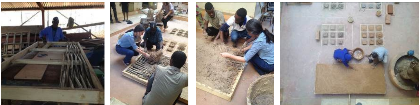
Panel en estructura de madera (estructura de bambú) relleno de tierra, madera de corteza, acabado recubierto con tierra + polvo de maíz: preparación de la estructura de bambú y marco de 10 cm de espesor x 2.50 m de largo, aplicación de corteza y paja para aligerar la estructura, aplicación de la primera capa de arcilla / arcilla (arcilla + salvado + paja y aplicación de la capa superior recubierta de arena + arcilla tamizada de 2 mm
