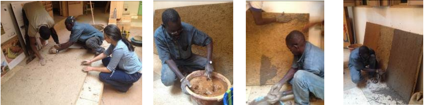
Estructura del panel en madera (marco) relleno total en paja, con malla + acabado de capa recubierta con tierra: aplicación primera capa: arcilla + salvado de maíz + paja cortada, mezcla de arcilla + arena fina, panel con dos tipos de tierra (tierra negra + tierra amarilla) y aplicación segunda capa de arcilla tamizada Ø 2 mm
