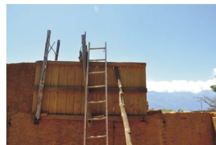
Foto de portada: Natalia Rey Cuellar, 2018 Muro de tapia en construcción, Barichara (Colombia)
