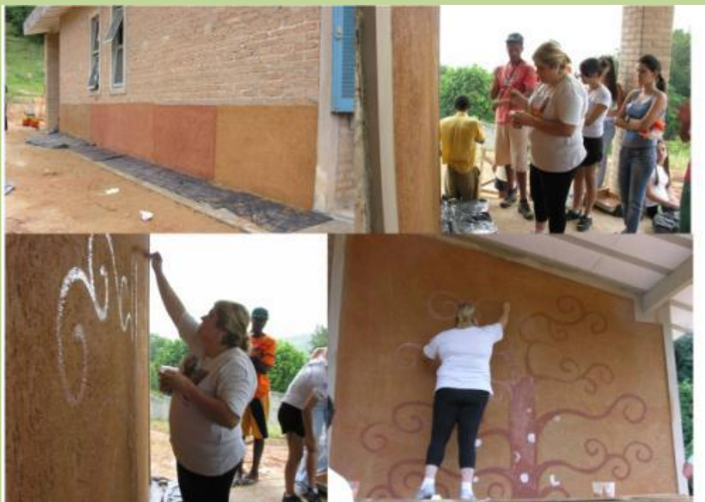
Conclusão pintura da barra de proteção dos BTCs na lateral da casa.
