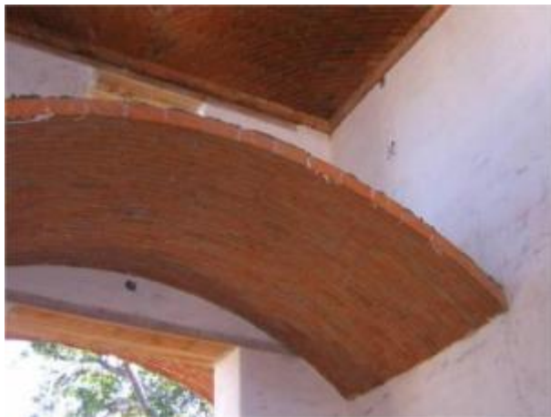
Bóveda de entrepiso
