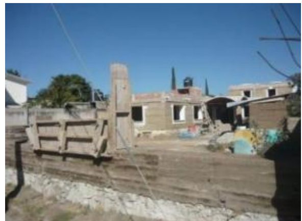
Proceso de encofrado de los muros de tapia
