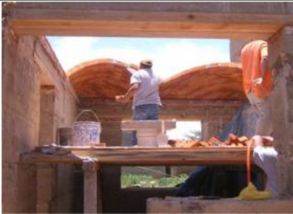
Arranque de bóvedas
