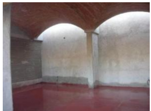
"Piso sano" de cal con pigmento y muros encalados.
