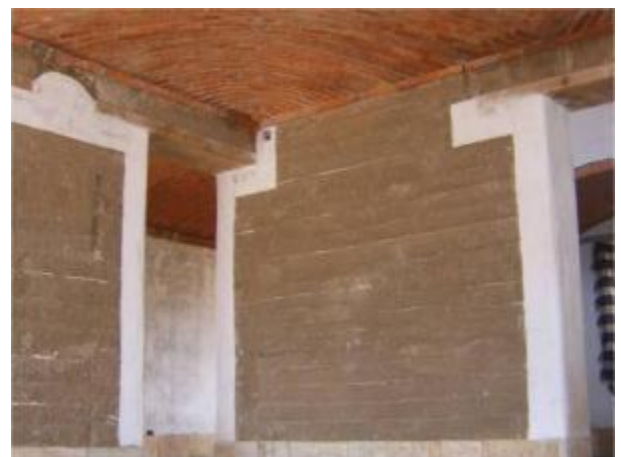
Muros de tapia encalados en sus aristas y sellados con mucilago de nopal.
