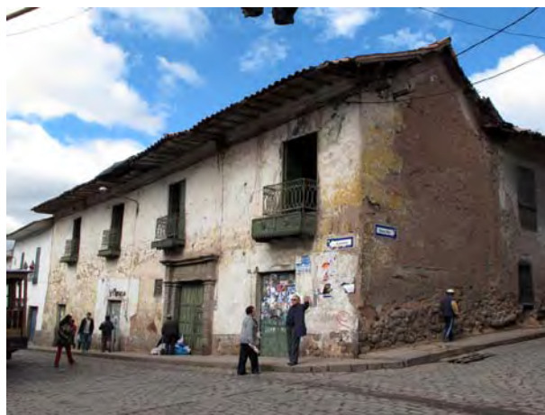
Segunda edificación prototipo: Casona de adobe en el primer y segundo piso, en esquina y con techo de "Par y Nudillo". Casa Arones, ubicada en el Centro Histórico del Cusco © J. Paul Getty Trust
