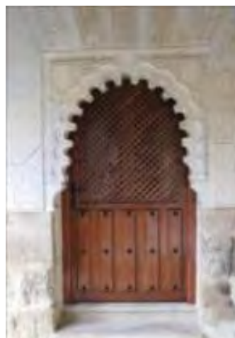
Yeserías de tradición musulmana en el Convento adyacente al Palacio de Astudillo
