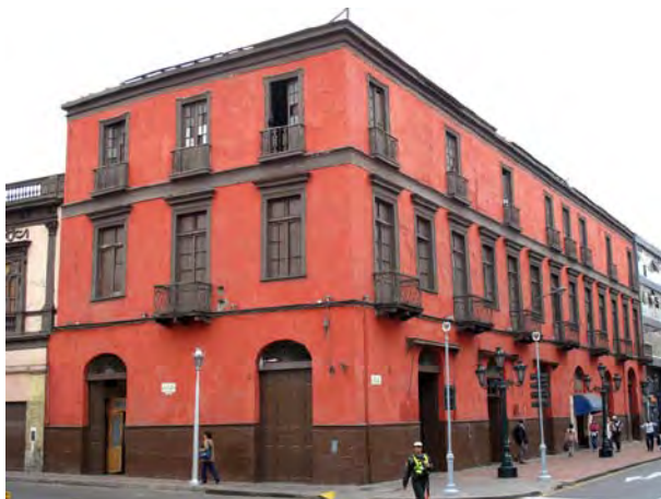
Primera edificación prototipo: Casona en esquina, de adobe en el primer piso y "Quincha" en el segundo. Hotel El Comercio, ubicado en el Centro Histórico de Lima
