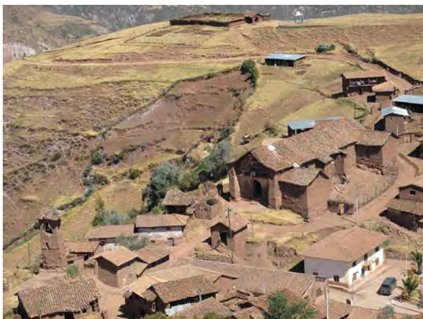
Cuarta edificación prototipo: Iglesia no intervenida de muros y contrafuertes de adobe y con techo de "Par y Nudillo". Iglesia Santiago Apóstol en Kuño Tambo, ubicada en las afueras de la ciudad del Cusco © J. Paul Getty Trust
