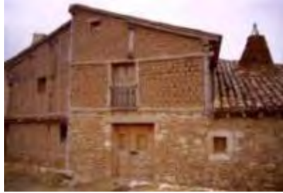
Centro de Investigación en Navapalos, restaurado por Erhard Rohmer
