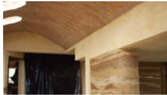
Foto 4. Muro de tapia y bóveda
