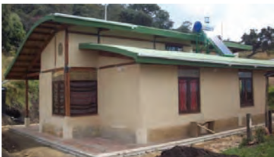
Foto 1. Vista fachada sur
