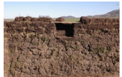
Foto de portada: Alejandro Ferreiro, 2013 Detalle de muro de terrón en Sierra de los Caracoles, Maldonado; Uruguay
