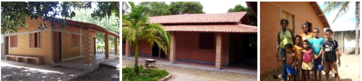
Construções comunitárias e casa popular com blocos Mattone
