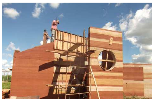
Casa de terra Bororó em taipa-de-pilão, BTC e cordwood, construída por trabalhadores indígenas e assentados - 120 m 2 ; Dourados, MS. Projeto e construção: Ana Carolina Veraldo
