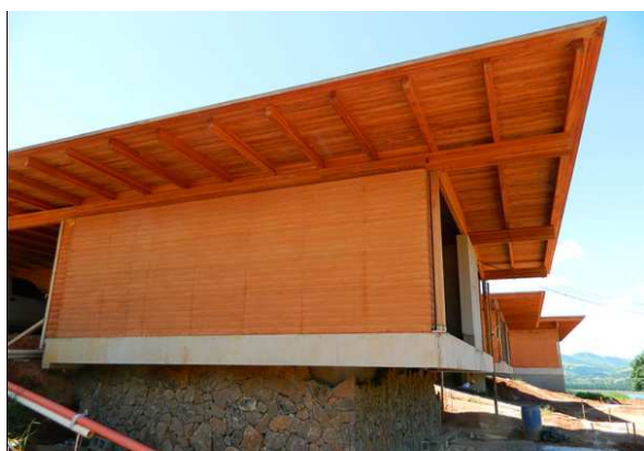
Estrutura da fundação
