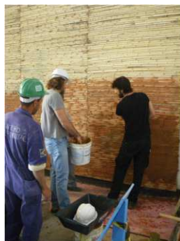
Imagem 1: Aplicação da primeira camada de terra sobre bambu.
