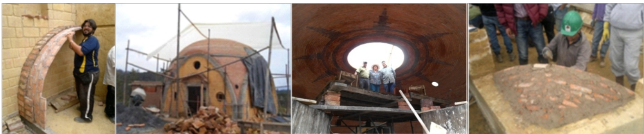
O Arq. Habbib com arco para construção da escada catalã; imagens da Capilla del Arte, cúpula com raio de 5,00m e cúpula de pañuelo
