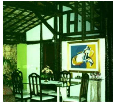
Fig. 02. Detalhes externo e interno de construção de taipa de mão, com estrutura em carnaúba, situada em Teresina, Piauí. (Foto: Wilza Lopes, 1997).
