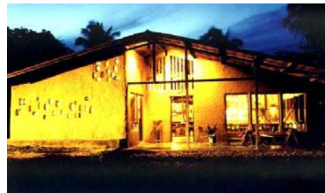
Figura 04. Fotos da etapa de colocação do barro, com detalhe das garrafas amarradas no entramado, formando os vitrais e da fachada frontal da Casa Estúdio, em Fortaleza, Ceará. (Foto: José Cordeiro Albano)
