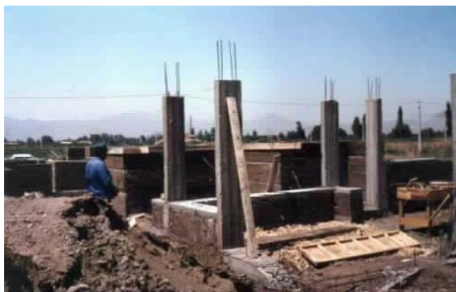
FOTO 1 Detalle ejecución muros de tapial. Es posible observar los pilares de concreto con rafas del mismo material.
