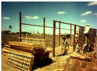
Figura 06. Colocação dos painéis, fixados em pilares e maçaranduba em construções localizadas em João Câmara, Rio Grande do Norte, Brasil. (Foto: Guadêcio Torquato)
