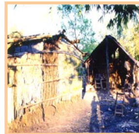
Cerramiento vertical en caña y barro.
