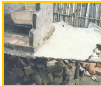
Mesada en caña y tierra-cemento.
