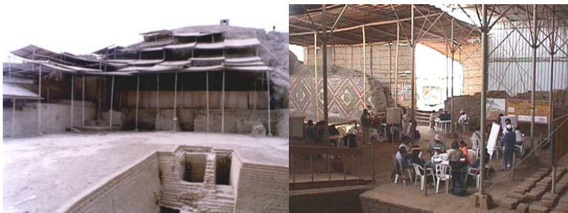
Fig. 9 e 10 – Sistemas de coberturas dos sítios arqueológicos El Brujo e Del Sol y de la Luna – Perú
