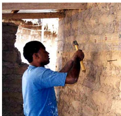
Fig. 17a – Refuerzo de malla de alambre electrosoldada.
