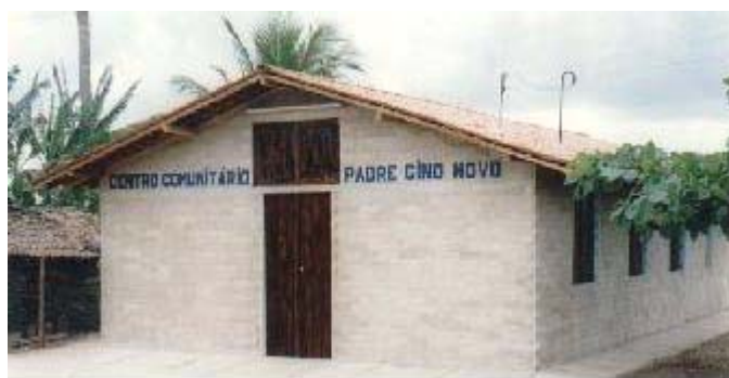
Figura 4 – Construção com tijolos prensados de terra crua estabilizada com cimento.
