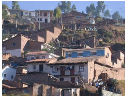
Fig. 8b – La construcción con adobe en el Perú hoy.
