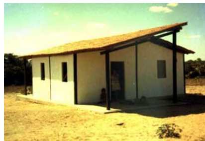
Figura 06. Colocação dos painéis, fixados em pilares e maçaranduba em construções localizadas em João Câmara, Rio Grande do Norte, Brasil. (Foto: Guadêcio Torquato)
