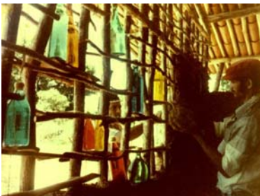
Figura 04. Fotos da etapa de colocação do barro, com detalhe das garrafas amarradas no entramado, formando os vitrais e da fachada frontal da Casa Estúdio, em Fortaleza, Ceará. (Foto: José Cordeiro Albano)
