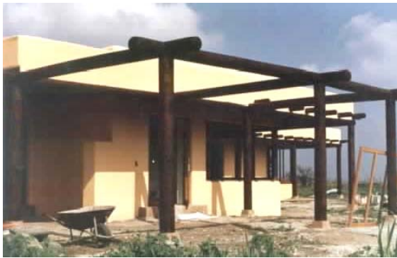
FOTO 5 Vista corredor fachada norte.
