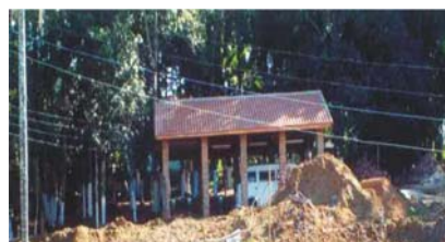
Figuras 3, 4 e 5 – Canteiro de Obras em Guararema / SP
