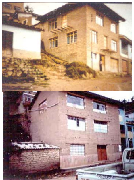
Fig. 9 – Viviendas de adobe de tres pisos.
