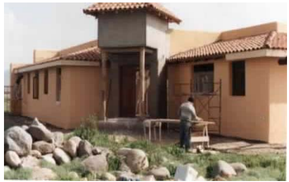
FOTO 6 Vista torreón de acceso desde surponiente.
