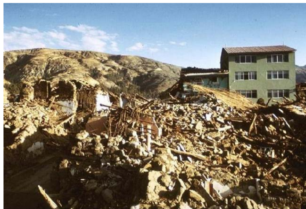
Fig. 1 – Colapso total de viviendas de tierra.
