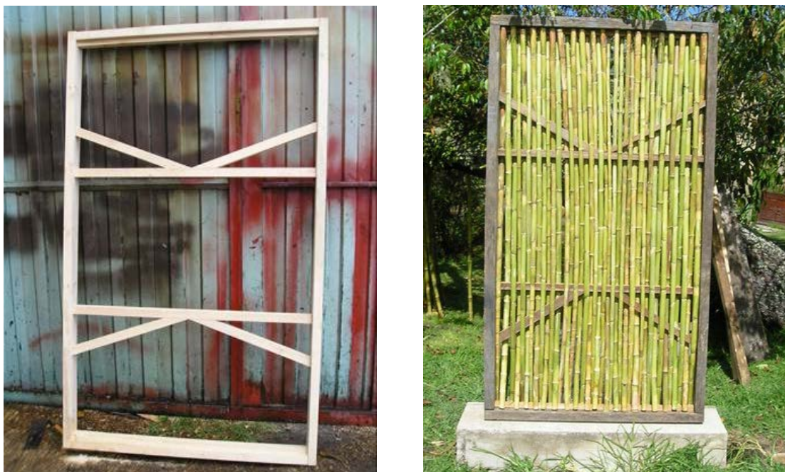
Figura 14 – Modelo de la estructura y trezado del panel de quincha o bahareque prefabricado
