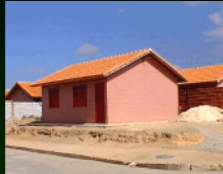
Casa de tijolo de solo-cimento (fonte: www.arquitetura.ufmg.br/habitar/sis2.html )
