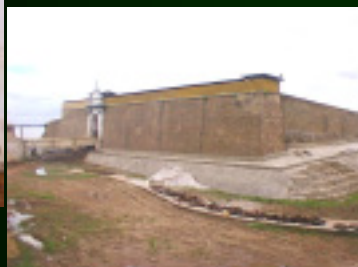
Muralha frontal da fortaleza com dois parâmetros de pedra, preenchidos com a tradicional faxina de terra.
