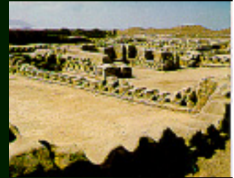
Ciudadela de Chan Chan. Sus materiales fueron adobes y piedras unidas con barro acompañado de elemento vegetales. Trujillo Perú. (Foto: A.Calla)
