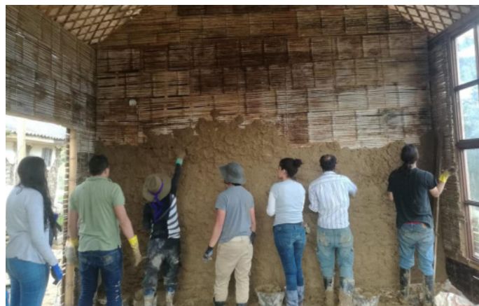
Fig 2. Revestimiento de muros, todos aprendiendo en la casa de Macheta /Cundinamarca , Beneficiarios: Familia Moncayo. Autora: Lucía Garzón.
