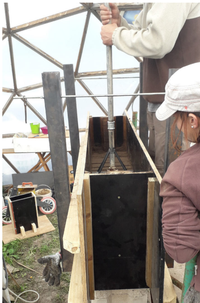
Fig. 3 Tapia experimental en Ecomuna, Cooperativa Los Caminantes, ciudad de Mar del Plata.
