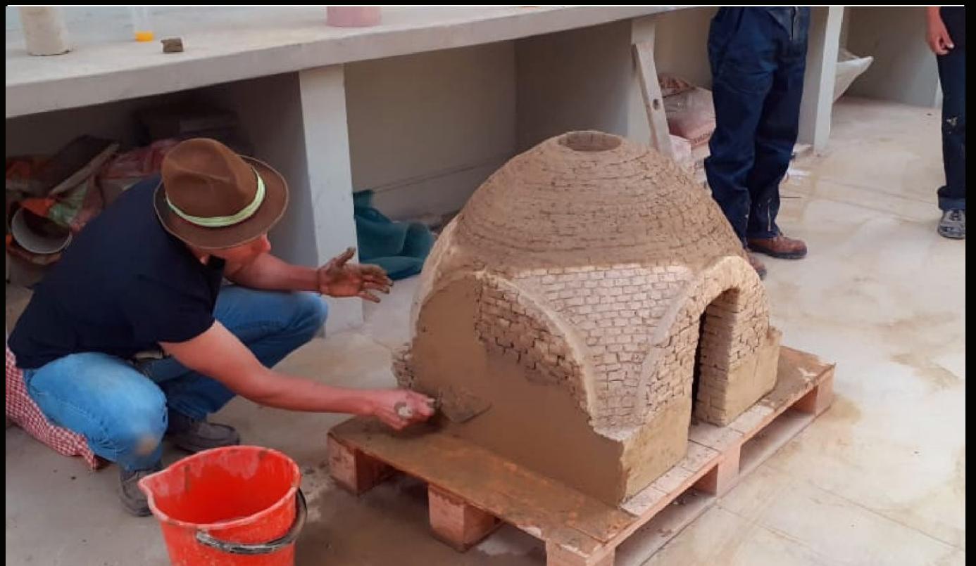
Fig. 3 Aplicación del revestimiento en muros en el Seminario taller de construcción contemporánea bóvedas y cúpulas de tierra Autora: Pacha Yampara
