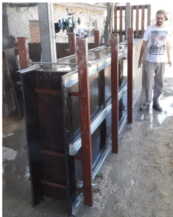
Fig. 1 Sectores de muro en el centro comunitario La Trinchera, ciudad de Mar del Plata.
