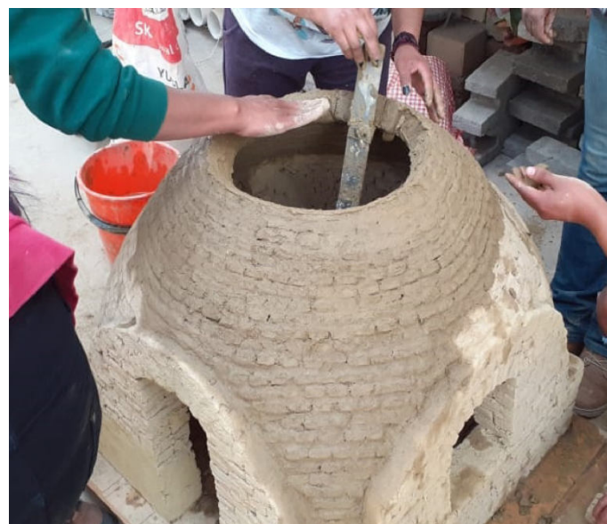
Fig. 2- Avance del cerramiento de la cúpula Autora: Pacha Yampara
