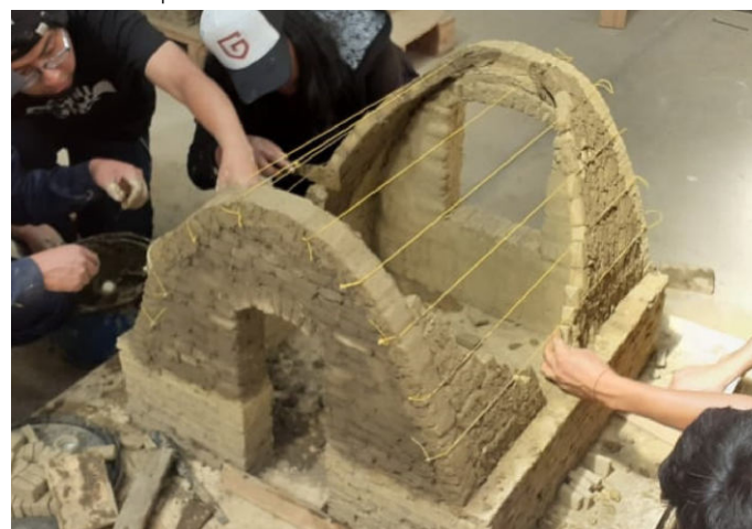
Fig. 3- Extensión de hilos paralelos para conformación de la bóveda Autora: Pacha Yampara
