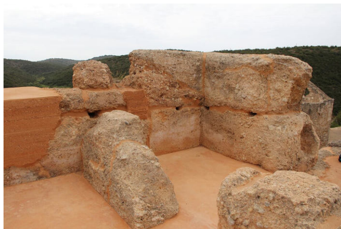
Fig 1.- Resultados da intervenção de conservação que teve lugar no Castelo de Paderne, Algarve, Sul de Portugal. Autora: Paulina Faria.
