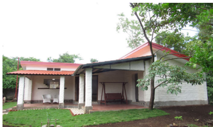
Fig. 5 Vista de conjunto de la casa “Quintana” terminada. Autor: Dulce María Guillén.
