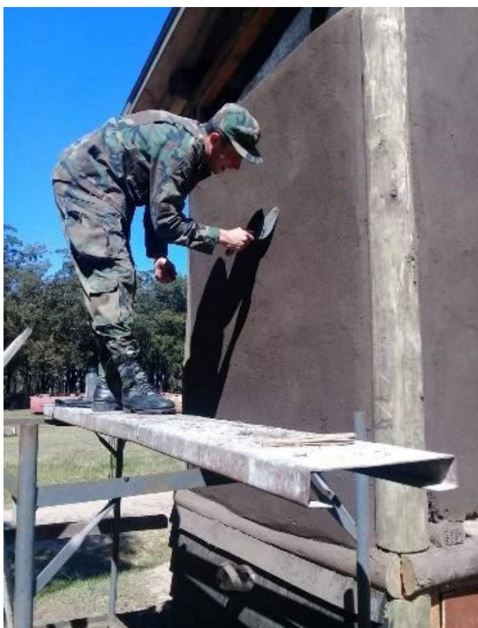
Fig 2. Revoque exterior de tierra Autora: Helena Gallardo
