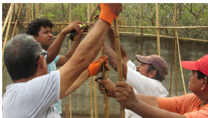
Fig.3 El dueño, el técnico y los trabajadores armando los refuerzos verticales. Autor: Ernesto González
