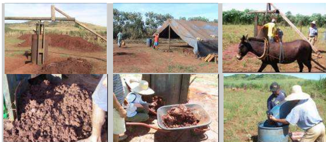
Figura 6 – Pipa em funcionamento e barracão para secagem e armazenamento dos adobes.
