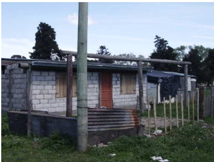
Figura 3: Sector prototipo de vivienda nueva con bloques económicos de hormigón con autoconstrucción vecinal y apoyo del obrador local (fábrica de bloques y asistencia técnica local). Barrio Monte Terrabusi, Mar del Plata (2009).
