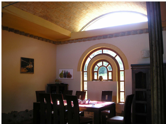
Fotografía 3 -Vivienda de BTC construida hace 20 años con cubiertas y muros de y tierra cruda, Villa de leyva Colombia, (Diseno: Angel ,Garzon, Salamanca)
