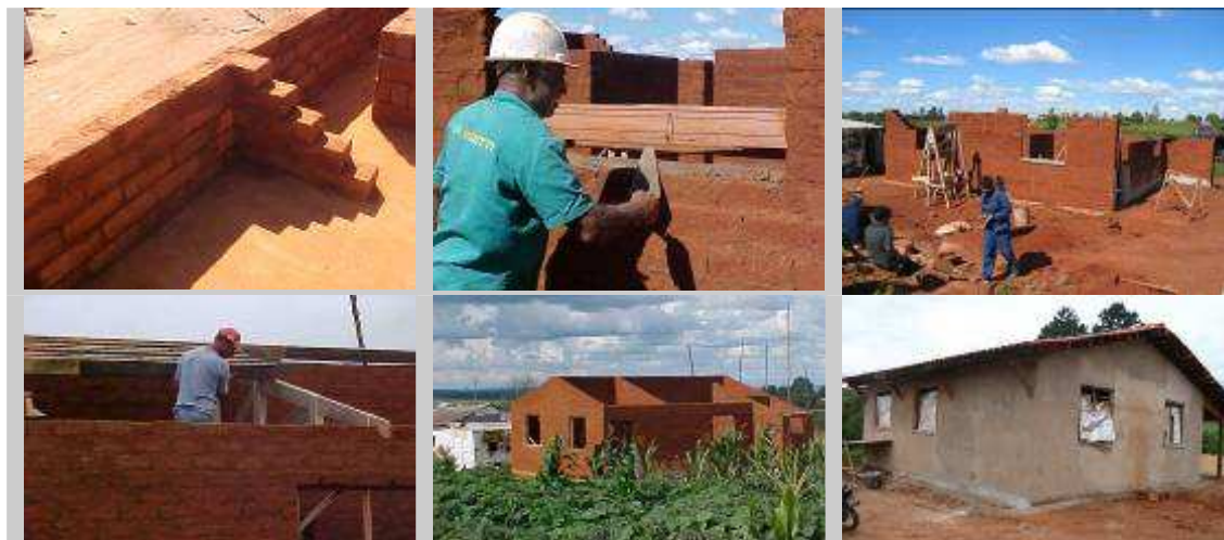
Figura 4 - Fotos da seqüência de elevação da casa de adobe.
