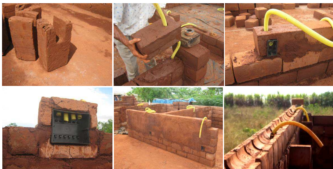
figura.2 – Etapas en la elevación de la pared: a) adobe con otro corte para tener mayor flexibilidad de espacio al momento de pasar el tubo flexible, fue usado para pasar los 4 tubos que salen de la caja de distribución; b) paso del tubo por el adobe para enseguida ser asentado; c) Adobe asentado en la tercera hilera con caja y tubo instalado; d) adobes con caja de distribución; e) imagen de varios puntos en paredes por donde pasa el tubo flexible; f) tubo flexible pasando por el adobe canaleta donde será concretada la viga cinta (créditos: autor)
