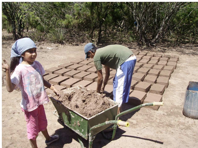
Figura 2: Capacitación en áreas rurales pobres de monte (Santiago del Estero) con población campesina ganadera. Proyecto "Parayacu" 2008-2009. Integración de toda la familia en las prácticas de fabricación de adobes para las paredes de un reservorio de agua de lluvia.
