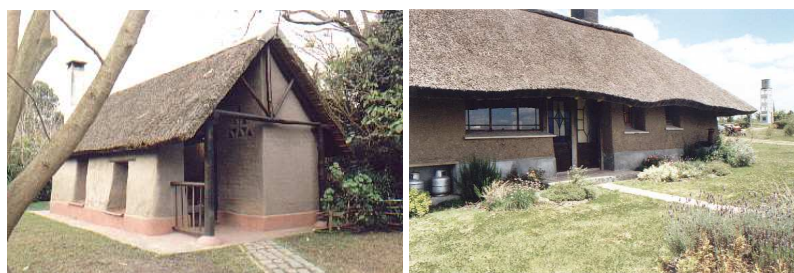
Figura 07 – residências em terra edificadas com a utilização da técnica de torrões, respectivamente, Flía. Montero , em Montevideu e Flía. Weiss , em Maldonado. Fonte: Alderton (2003).
