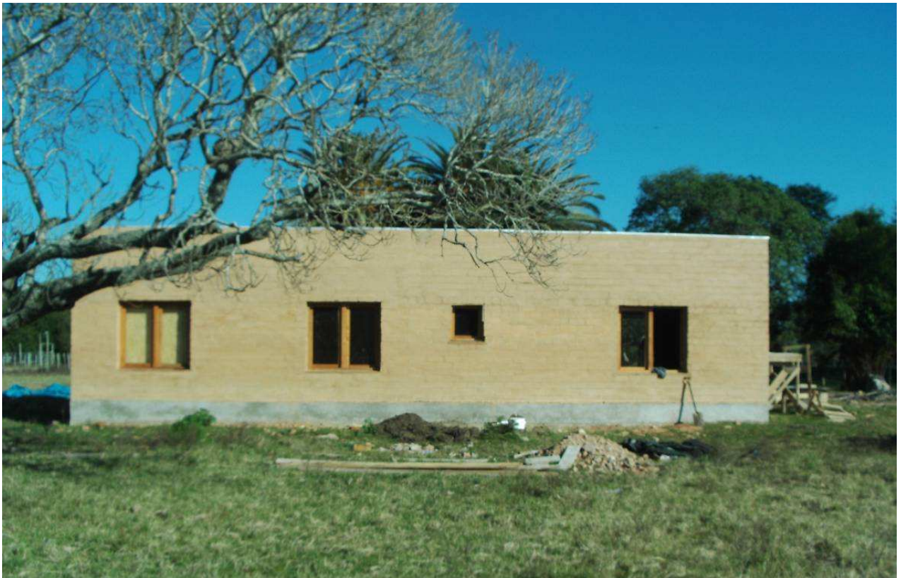
Fig. 4 La casa terminada (Créditos Arq. Andrés Nogués - 2010)
