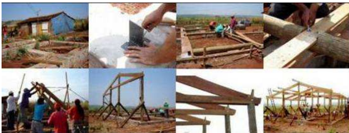
Figura 9 – Algumas etapas de execução do sistema estrutural pilar-viga de eucalipto roliço (acervo HABIS).
