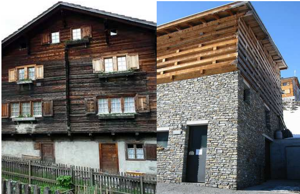
Fig.2 Vrin, Suiza, casa tradicional; Matadero de Vrin, Suiza, arq. Gion Caminada – piedra y madera, los materiales tradicionales del lugar. (crédito: Patrícia Marchante)
