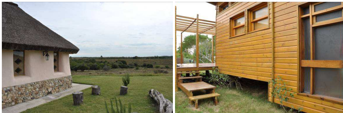
Figuras 3 y 4: Vivienda con zócalos y aleros (Arq. C. Alderton, 2007) y vivienda de tierra revestida en madera (Arq. J. Márquez, 2006). (Créditos: I. Ferrari, 2010).
