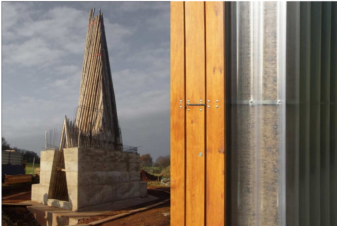
Fig.4 Klaus Bruder Chapel, Suiza, arqto. Peter Zumthor – tapia de cemento com enconfrado interior de palos rollizos ;(crédito: Rodrigo Jorge, 2007); Casa Arruda, Portugal, Plano b arqtos. – quincha aislada con corcho y protegido com chapa de policarbonato. (crédito: Patrícia Marchante, 2008)
