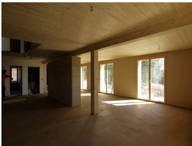
Fig.12 – Obra de piso, tierra vertida, obra participativa en fardos de paja portadores y tierra CarPE y Caracol, Lausanne, Suiza (créditos: Elsa Cauderay, 2010)
