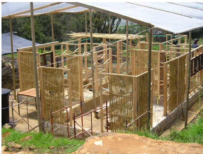
Fotografía 1- Prototipo de vivienda de bahareque prefabricado con piedra, madera y tierra (fotografía de Lucia E. Garzón).
