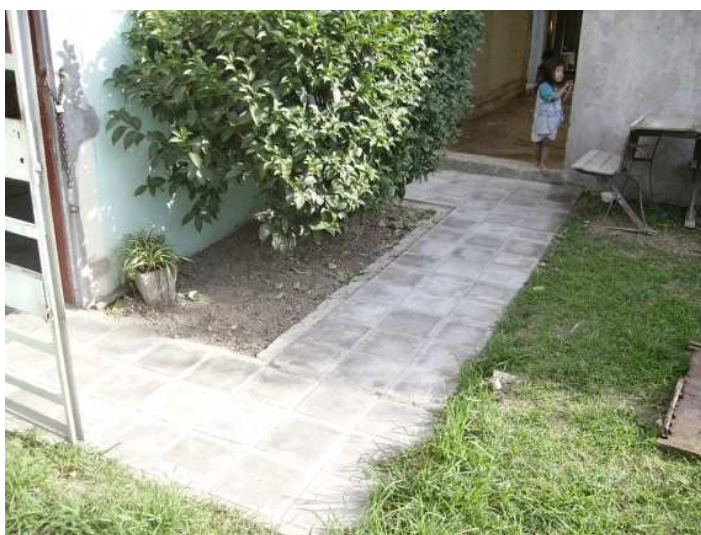
Figura 1: Piso exterior con baldosas CONICET en patio exterior del centro vecinal de Bancalari. Prototipo demostrativo en uso y evaluación desde 2007.
