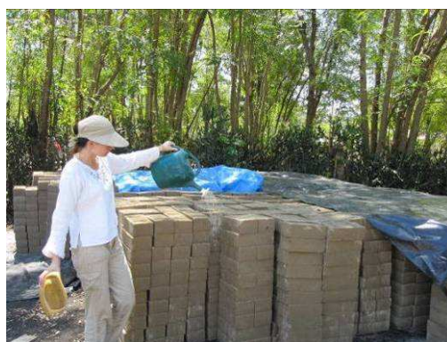
Fig.4 - Curado de los Bloques (créditos: Jim Hallock, 2010)
