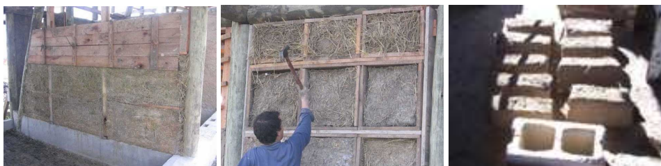
Figura 06: formas de utilização da técnica de terra-palha no Uruguai, respectivamente: taipa, painéis e blocos. Fonte: www.proyecto-hornero.edu.uy/proyecto.htm .
