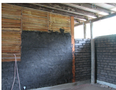
Figura 06: parede divisória em taipa de mão, salas de aula – San António, Salto.
