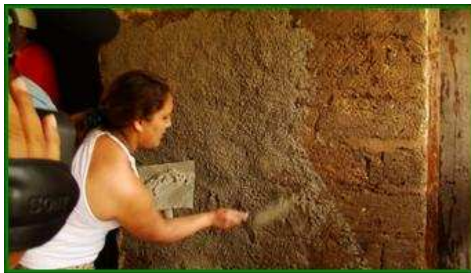
Fotografía No.2: Técnicas de repello en viviendas de adobe
