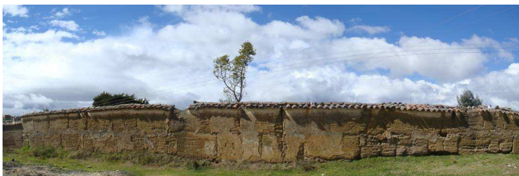
Fig.2 – Tapia de cerramiento del Cementerio de Chivatá (créditos: J. Vargas, 2009)
