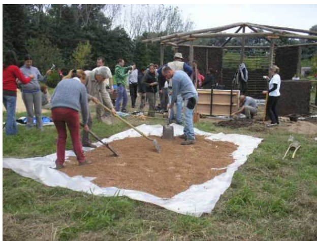
Figura 4: Mezclado en seco de suelo tamizado con cal para la fabricación de un tapial. Curso-taller con apoyo de ONG (SAHDES) con práctica intensiva en chacra El Arca, Luján, provincia de Buenos Aires. Participación de constructores, empleados, ingenieros, arquitectos (FAU-UNSJ, San Juan).
