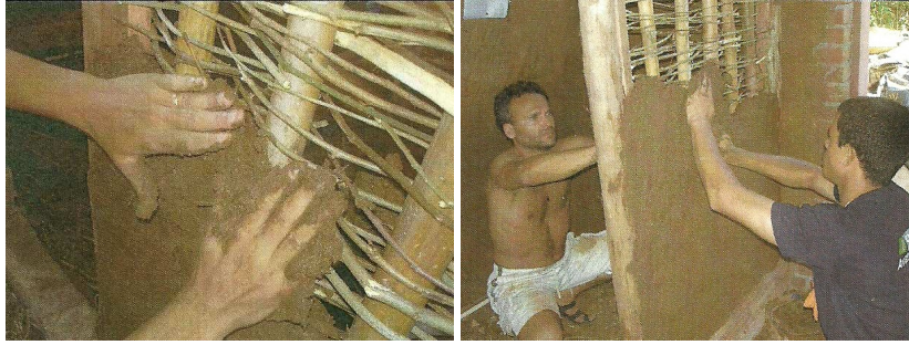
Figura 02: aplicação de terra sobre estrutura em pau-a-pique, combinando bambu e galhos tramados. Fonte: Integria.
