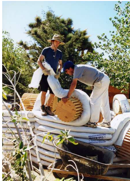
Fig. 1 Ejecución de vivienda con STC, California, EEUU.
