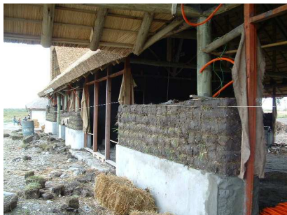
Colocación de terrones en el muro
