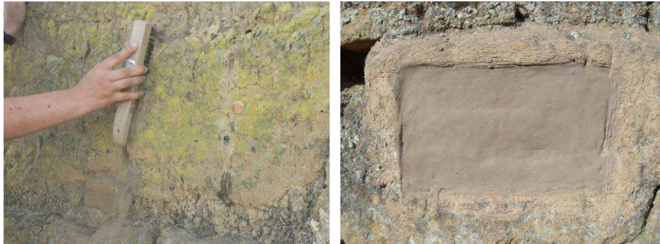
Fig. 4 – Actividades de renovación de la superficie del muro
