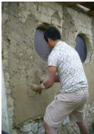
Figura 7: Estudiante aprende a revocar un muro exterior
