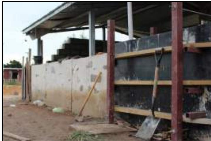
Figura 4: Prueba de molde en la construcción del muro exterior de la vivienda, con técnica similar a la de tierra vertida.
