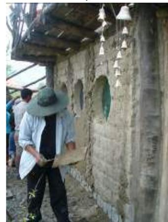
Figura 8: Estudiante aprende a marcar botones para el revoque muro exterior
