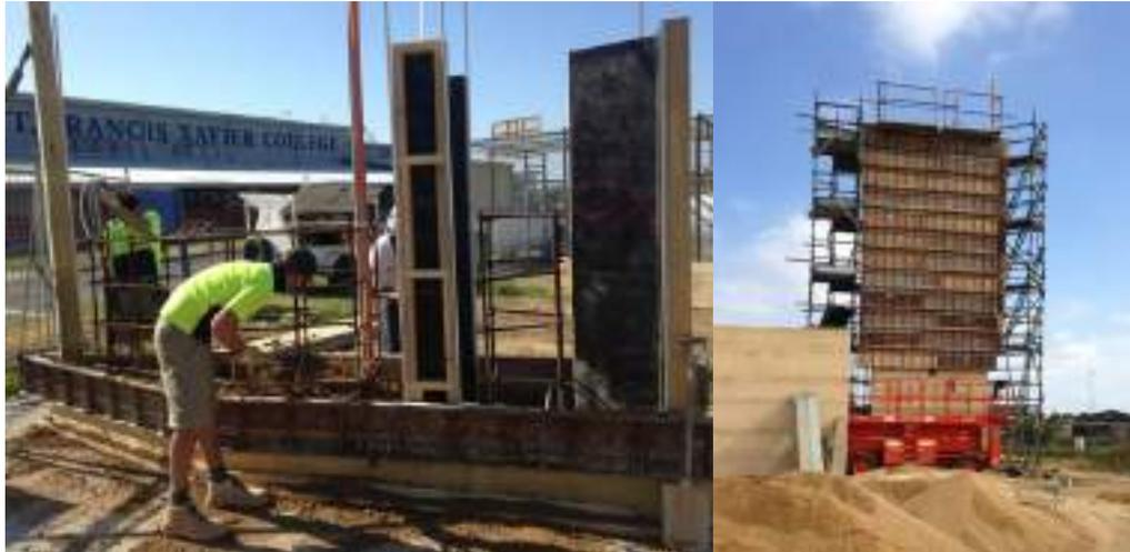
Figura 4 - Exemplo de execução de torre de 12 metros de altura de taipa de pilão armada, 2014 (Créditos: Oliver Petrovic)
