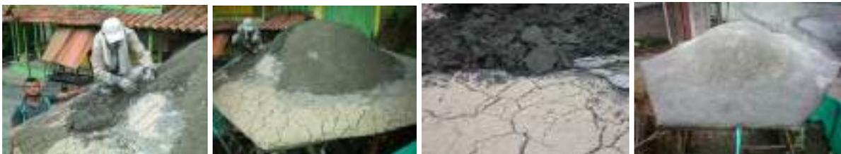
Figura 6: Cobertura de mortero de domo caña por capas de tierra y afinado, 2015
