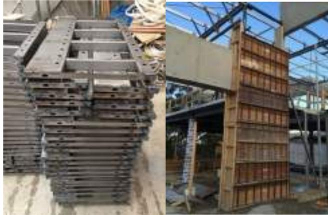
Figura 2. Fabricação de fôrmas metálicas e utilização das fôrmas na execução, 2015
