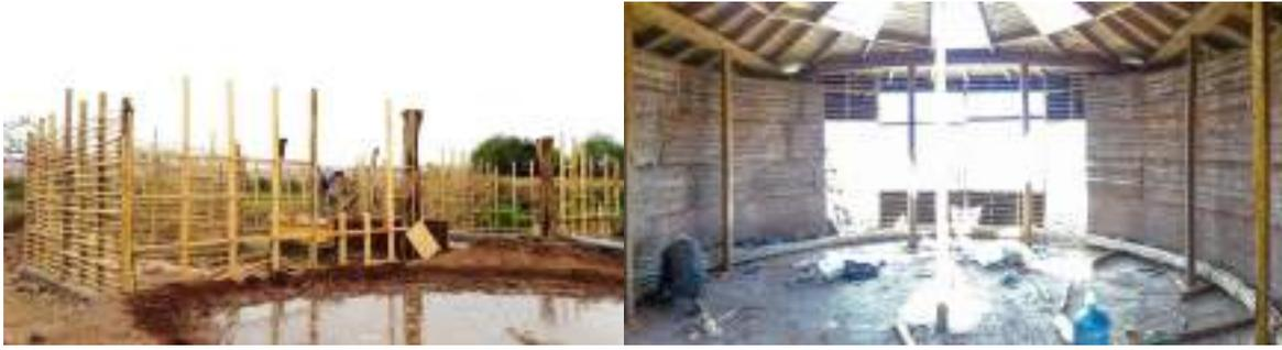
Figura 4. Preparación de mezcla de tapial, preparación cadena superior de cañas
