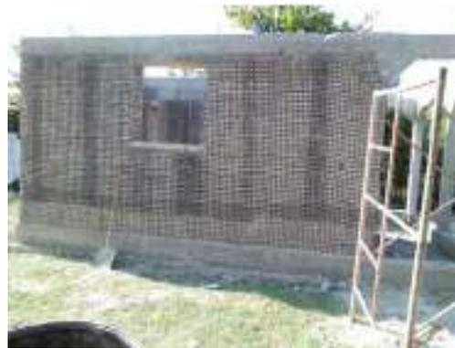
Figura 6. Muros en BTC y geomalla
