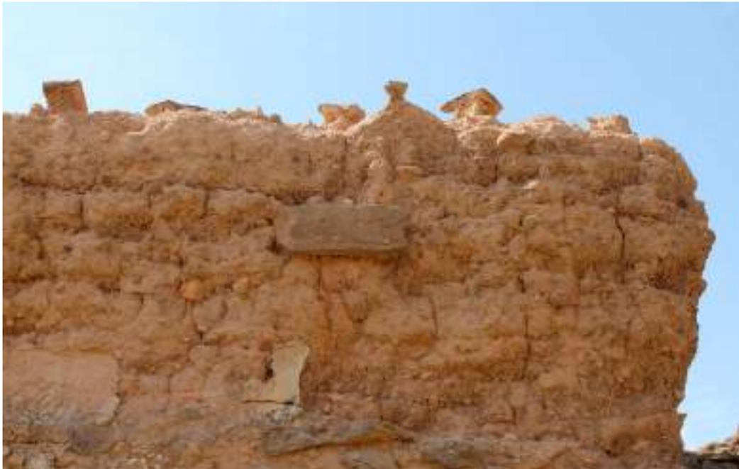
Figura 6. Detalle del descalce de un mampuesto en posición central en un muro de tapia careada con piedra (Campo Arriba, Alpuente)
