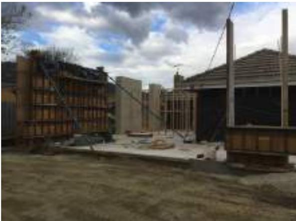
10. Execução das paredes em taipa de pilão estabilizada
