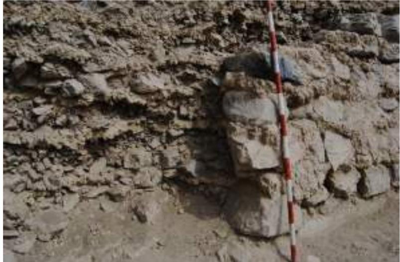
Figura 6. Típico muro de contención que contiene un relleno estructurado
