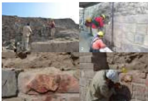
(1) Anastilosis de un paramento de piedra con inclinación y riesgo de colapso en el pasadizo, (2) Proceso de conservación, (3) Enlucido - en superficie de piedra - rojo y amarillo, con diseño negro, (4) Tratamiento de conservación y estabilización de los enlucidos.
