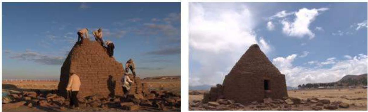
Figura 9 – Finalización del proceso constructivo del putuco
