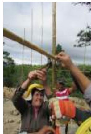
Figura 7. Colocación de refuerzo vertical
