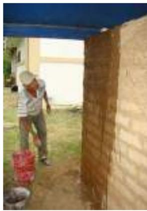
Figura 2. Preparación de la superficie para la colocación del repello
