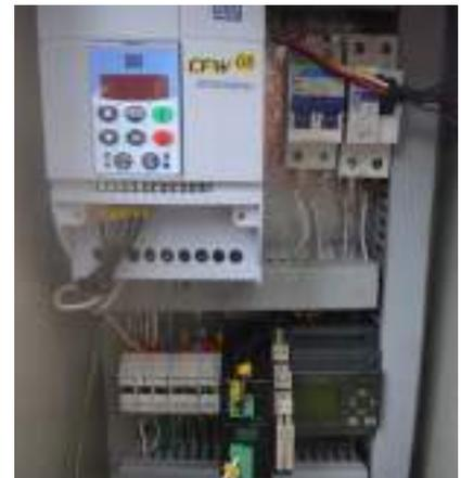
Figura 5. Tablero de PLC y reguladores
