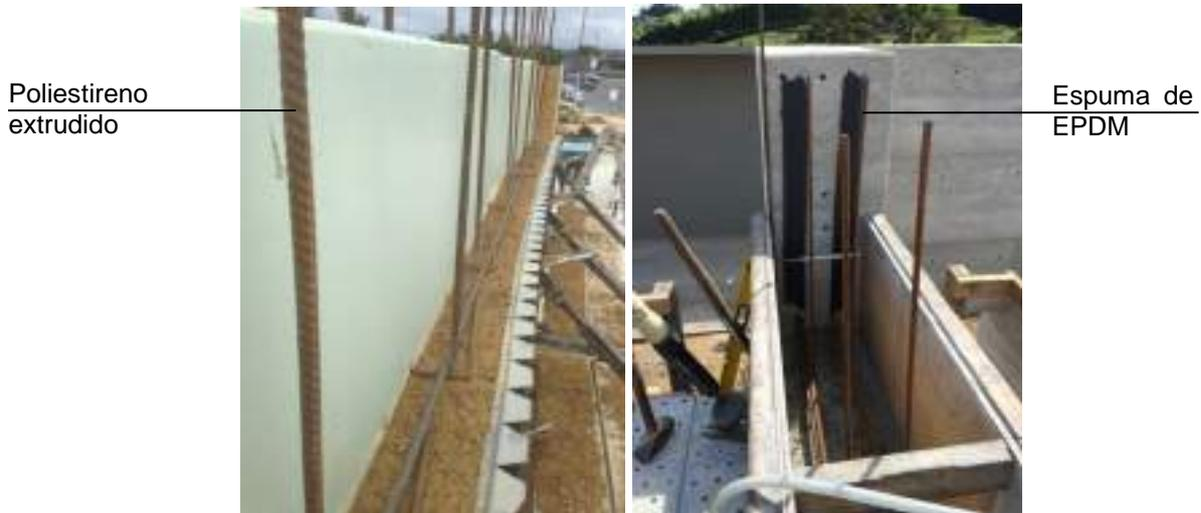
Figura 5. Exemplo de parede curva armada com poliestireno extrudido, resistência térmica de 2,5 m<sup>2</sup> KW, viga de taipa armada com fita de espuma de EPDM expandido como junta de dilatação, 2014 (Créditos: Oliver Petrovic e Rodrigo Rocha)
