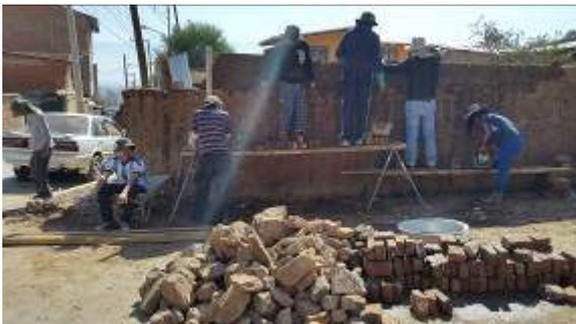
Figura 18: Estudiantes realizan el levantamiento de muro perimetral 45 cm más
