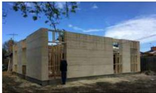
Execução das paredes em wood frame
