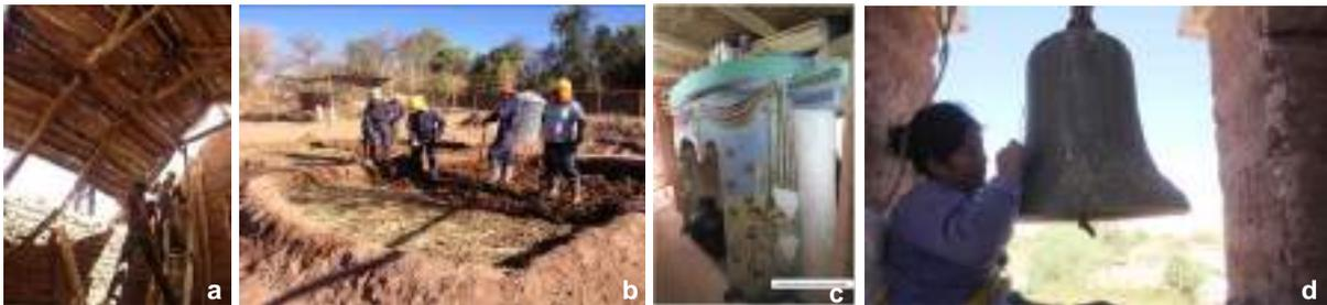
Figura 6 a) trabajadores en tareas de apuntalamiento de estructura de techumbre y calzaduras; b) muestra albañiles en el pozo de amasado; c) tareas de recuperación de pinturas hornacina retablo; d) trabajadora local en faenas de limpieza de campana (Créditos: Fundación Altiplano)
