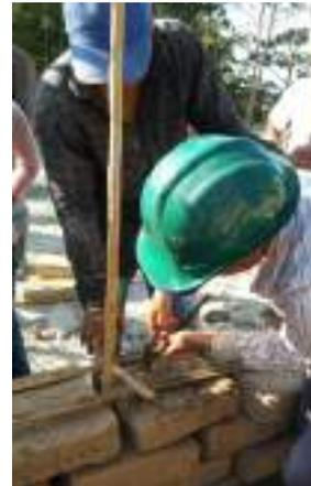
Figura 5. Colocación de refuerzo horizontal.
