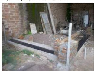
Fig 8- Submuraciones y capa aisladora
