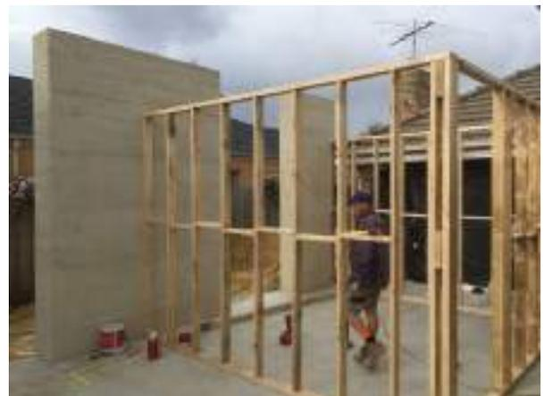
11. Execução das paredes em wood frame
