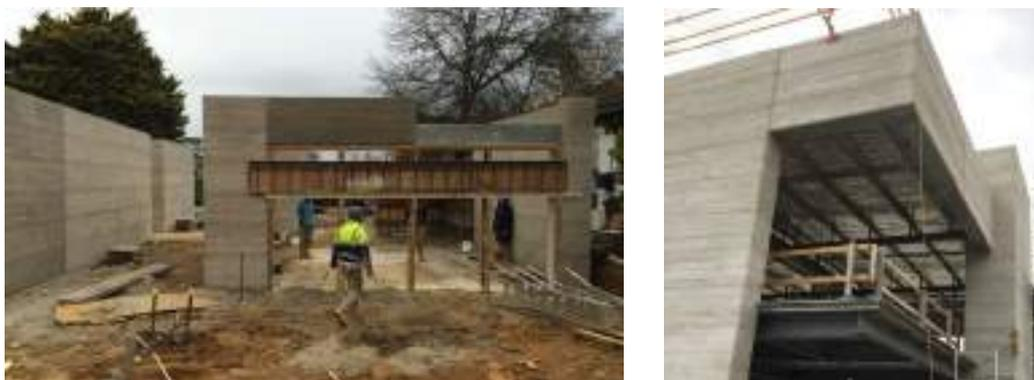
Figura 9. Exemplos de execução de vigas de taipa acima de vigas metálicas em “T”, 2015 (Créditos: Rodrigo Rocha)
