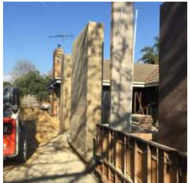
13. Execução das paredes em taipa de pilão estabilizada
