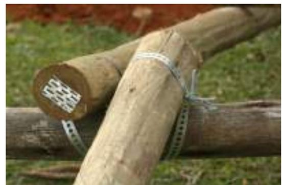
14. Demonstração da amarração das peças com fita metálica perfurada e parafusos
