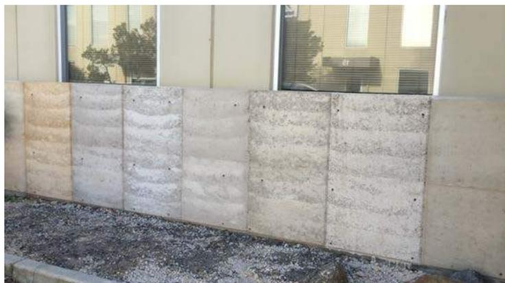
Figura 3. Tipos diferentes de taipa de pilão com terra estabilizada na fachada da construtora Olnee Constructions, 2015 (Créditos: Rodrigo Rocha)
