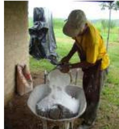
Figura 3. Preparación de la mezcla para morteros de repello
