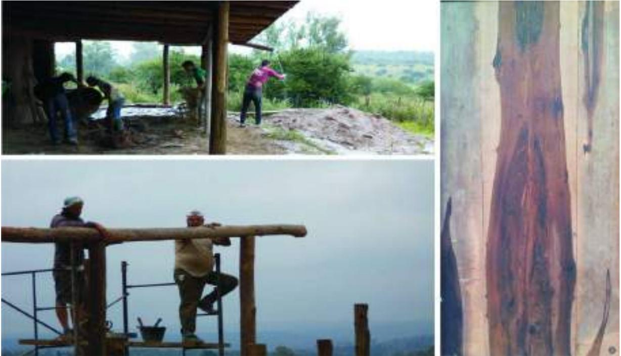
5. Manejo de la arcilla y pasto para los muros de quincha. Estructura independiente de eucalipto
