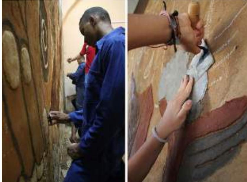
Figura 4. Aplicación de técnica de esgrafiado y estuco de detalles (archivo Pangea Fundación, 2016 - 2017)
