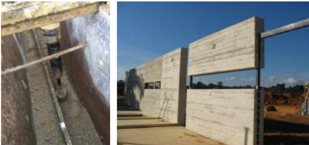
Figura 8. Execução de taipa de pilão sobre viga metálica em “T” e colunas metálicas embutidas, 2014 (Créditos: Rodrigo Rocha e Oliver Petrovic)
