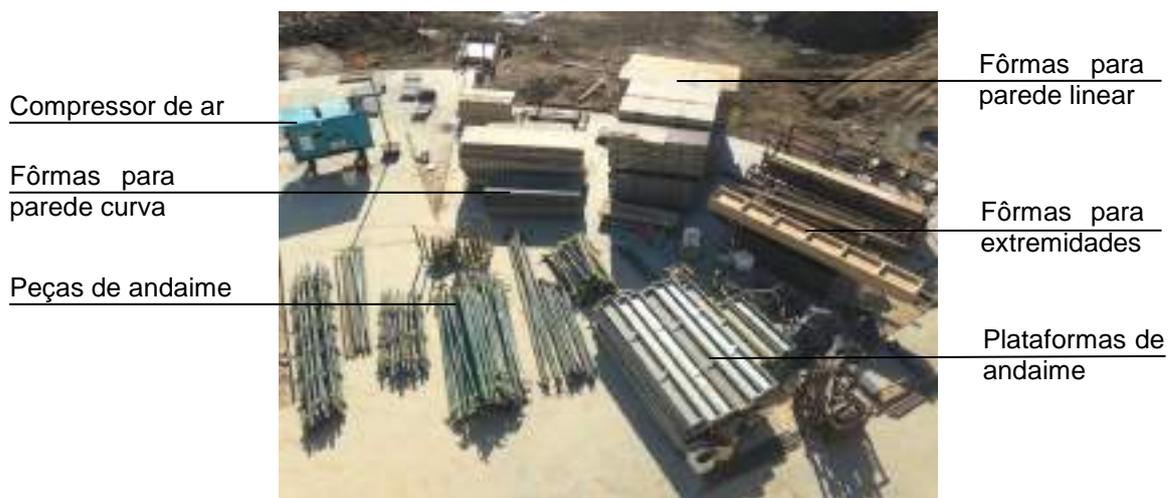
Figura 1. Equipamentos necessários para a execução da taipa de pilão com terra estabilizada, 2014 (Créditos: Oliver Petrovic)
