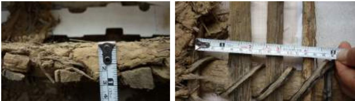
Figura 3. Espaçamento das ripas e espessura do barro aplicado na parede (Hijioka, 2012)
