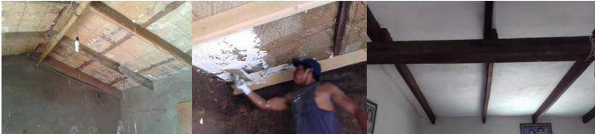
Figura 3. Mejoramiento del tumbado por la necesidad de colocar la malla y el papel que sirven como soporte debe realizarse simultáneamente a la ejecución de la cubierta
