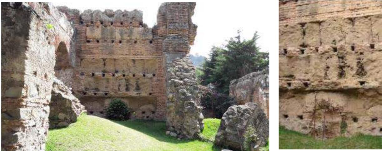
Figura 4. Detalle de muro de tapial con rafas de ladrillo del Convento de San Francisco (Créditos: Lucía Carrera)
