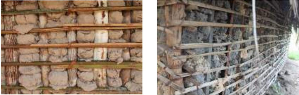
Figura 2. Detalles de distintos materiales usados al realizar la técnica quincha en aldeas Kayapó visitadas
