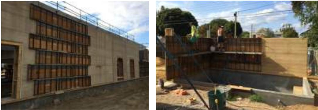
Figura 10. Exemplos de utilizações das fôrmas e plataformas metálicas apoiadas em cantoneiras para execução de paredes em taipa de pilão, 2015 (Créditos: Rodrigo Rocha)
