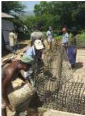
Figura 5. Construcción y colocación de la geomalla
