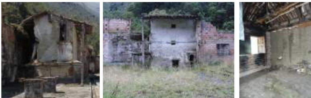
Figura 7: Estado de conservación de elementos construidos con tierra en la Antigua Hacienda de Llaviucu, año 2016 (acervo del Proyecto vIirCPM)
