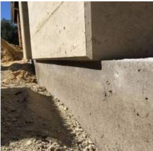
12. Detalhe da taipa de pilão estabilizada a 45 mm da fundação
