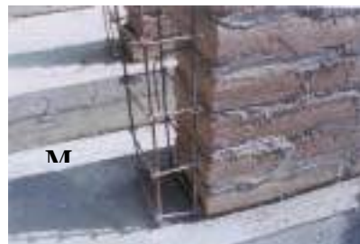
Foto 2. Conexión dentada en M2 (izquierda) y a ras en M3 (derecha)
