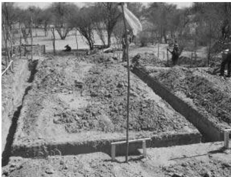
Fig.6: Etapa de excavación de zanjas.
