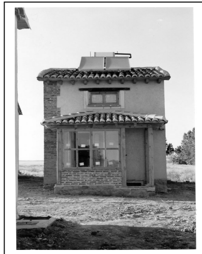
Figura N°4. Fachada sur, con galería, boca de la gloria, y paneles de energía solar térmica.
