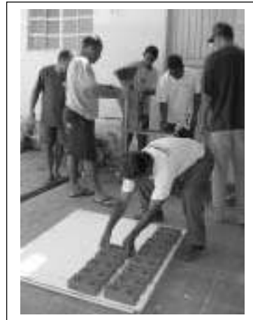
Fotos 3 y 4. Capacitación de comunitarios en la utilización de la prensa "cinva-ram", para confección de ladrillos de suelo-cemento-cal Asentamiento Jardim Esperança – Resende – RJ
