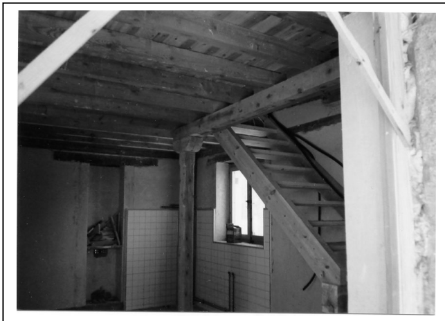
Figura N° 3. Interior, con forjado y escalera de madera, durante la obra.
