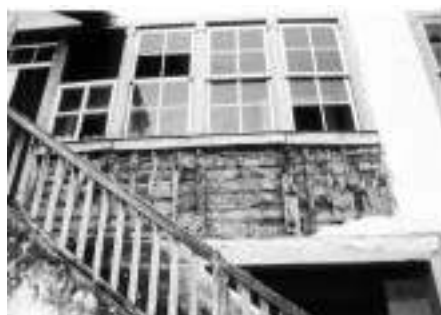
Fig. 4 – Fachada Frontal – pavimento superior
