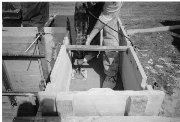
Figura N° 2. Apisonado de tapial con martillo neumático.
