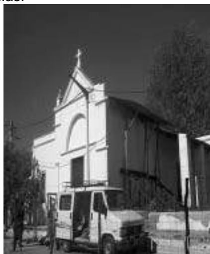
4. Iglesia del Rosario de Merlo luego del derrumbe de la torre.
