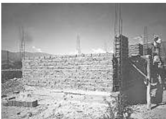
Imagen 3. Estructura de H°A° y cerramiento Mampostería de adobes
