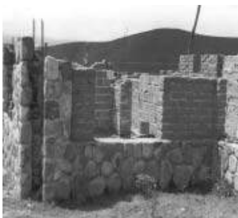
Figura 4: Construcción con adobe en el noroeste argentino.
