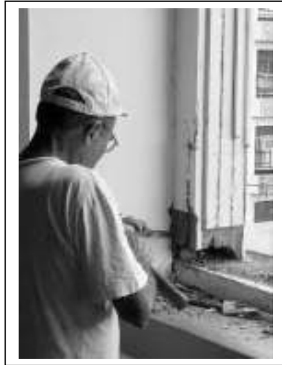
Foto 5. Removiendo las partes afectadas
