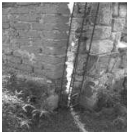
Figura 6: Construcción con adobe en el noroeste argentino.
