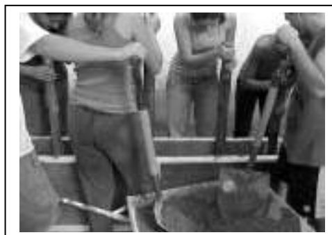
Foto 6. Ejecutando la tapia
