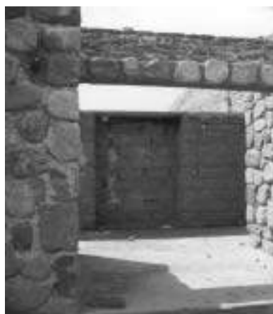
Figura 5: Construcción con adobe en el noroeste argentino.
