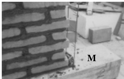
Foto 2. Conexión dentada en M2 (izquierda) y a ras en M3 (derecha)
