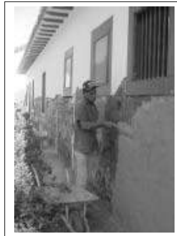
Foto 2. Aplicación del revoco de cal apagada
