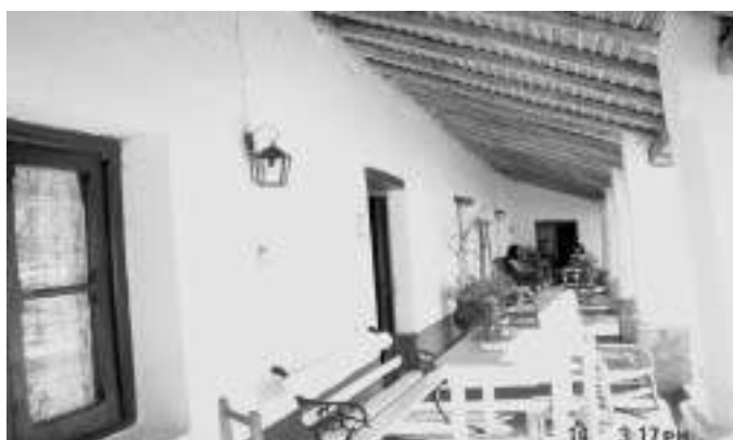
Figura N° 2 – Vista parcial de la galería
