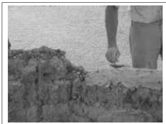
Foto3. Aplicación del mortero de la capa de sacrificio
