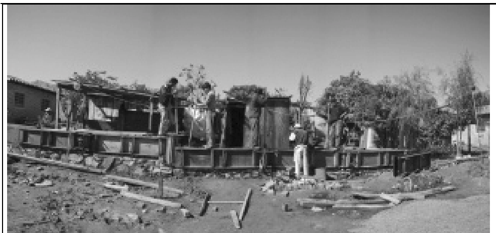
Corrección de molde esquinero Construcción de muros linderos
