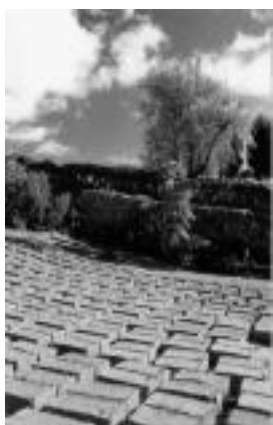
Figura N° 1. Fabricación de adobes
