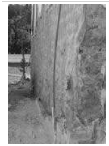
Foto 1. Remoción del enlucido
