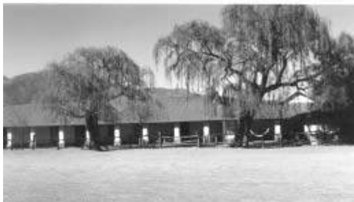
Figura N° 1 - Vista parcial del frente Norte
