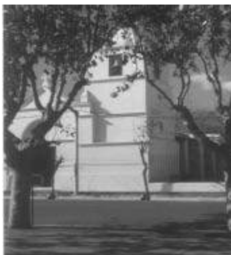
3. Iglesia del Rosario de Merlo, vista antes del derrumbe de la torre.
