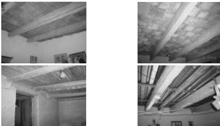
Figura No. 5 Detalles de techumbres , fotos tomadas por los alumnos de la Unidad Académica de Arquitectura, Diseño y Urbanismo de la UAT, julio 2004
