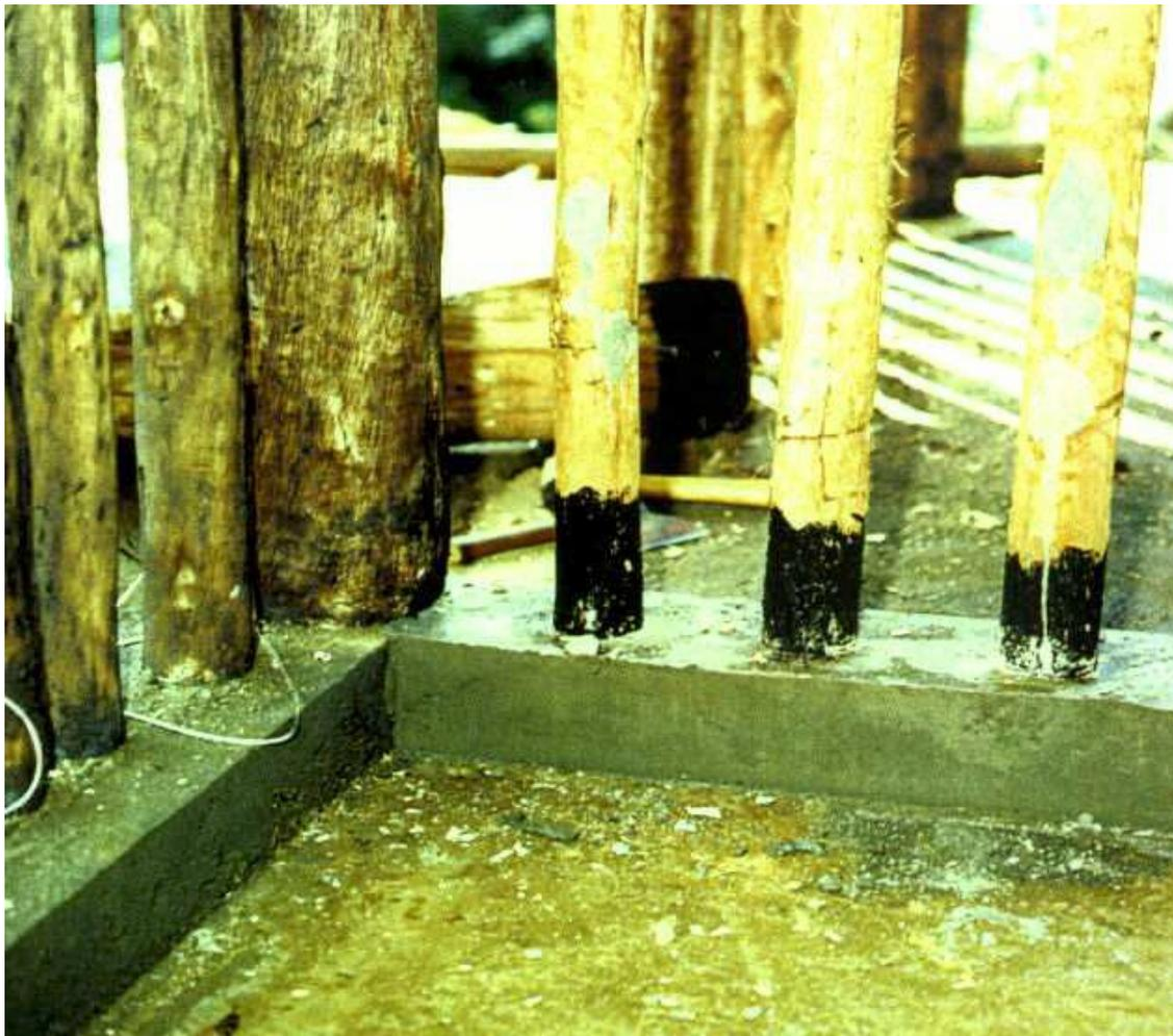
Para proteção contra os danos causados pela incidência da água das peças verticais de madeira, pilares e forquilhas que ficam em contato com o solo, Lopes (1998) cita que, nas construções recentes, são usados geralmente materiais impermeabilizantes, como pintura asfáltica, betume, resina, sacos plásticos e base de concreto, de acordo com a disponibilidade local, como no detalhe construtivo usado nas obras em taipa pelo arquiteto Cydno Silveira (Figura 17).
