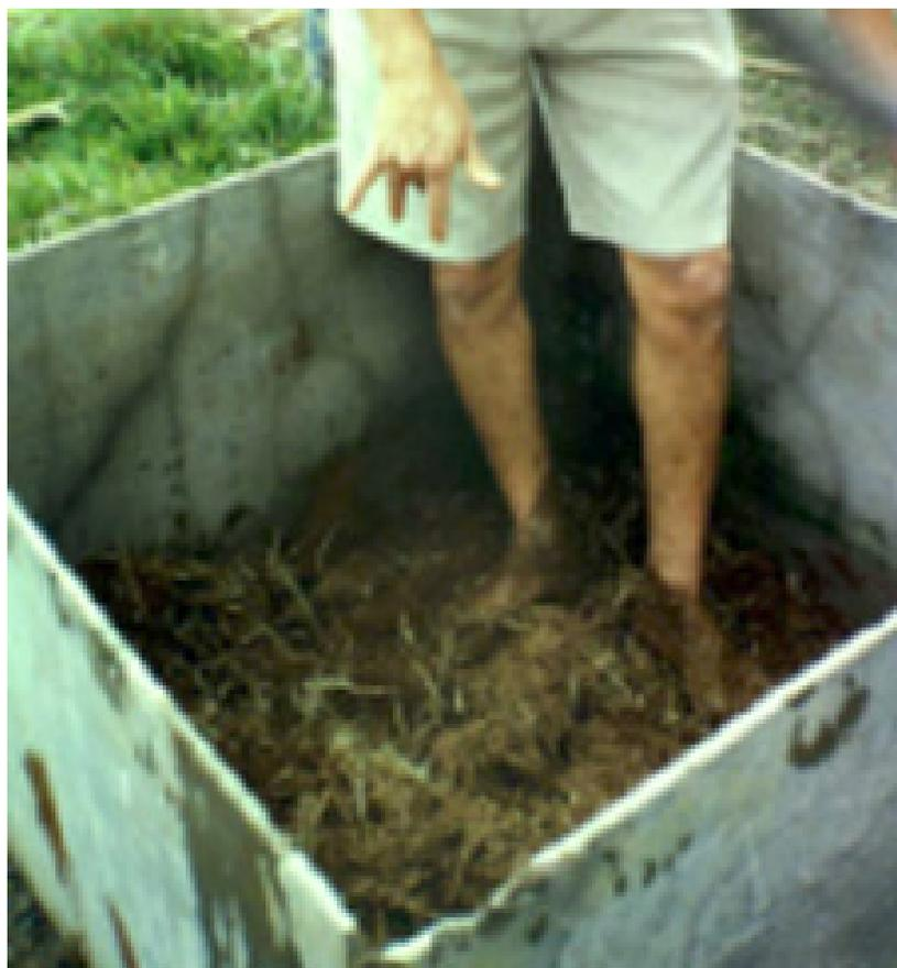
No preparo da mistura para barreamento, normalmente, costuma-se amassar a terra com os pés descalços (Figuras 10 e 11). E, segundo Gieth et al. (1994), é conveniente deixar esta mistura em repouso, por um período de 12 horas, de preferência durante a noite, para garantir ao barro um estado plástico ideal para aplicação.
