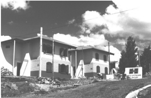
foto 3 - obra ARQ. ROSARIO ETCHEBARNE
