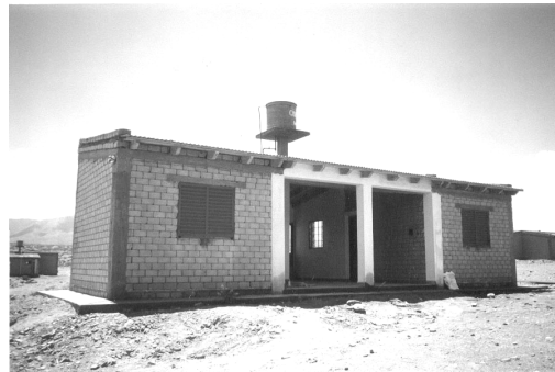
Figura 2 - Vivienda de Bloques comprimidos de s-c. Proyecto ECOSOL . IPDUV / UCA – Salta, Argentina
