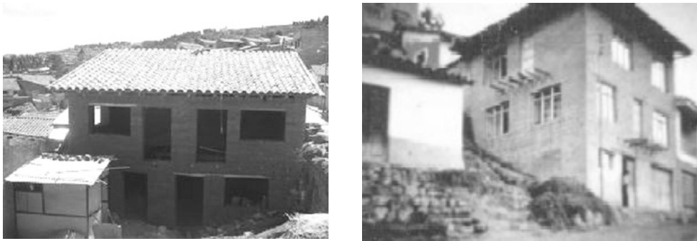
Fig. 2.1 Configuración inadecuada en viviendas de adobe
