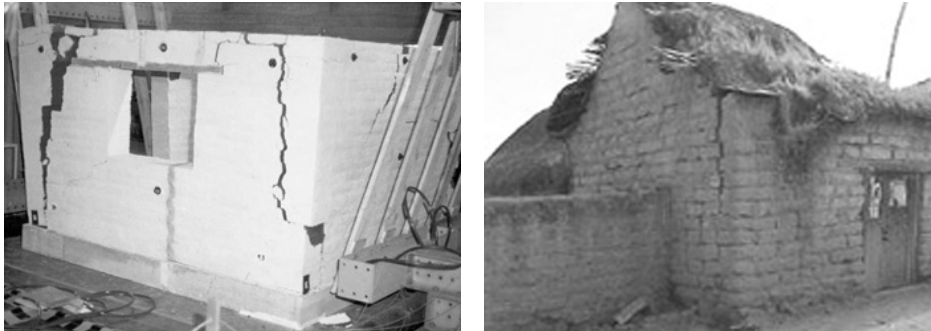
Fig. 2.4 Grietas verticales en las esquinas de muros
