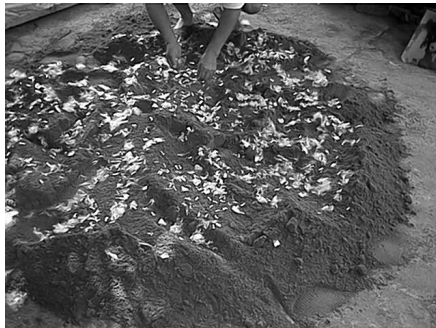
Figura 2. Mezclado de la fibra con el material arcillo - limoso
