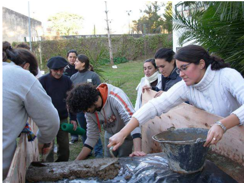
Figura 4 – Media bóveda, malla plástica y suelo cemento
