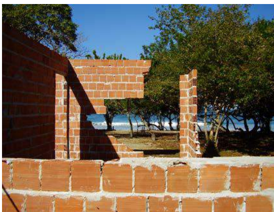
Figura 1 – Construção inacabada com material industrializado. Foto: Ana Villaça
