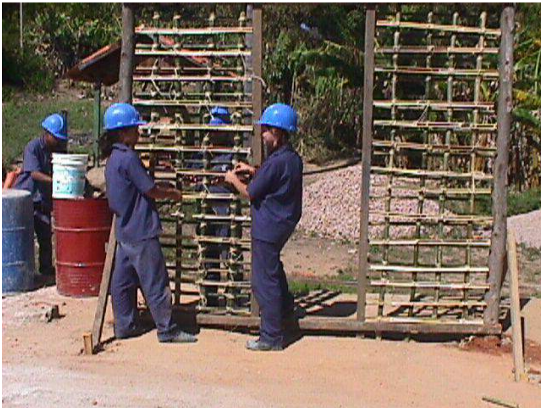
Figura 1 – Construção do entramado de parede em pau a pique executada pelos alunos
