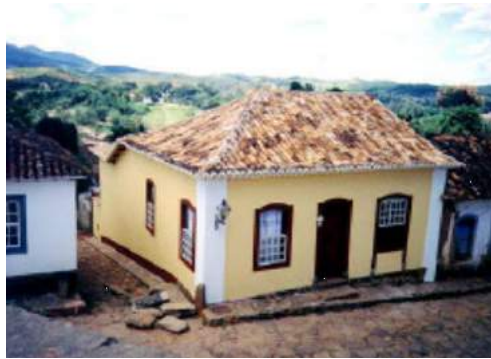
Figura 1 – Casa construída em 1750, em adobe, taipa e pau-a-pique, restaurada em 1996 pelo arquiteto Marcos “Reco” Borges (Tiradentes-MG). Fonte: Faria (2002), p.57
