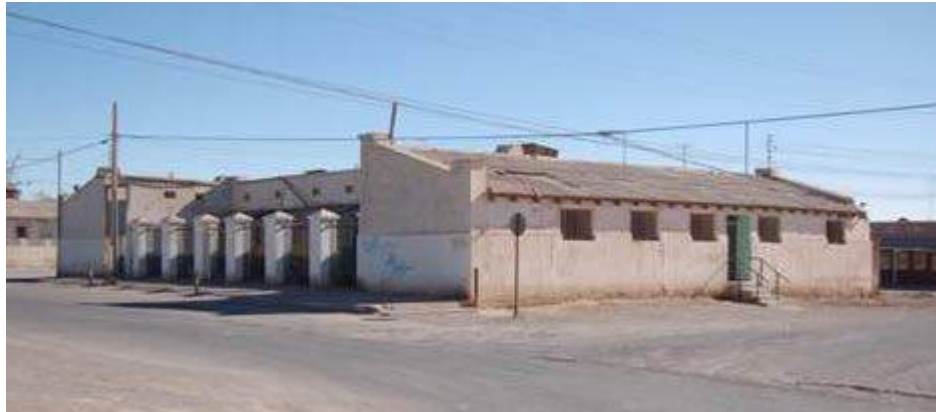
Figura 19 –Vista general del ala sur-oriente del edificio Inchinor. Fuente: Oficina Surtierra Arquitectura
