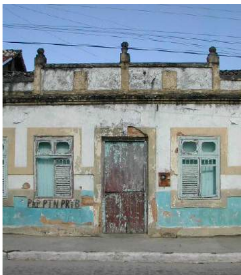
Figura 4 – Casa térrea em partido de morada inteira construída em taipa e tijolos com cobertura em duas águas; cumeeira paralela à fachada; sem beiral e uso de platibanda decorada
