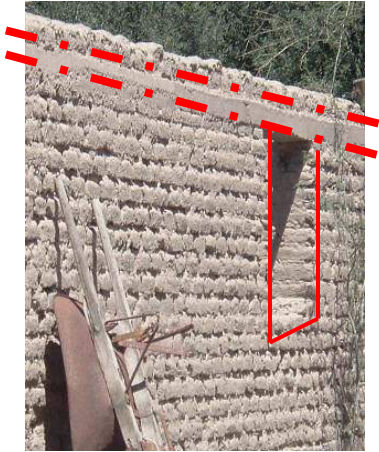
Figura 3 - Estructura sismorresistente de hormigón armado cumple la función de dintel
