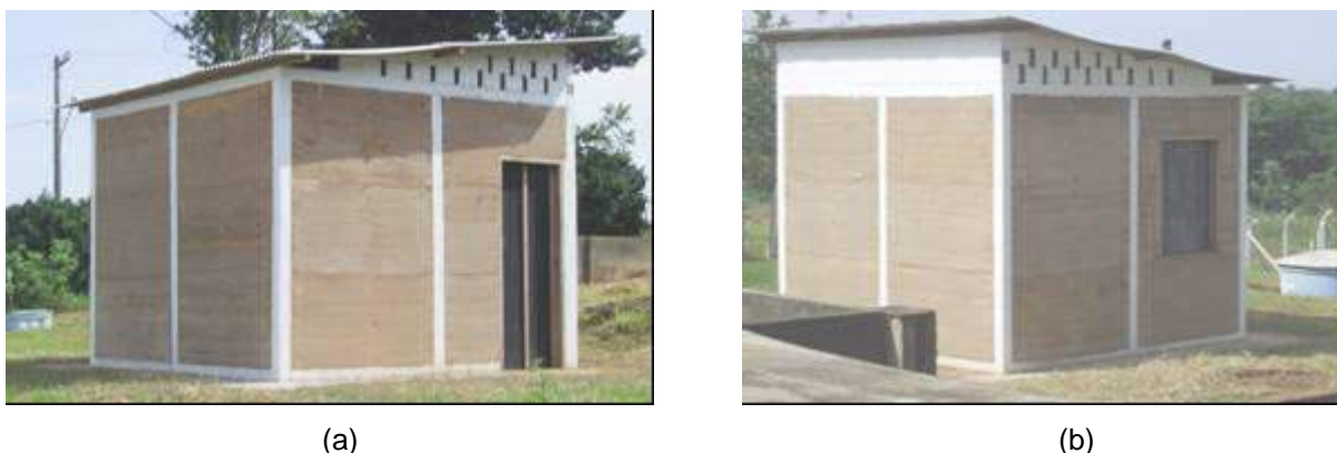
Figura 5 - Vista sul/oeste da edificação-protótipo (a) e vista norte/leste da edificação-protótipo (b).
