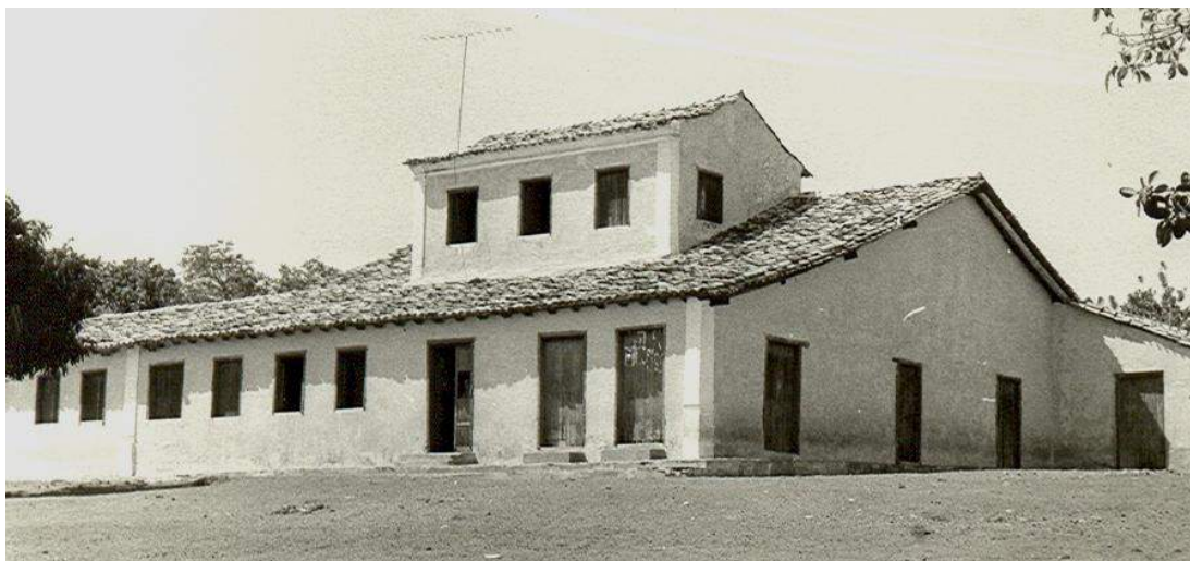
Figura 3 – Vista geral da Fazenda Tocaia, no município de Campo Maior. Único exemplar dessa arquitetura típica do Piauí, com 2 pavimentos
