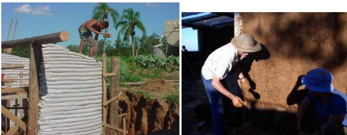
Figura 1 – Superadobe (a) e reboco de terra (b)
