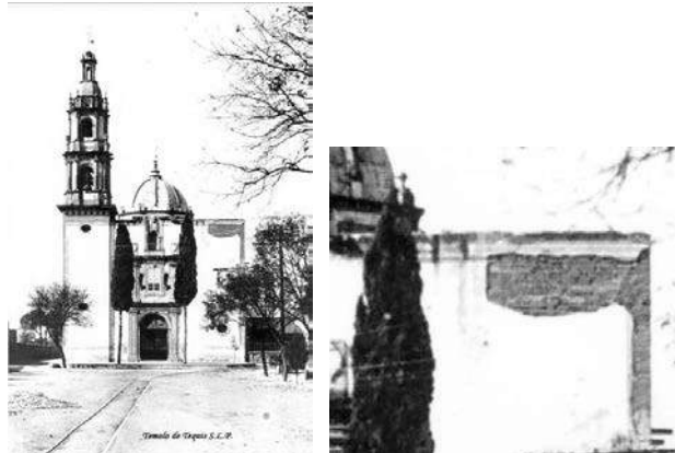
Figura 4 – Templo del barrio de Tequisquiapan; en la esquina derecha se observa el adobe
