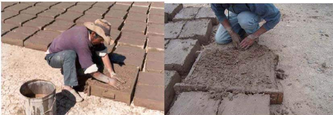
Adobes cuadrados para muro reforzado (Sistema ININVI, Peru)
