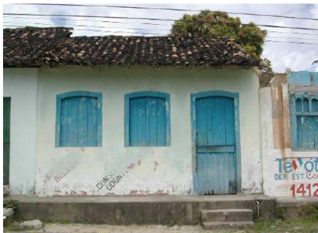
Figura 1 – Casa térrea em partido de meia-morada construída em taipa com cobertura em duas águas; cumeeira paralela à fachada; beiral simples em caibro
