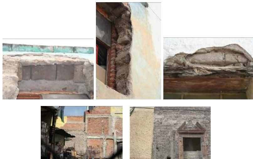
Figura 5 – Detalles del confinamiento del adobe por el ladrillo, cerramientos de madera para soportar el adobe y preparación con malla de gallinero para el repellado
