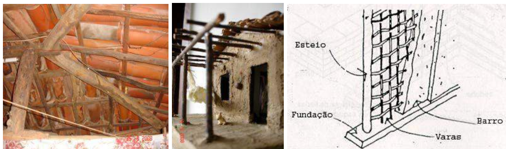
Figura 6 – Estrutura da cobertura e das paredes
