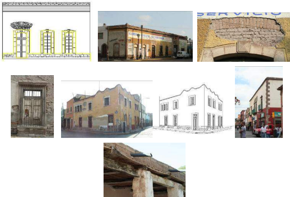
Figura 2 – El sistema constructivo en casas de uno y dos niveles en adobe, con marcos de cantería, sobrecimiento de piedra y el techo de terrado. San Luis Potosí
