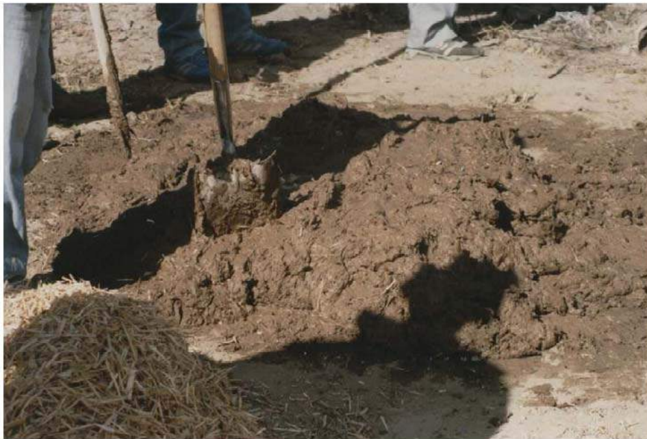
Preparando La mezcla de tierra, paja y agua
