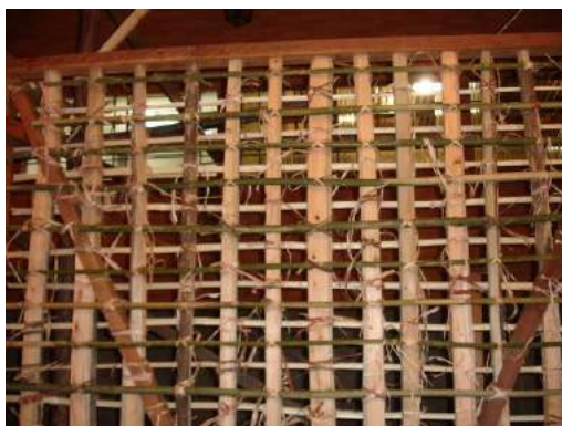
Figuras 3 e 4 – Execução da trama do pau-a-pique
