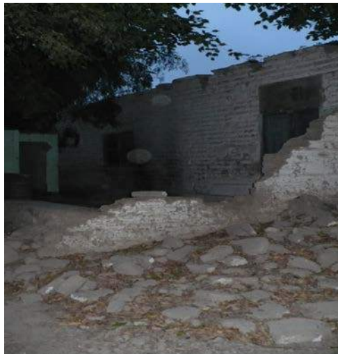
Figura 5 – Vivienda típica de adobe en Santa Luisa
