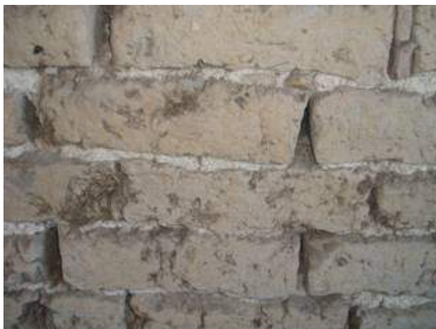
Figura 2 – Exemplo de parede interior elevada em adobe de palhão em Requeixo, Aveiro
