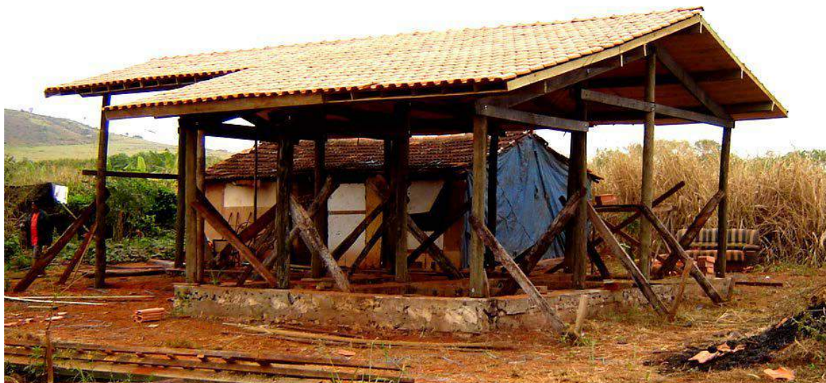
Figura 1 – Casa com sistema estrutural pilar-viga
