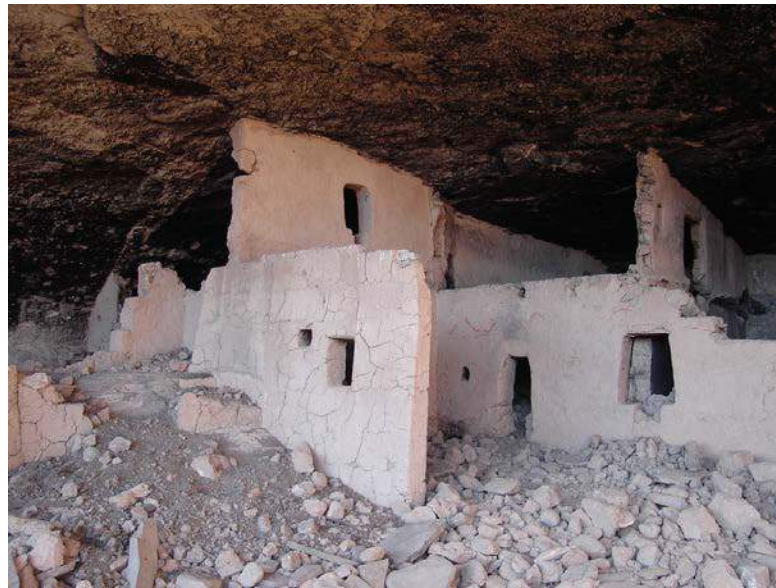
Figura 4 – La coincidencia de la puerta y el muro del lado derecho de la imagen, demuestra que éste fue colocado con posterioridad para subdividir el espacio interior. Cuevas de El Embudo
