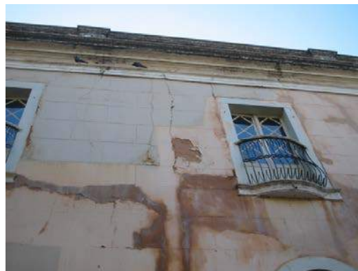
Figura 4 – Fachada lateral do casarão do Tatu em 2004, com o contraforteamento feito para impedir a abertura da parede. Trincas e falhas no reboco da Igreja da Boa Morte em 2004, antes da pintura atual em terra.
