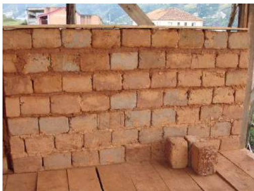
Figura 1 – Confeção de adobes para execução de parede
