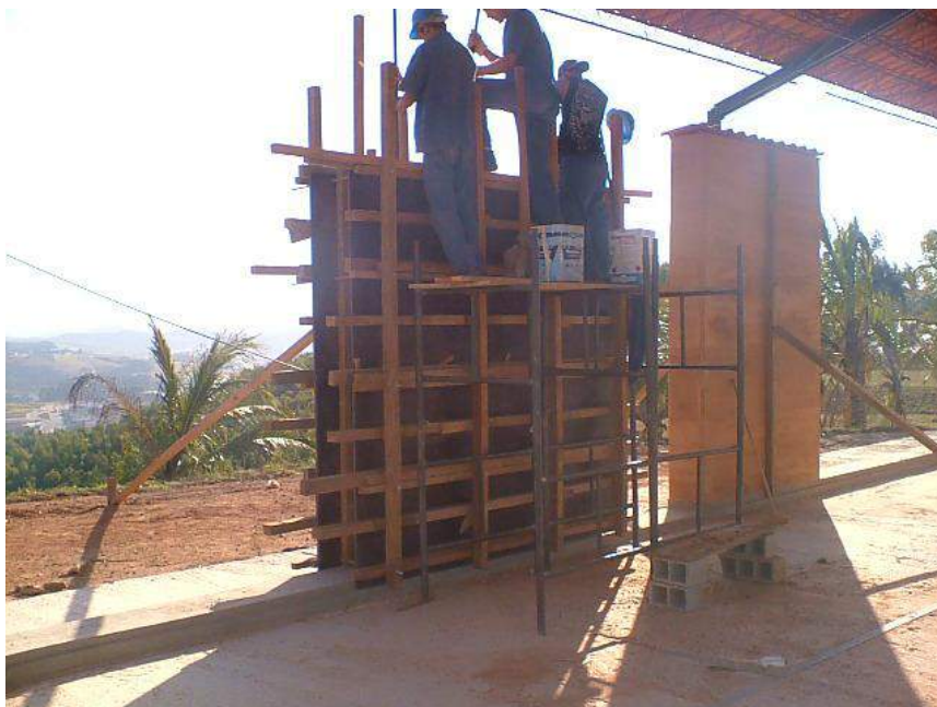
Figura 5 – Apiloamento de parede em taipa de pilão
