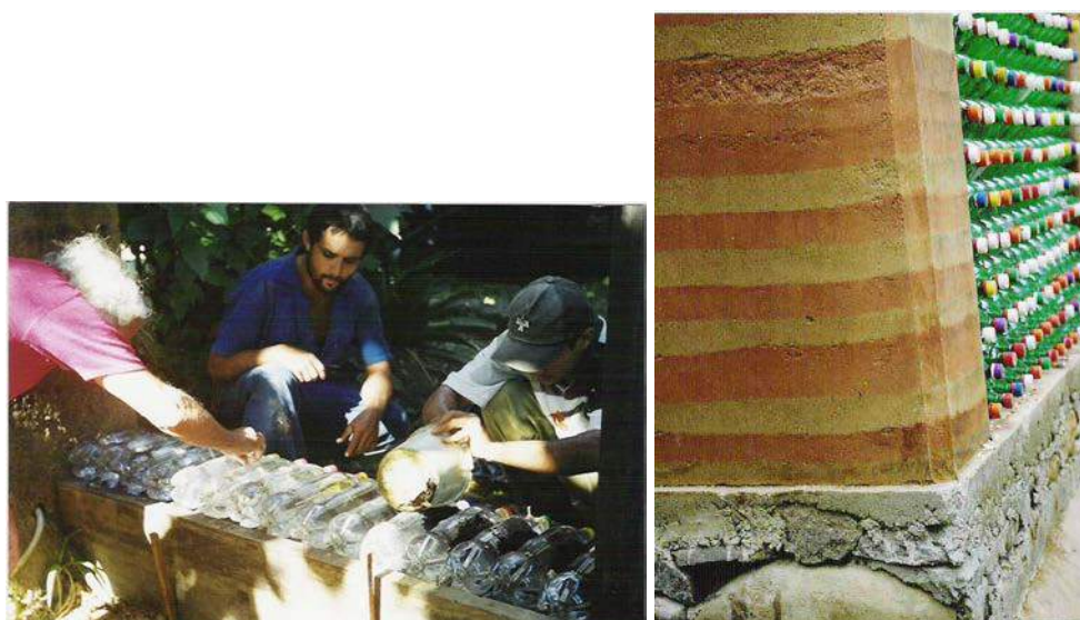
Figura 4 – Produção da parede de garrafas PET; cor e textura dos materiais taipa de pilão e garrafas PET
