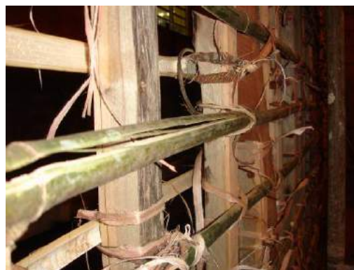
Figuras 3 e 4 – Execução da trama do pau-a-pique
