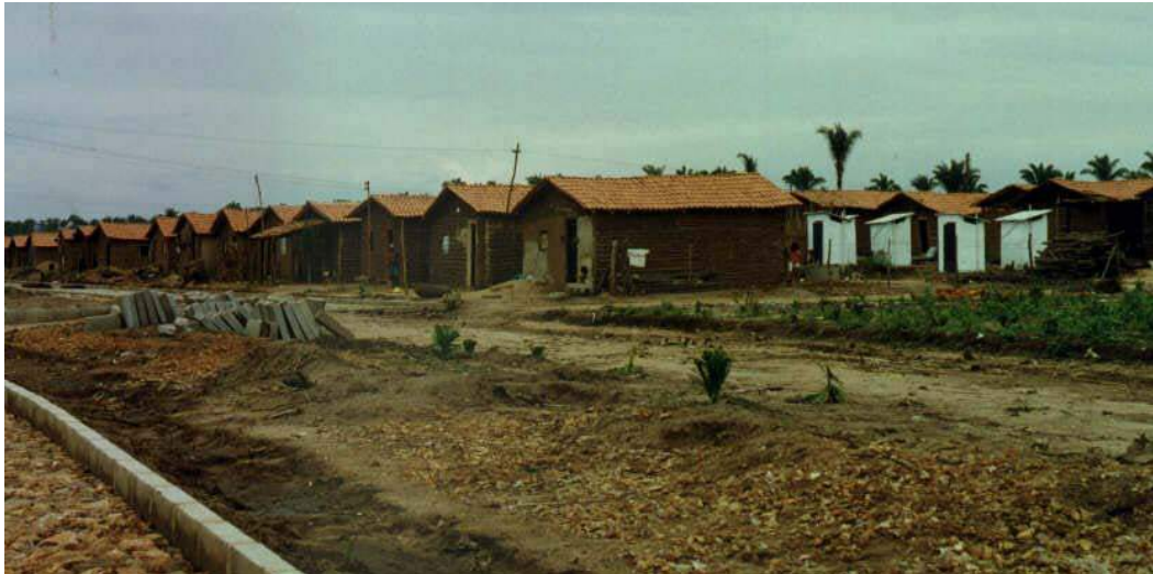
Figura 2 – Conjunto Parque Wall Ferraz, todo construído com taipa de mão, em 1996 Fonte: Wilza Lopes, 1997
