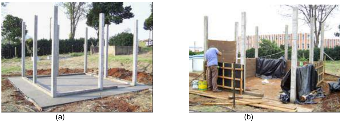
Figura 4 - Pilares e cinta de concreto (a) e compactação solo-cimento-cinza e cura das paredes (b).
