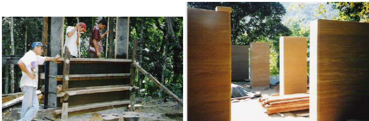
Figura 3 – Detalhe das fôrmas e das paredes de taipa durante a cura
