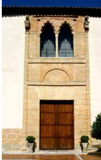
Figura 2 – Fachada principal del palacio. La ventana geminada, sobre las dovelas onduladas del dintel que cobija la puerta de acceso, se enmarca con los soportes que sostienen las figuras de los dos leones. A los lados, columnillas talladas en las esquinas de sillería
