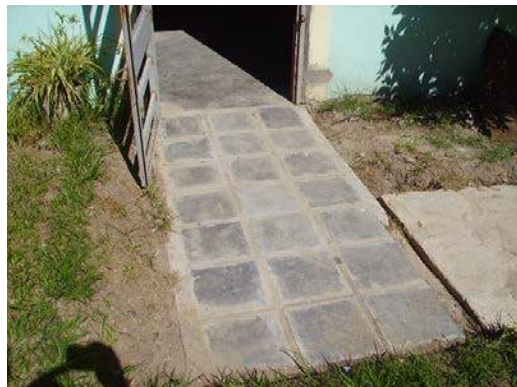
Figura 4 – Piso terminado con junta con mortero cementicio
