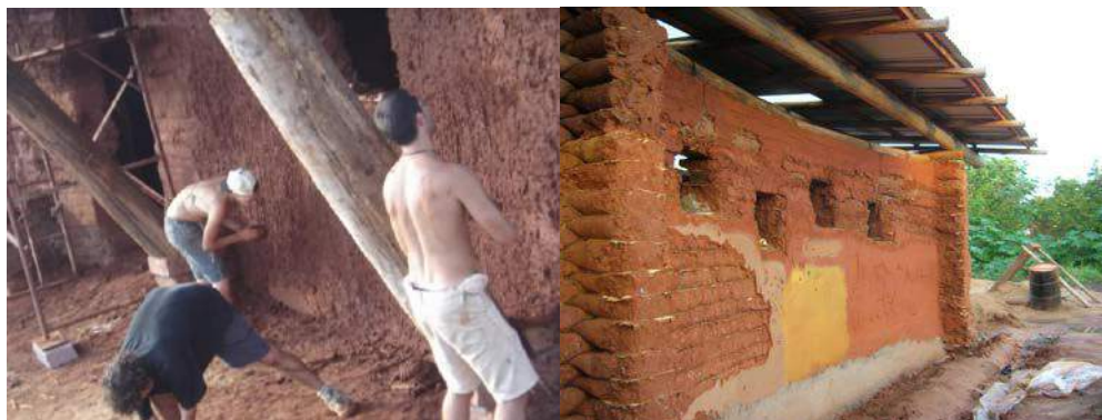
Figura 6 – Paredes de superadobe com provas de reboco – IMCA
