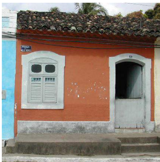
Figura 3 – Casa térrea em partido de meia-morada construída em taipa; coberta em duas águas; cumeeira paralela à fachada; beiral em beira-seveira
