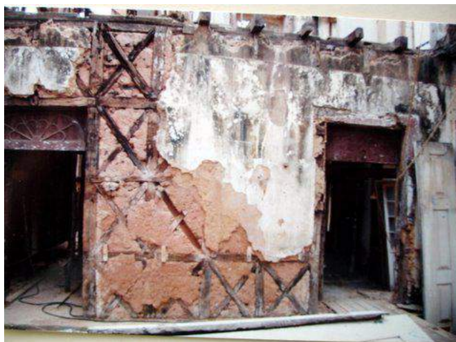
Figura 4 - Parede com estrutura de gaiola. Fonte: Arquivo da Superintendência do Patrimônio Cultural do Estado do Maranhão, 1992.
