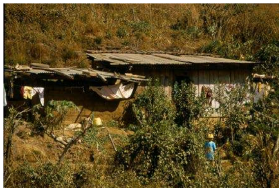
Figura 7 – Vivienda de madera. Infestada
