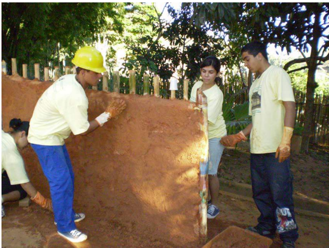
Figura 2 – Barreamento de parede em pau a pique
