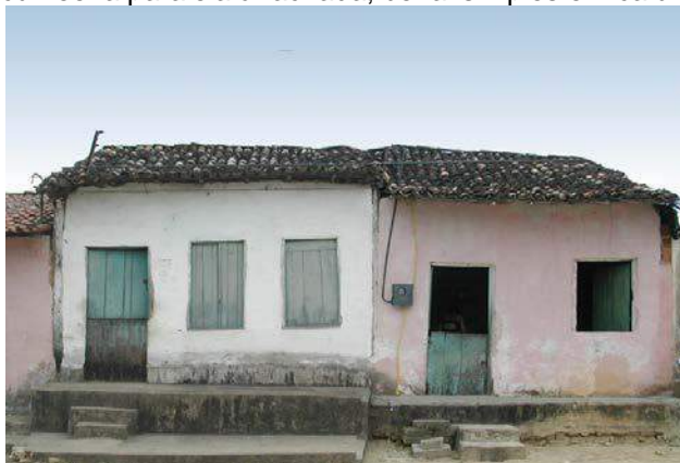
Figura 2 – Casas térreas (em parede de meia); ambas em partido de meia-morada construídas em taipa; cobertas em duas águas; cumeeiras nivelada e paralelas à fachada; beiral simples em caibro
