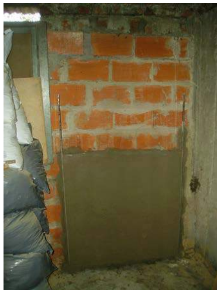
Figura 5 – Revoque bicapa con tosca estabilizada sobre ladrillo cerámico hueco
