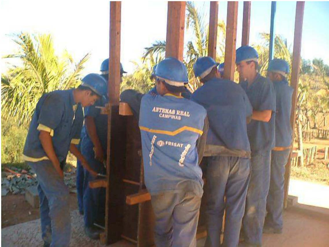
Figura 4 – Montagem de forma de taipa de pilão
