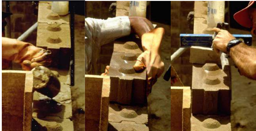
Figura 1 – Blocos Mattone e execução de alvenaria
