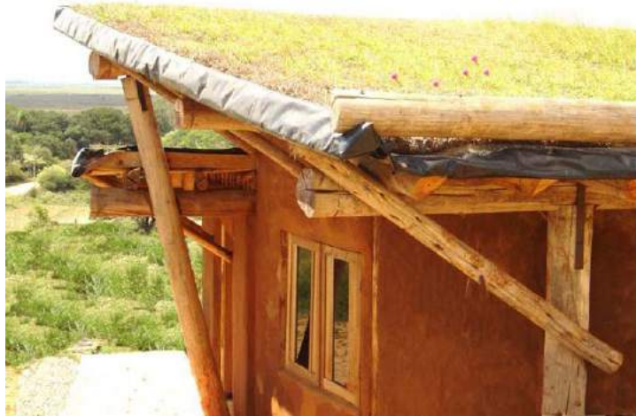
Figura 2 – Telhado vivo (b)
