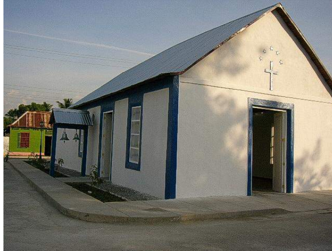
Figura 3 – Iglesia San Antonio después de la intervención. Fuente: Empresa Arquiluz, 2007
