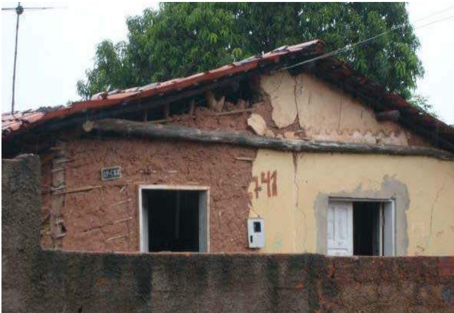
Figura 5 – Casa de taipa de mão, vendo-se a madeira flexionada Fonte: Thiago Melo, 2008
