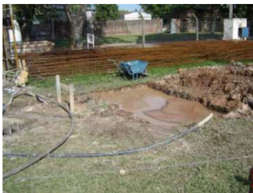
Figura 3 – Barros de excavación de pilotes
