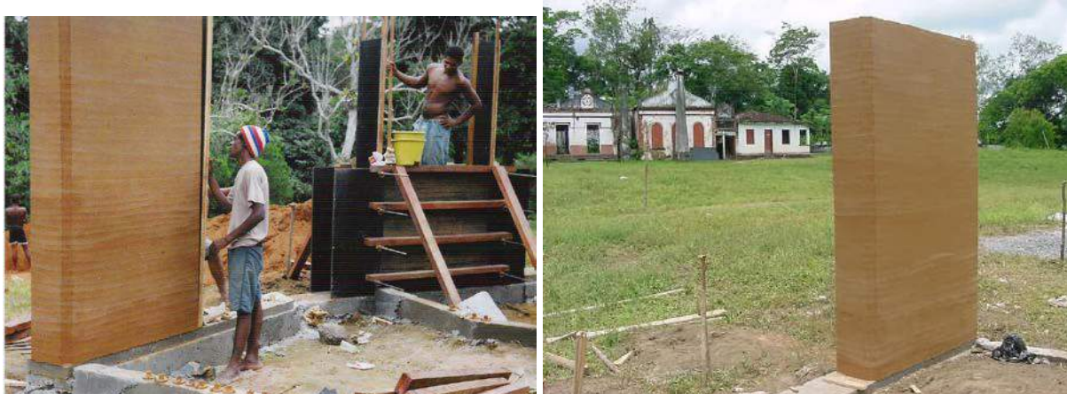
Figura 5 – Construção do Centro Comunitário em Ilhéus
