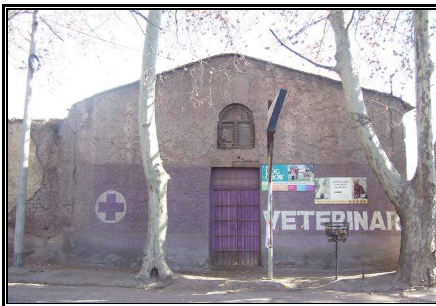
Figura 1 – Fachada del edificio
