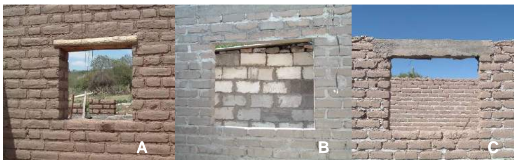
Figura 5 – Distintos casos registrados: A- muro adobón-dintel triple rollizo; B- muro BSC-dintel de junta reforzada 2\Phi 8 ; C- muro adobe-dintel de hormigón armado
