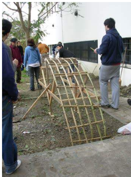
Figura 6 – Caña, malla de alambre y suelo cemento, con cimbra
