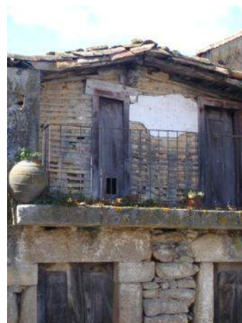
Figura 1.b - Construção com paredes exteriores em tabique nos pisos superiores
