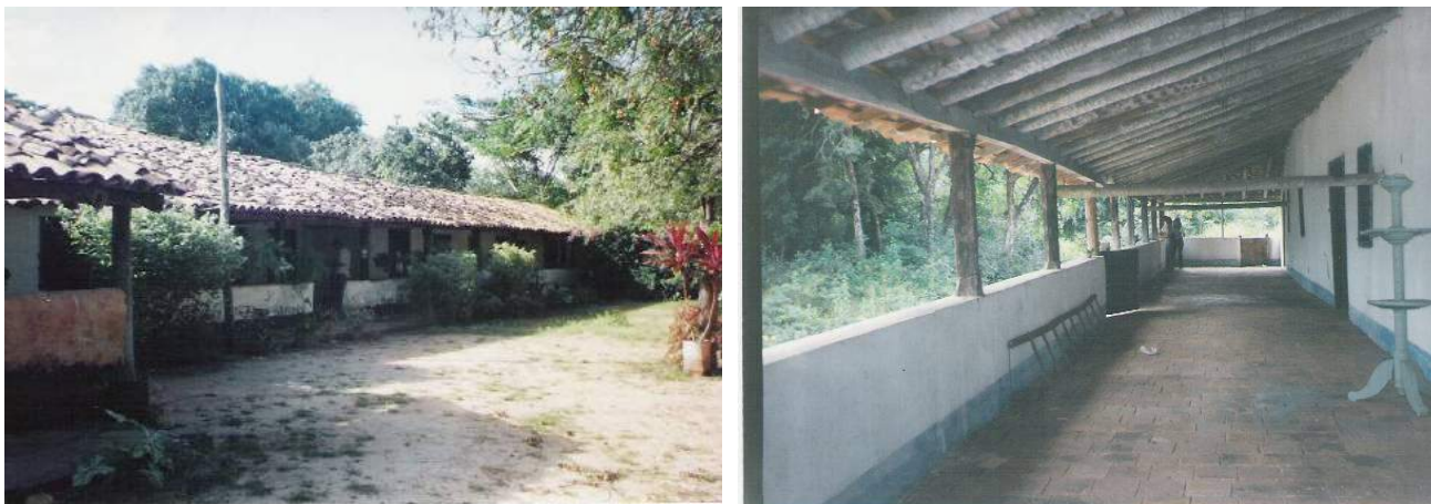
Figura 4 – Fachada principal e vista da varanda principal da Fazenda São Domingos
