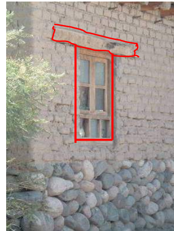
Figura 4 – Dintel de madera (doble sección que abarca el espesor del muro)
