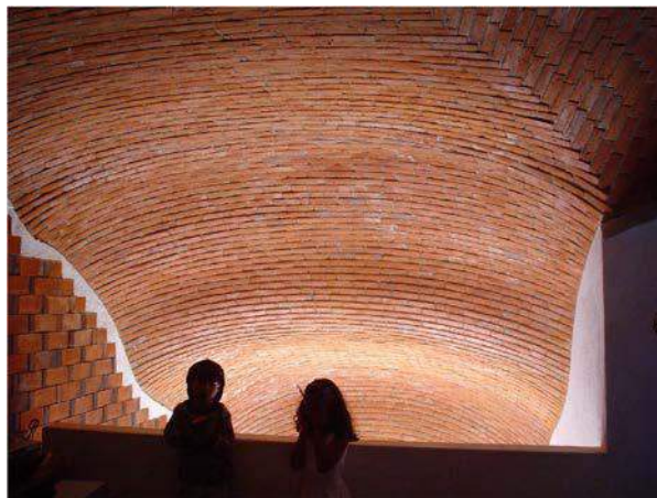
Figura 4 – Bóveda de ladrillo Ciudad de México generatriz y directriz ondulada
