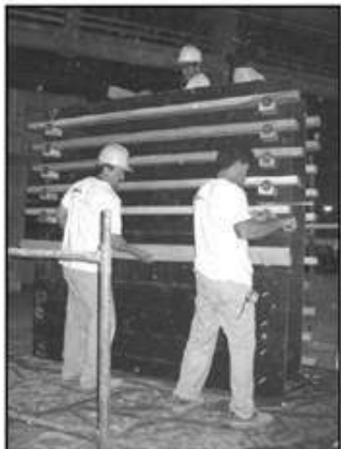
Fôrma de madeira
