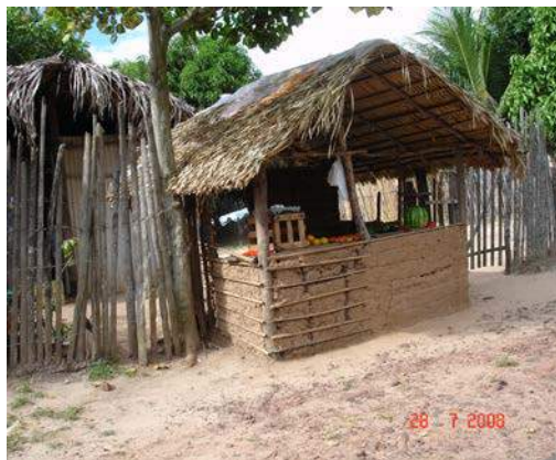
Figura 2 – Estrutura de taipa com galhos de mangue, Araçagy
