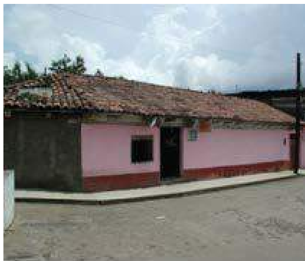
Figura 3 – Vivienda tradicional de la Cañada que muestra el predominio del macizo sobre el vano, el acceso al zaguán y la cubierta a dos vertientes
