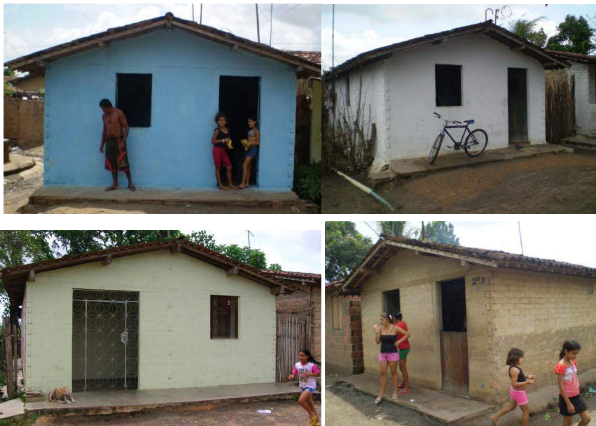
Figura 3 – Casas típicas feitas com os blocos de terra comprimida, na Favela Cuba de Baixo
