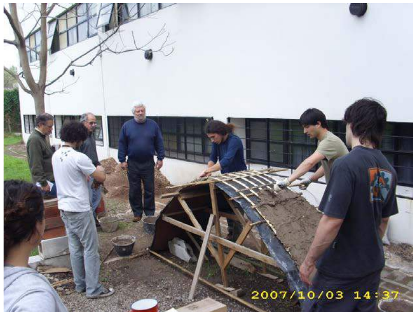
Figura 7 – Caña, malla de alambre y suelo cemento, con cimbra y encofrado
