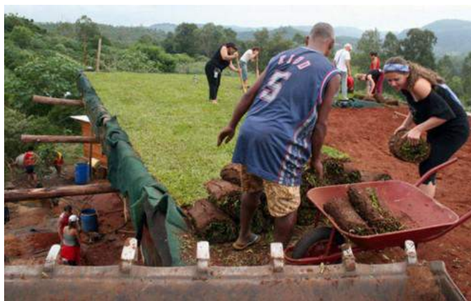
Figura 5 – Mutirão de construção do telhado vivo – IMCA
