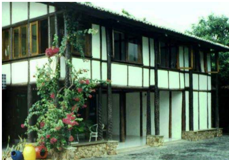
Figura 1 – Casa em taipa de mão, na cidade de Teresina, do arquiteto Paulo Frota Fonte: Wilza Lopes, 1997
