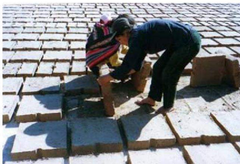
Adobes cuadrados para muro reforzado (Sistema ININVI, Peru)
