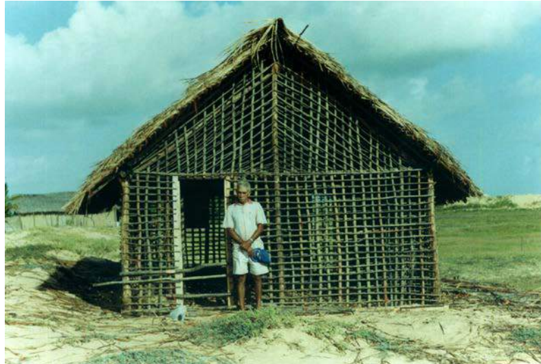
Figura 1 – Casa pronta para o tapamento
