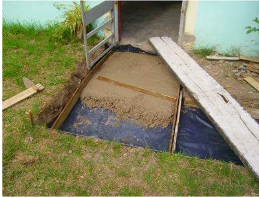
Figura 2 – Contrapiso colado con tosca estabilizada
