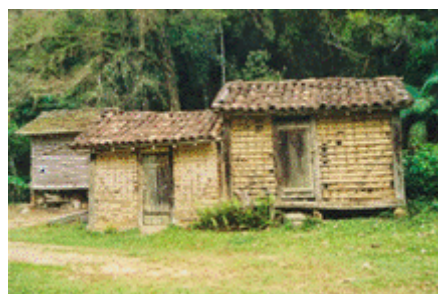
Imagem 18 – Casa construída com adobe. As madeiras estruturais horizontais e o barro que remetem à poética das minhas obras
