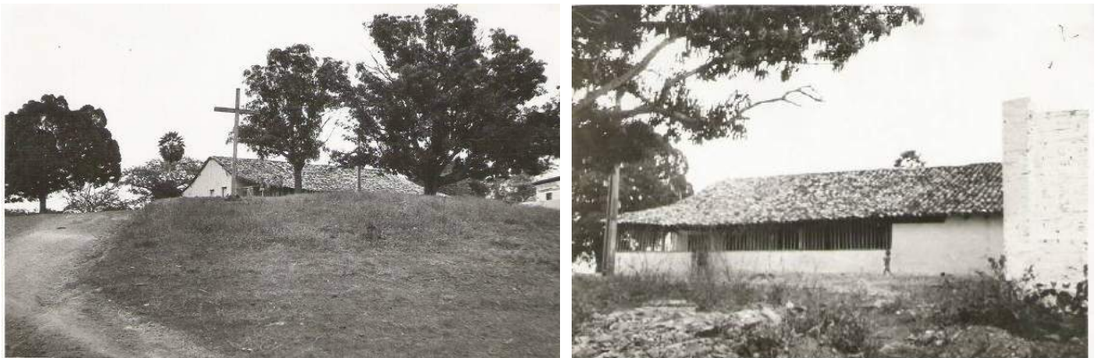
Figura 6 – Acesso e fachada lateral da Fazenda da Dona Alemã
