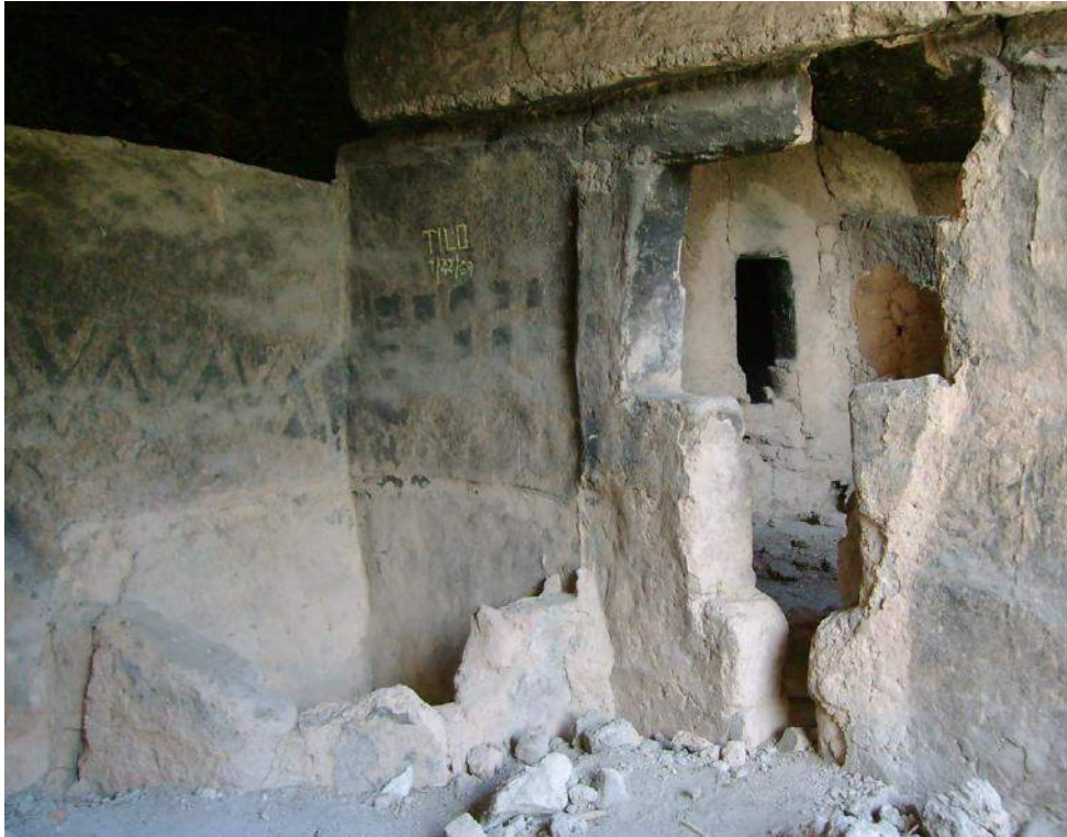
Figura 5 – Graffiti realizado en 1969 sobre las pinturas murales de una habitación en Sírupa
