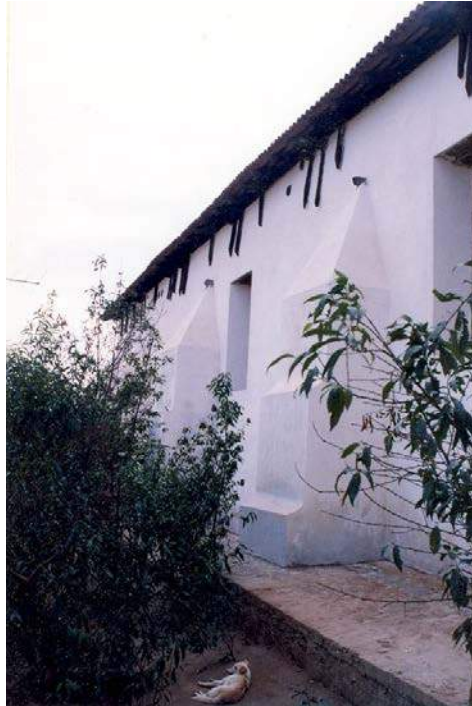
Figura 6 - Muro de adobe y cubierta de madera reconstruidos. Fotografía: Luis Torres
