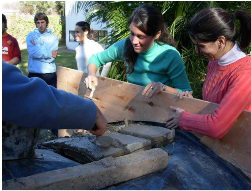
Figura 5 – Dovela de ladrillos de adobe estabilizado
