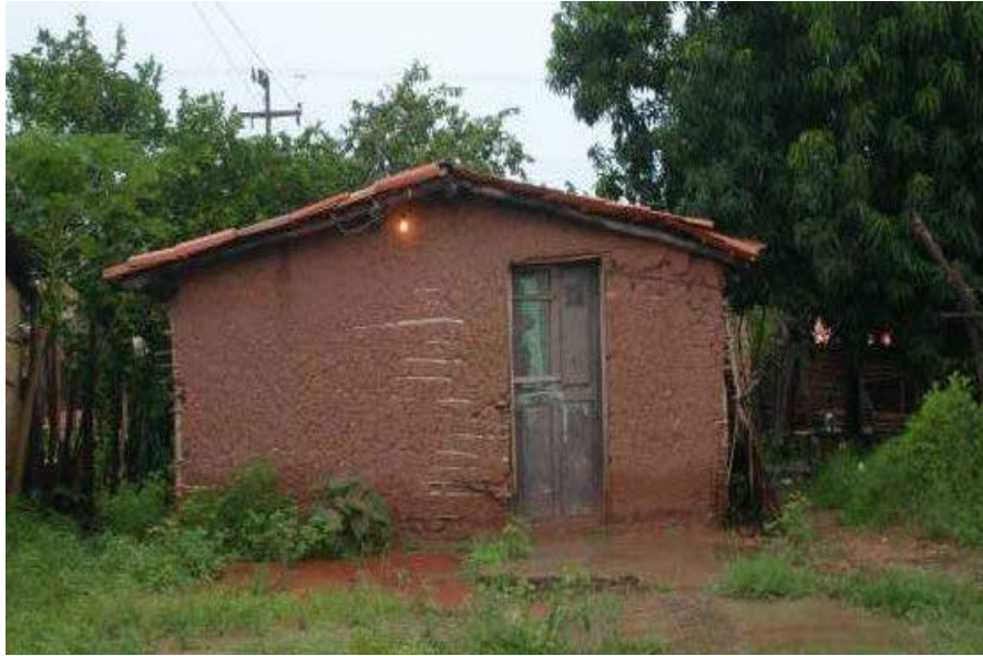
Figura 4 – Casa de taipa de mão sem reboco Fonte: Thiago Melo, 2008
