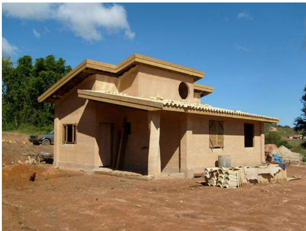
Figura 6 – Casa dos colonos em alvenaria estrutural de BTC
