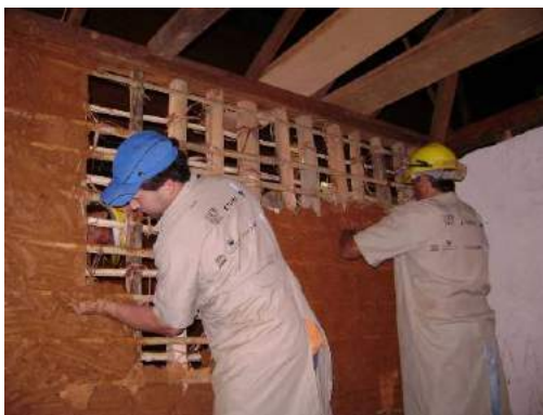
Figura 2 – Preenchimento do pau-a-pique com barro
