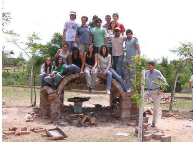
Figura 3 – Taller de construcción de bóveda de BTC y ladrillo, en Santa Fe, Argentina
