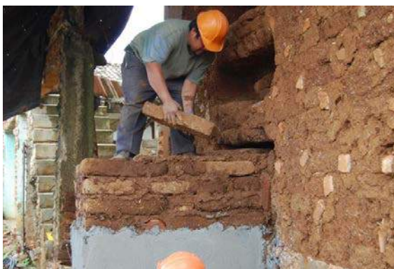
Figura 6 – Obras de rehabilitación con adobe, templo de Villa Madero, Mich. Fotografía: Luis Torres
