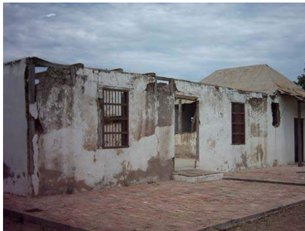
Figura 4 – Fachada posterior antes de la intervención – Casa Rafael Urdaneta. Fuente propia, 2007
