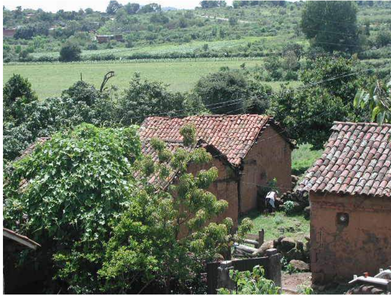
Figura 1 – Muestra la baja densidad de construcción y el aprovechamiento del huerto para autoconsumo, destaca la cubierta a dos vertientes
