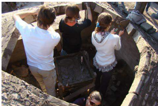
Figura 2 – Proceso constructivo. Foto: Elian Hirsch
