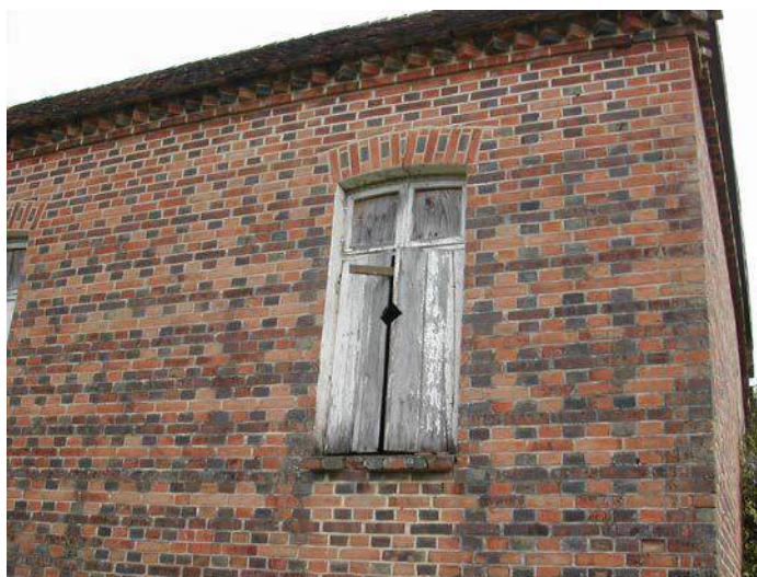
Figura 6 – Casa de alvenaria de tijolos aparentes
