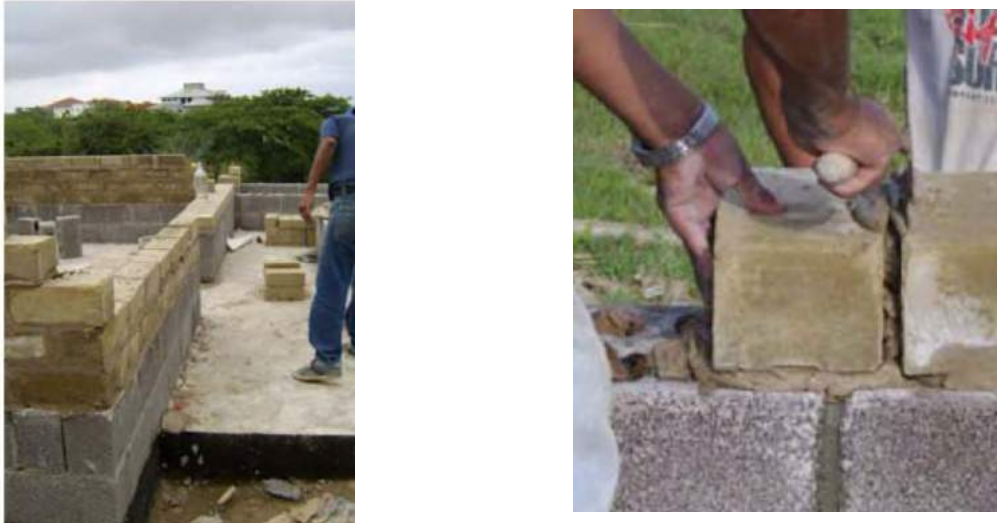
Figura 2 – Detalles de colocación del BTC en el modelo de vivienda
