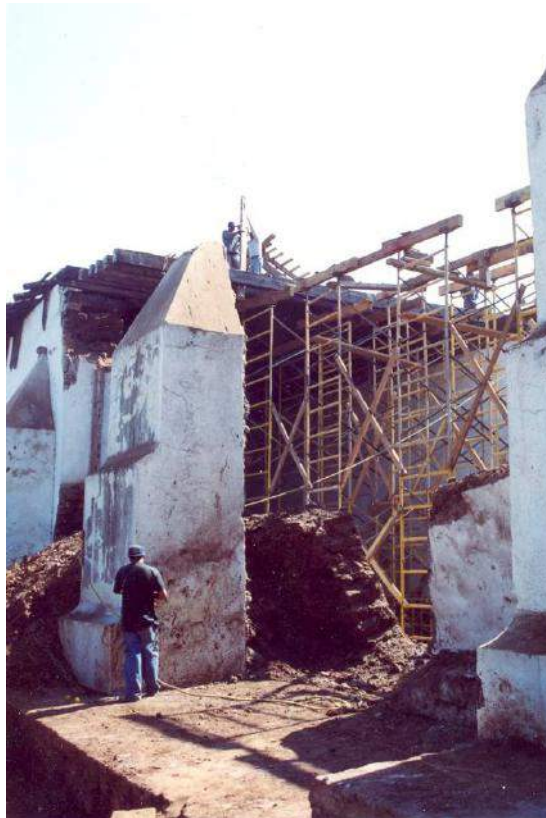
Figura 5 - Obras de reconstrucción de muros y cubierta. Fotografía: Ulices Chávez
