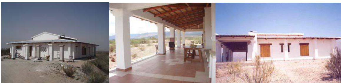
Figura 4 – Vistas de acesso com pilares para pérgola - galeria - frente Sudoeste
