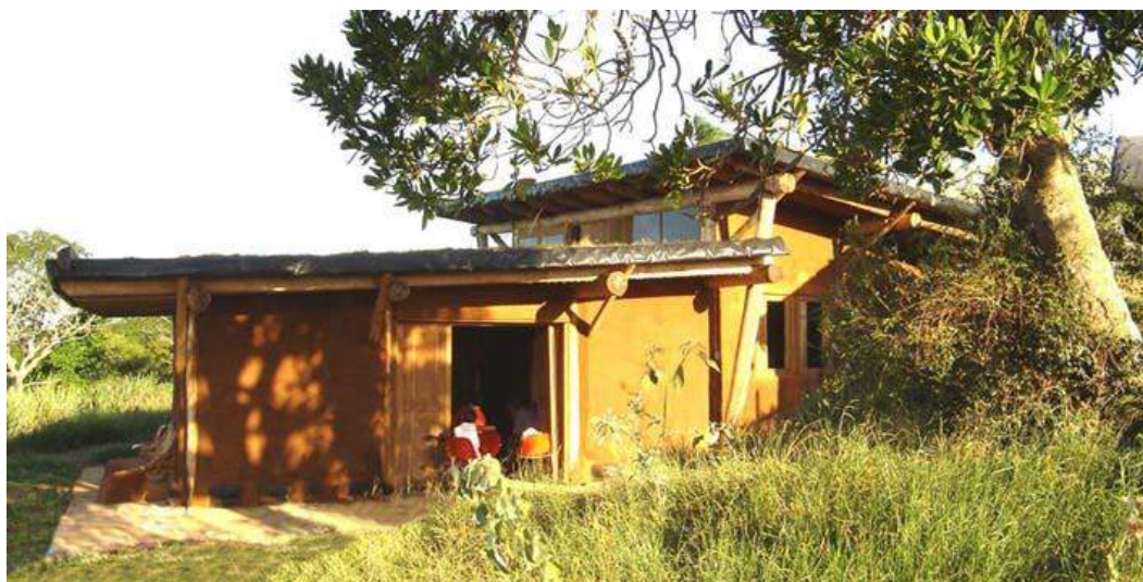
Figura 4 - Oficina do Assentado – obra concluída
