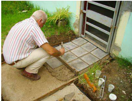
Figura 3 – Colocación de las baldosas con mortero de tosca estabilizada
