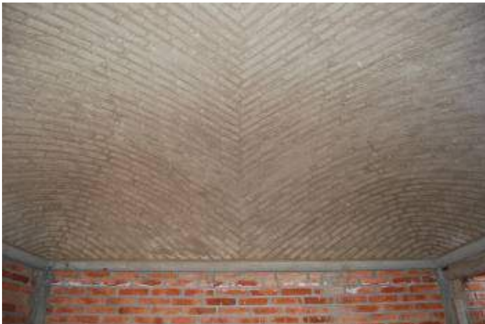
Vista interior del espacio abovedado.
