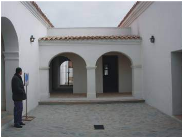
Imagen 5.- Detalle del patio de casa Radich, una vez terminada la intervención en el Pueblo de San Carlos. Valles Calchaquíes - Salta Argentina.
