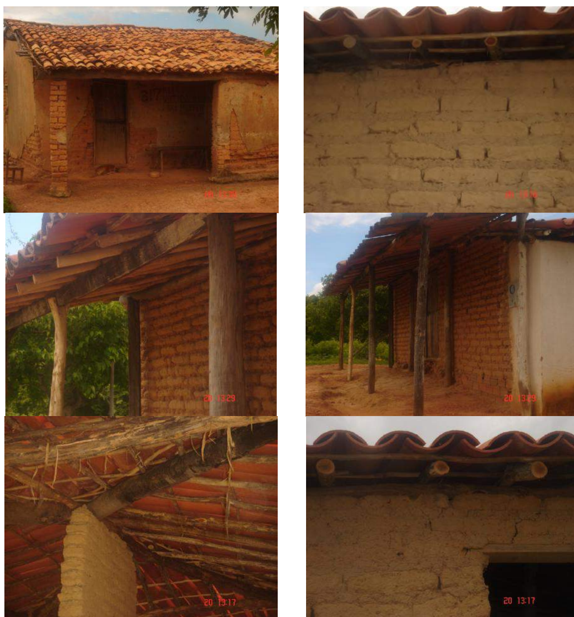
Figura 04 – Detalhes construtivos das construções em adobe.
