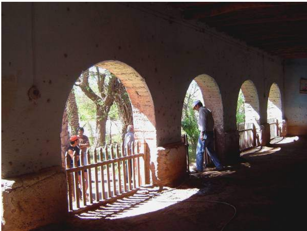
Figura 3 – Casa Pazos – Vinchina – Vista del interior de la galería-
