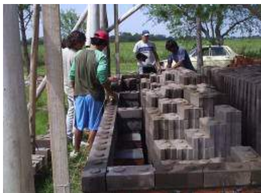
Figuras 4 y 5: Taller de mampostería de bloques de tierra comprimida para constructores locales.
