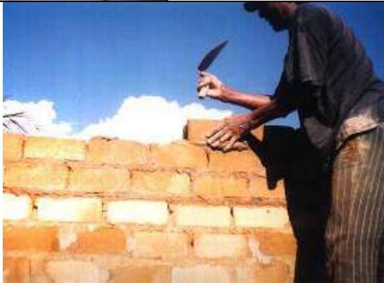
Foto 05- Processo construção de casas p/ população
