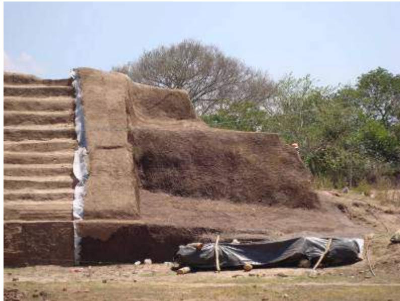
Figura 5. El revoque de sacrificio sobre el geotextil.
