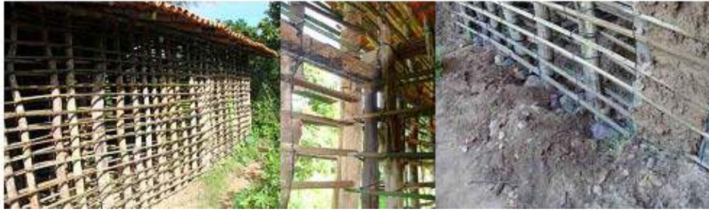
Figura 1 – Entramado na área externa, entramado na área interna e fundação das varas do entramado.
