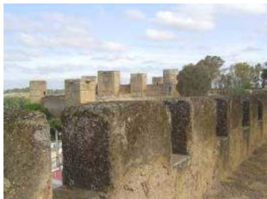
Foto 4: Vista general desde explanada superior
