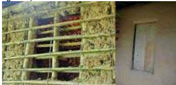
Figura 4 – Aplicação das janelas.
