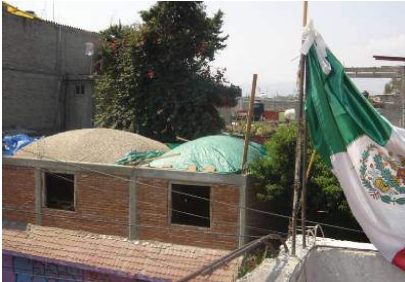
Vista exterior de bóveda, casa en el barrio de santo domingo.
