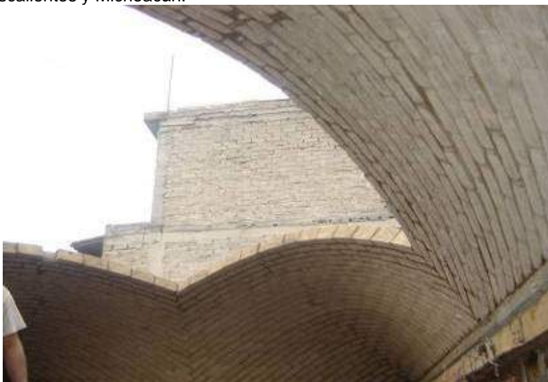
Vista interior del espacio abovedado.
