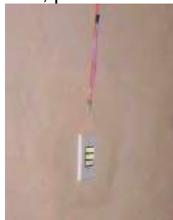
Figura 5 – Aplicação de instalação elétrica.
