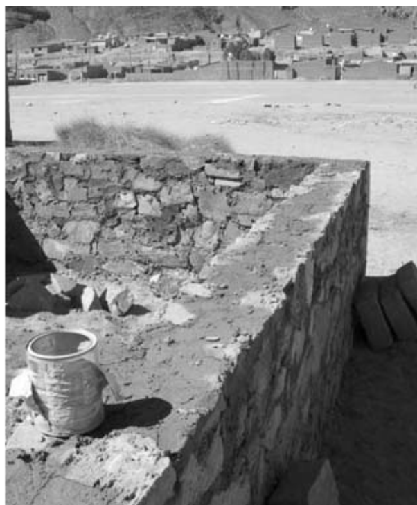
Fig. 5 (Izq.) Elevación de sobrecimiento de 40 cm. de ancho, al fondo se observan los adobes para completar el muro. Puesto rural, Susques, 2007.
