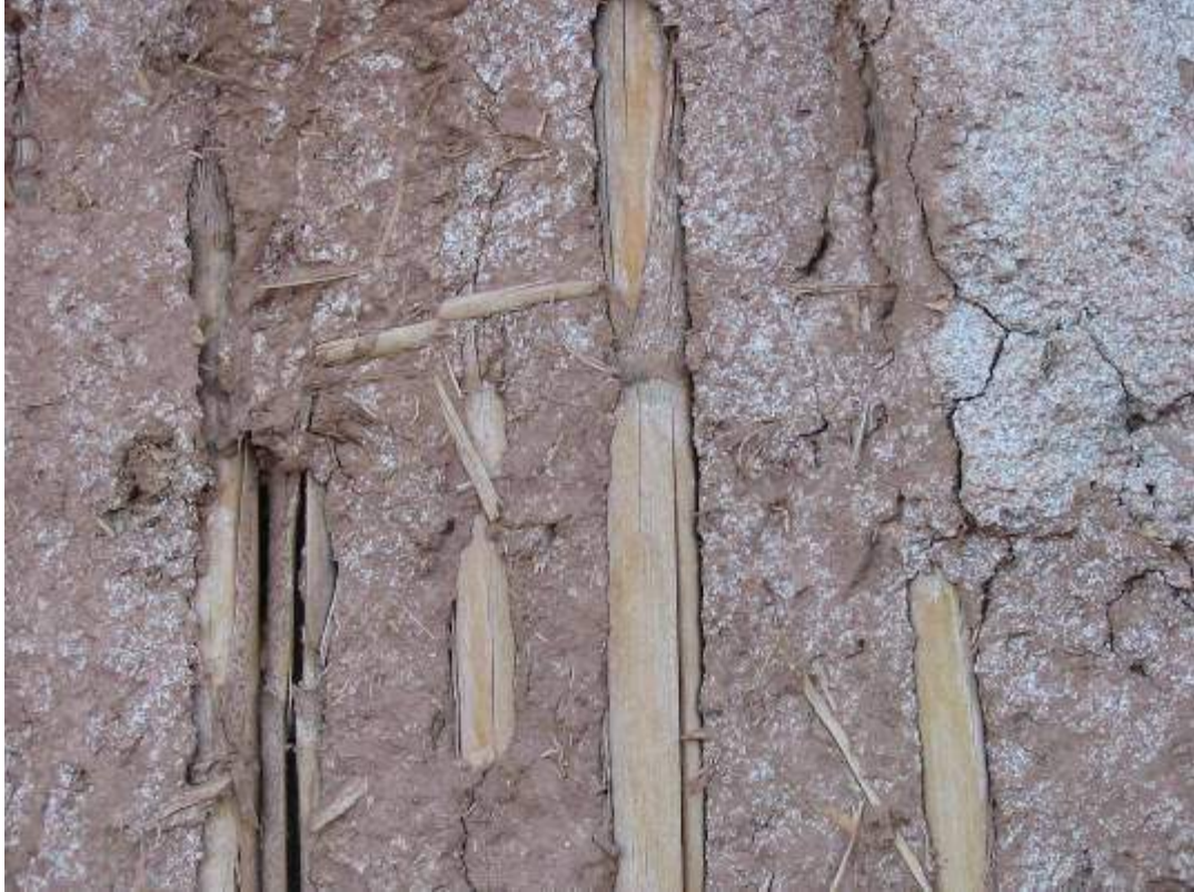
Técnica de bahareque embutido en Villa Unión – La Rioja
