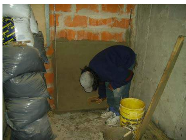
Figura 3: Prototipo de revoque de suelo-cemento-cal (Florencio Varela)
