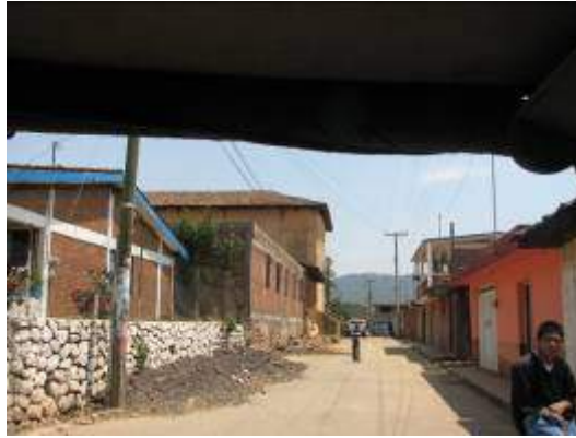
Fig. 4 Vista exterior del muro testero (Fotografía F. Méndez).
