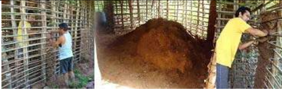
Figura 3 – Preenchimento do entramado e barro armazenado.
