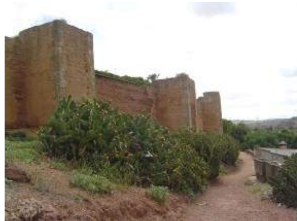
Foto 6: Lienzo muralla antes de puerta del Buey
