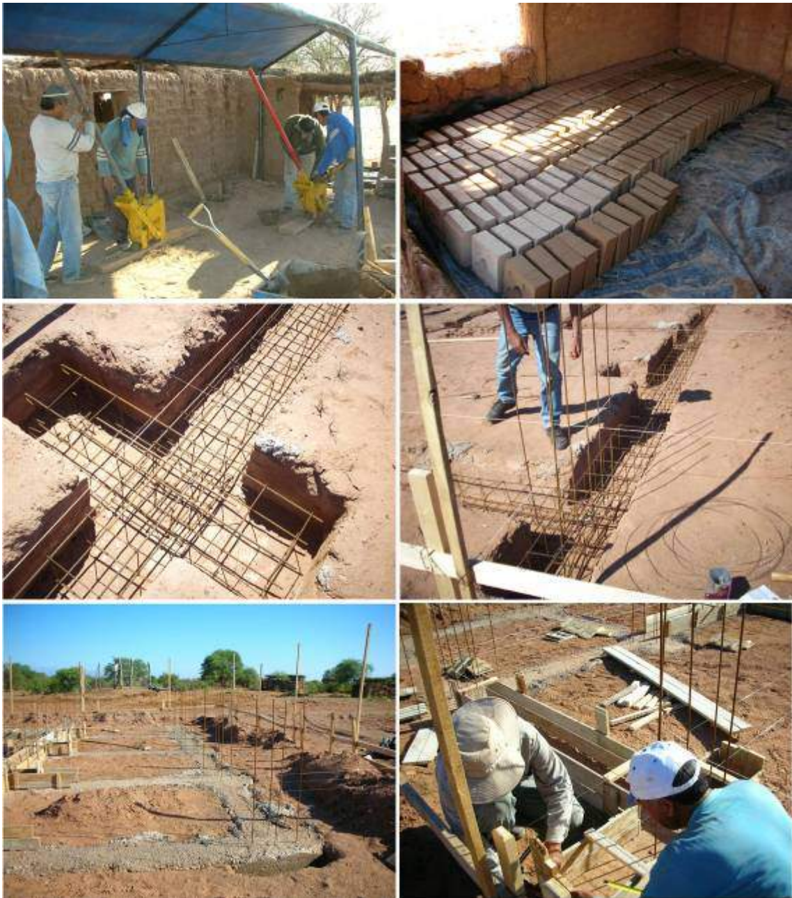
Fig. 4. Arriba: Operarios fabricando los mampuestos de suelocemento con dos prensas IRPHa-RAM. Al medio: Armadura horizontal y vertical en la zanja de la zapata corrida. Abajo: Zapata armada hormigonada y armado de encofrado del sobrecimiento.
