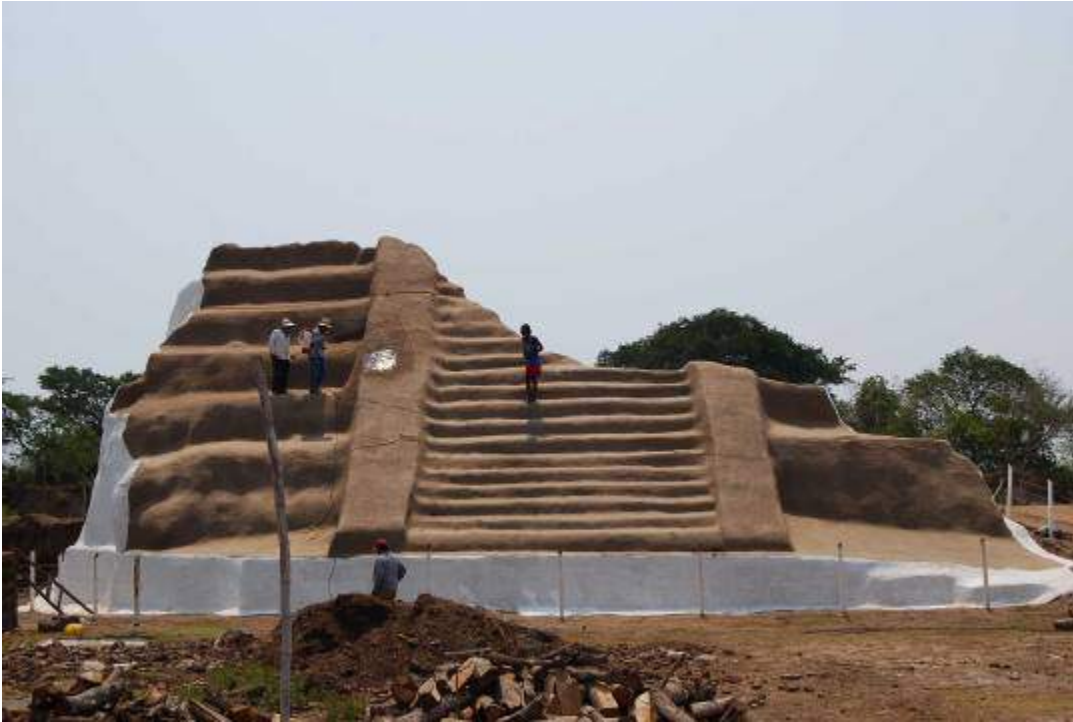
Figura 6. Aplicación de la emulsión hidrofugante por aspersión.
