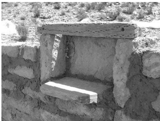
Fig. 5. Detalle de hornacina de adobe con base de laja y dintel de cardón, Susques, 2007.
