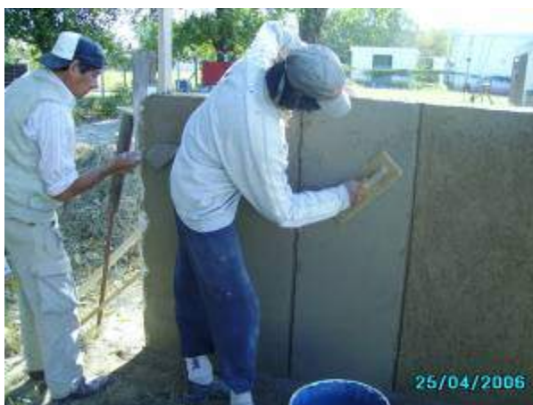
Figura 2: Prototipos de revoque de suelo-cemento y suelo-cemento+estiércol (Florencio Varela)
