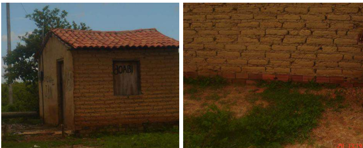
Figura 03 – Utilização de tijolos furados como baldrame das paredes de adobe.
