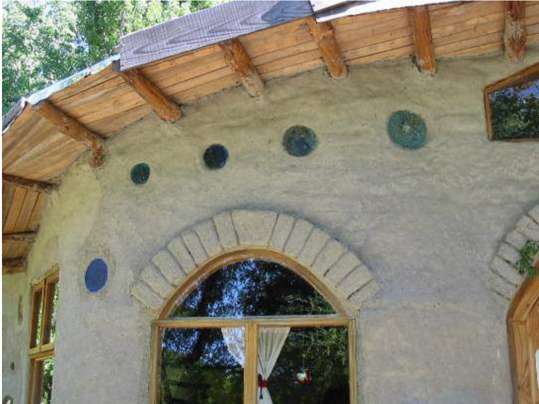
Construcción con cob en Golondrinas – Chubut
