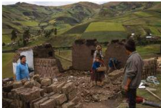
Fotografía 13 Construcción en adobe ejecutada fuera de normativas, es muy susceptible de sufrir la disgregación de sus muros.
