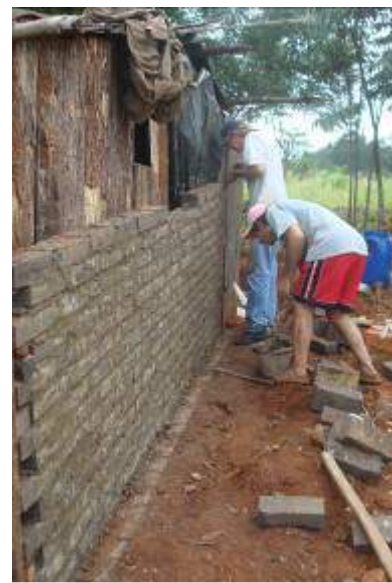
Imag.2 construcción de nuevos muros
