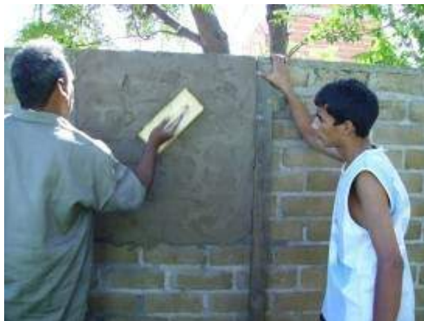
Figura 4: Revoque grueso con fratacho (Bancalari)
