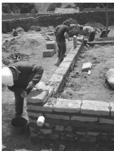
Fig. 3. Colocación de adobe esquinero y elevación de muro sogá , Rinconada, 2007.
