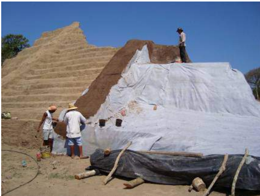
Figura 4. Colocación del geotextil y la superficie de sacrificio para su protección.
