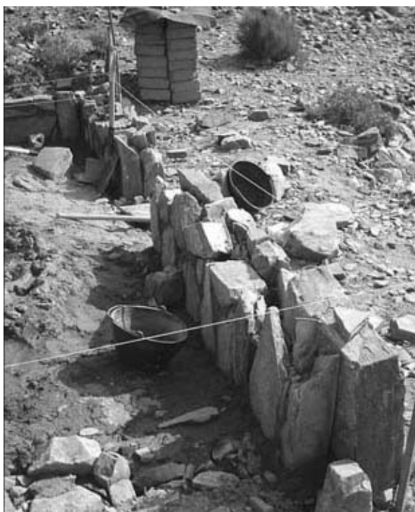
Fig. 5 (Izq.) Elevación de sobrecimiento de 40 cm. de ancho, al fondo se observan los adobes para completar el muro. Puesto rural, Susques, 2007.
