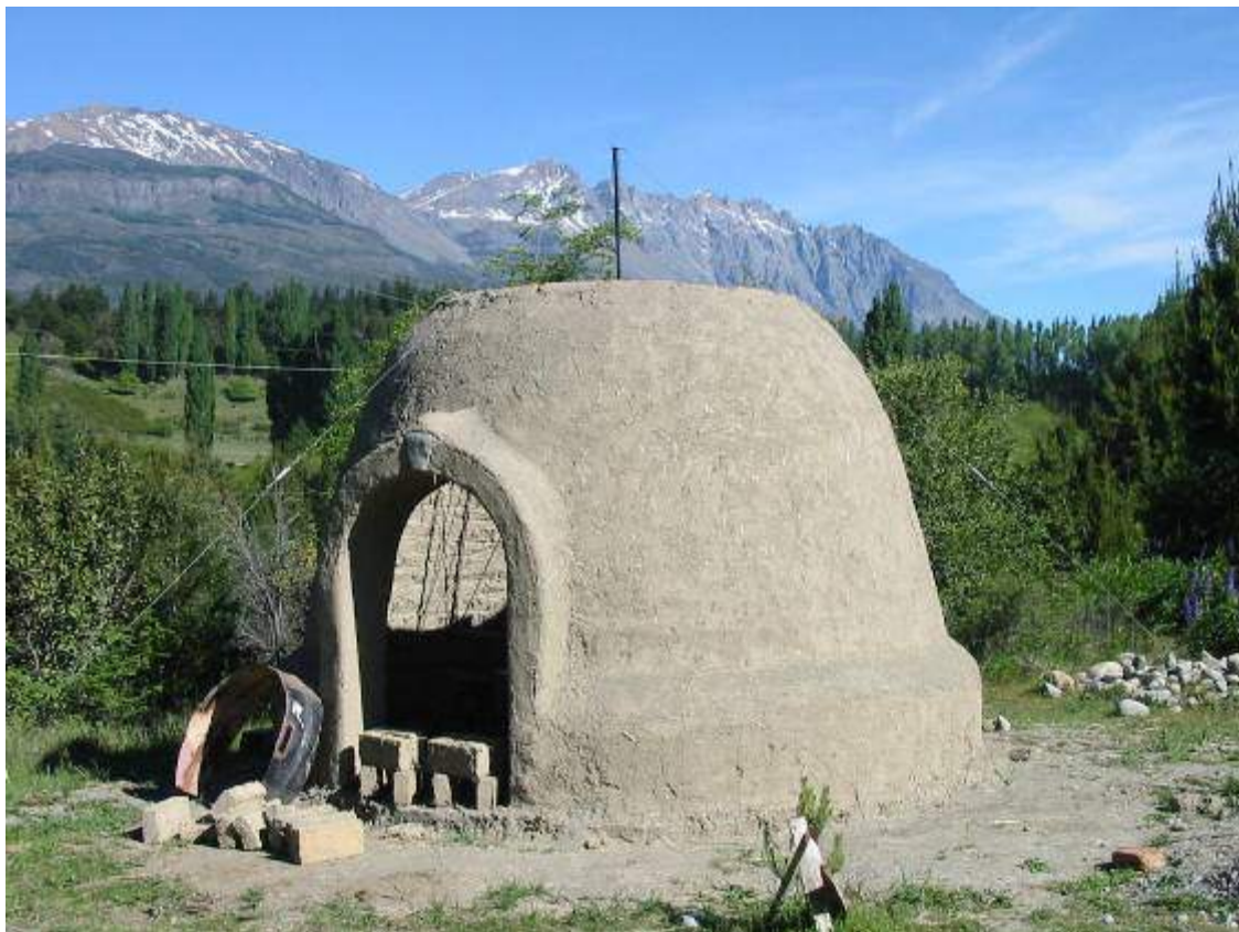
Construcción con adobe en Golondrinas - Chubut
