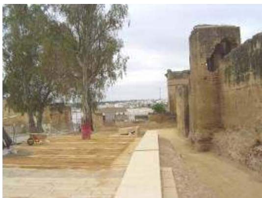
Foto 3: Lienzo muralla acceso Alcazar, en obras.
