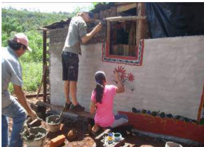
Imag 4. Tarea comunitaria: construcción y pintura
