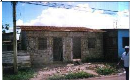
Foto 08-Casa em bloco de argamassa
