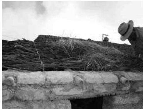
Figura 3, colocación del cijne por parte de un maestro constructor, Rinconada 2008.
