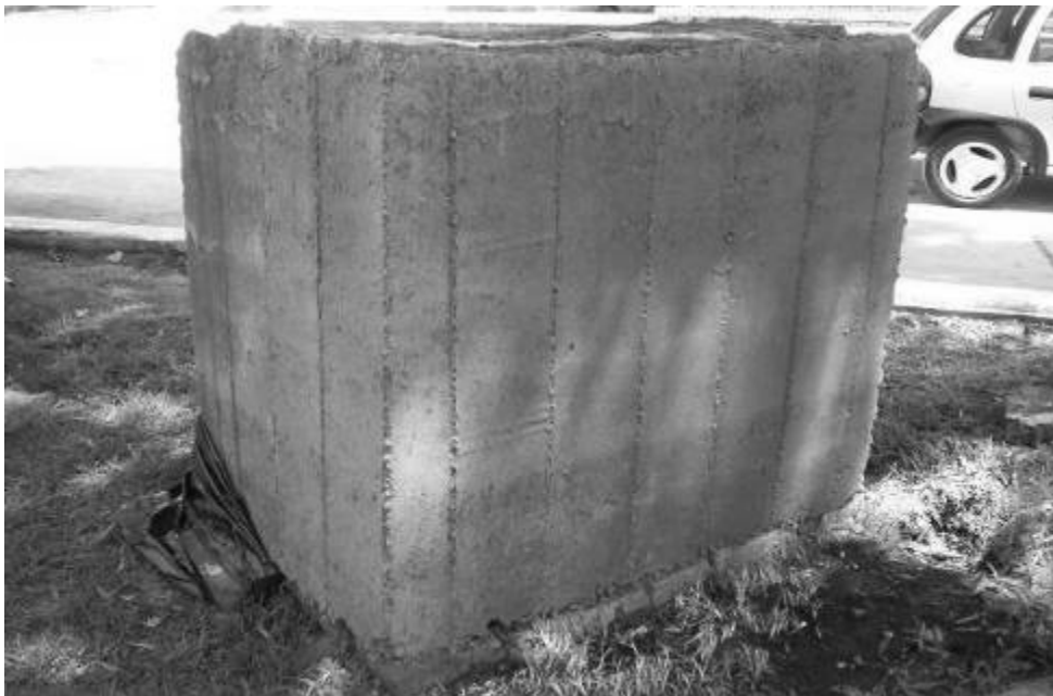
Figura 4. Muro con estabilizante a 15 días de terminado, el acabado de estos es mas liso.
