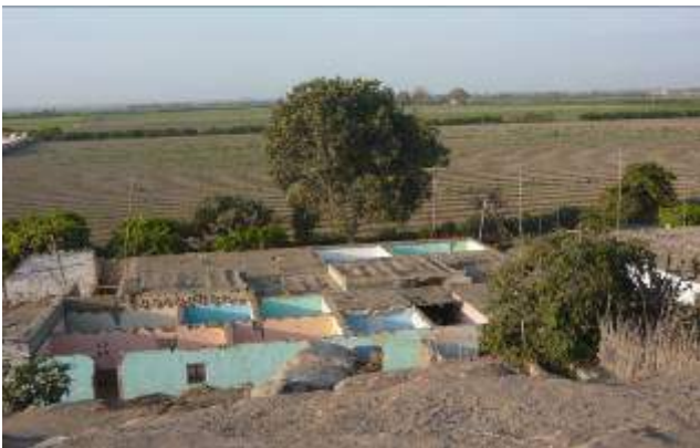
Figura 1 – Vivienda típica de adobe en Santa Luisa
