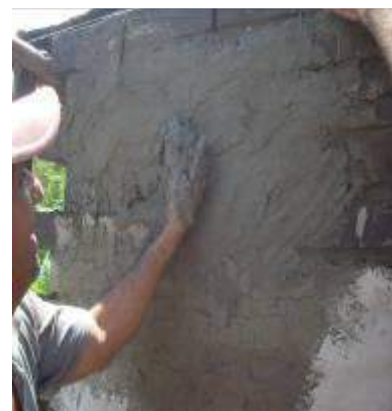
Imag3. Aplicación de Revoque
