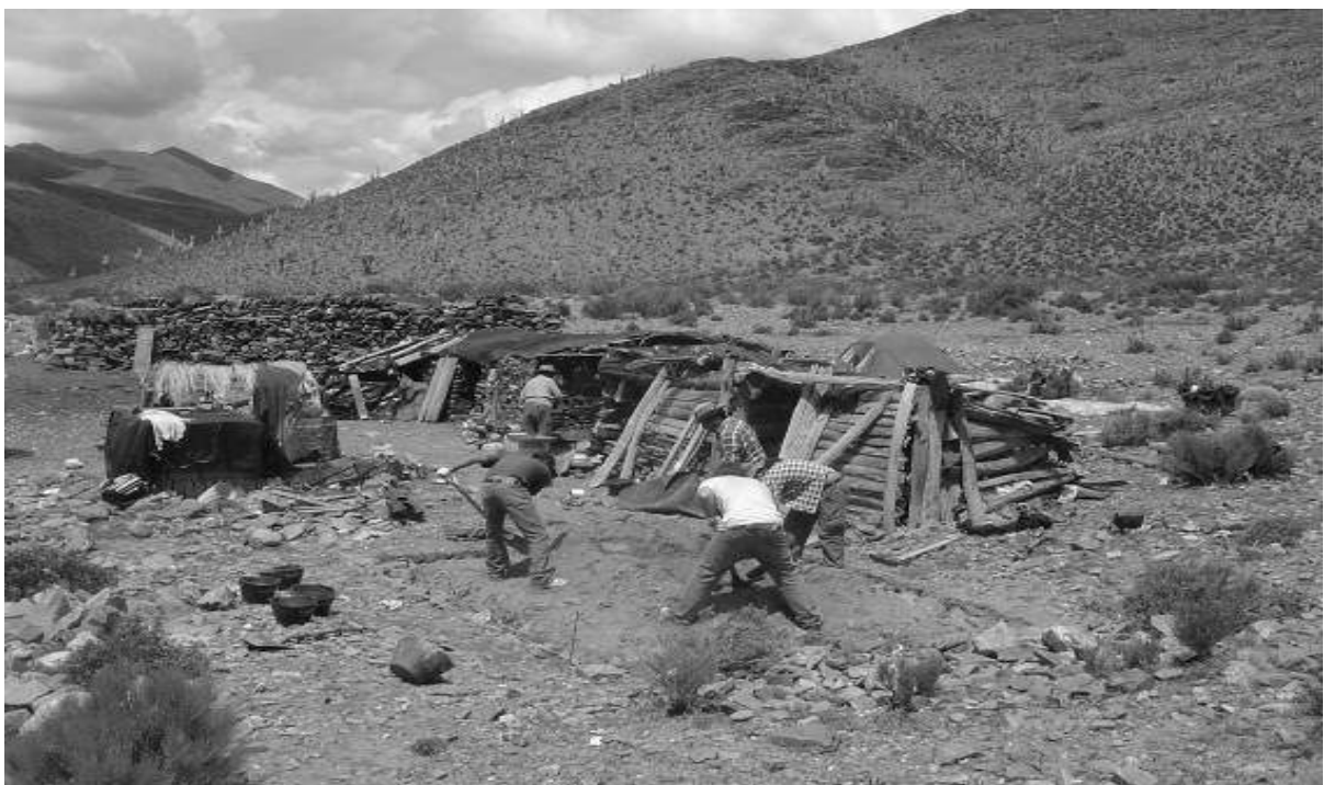
Figura 2. Trabajos en los cimientos en un puesto de pastoreo en Susques
