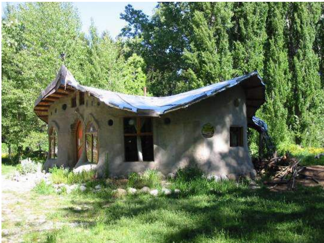
Construcción con cob en Golondrinas – Chubut
