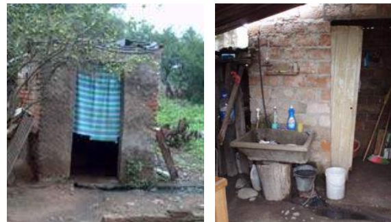
Figura 2: Vista de algunas letrinas y baños
