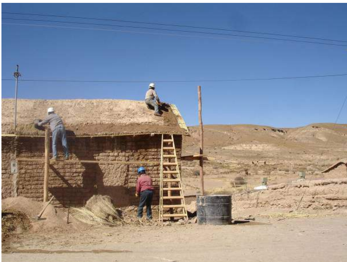
Figura 5. Equipo trabajando en un techo. Uno está colocando guaya en el alero, otro está colocando torta en cumbre y en alero lateral, el tercer hombre está abajo alcanzando los baldes con torta de barro.
