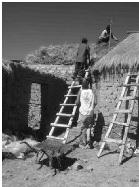
Figura 6, cadena de trabajo durante el guayado de una habitación, Rinconada 2007.
