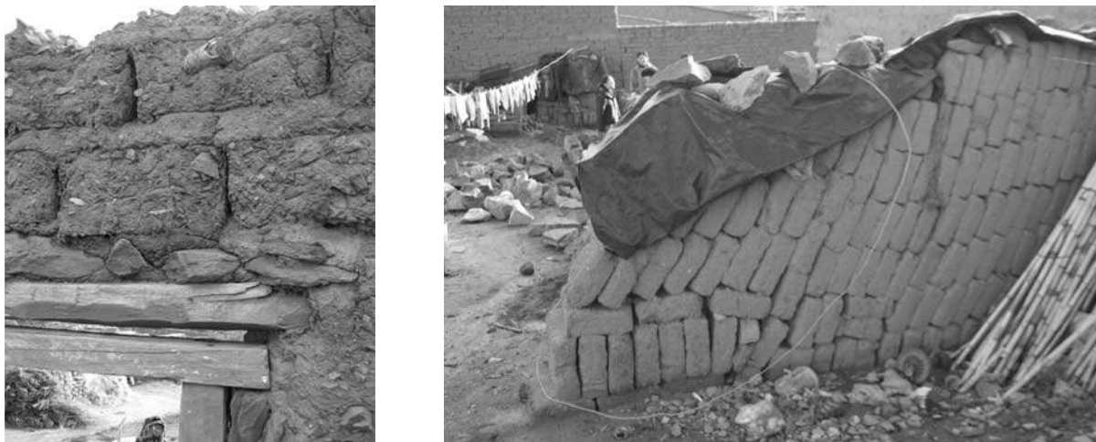
Fig. 1. Adobes con visible presencia de vidrios y piedras, registrados en Rinconada, 2007.
