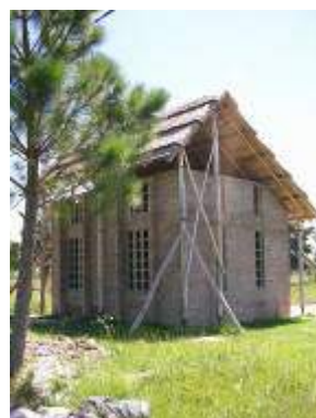
Figuras 4 y 5: Taller de mampostería de bloques de tierra comprimida para constructores locales.
