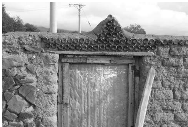
Fig. 5. Detalle de hornacina de adobe con base de laja y dintel de cardón, Susques, 2007.
