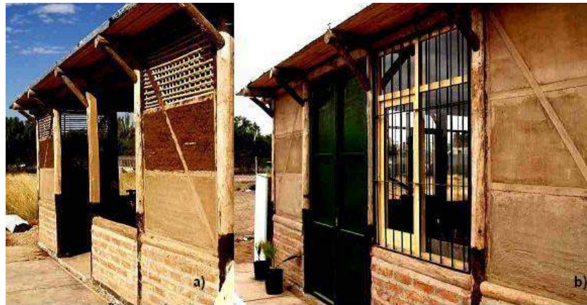
Figura N°4: a) Proceso de embarrado de las paredes y b) paredes terminadas.
