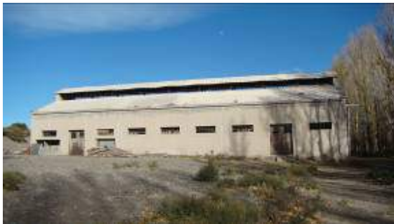
Foto Nº3 Intervenciones en muro exterior este
