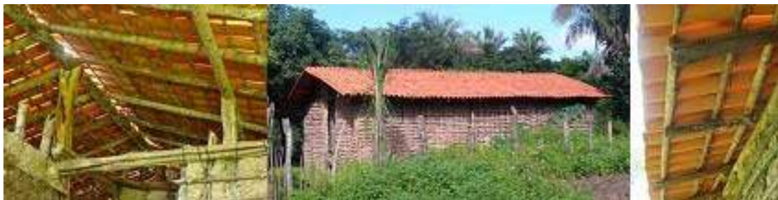
Figura 2 – Estrutura da cobertura, vista externa e beiral.
