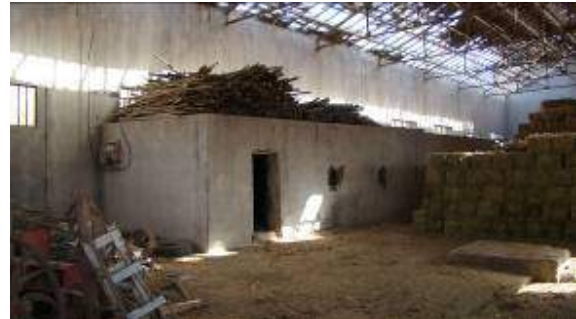
Foto Nº4 Intervenciones en el interior de la sidrera
