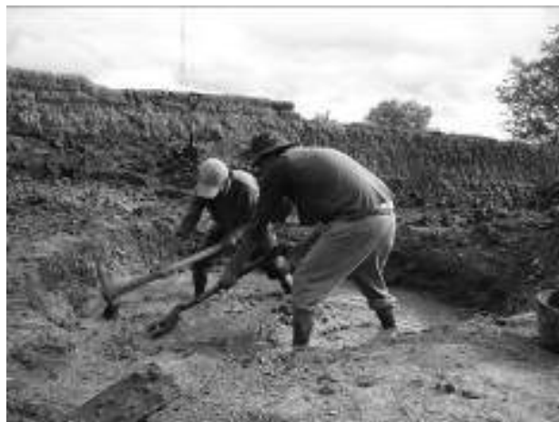
Figura 1, preparación del barro (agregado de tierra), Rinconada 2007.
