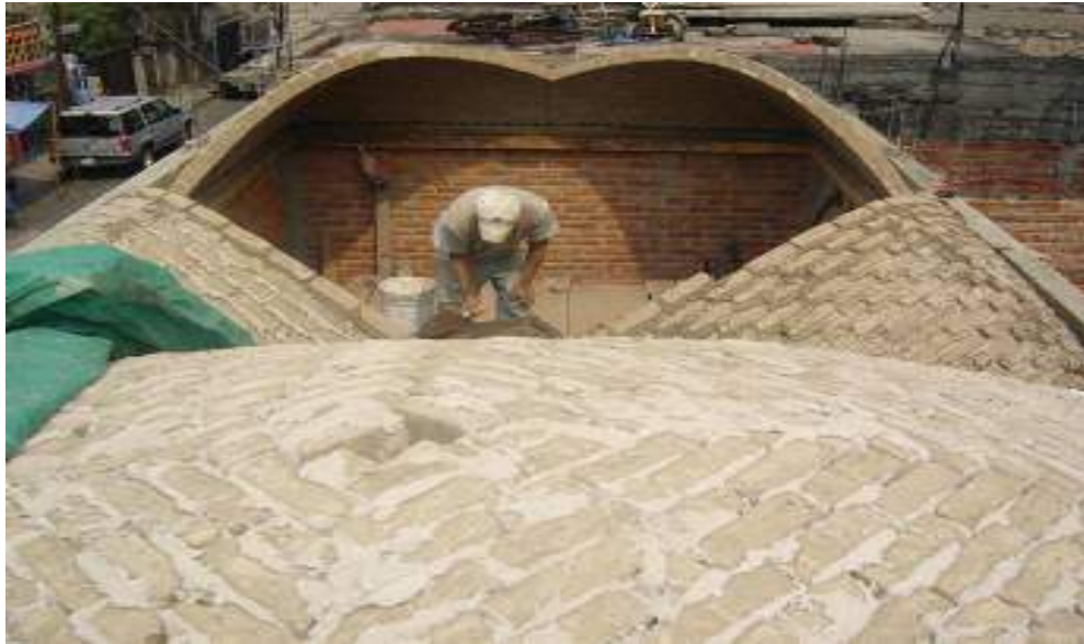
Avance de la segunda bóveda.
