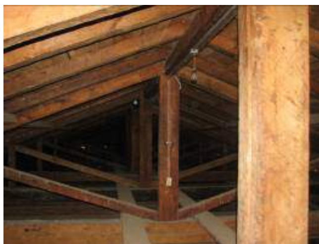
Fig. 6 estado de la estructura después de la restauración (Fotografía de F. Méndez).
