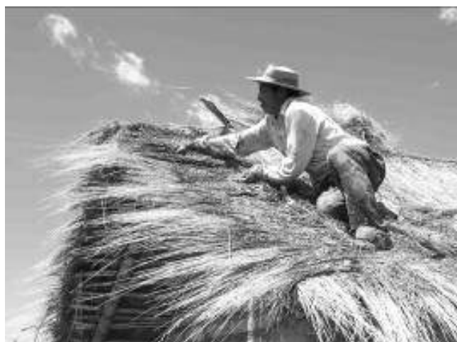
Figura 5, colocación de los aleros laterales, Rinconada 2007.
