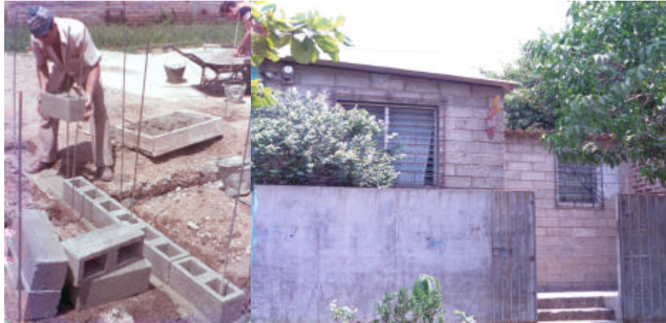
Fotografía No.1: Vivienda con Sistema de Bloque de Pómez
