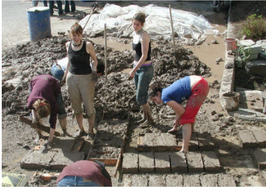
Foto 5: El manejo de las diferentes técnicas de construcción con tierra (en este caso la fabricación de adobes) ( Donald Chang, 2002 ).
