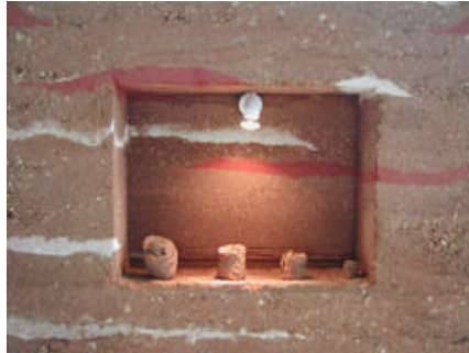
Nicho dentro el muro de tapial
