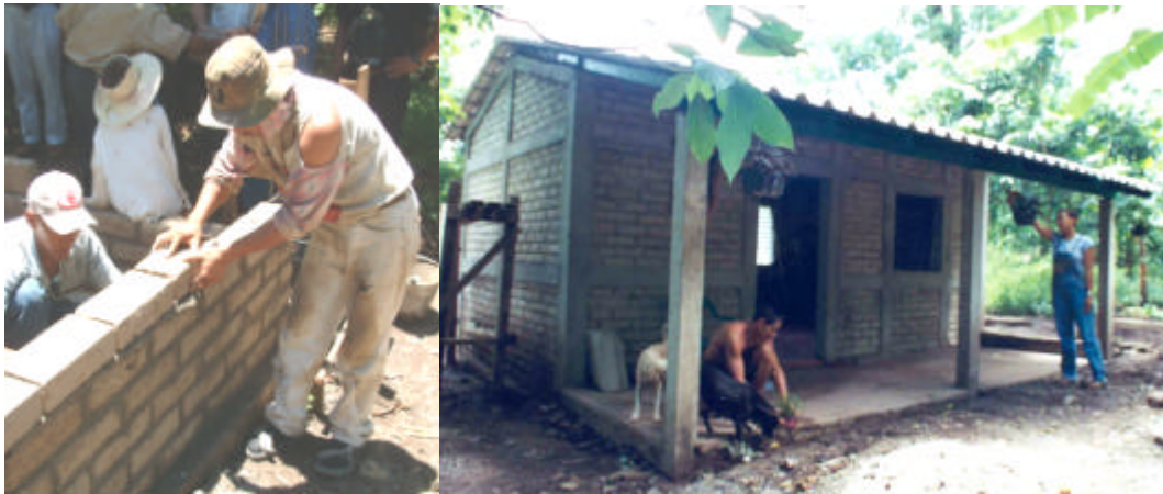
Fotografía No.2: Vivienda con Sistema de Ladrillo de Suelo Cemento
