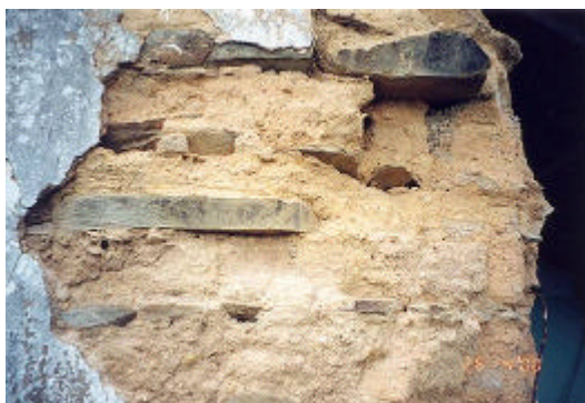
Fig.4 - Taipa com pedra no meio das fiadas na Casa Escola, em Ermidas de Sado, Santiago de Cacém (Correia 2000: 106). Fotografia da autora.
