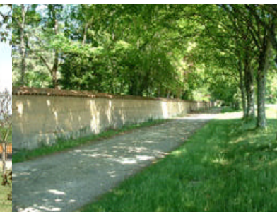
Largo muro de clausura en tapial
