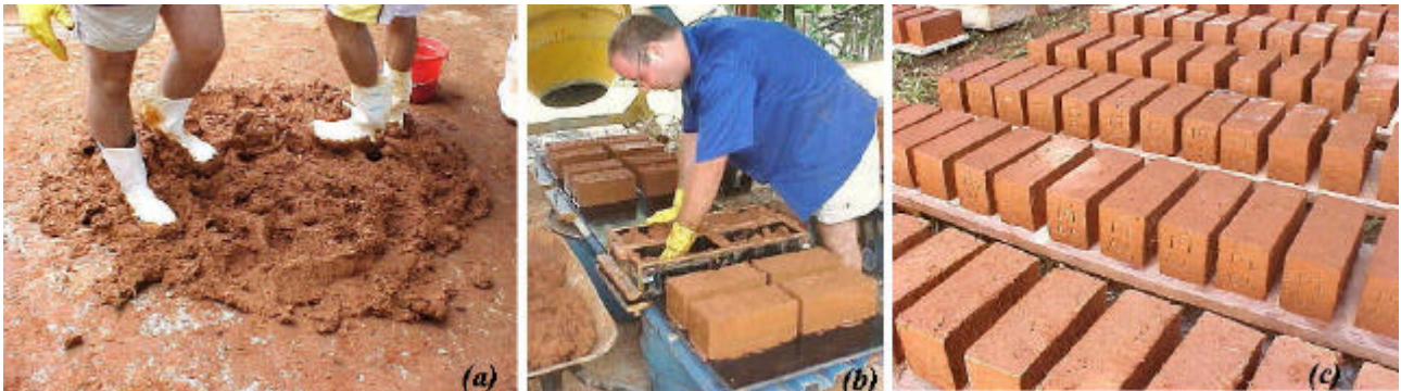
Figura 3: Amassamento do barro com os pés (a); moldagem (b) e secagem dos tijolos (c).
