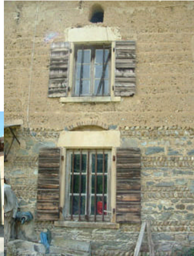
Detalle de ventanas en el basamento y en el muro de tapial
