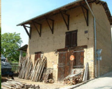
Detalle de ménsulas de protección
