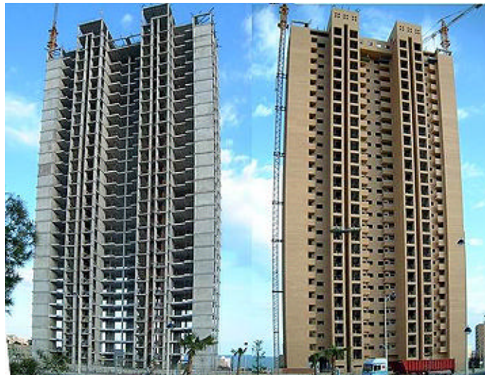
Fig. 4. Cierre de las fachadas con ladrillo cara vista en un edificio actual con estructura reticulada.
