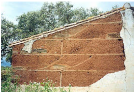
Fig.3 - Taipa com pedra no topo das juntas verticais. Casa do gado, Monte Pelicão, em Saraiva, Ourique (Correia 2000: 100). Fotografia da autora.
