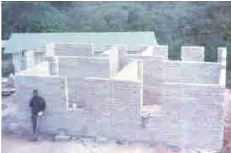
Figura 2. Paredes de una vivienda de 69 m 2 de superficie con bloques machihembrados de suelo cemento
