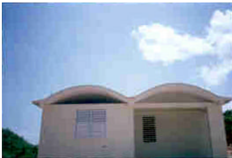
Figura 4. Vivienda terminada de 69 m 2 con paredes de Bloques Machihembrados de Suelo Cemento Prensado y techo de Bóveda de Bloques de Suelo Cemento.
