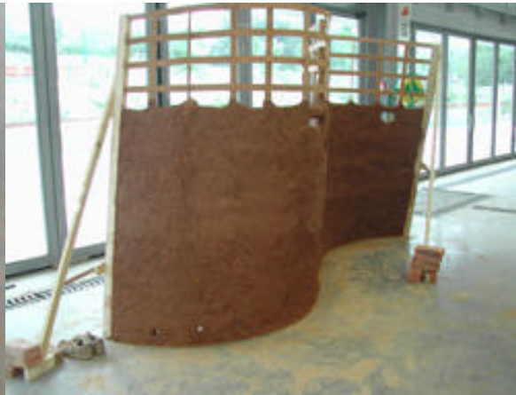
Pared curva de madera y bahareque
