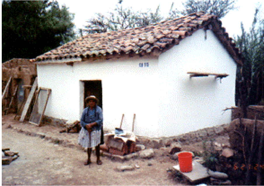
Foto 5: Vivienda mejorada con revoque de cal sobre adobe para prevención contra la enfermedad del Chagas (PRO HÁBITAT 2003)
