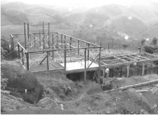
Construcción en estructura de eucalipto citrodora autoclavado y cerramiento en pau a pique y adobe Monteiro Lobato – São Paulo
