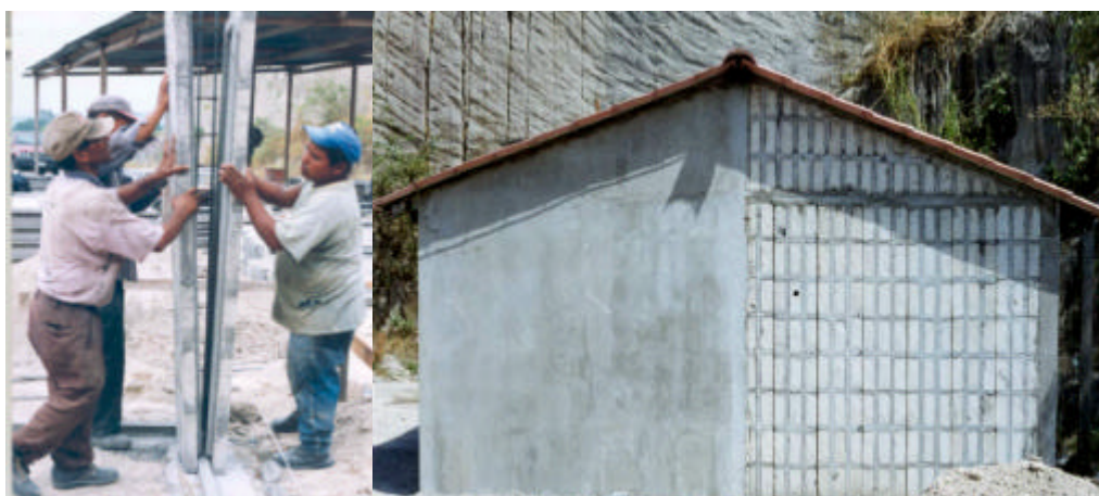
Fotografía No3: Vivienda con el Sistema BENO
