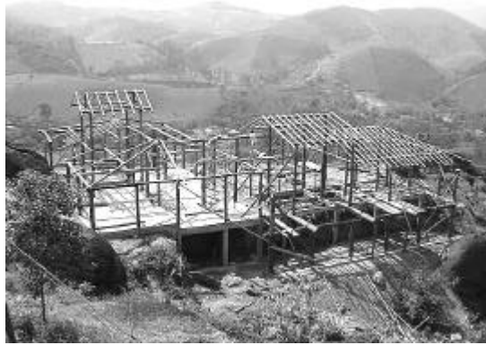
Construcción en estructura de eucalipto citrodora autoclavado y cerramiento en pau a pique y adobe Monteiro Lobato – São Paulo
