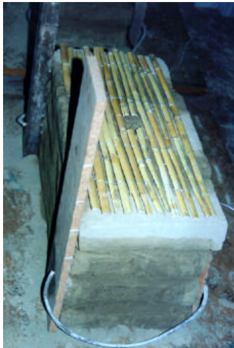
Foto 6: Refuerzo en muros de adobe
