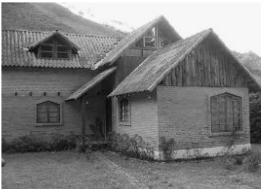
Construcción con ladrillos de suelo-cal - Vizconde de Mauá - Río de Janeiro
