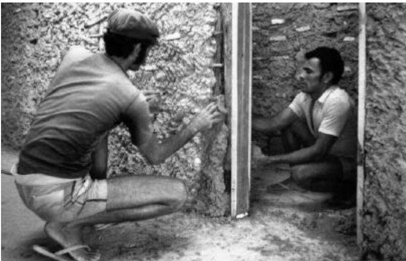
Figura 3. Processo de barreamento com colocação de pedaços de tijolos
