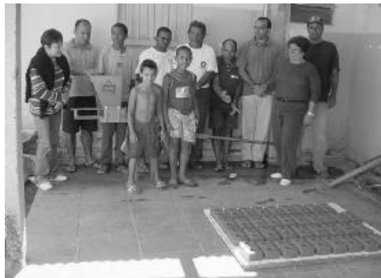
Capacitación de albañiles y obreros en la utilización de prensa tipo “cinva-ram”, para hacer ladrillos de suelo-cal Resende – Río de Janeiro
