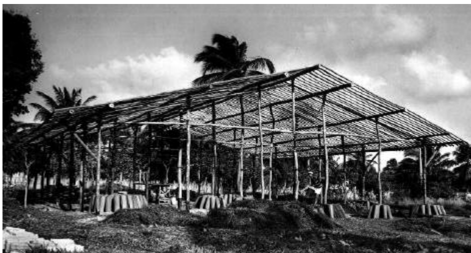
Figura 1. Vista da estrutura de madeira pronta
