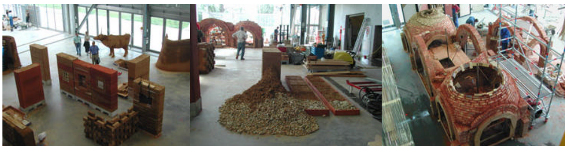
Instalación de muros de tapial
