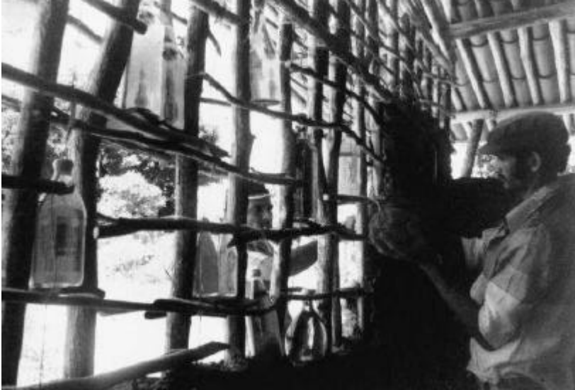
Figura 2. Processo de barreamento e vista das garrafas colocadas para funcionar como vitrais
