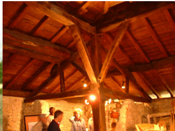
Interior: conservación de las estructuras originales de madera (carpintería) y de los muros de tapial o piedra y tapial.
