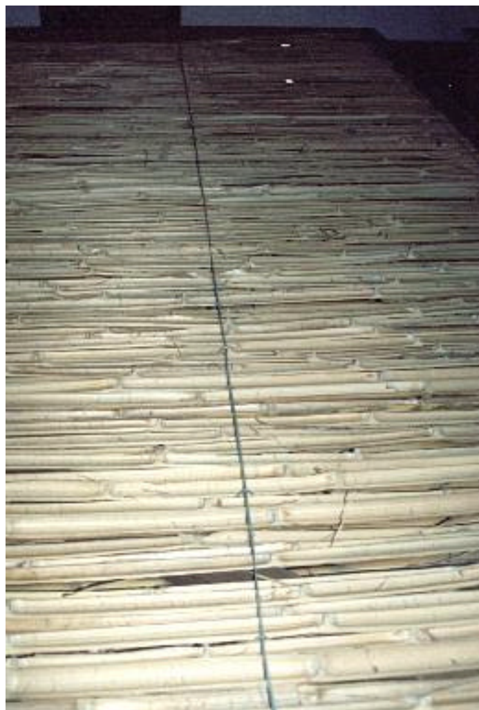
Foto 4: Paneles de caña y tierra – cemento
