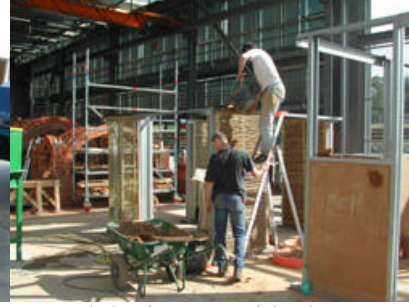
Pared de tierra vertida dentro encofrado de cana
