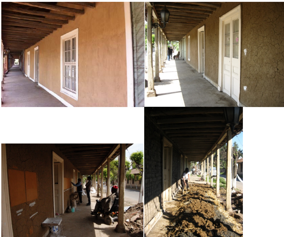
Figura 5. Imágenes del proceso de restauración de la vivienda piloto en Guacarhue
