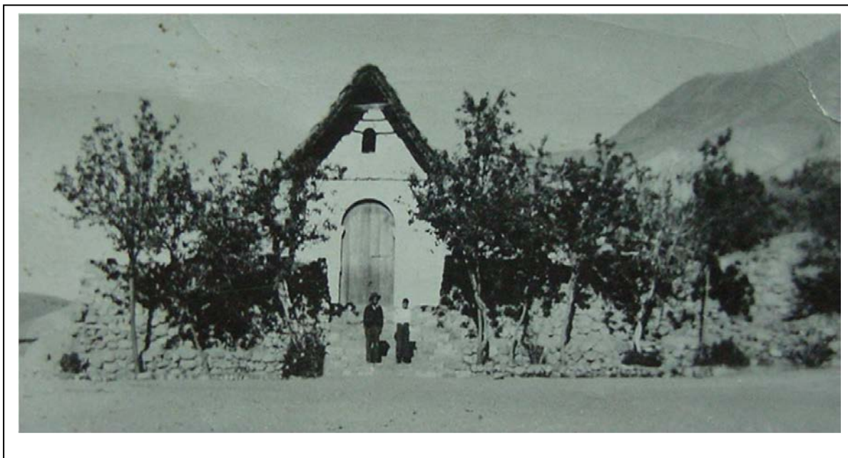
Figura 6. Foto fachada principal Iglesia de Parca (sin fecha precisa, se estima de fines del s. XIX o inicios del s. XX). Aporte de Sra. Christianne Raczinsky de V. de AIS
