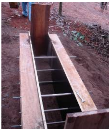
Figura 3: Montagem da forma
