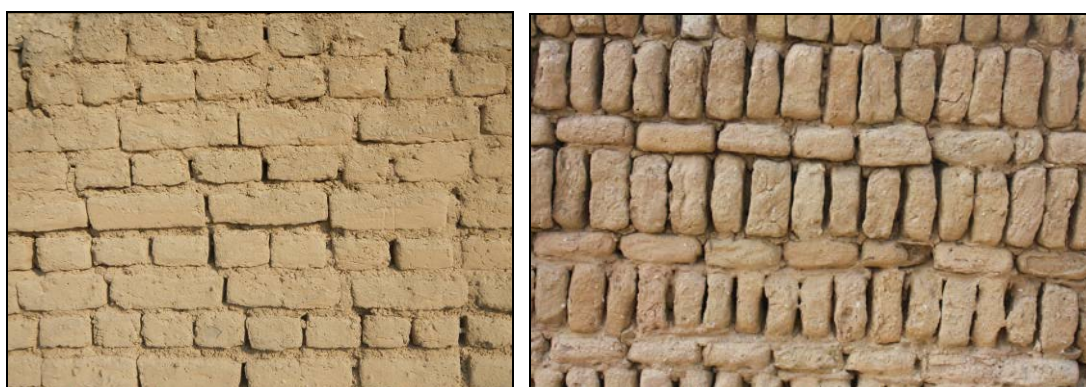
Figura 3. Detalle de aparejos. Izquierda: Muro Ychma – Derecha muro Lima “técnica del librero”.
