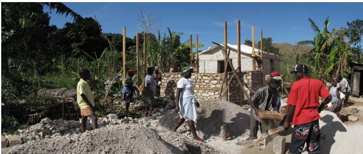
Figura 5. PADED, Ducrabon, Haití. Ayuda mutua en obra. Photo J. Hosta
