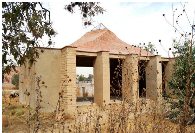
Figura 6. El enladrillado protege la cubierta de la intemperie y le da estabilidad. (Foto: L. Guerrero)
