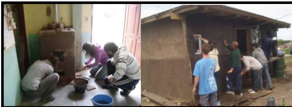
Figura 4: Construcción de estufa de adobe con alumnos de Arquitectura en centro vecinal Bancalari, Buenos Aires (2011). Capacitación de alumnos, profesionales y albañiles en zonas urbanas pobres de Mar del Plata (2012).
