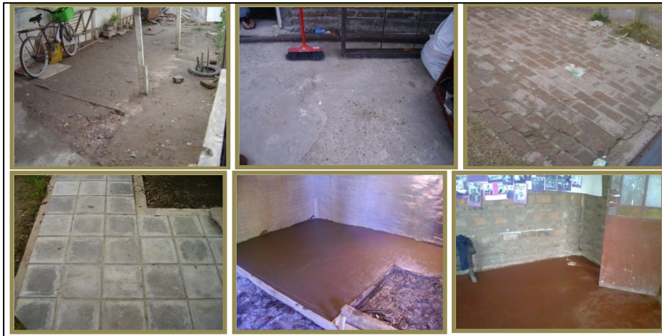
Figura 2: Situaciones de pisos de baja calidad y durabilidad en viviendas autoconstruidas (arriba). Prototipos de pisos y solados de suelo-cemento alisado y de baldosas artesanales de suelo-cemento. Barrios de Bancalari y San Martín, Gran Buenos Aires. (Créditos: Rotondaro, 2008 y 2012)
