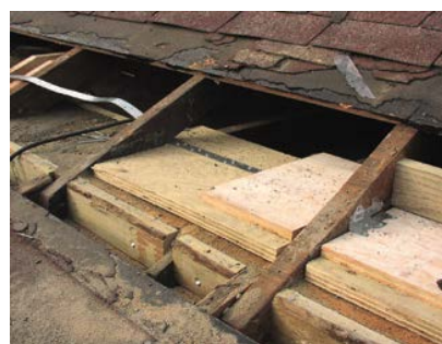
Figura 1 – Izquierda: Esquema de viga collar (Tolles; Kimbro; Ginell 2002). Derecha: Implementación en Las Flores Adobe National Historic Landmark en California (Barrow et al, 2006)
