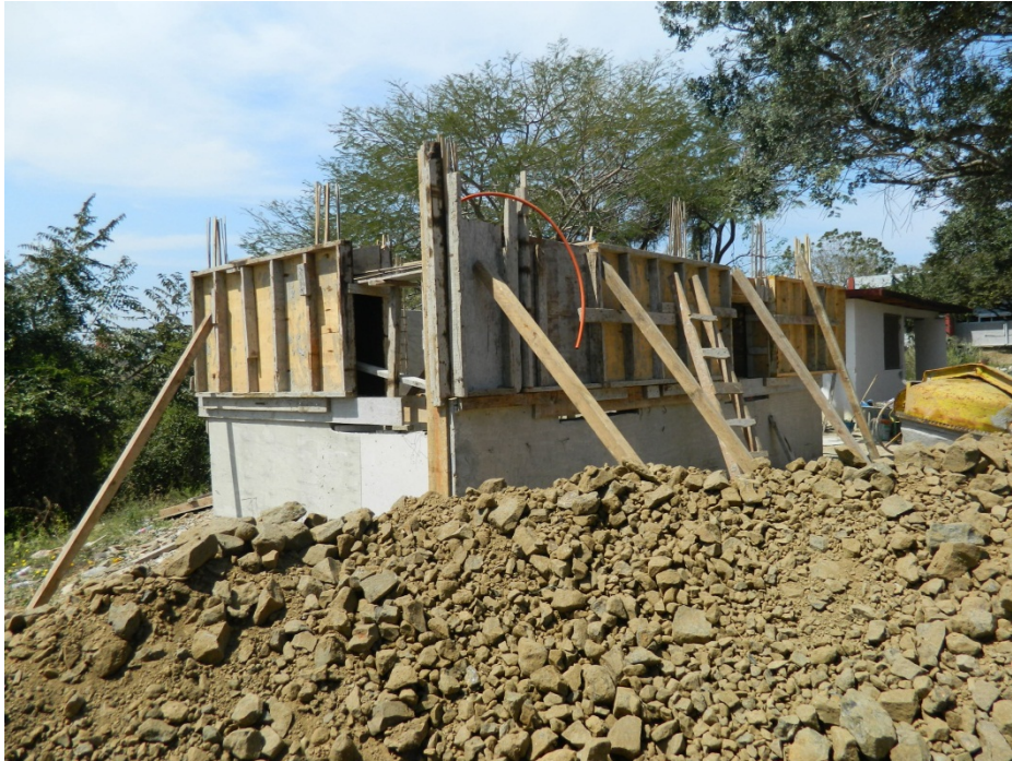
Figura 4: Fachada principal y sur del prototipo, aparece en primer plano el suelo de la región. Foto: Aranda, Marzo 2013
