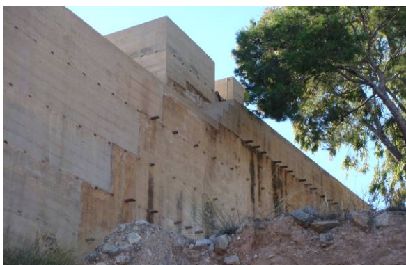
Figura 4. Lienzo de la muralla exterior del castillo de la Mola (Novelda) con los volúmenes regularizados. Fuente: F. Vegas & C. Mileto
