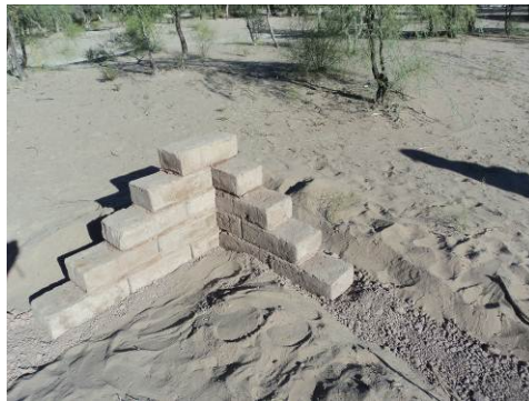
Figura 4. Aparejo de sogas del adobe. Foto del autor, Febrero 2013
