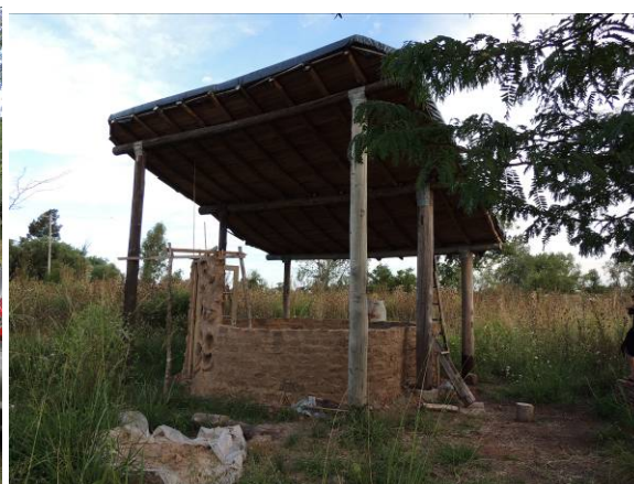
Figura 5. Vivienda en construcción
