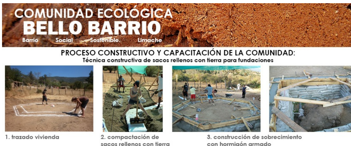
Figura 3. Proceso constructivo y capacitación de la comunidad para la construcción de la fundación.
