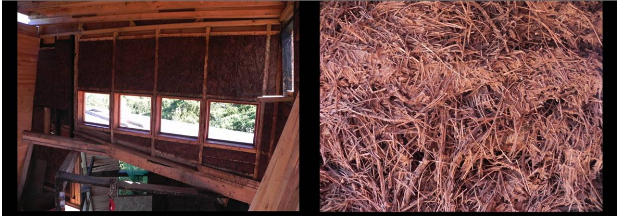
Figura 3. Imágenes de mezcla con 80% de hoja de pino y 20% de tierra. Fotografías de autores
