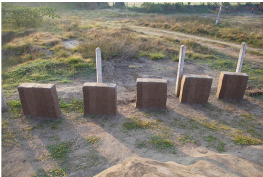
Figura 6. Los 5 muros de pruebas, del lado izquierdo: control, malva, guácima, chapopote, y emulsión asfáltica. Cada muro tiene 5 franjas de aplanados de distinta composición: empezando del lado derecho, control, malva, guácima, chapopote, y emulsión asfáltica. En los 2 lados angostos de cada muro se aplicó el aplanado de control.
