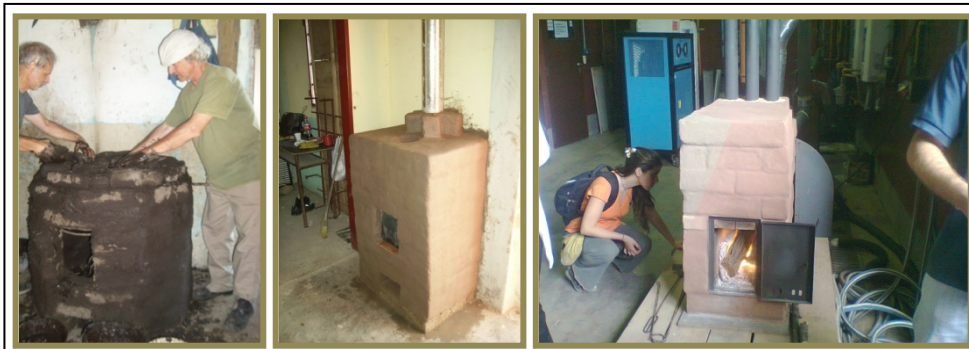
Figura 4: Estufas experimentales de masa térmica con paredes de adobe y mortero de barro en Monte Terrabusi (Créditos: Cacopardo y Rotondaro), Bancalari (Crédito: Rotondaro 2011) y prototipo en INTI Sede Central San Martín. (Crédito: Rotondaro-INTI Energía 2012).
