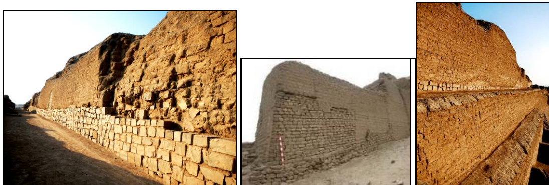
Figura 2. Muros de sección trapezoidal: Calle Norte Sur y muros perimetrales (1100 a 1470 d.C.)
