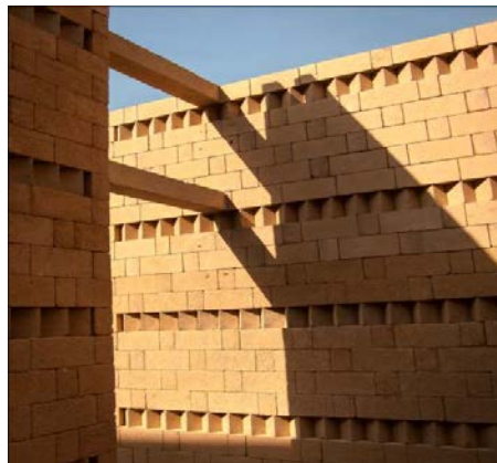
Figura 9. Sistema de ensamblaje de muros. Investigación 3244/ 2012 U
