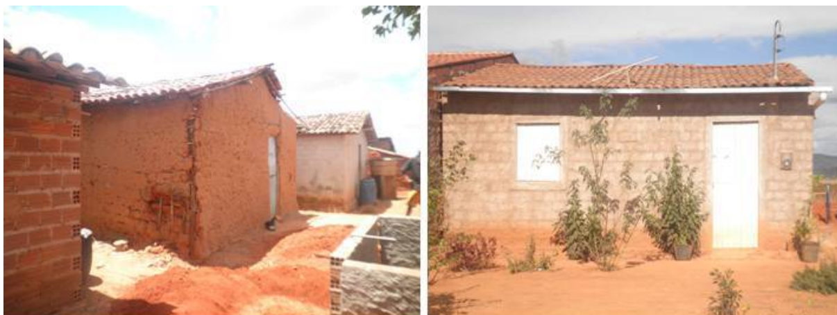
Figura 4 - Substituição das casas de taipa por alvenaria convencional
