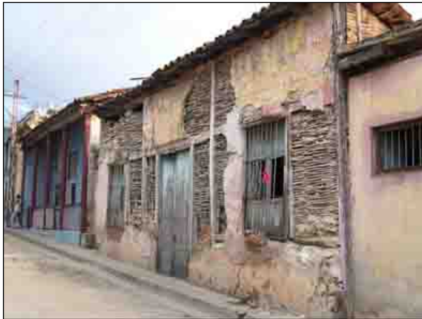
Figura 2. Fachada que muestra los elementos componentes de la tecnología en el tipo constructivo 1
