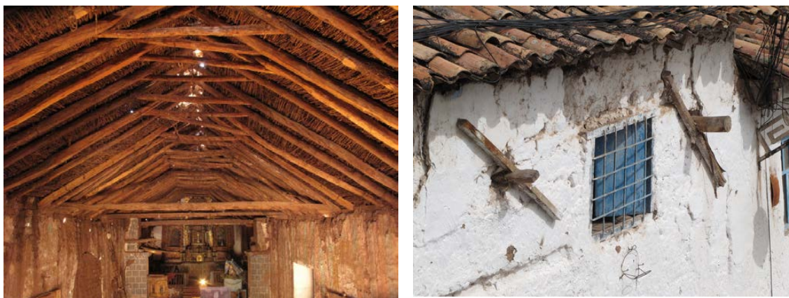
Figura 4 - Izquierda: tirantes en la iglesia de Kuño Tambo, uno de los edificios prototipo del proyecto SRP (Foto Claudia Cancino, 2010) Derecha: Vista exterior de conexiones de tirantes en Cuzco (Foto Sara Lardinois, 2012 © J . Paul Getty Trust).
