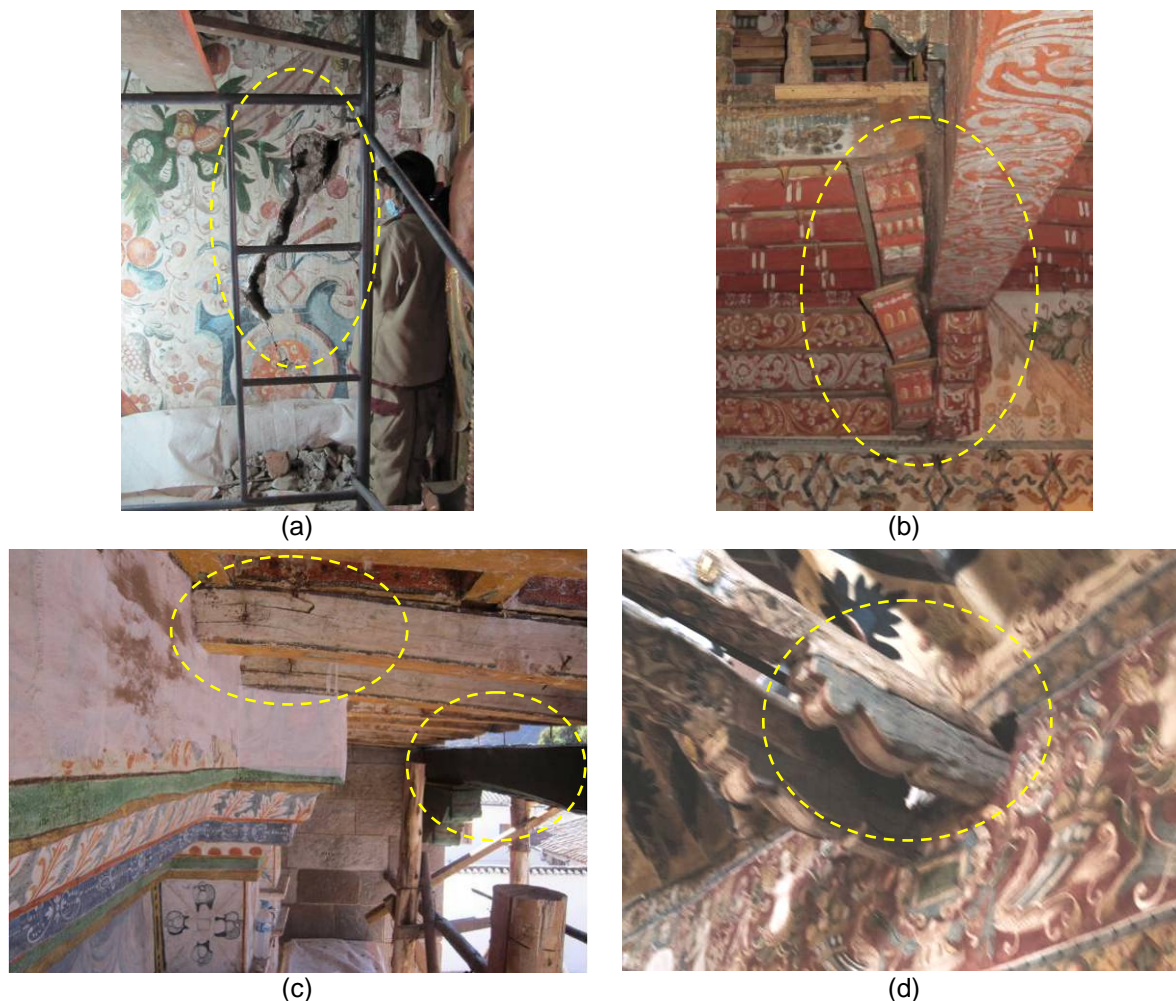
Figura 3. Patologías estructurales más evidentes en la iglesia: (a) grieta ubicada en la parte superior del arco triunfal; (b) deformación y desacople de canes que son parte del sistema de piso del coro; (c) tensor de madera apollillado; (d) viga aislada del sistema estructural y can fracturado en la fachada
