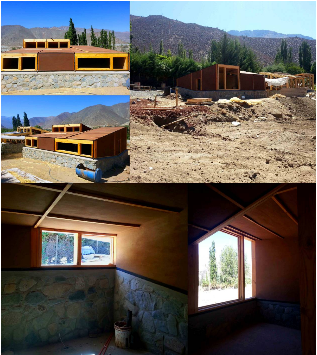
Figura 6. Fotografías del resultado final en fachada e interior del primer refugio.
