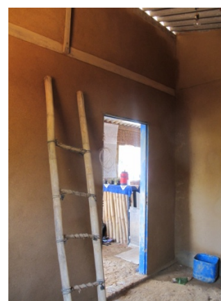
Figura 3. Paredes internas rebocadas
