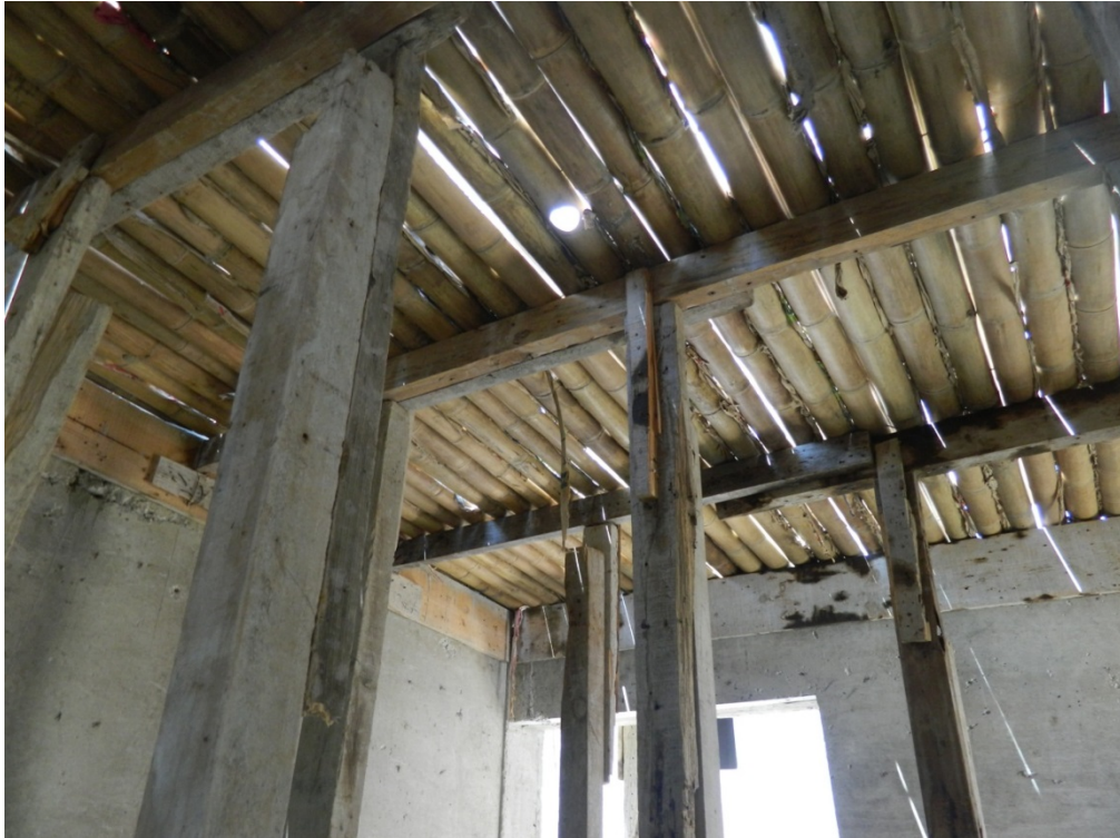
Figura 6: Armado de la losa de bambu-creto. Foto: Aranda, Marzo 2013.
