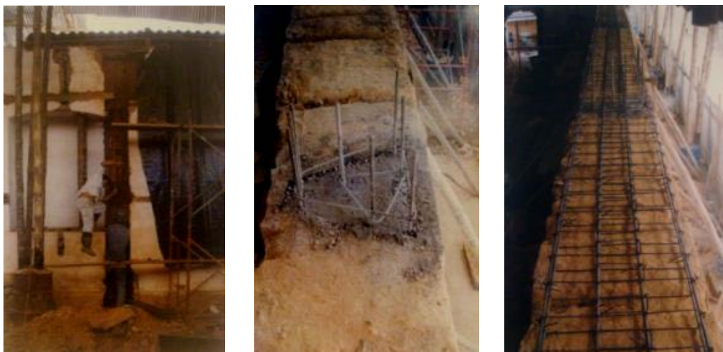
Figura 2. Ejemplo del proceso constructivo de las columnas y vigas de concreto, para reforzar muros de tierra. Fuente: Informe de intervención Capilla de Jesús Nazareno (Marinilla, antioquia), Fundación Ferrocarril de Antioquia
