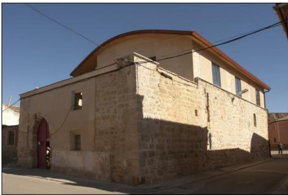
Figura 5. Vista general del exterior del edificio restaurado.
