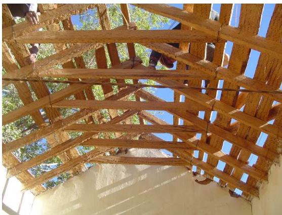
Figuras 2. Estructura de un techo en Susques con sus tijeras y alfajías (Fotografía propia)
