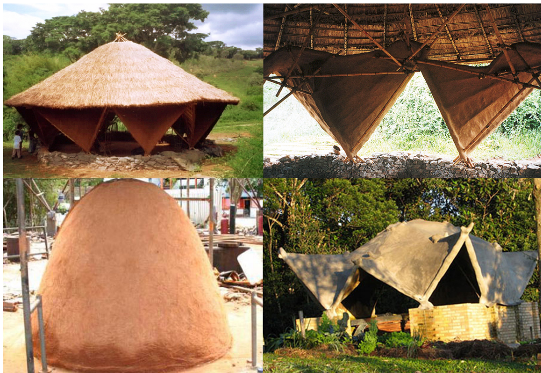
Figura 2 - Capela de Andrelândia externa e interna, cúpula catenária de fibrobarro e domo de Yvy Porã
