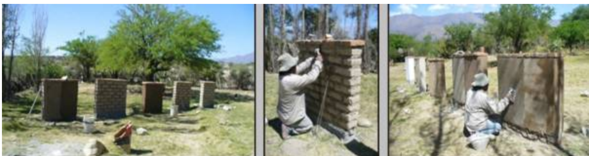
Figura 3. Muretes realizados con materiales y mano de obra local y expuestos al clima del lugar para verificar su comportamiento a la intemperie.
