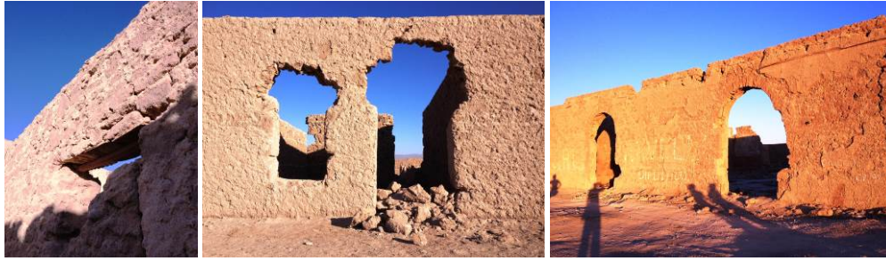
Figura 6. Diversas manifestaciones constructivas a escala de obra gruesa del uso del costrón en Pampa Unión. Fuente: registro propio, Pampa Unión 2013.
