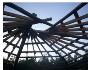
3. montaje de la estructura de techumbre autoportante
