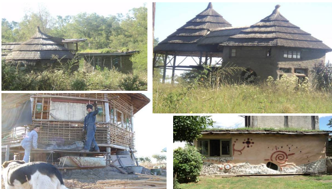
Figura 3: Obras sin intervención de profesionales
