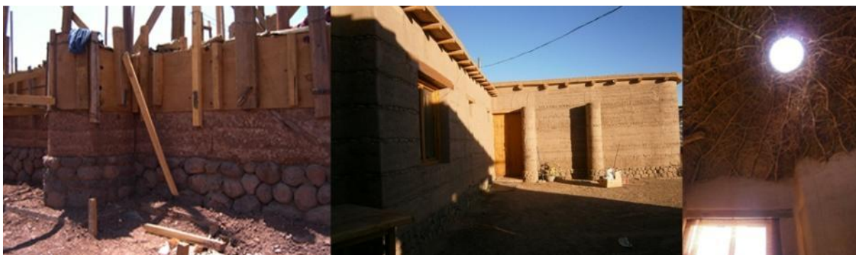
Figura 6. Moldajes tapiales, acceso principal, detalle cúpula. (Fotografías del autor).
