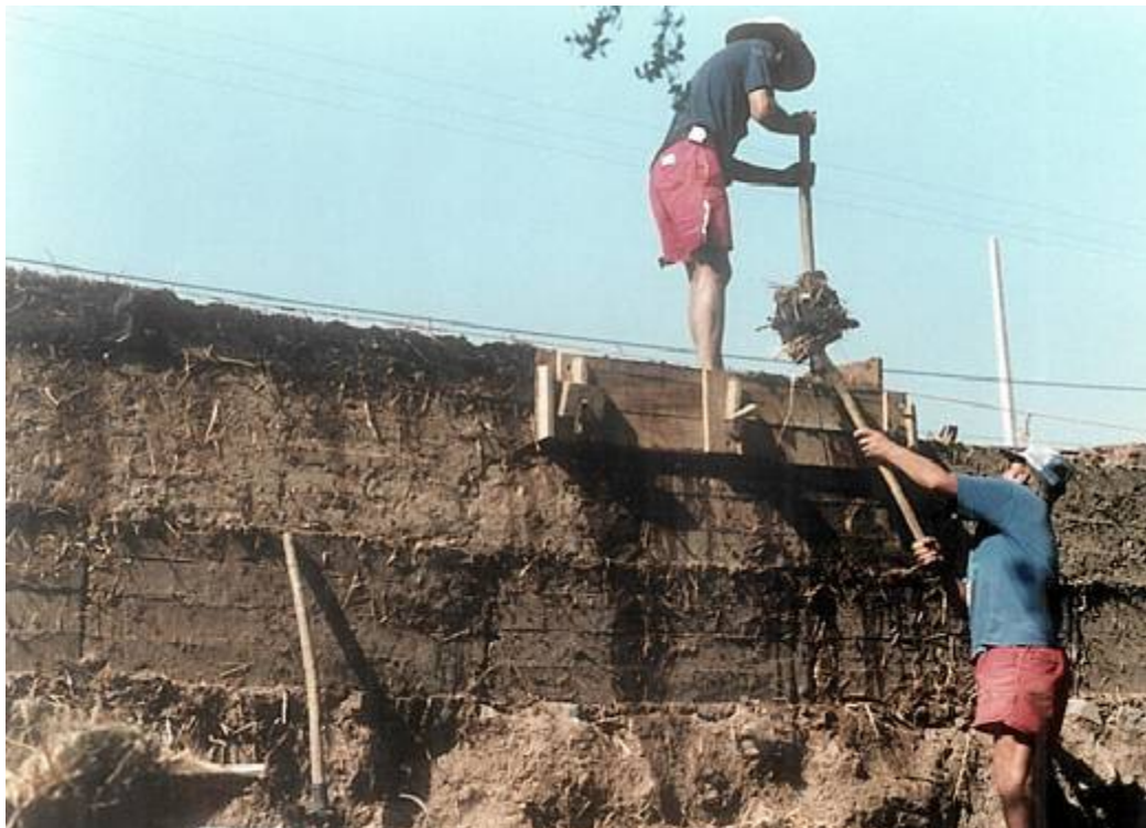
Figura 2. Fabricación de tapial, Enero 1992, Comuna de La Florida, Chile. Foto: H.Pereira Existen testimonios acerca de la utilización de la tierra en las construcciones agrícolas,
