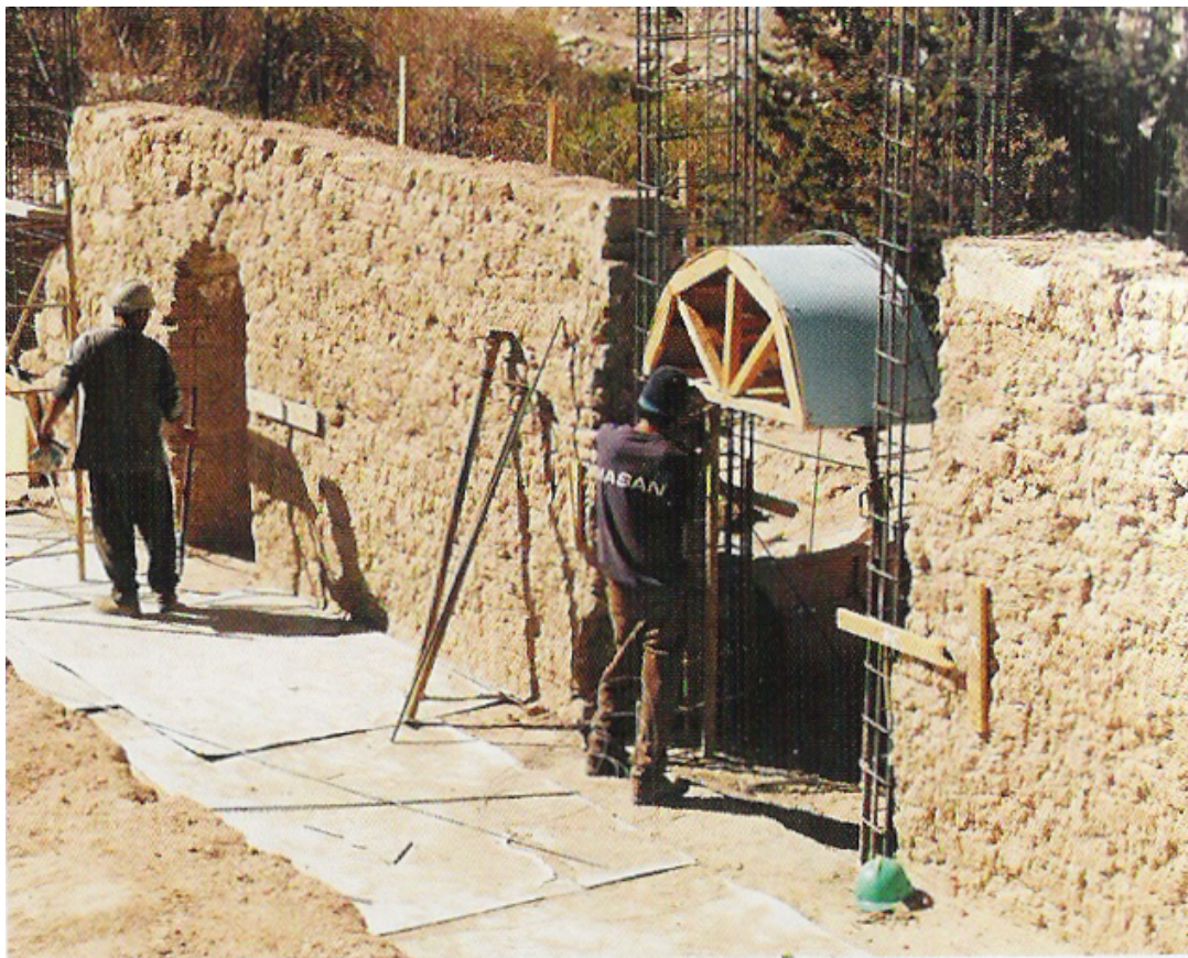
Figura 4. Muro de albañilería de adobe, fachada sur, 2005
