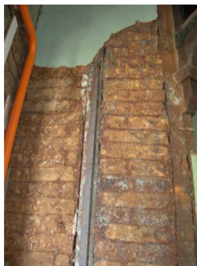
Figura 5. Detalle del sistema conocido como “adobillo”, cuya elasticidad y uniones eficaces han permitido un buen desempeño frente a los sismos. (Créditos: Natalia Jorquera)
