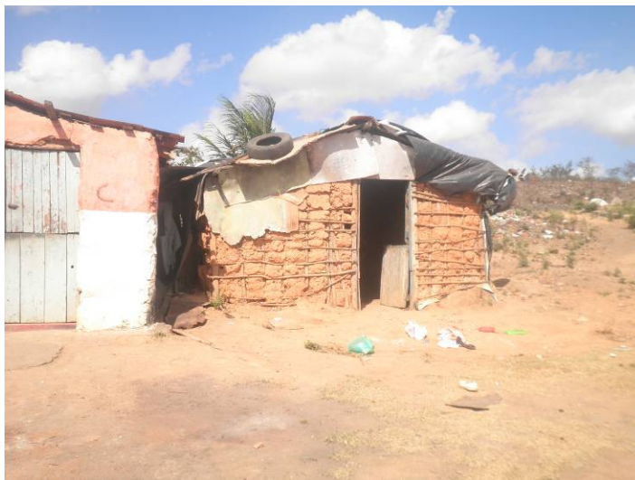
Figura 2 - Construção em taipa de mão ou pau-a-pique
