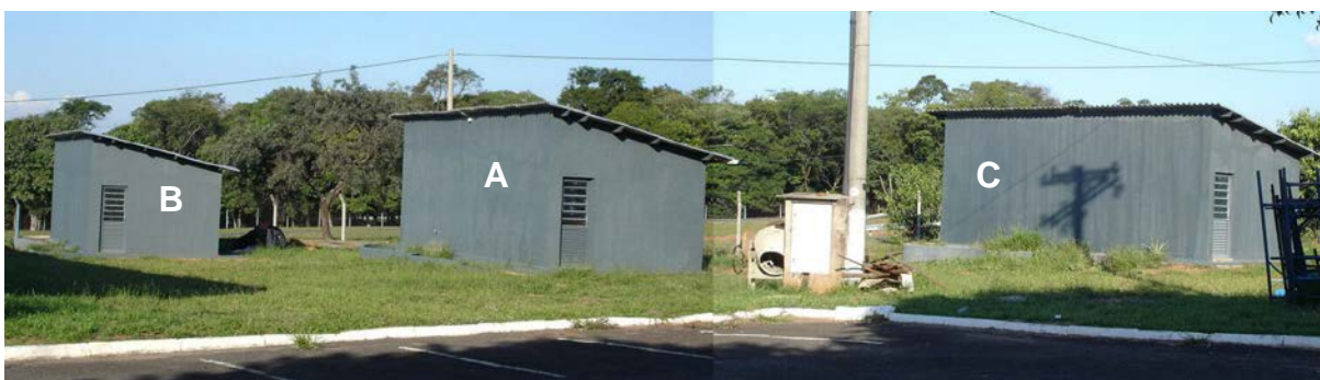
Figura 3. Vista geral da face norte dos três protótipos: adobes (A), blocos de concreto (C) e blocos cerâmicos (B). (adaptado de Faria, 2007).
