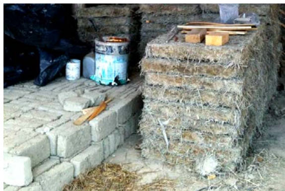
Figura. 4 (abajo) Placas de aislación térmica para el techo hechas de arcilla y paja; adobes hechos en obra.
