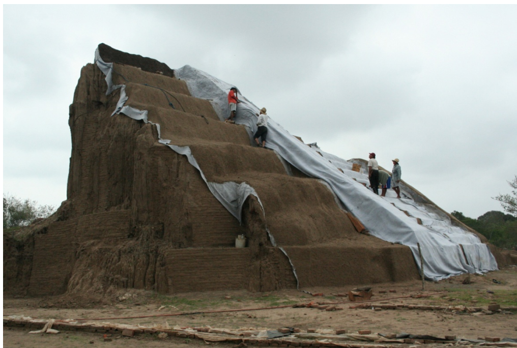
Figura 1. Recubrimiento de fachada por geotela y capa de sacrificio. En la sección Norte (a la izquierda), se observa el corte vertical dejado por los ladrilleros, reforzado por muros de contención de ladrillo crudo (Foto A. Daneels, 30 de marzo 2009).
