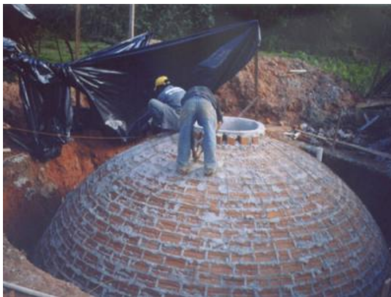
Figura 2. Biodigestor em construção no Haiti ( www.oia.org.br/new/biosistemas_integrados.asp )
