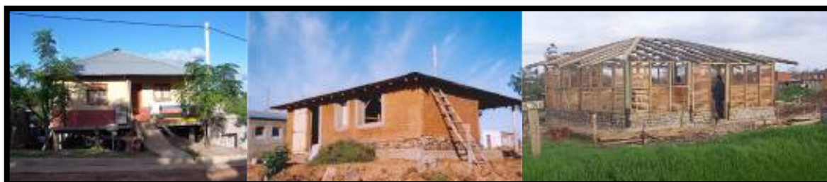
Figura 2: Obras escuela: Adobe en Salto, BTC en Artigas, Fajina en Montevideo.
