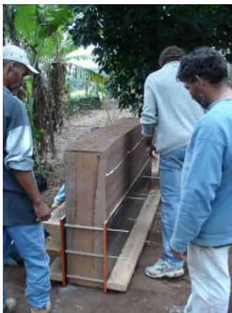
Figura 4: Retirando a forma
