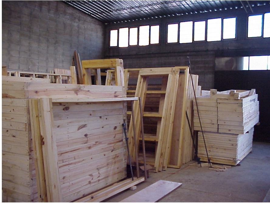
Figura 2 – Bastidores prefabricados, listos para ir a la obra
