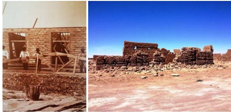
Figura 4: izquierda, fotografía de la época salitrera que muestra las características del proceso constructivo en obra gruesa, el basamento del corredor está construido con bloques de costrón mientras que en las paredes se aprecian aparejos de adobe. Fuente: registro fotográfico ubicado en Teatro Oficina Chacabuco, Antofagasta.
