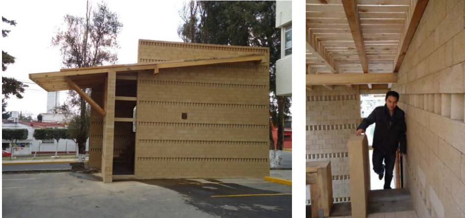
Figuras 5 y 6. Construcción de la casa ecológica. Investigación 3244/ 2012 U. Vista exterior y segundo nivel
