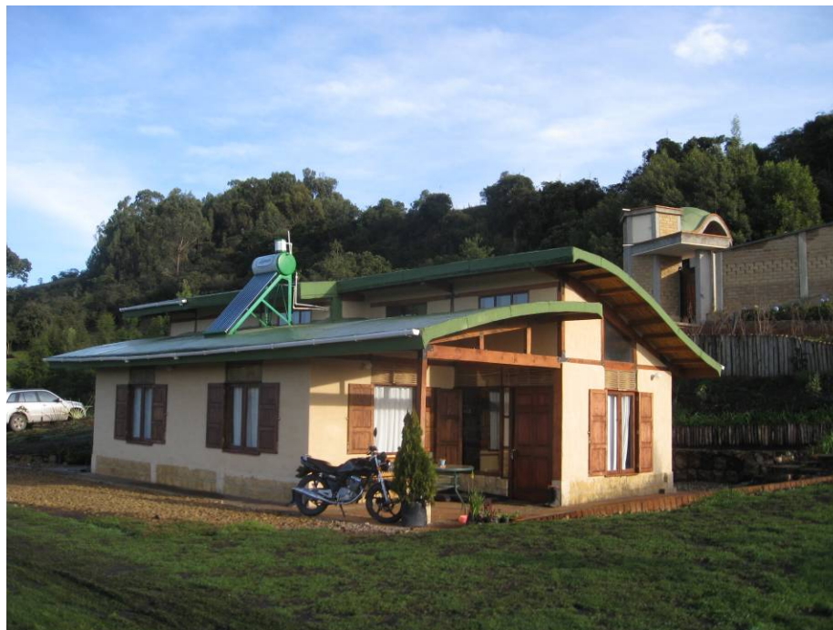
Figura 6 – Casa Supitina – Vivienda administrativa en quincha prefabricada. Fotografía: Andrés Bermúdez
