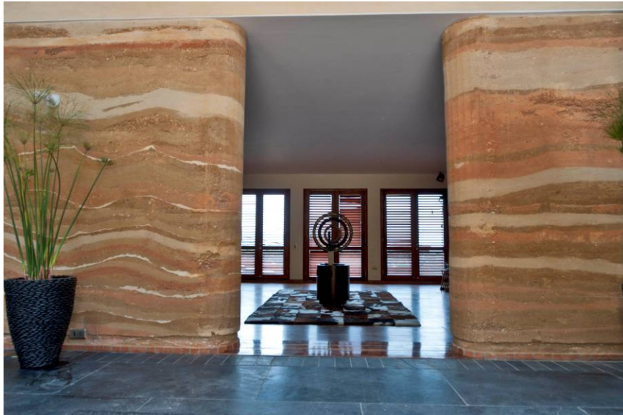
Figura 7 – Casa Supitina – Tapia pisada del acceso principal. Fotografía: Andrés Bermúdez
