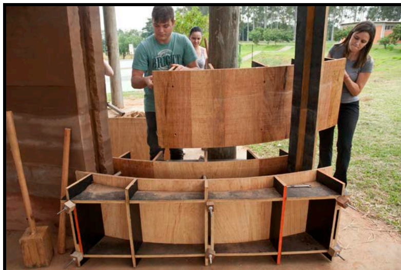
Figura 1: Alumnos del quinto semestre construyendo una pared curva en tapia. Campus Santa Bárbara D' Oeste-FAU-Maio/2012.
