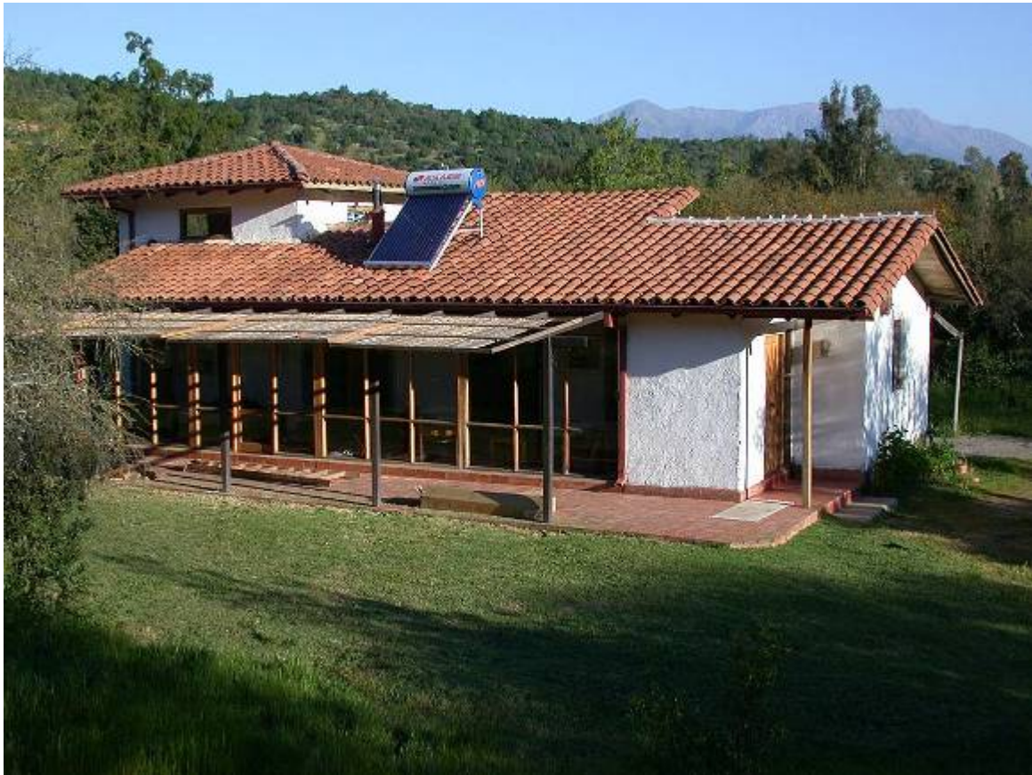
Figura 3. Casa Sr. Jaime Pereira G., Comuna de Paine, Chile. Foto J.Pereira (Geo referencia: Lat -33^{\circ},82' Long -70^{\circ},91' )
