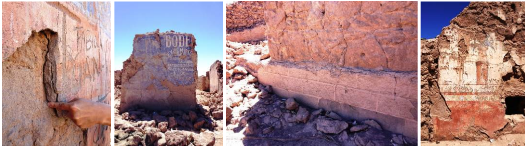
Figura 7. Diversas manifestaciones constructivas a escala de acabados y terminaciones uso del costrón en Pampa Unión. Fuente: registro propio, Pampa Unión 2013.
