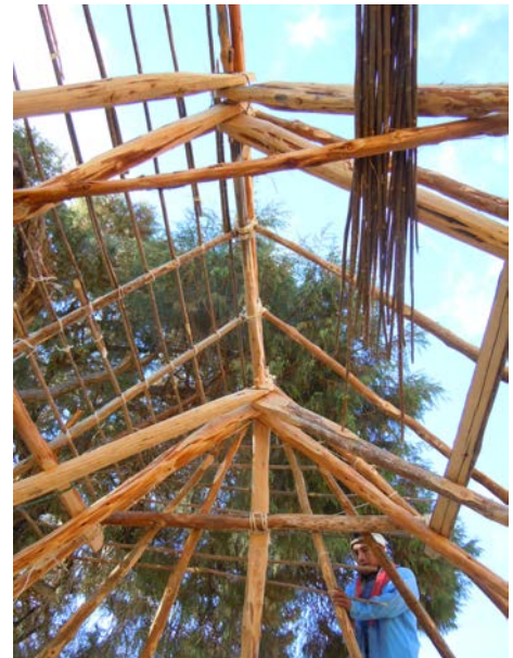
Cubierta en proceso de construcción
