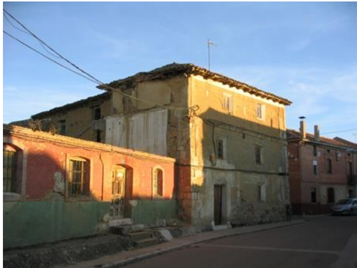
Figura 3. Vista del estado inicial de la vivienda a restaurar.
