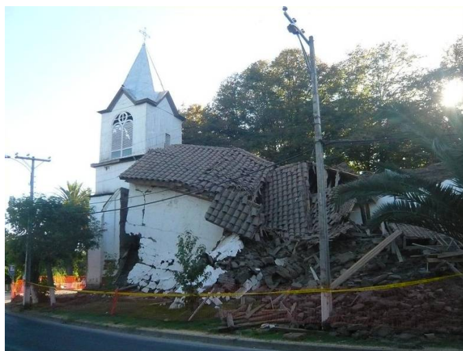
Figura 3. Iglesia de Guacarhue post-terremoto, año 2010
