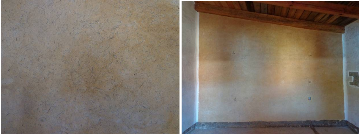
Figuras 5 y 6. Recubrimientos y acabados de muros, donde incluyo material fibroso natural de la región, práctica realizada con la asesoría del Arq. Ramón Aguirre. Foto: autor, 2012
