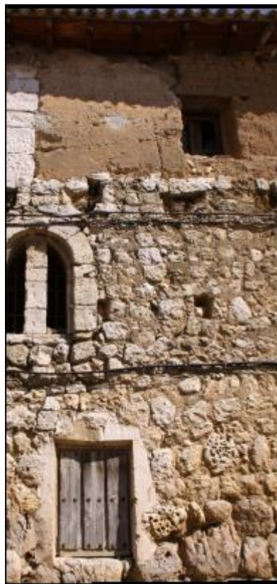
Figura 4. Vista de la composición del muro.
