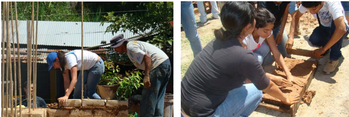
Figura 3. Estudiantes participan en elaboración y colocación de adobes
