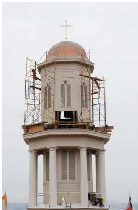
Figura 3. Reparación de revestimiento e instalación de cúpula de cobre en la Torre Campanario.
