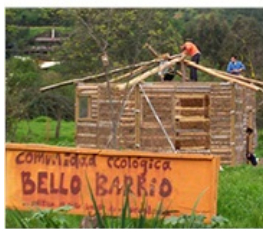
3. montaje de la estructura de techumbre autoportante
