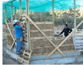
2. relleno y compactación con paja de trigo dentro de la estructura
