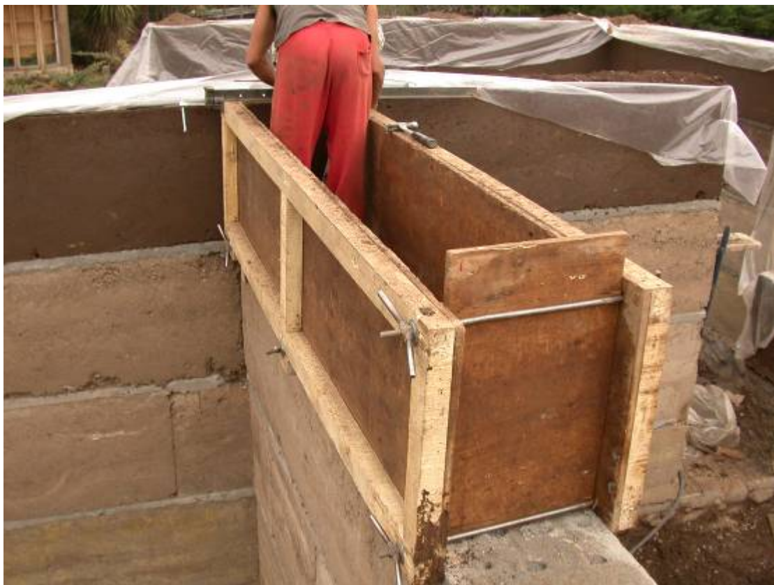
Figura 6. Sistema de apisonamiento de tableros de madera contrachapada Foto H.Pereira
