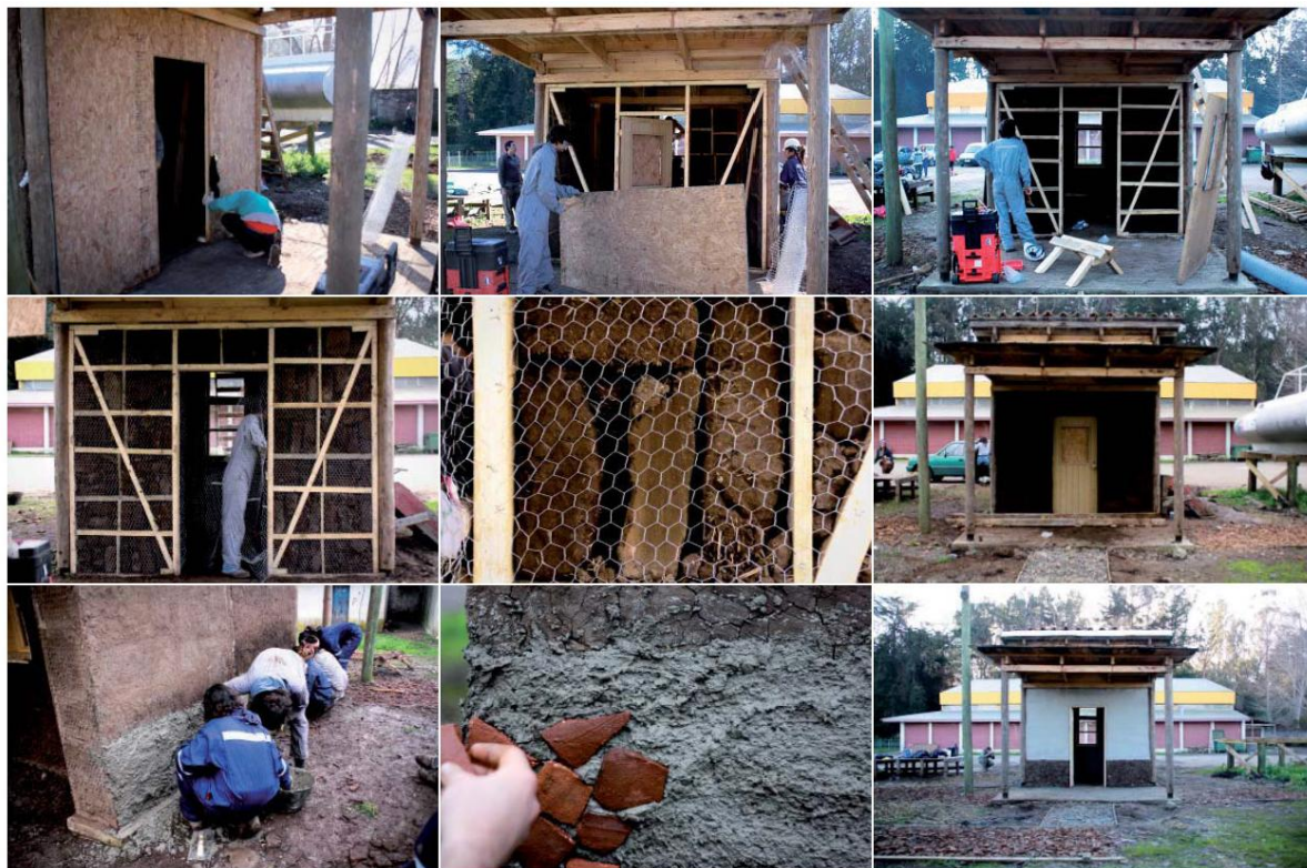
Figura 5. Construcción fotográfica. Proceso de armado de un muro de adobe. Fotos del equipo Reclaiming Heritage. Chanco, Chile. Julio 2012
