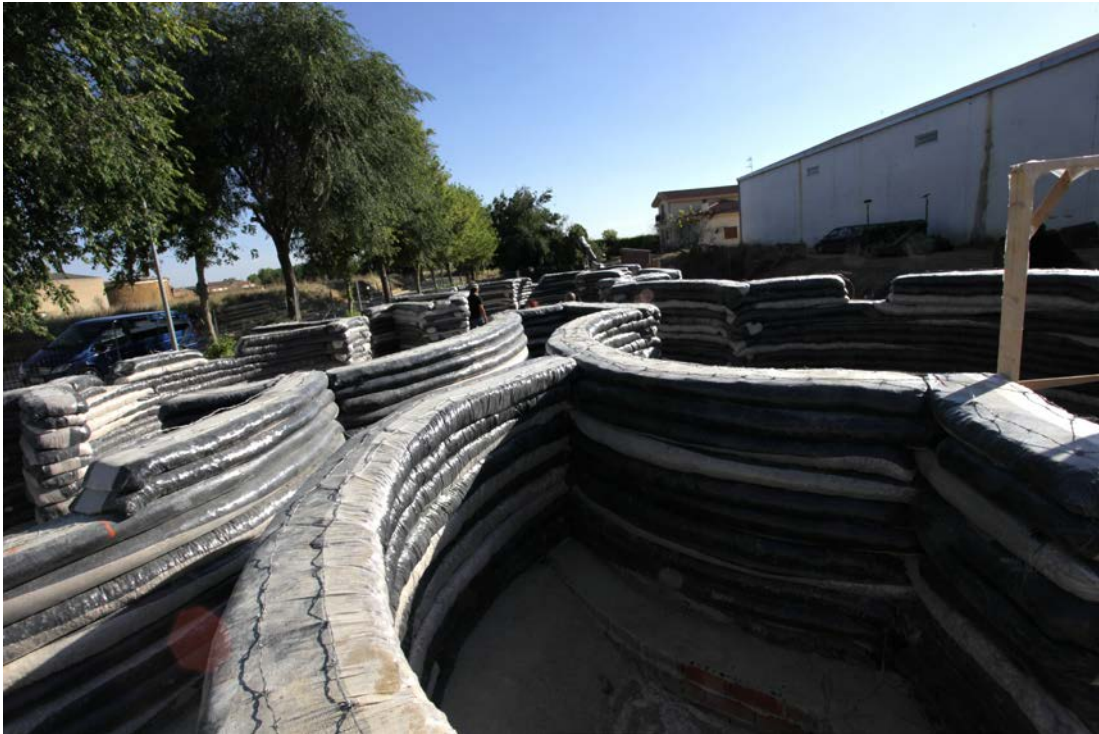
Figura 4. Imagen del proceso constructivo
