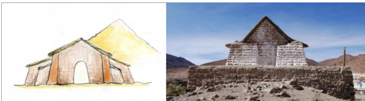
Figura 2. Modelo “estático gravitacional” que asemeja la forma del cerro. En la imagen a la derecha, la capilla de Nama en la región de Tarapacá. (Créditos: Natalia Jorquera)
