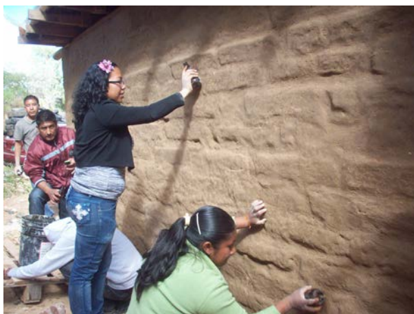
Acabado de revoque realizado por alumnos del Tecnológico de Teposcolula, Oaxaca, México
