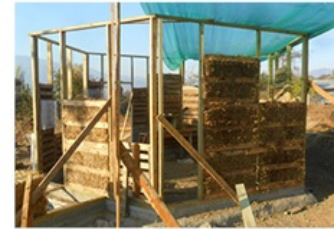
2. relleno y compactación con paja de trigo dentro de la estructura
