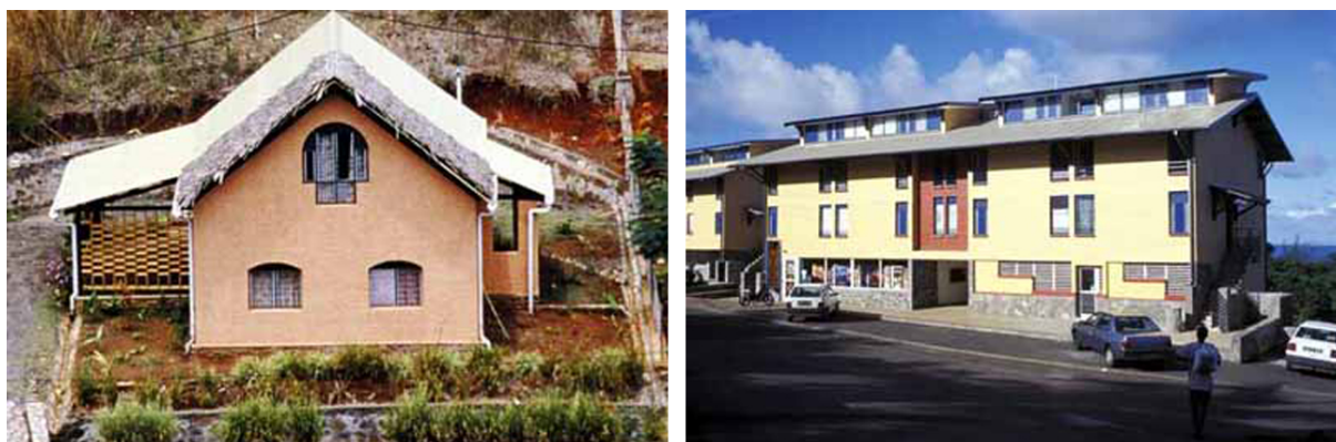
Figura 2. Construções em bloco de terra comprimida estabilizada com cimento, na Ilha Mayotte. Fonte: CRATerre apud Auroville.
