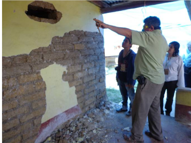
Figura 3. Retiro de aplanados de cemento-arena en la vivienda donde se realizaron las actividades del Taller de conservación de tierra, en la Comunidad de Capulálpam de Méndez. Foto: autor, 2012
