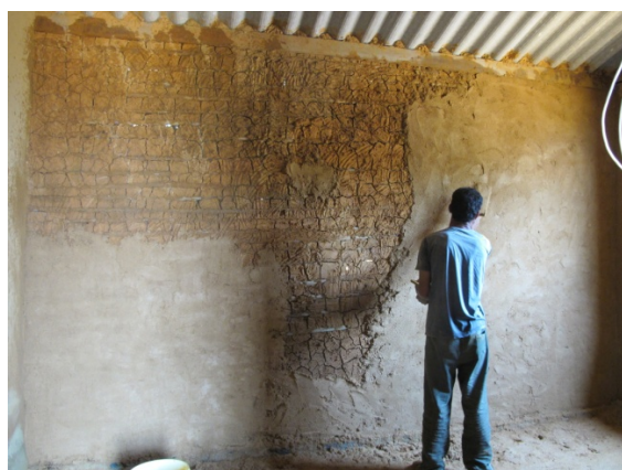
Figura 2. Oficina de reboco com terra e areia
