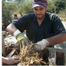
2. relleno y compactación con paja de trigo dentro de la estructura
