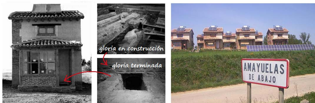
Figura 4. Viviendas bioclimáticas de tierra en Amayuelas de Abajo, Palencia, 2000
