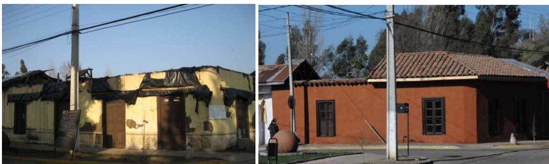
Figura 7. Imágenes antes y después de restauración una vivienda en Malloa (Créditos: equipo Arias Arquitectos)
