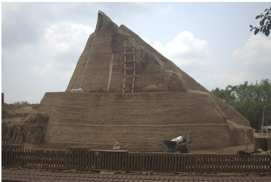
Figura 2. Talud de contención construido en el sector Norte y Noreste, para protección del corte en los rellenos del edificio (Foto A. Daneels, 16 de abril de 2011).
