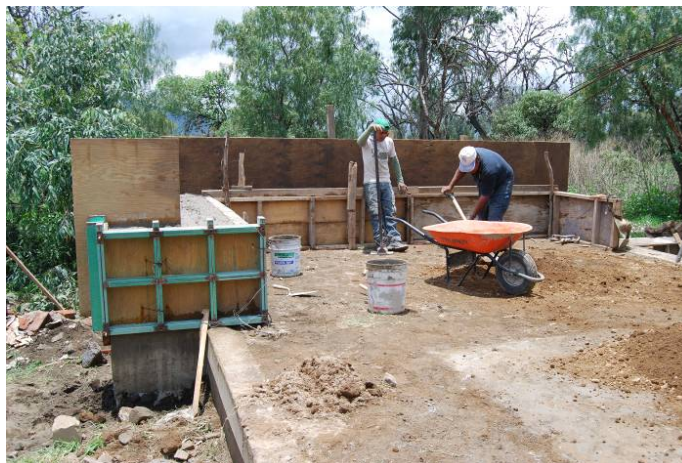
Figura 4. La primera hilada del muro de hormigón de tierra estabilizada (Foto: L. Guerrero)
