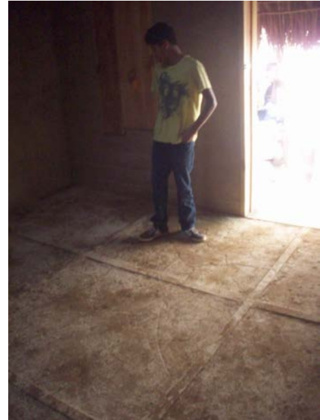
Primera capa de piso
