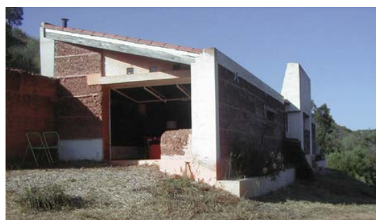
Figura 3 - Edifício contemporâneo em Troviscais, Odemira. Arq. Alexandre Bastos
