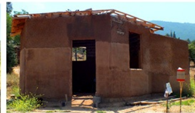
4. revoque de la estructura con una mezcla de tierra
