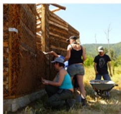
4. revoque de la estructura con una mezcla de tierra
