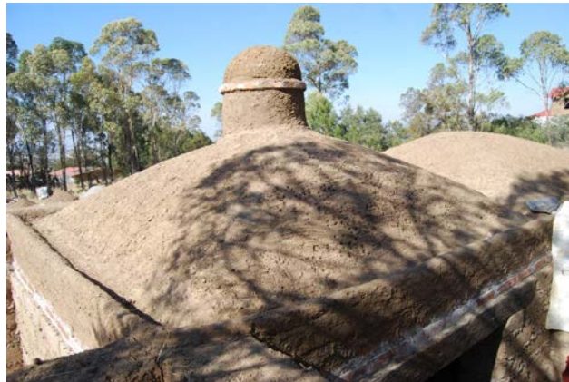
Figura 3. Anillo de refuerzo realizado con carrizos, haces de paja bañada en tierra arcillosa y cob (Foto: L. Guerrero, 2013).
