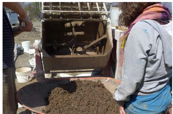
Figura 2. Batido mecánico de un mortero de tierra. Crédito: Bowman
