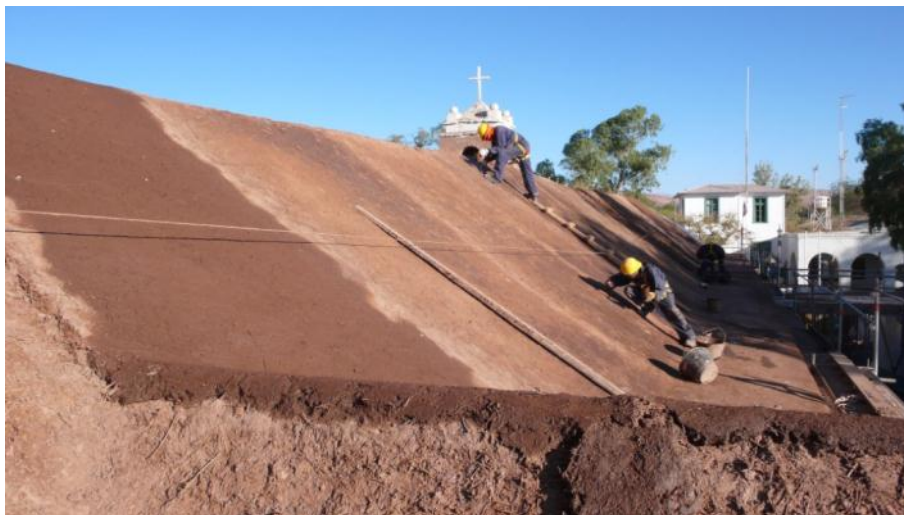
Figura 6. Aplicación de la segunda capa de 7 cm de espesor (Fernando Rivera, 2014)
