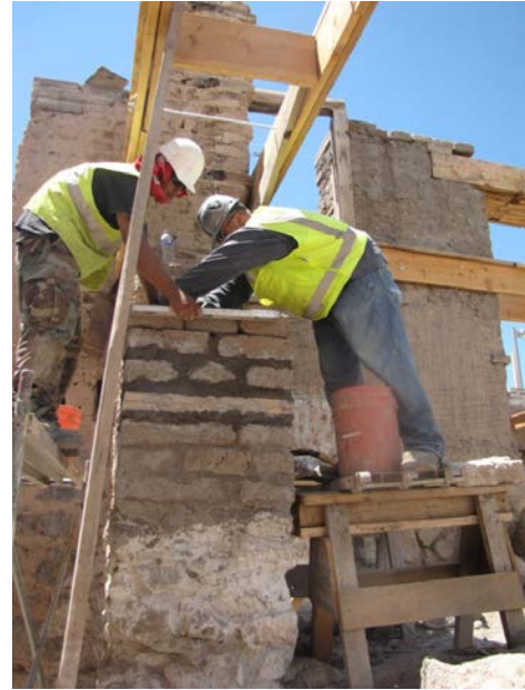
Figura 4. Jóvenes de la comunidad recuperando muro de adobe en el edificio del molino
