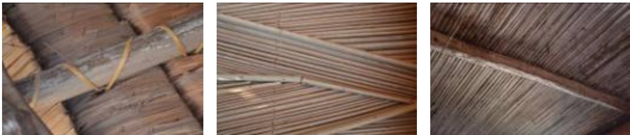
Figura 4: Exemplos de forros em bambu em Porto Novo, Ganvié e Adjarra (Créditos: Alexandre Mascarenhas, 2012)
