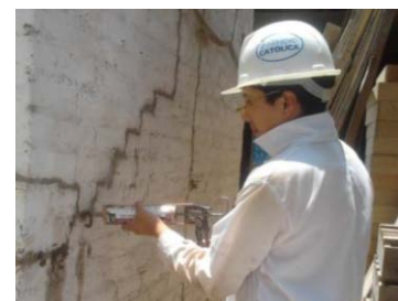
c) Inyección de barro líquido
