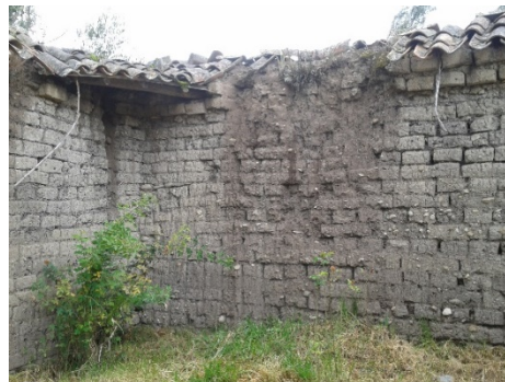
Figura 3 – Muro 2 esquina con muro 1: Cerramiento del Hospital Mariano Estrella, mayo 2015
