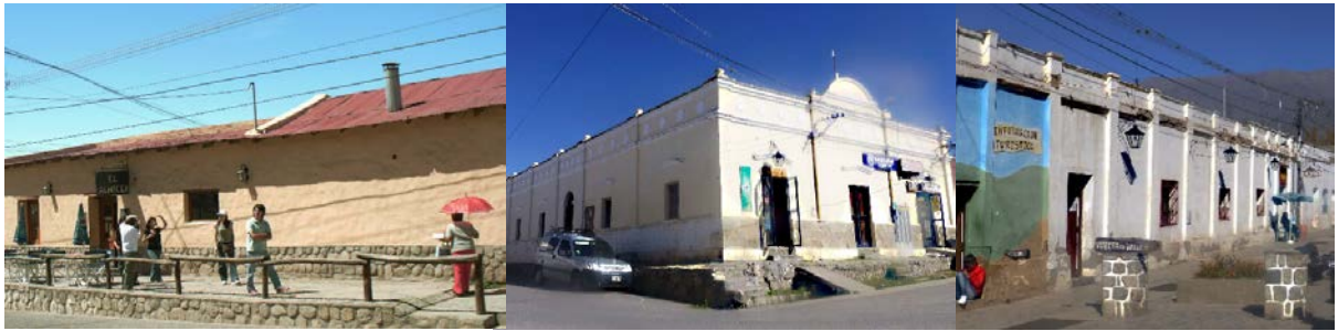
Figura 2. Fachadas del casco fundacional
