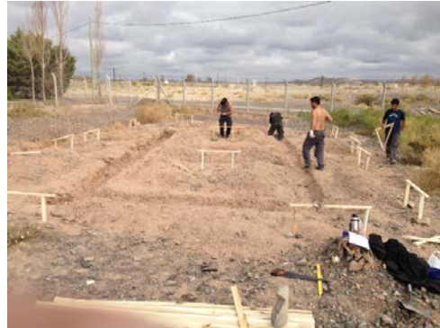
Figura 2. Replanteo de la obra
