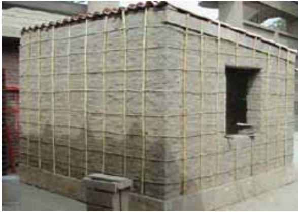
Figura 4. Malla natural mediante caña y cuerdas de fibra vegetal, (Blondet et al, 2007)
