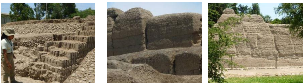
Figura 3. Arqueóloga L. Carrión frente a Huaca 33 y vista de las murallas 46A y 33A. La primera construida con adobitos hechos a mano, Cultura Lima, la segunda de tierra sola colocada en capas de poco espesor y la tercera de tierra y piedra pequeña mezcladas, siempre colocadas en capas. Parque las Leyendas, Complejo Maranga. Fotos: J. Vargas N.
