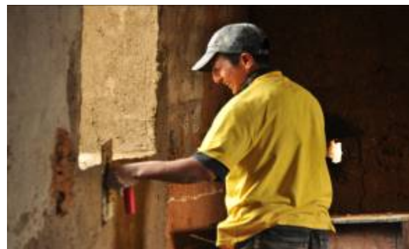
Figura 17. Acabado de filos de ventanas
