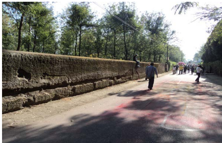
Figura 4. Muros lindero construidos de tierra compactada en Antigua Guatemala (Quiñónez, 2015).
