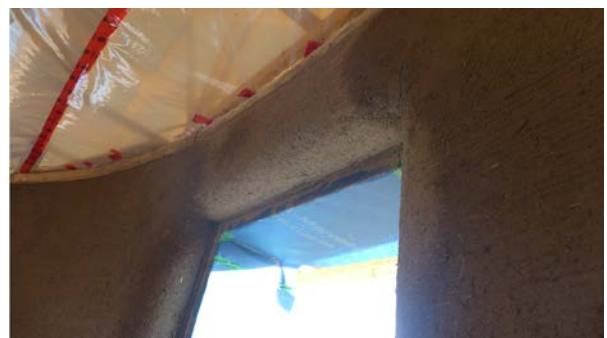
Figura 4. Segunda capa de mortero de tierra
