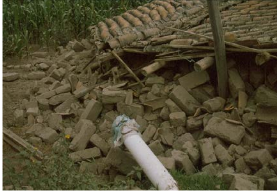
Figura 11 – El mortero debe garantizar la unión de las hiladas
