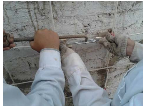
b) Templado de refuerzo horizontal
