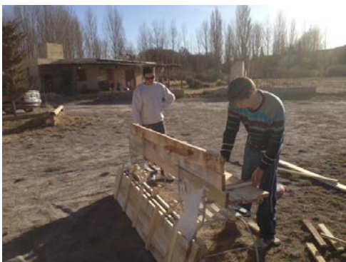
Figura 5. Armado de encofrado
