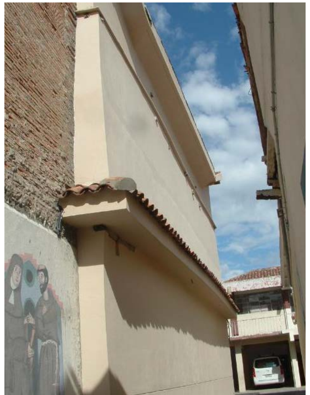
Figura 9. Muro terminado. Crédito: Baquero, 2014
