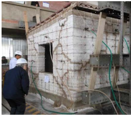
a) Inspección de daños
