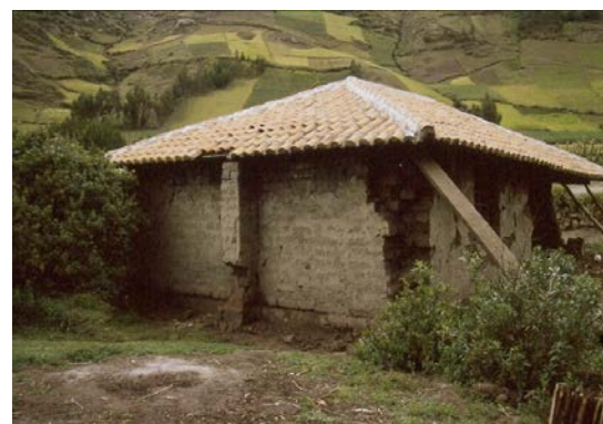
Figura 6 – Esquinas mal trabadas y sin refuerzo alguno, el contrafuerte falla por aplastamiento
