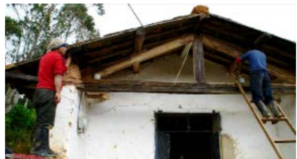
Figura 21. Aplicación de aceite de linaza a madera existente
