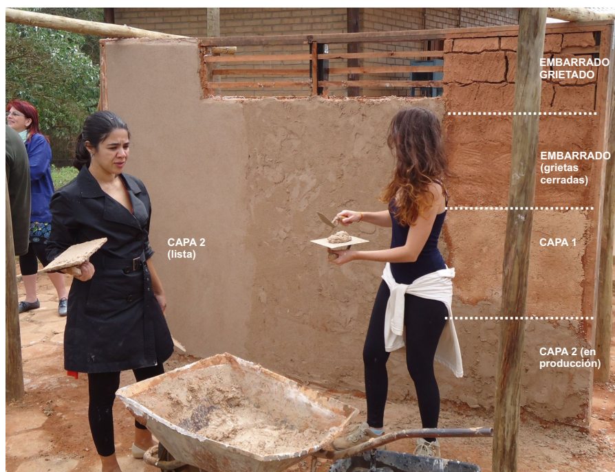
Imagen1: Actividad previa a la aplicación de pintura Fuente: Arq. Fernando Cardoso
