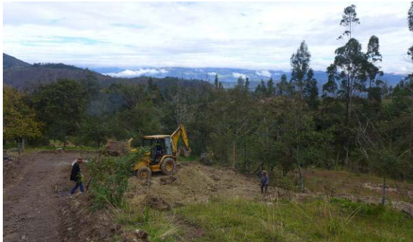
Figura 1. Nivelación del terreno
