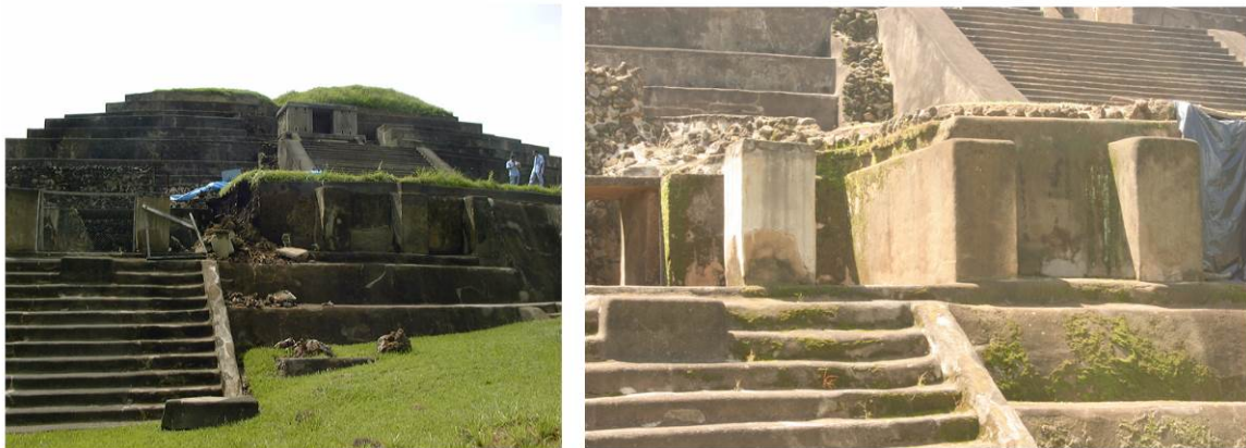
Figura 4 – Pared sur de la Sala Central de B1-1d-III antes y después de la restauración.
