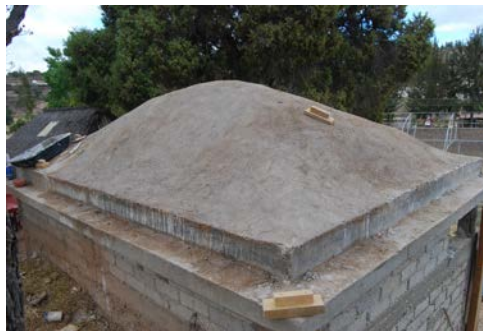
Figura 5. Acabado final con un revoque de cal y arena. (Foto: L. Guerrero, 2015).
