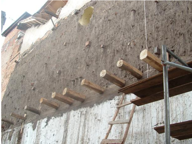
Figura 6. Vigas Llaves, cara exterior del muro. Crédito: Baquero, 2014
