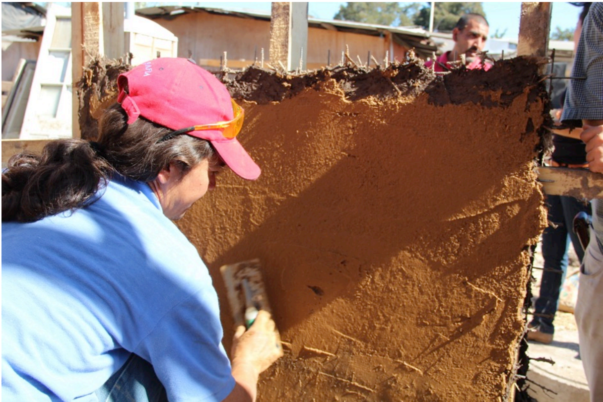
Figura 8- Capacitación a equipos de constructores a cargo de la reconstrucción en la localidades de Santa Cruz, región del Maule, Chile. Crédito: Cristian Muñoz
