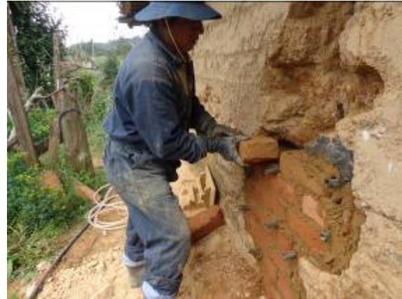
Figura 9. Consolidaciones, cocidos y descocidos de muros
