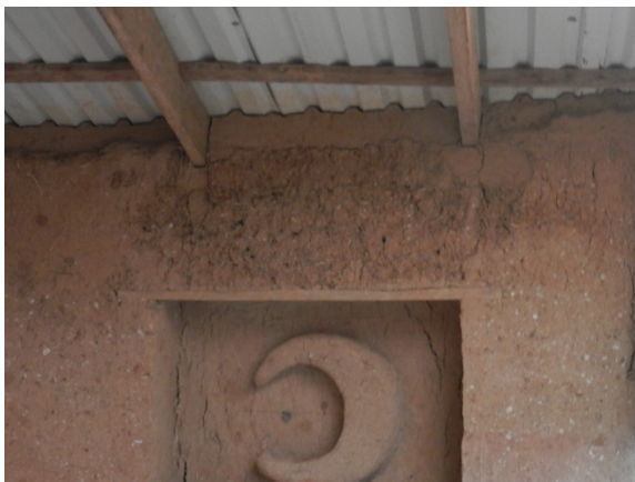
Figuras 3 y 4. Falta de dinteles. Falla en el empalme de la madera y grietas en los apoyos del larguero
