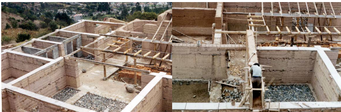
Figura 4. Muros de tapial en construcción
