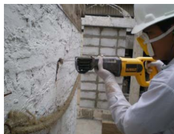
b) Uso de cuchillo eléctrico
