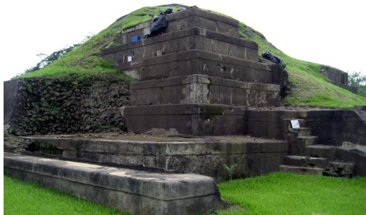
Figura 4– Intervención finalizada en la esquina Noreste del cuerpo superior de la Estructura 1.
