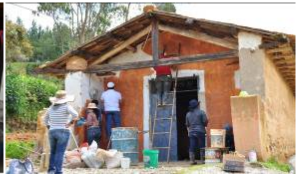
Figura 19. Aplicación de la pintura de tierra en la fachada de la capilla
