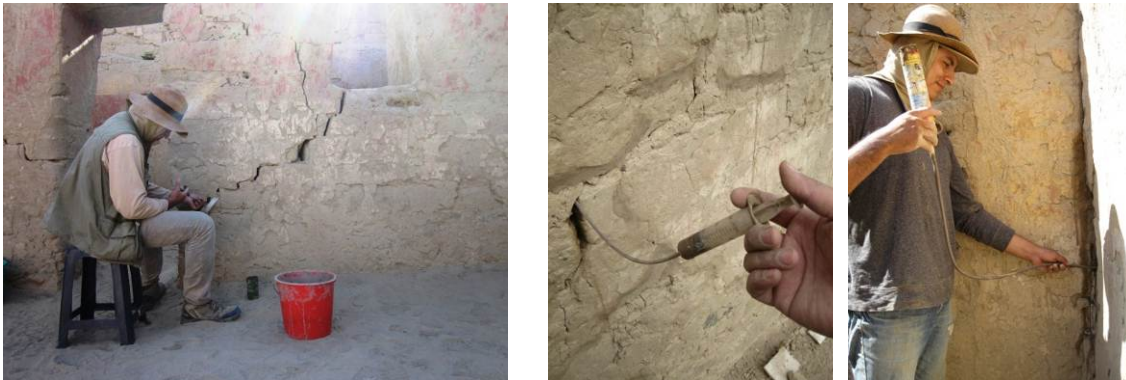
Figura 7 – Proceso de inyección del barro líquido en las grietas, se usaron instrumentos para ejercer presión o por gravedad. Fotos: Proyecto Tambo Colorado (2014)
