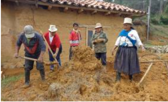
Figura 12. Proceso de elaboración del revoque
