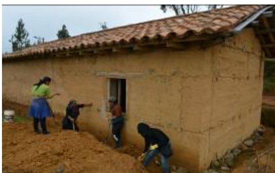
Figura 10. Excavación de zanjas perimetrales para desalojo de aguas lluvias
