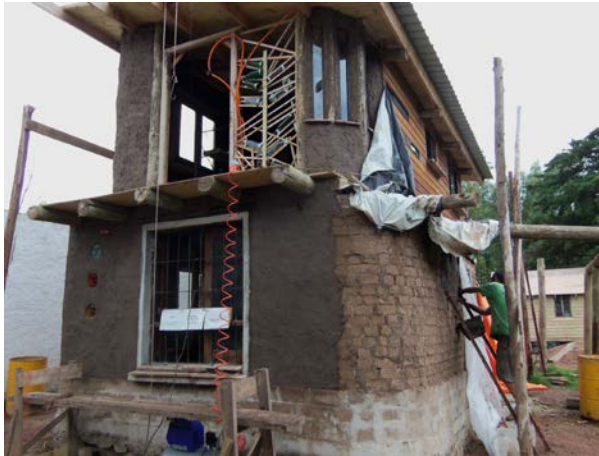
Figura 2. Revoque de arcilla sobre adobe. Zócalo de BTC
