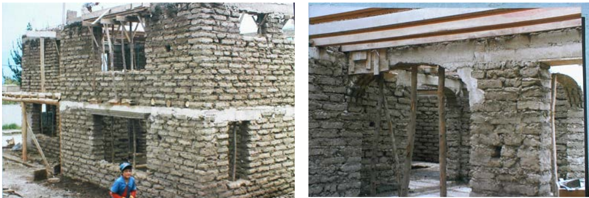
Figura 12 – Construcción con poca mampostería; esquinas poco estables; se puede intuir que tiene poca área de muros
