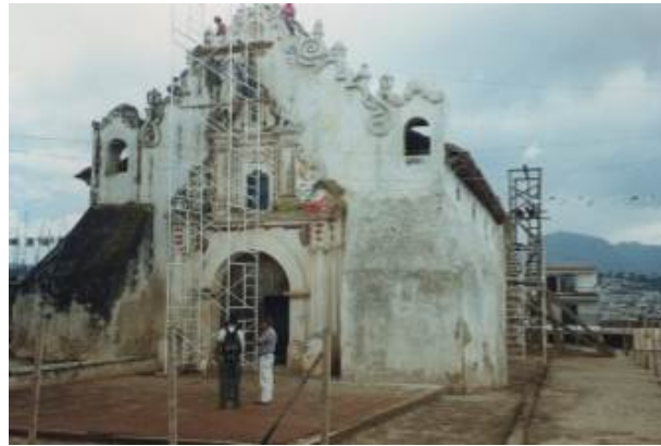
Figura 6. Templo durante el proceso de consolidación (Quiñónez, 2002)
