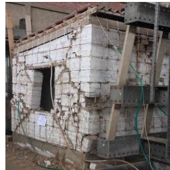
b) Daños en el ambiente de adobe
