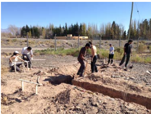
Figura 3. Excavación de zanjas
