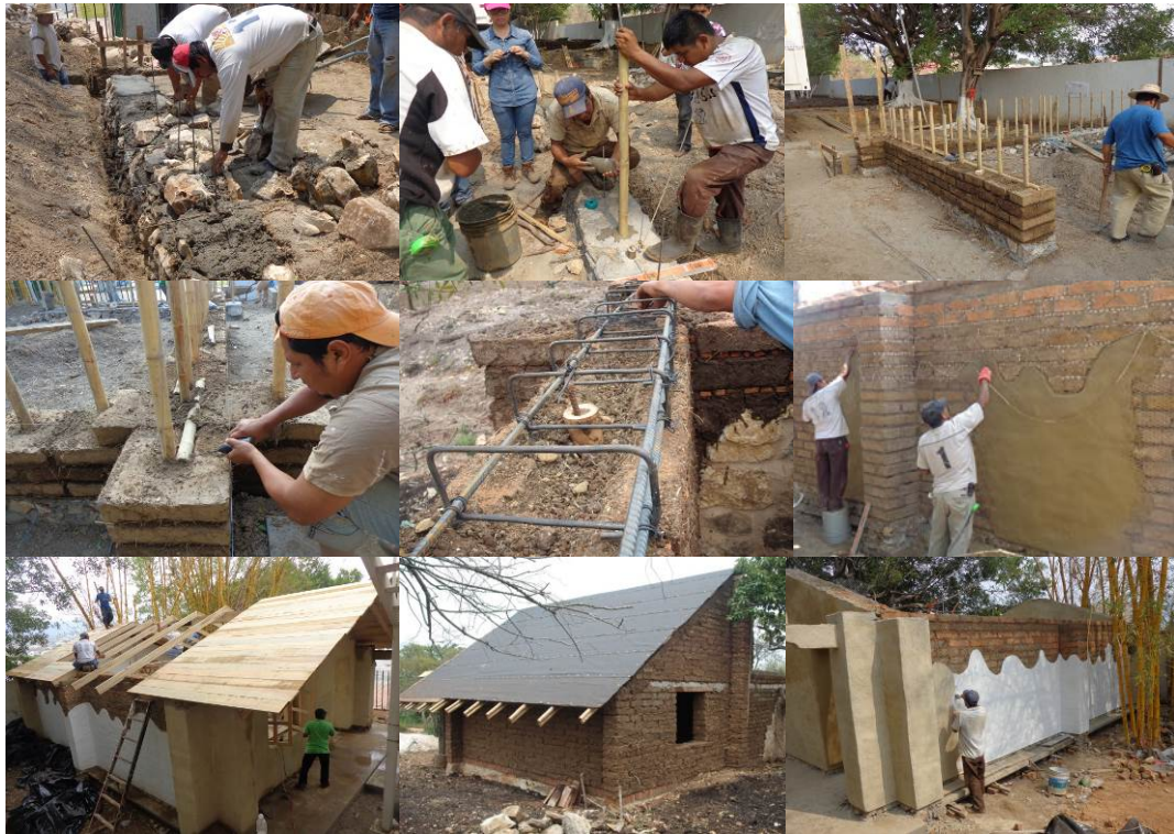
Figura 1- Proceso constructivo del adobe sismo-resistente (S-R)
