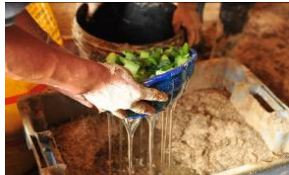
Figura 15. Incorporación del mucílago de tuna como aglutinante del empañete
