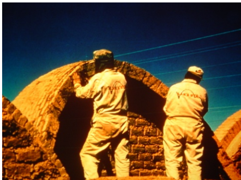
Figura 4. Ejecución bóveda catenaria, Lahuachaca, Bolivia (Crédito: Paz, 1990)
