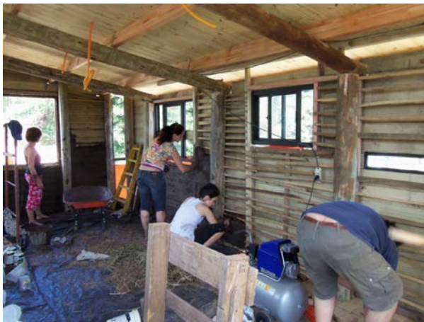
Figura 3. Jornada de embarrado de paneles de fajina
