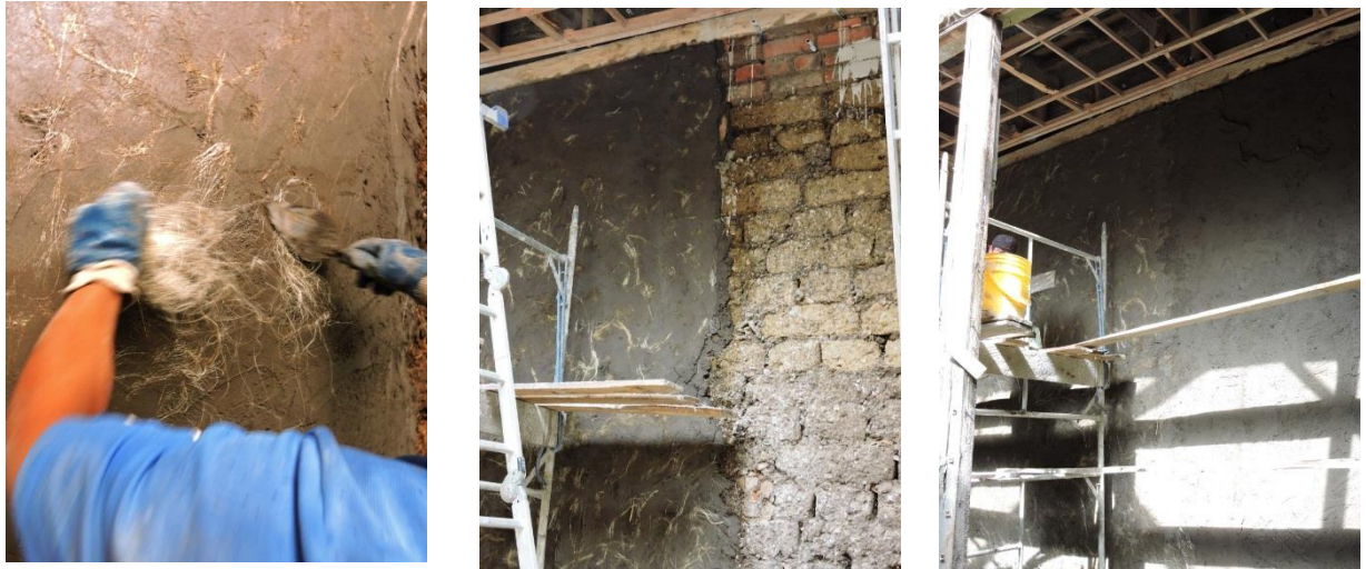
Figura 2. Aplicación de la primera capa de “cabuya enredada” en un muro de adobe
