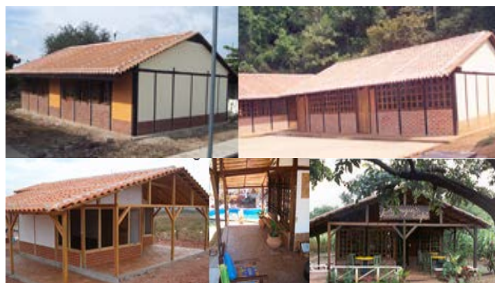
Figura 4b – Diversas obras concluidas con el sistema de bajareque mejorado
