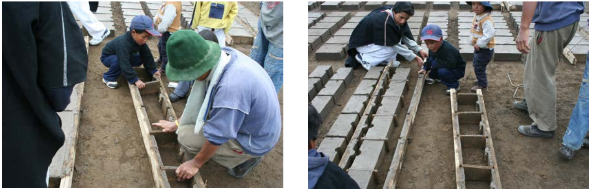
Figura 13 – Elaboración de adobes en una escuela rural
