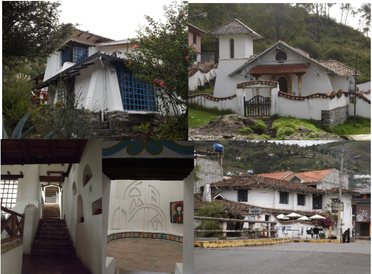
Figura 5. Construcciones de tapial en Paute
