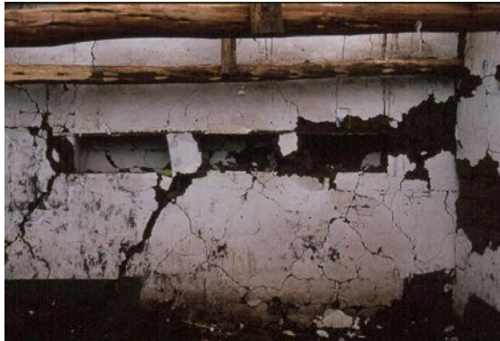
Figura 8 – El tamaño del vano se transforma en un plano de falla
