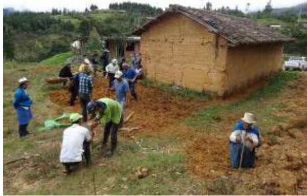
Figura 1. Trabajos previos para la realización del taller, limpieza del terreno
