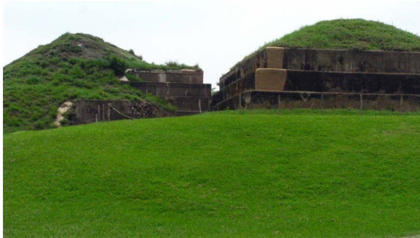
Figura 6– Ambas intervenciones finalizadas
