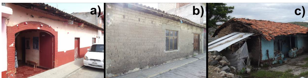
Figura 3. Variante en la condición física de las viviendas de Malinaltenango. a) Buena condición, b) Condición regular y c) Mala condición.
