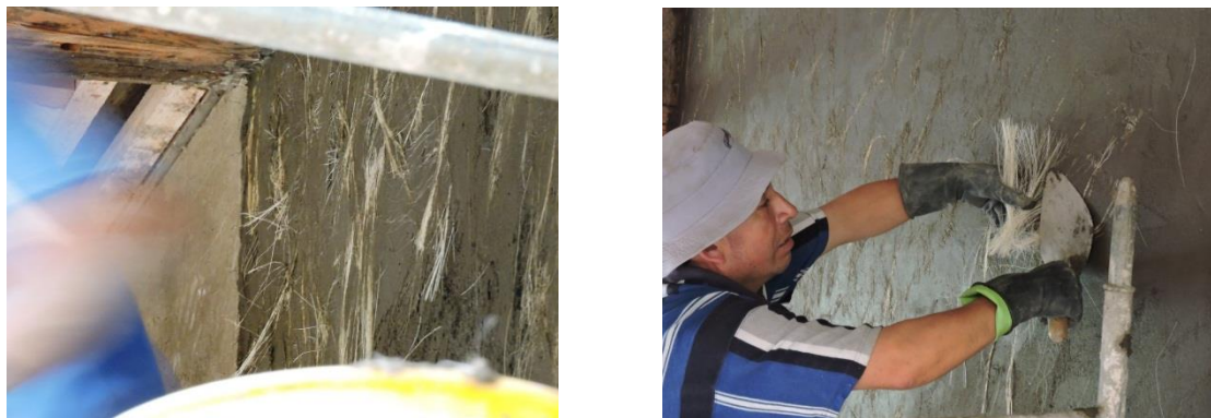
Figura 3. Aplicación de la segunda capa de “cabuya peinada” en un muro de adobe
