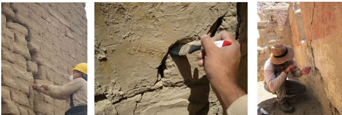
Figura 5 – Limpieza de las grietas antes de la inyección de barro líquido empleando diversas herramientas
