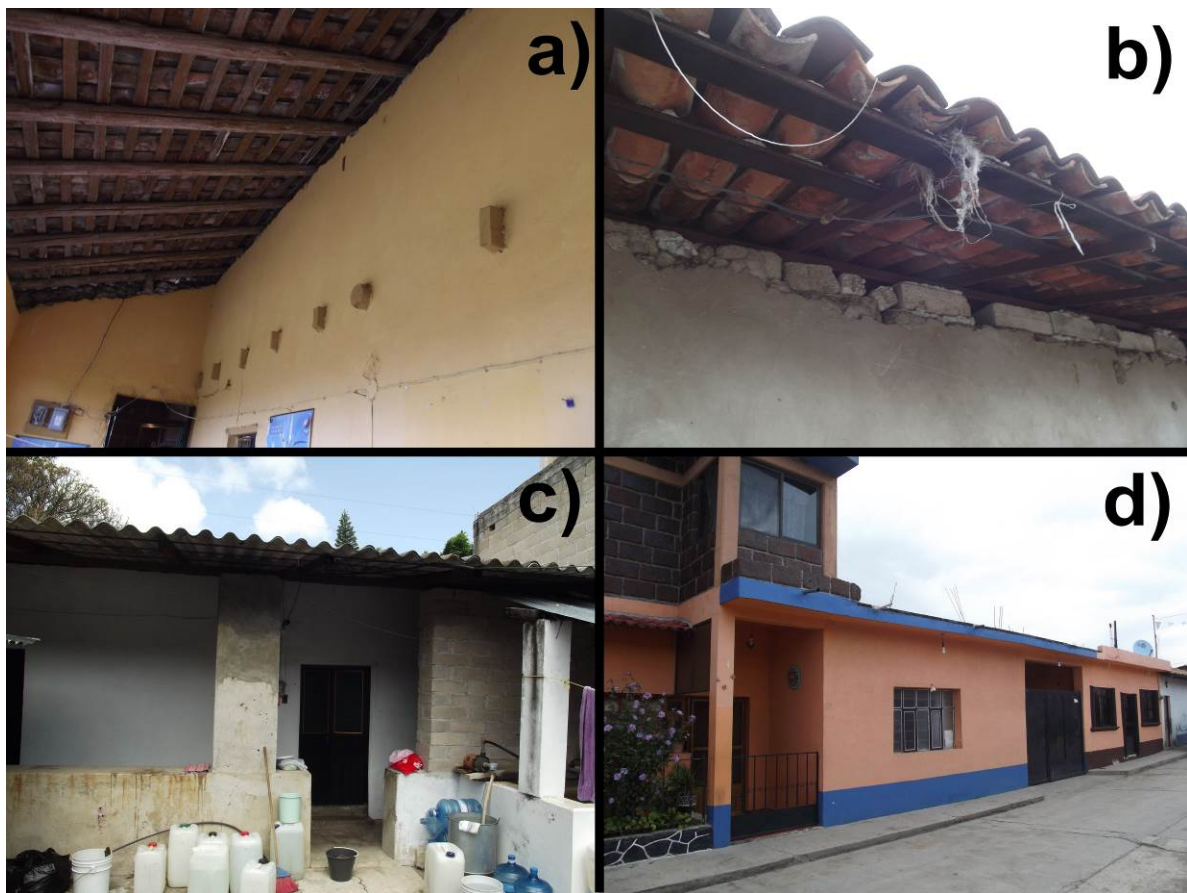
Figura 5. Tipos de techos en las viviendas de adobe de Malinaltenango. a) Tejas con morillos de madera; b) Tejas con estructura mixta de madera y metal; c) Techo de lámina de asbesto sobre estructura de metal; y d) Techo colado.
