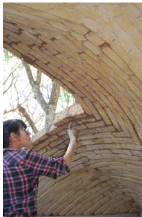
Figura 1. Trazo de las hiladas de las bóvedas de adobes recargados (Foto: L. Guerrero, 2015).
