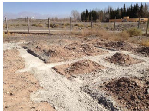
Figura 4. Hormigonado cimiento
