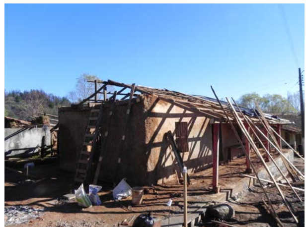
Figura 6. Desarme de vivienda
