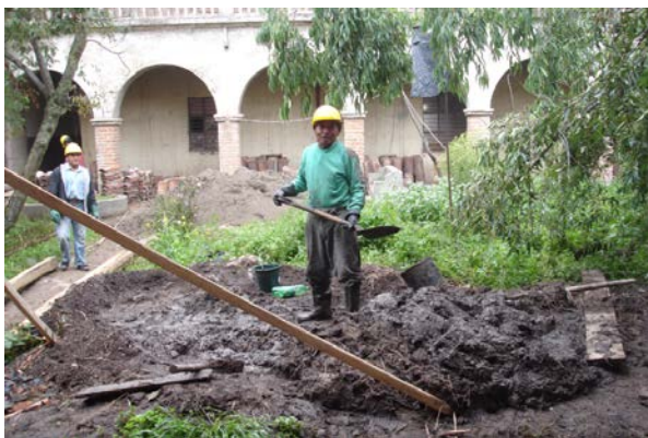
Figura 1. Batido manual de un mortero de tierra
