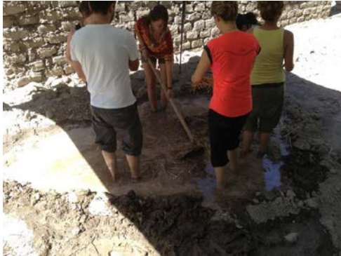
Figura 1. Elaboración de adobes
