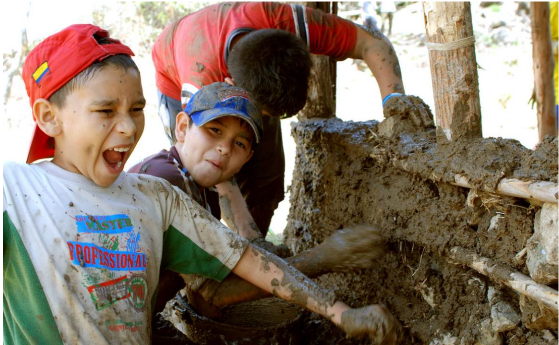
Figura 2. Niños construyendo un muro en bahareque para el Museo Textil de Guane
