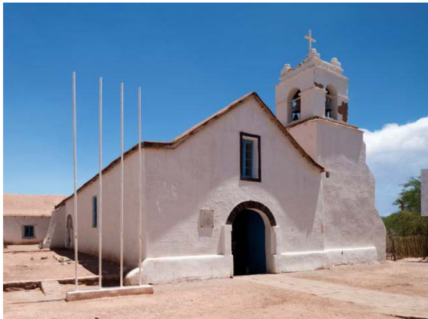
Figura 1. Iglesia San Pedro de Atacama (Cristóbal Correa, 2014)
