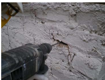
a) Uso de taladro eléctrico
