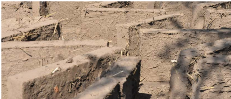
Figura 4. Construcción de adobes zona centro sur de Chile. Registro 2015.
