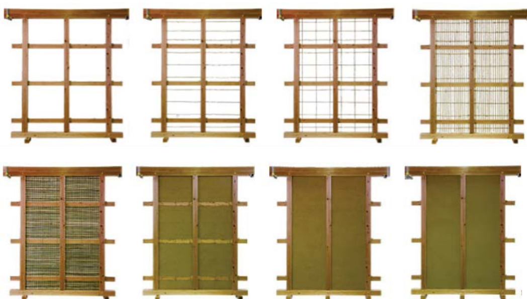
Figura 1: Sequencia da montagem do entramado e aplicação do barro Fonte: tsuchikabe network
