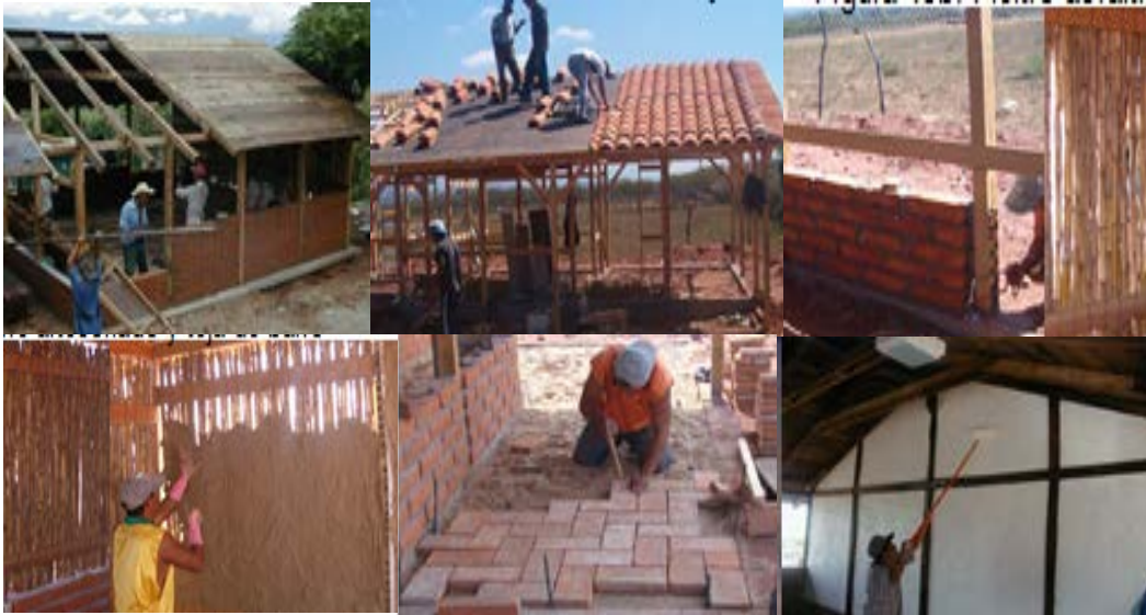
Figura 3b- Desarrollo del proceso constructivo del bajareque mejorado
