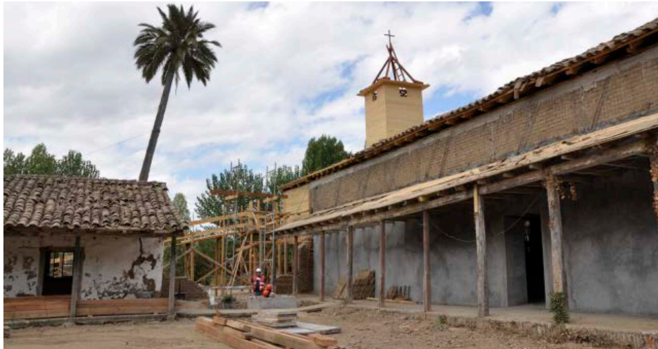
Figura 3. Reparación iglesia San Pedro de Alcantara, fuente COTTA Chile
