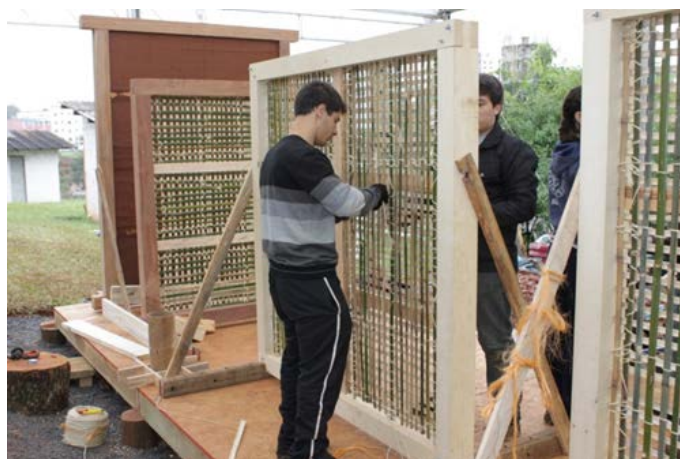
Figura 5: Atando os feixes de bambu no painel. Crédito: Ceneviva, 2013
