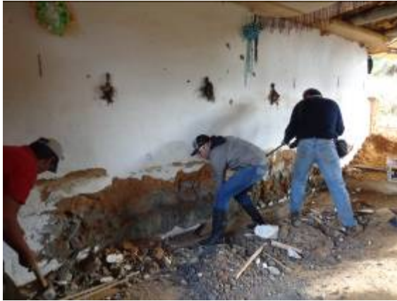
Figura 8. Liberación del revestimiento de cemento de los muros de tapia
