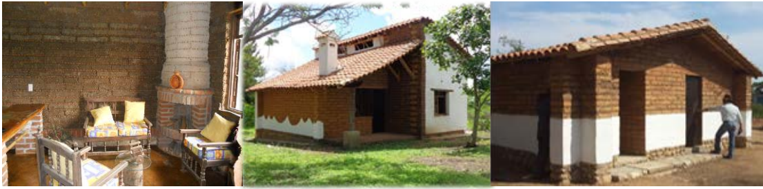
Figura 2b- Diversas obras concluidas con el sistema de adobe sismo-resistente
