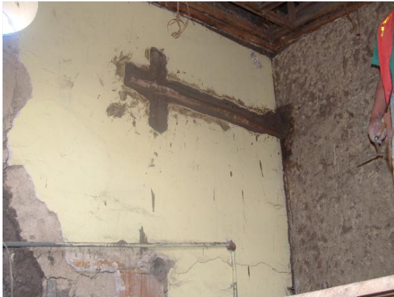
Figura 4. Llaves de madera en el nivel superior, entre muros de adobe y muros de bahareque. Crédito: Baquero, 2014
