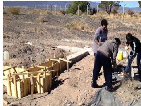
Figura 6. Hormigonado sobrecimiento
