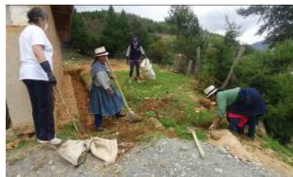
Figura 11. Limpieza y mantenimiento de zanjas
