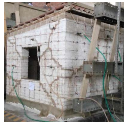
d) Ambiente de adobe reparado y reforzado
