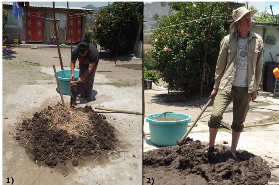
Figura 4. Proceso de elaboración de adobes, concretamente de la muestra 4: 1) preparación de tierra y agregado de pasto seca; 2) revoltura a pie descalzo y azadón.
