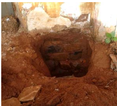
Figura 9. Cimentación de piedra bruta colocada que soporta el muro de la fachada.
