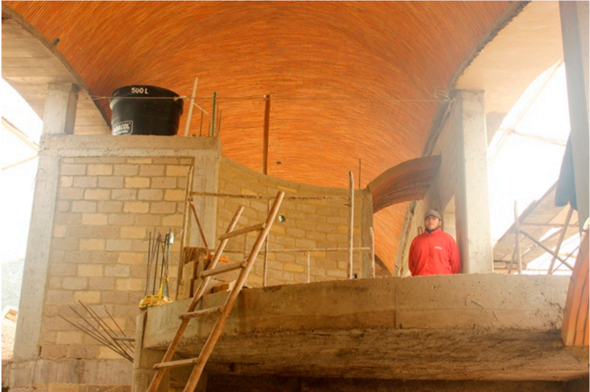
Figura 5 – Sensación espacial de la obra, vista interior desde la sala al estar.
