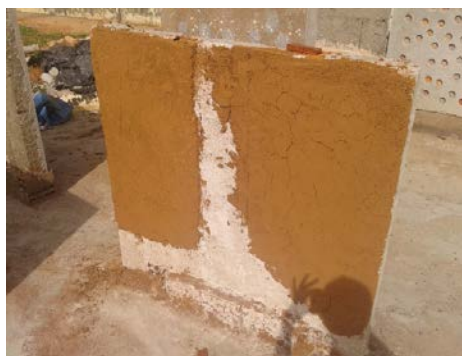
Figura 2 – Parede 1 (à esquerda, reboco com fibra de jornal; à direita, reboco com fibra de sisal)
