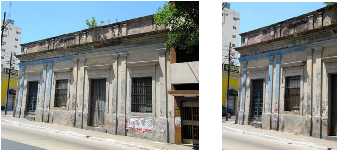
Figura 5. La obra en forma previa a que los ex-propietarios la hayan destechado
