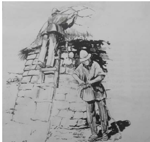
Figura 10 – Los arcos se cubren con una lámina circular de arcilla y paja llamada wara, para ponerla se corta en piezas trapezoidales
