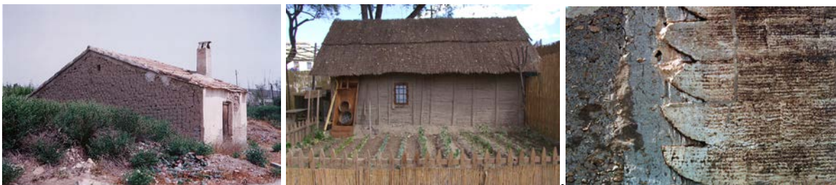
Figura 4. Casa de adobe en zona de huerta de Lorca. Barraca de testeros recreada en Murcia. Tapia con brecas de yeso en zona de Caravaca (fotos FJ. López Martínez).
