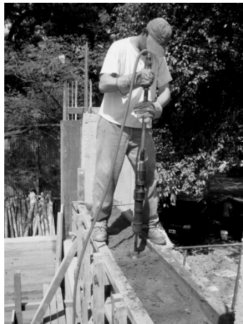
Figura 2 – Muro monolítico - tapial
