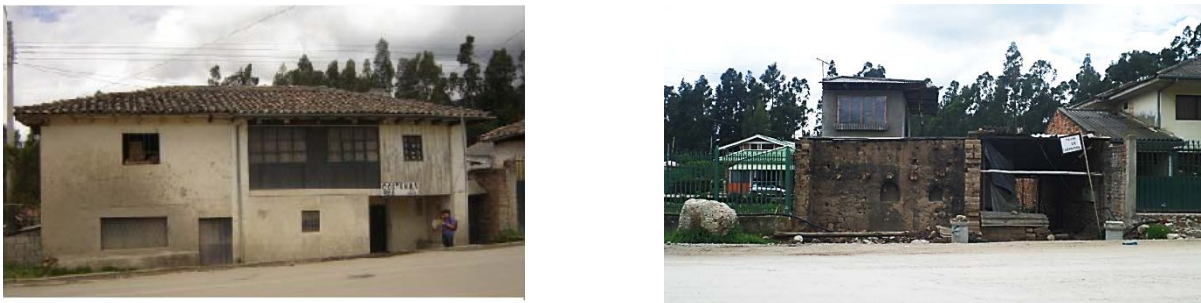
Figura 10. Vivienda de adobe en la avenida Ordoñez Lazo antes de la ampliación y después de la ampliación vial, 2015 (Créditos: Tatiana Pérez)
