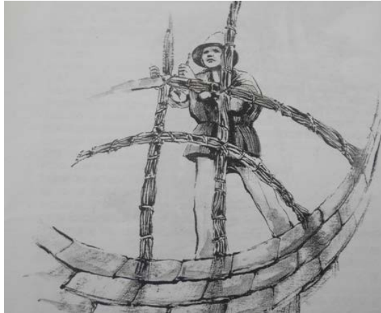
Figura 7– El último anillo formado por los tepes llega a una altura de 2,20 m. Este aro está formado por tepes de mayor grosor (0,45 m) ya que debe resistir el peso de la cúpula
