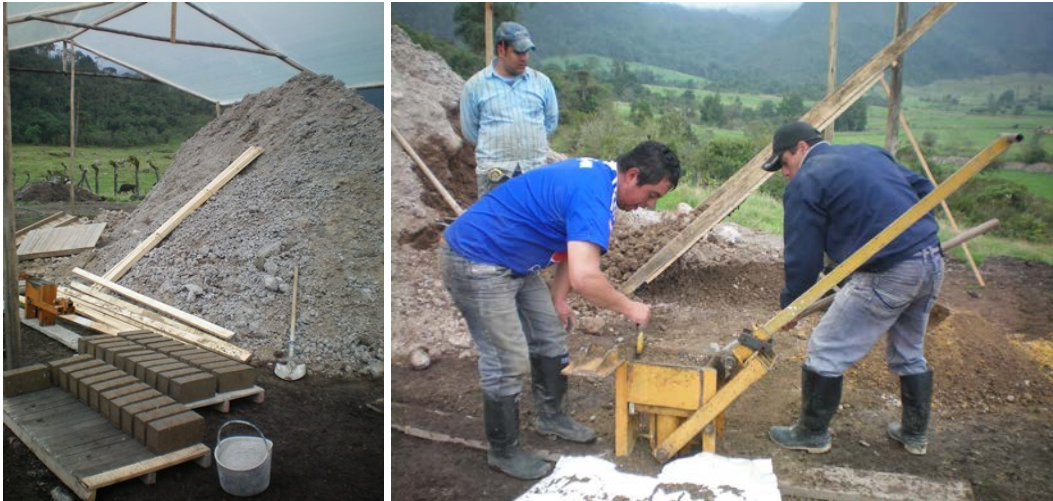
Figura 3 – Producción de BTC in situ con dos máquinas Cinva Ram
