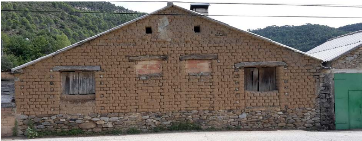
Figura 2. Edificio construido con adobes en la localidad de Besians (Huesca)
