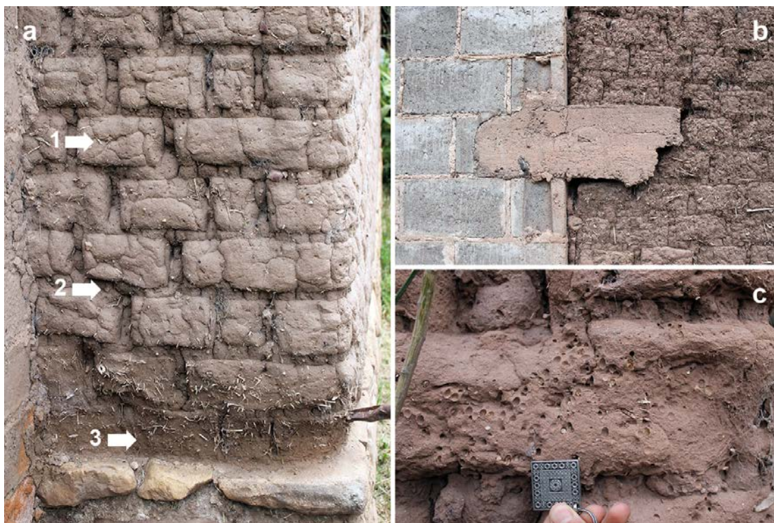
Figura 6. Deterioros observados: a). 1. Cuarteado, 2. Merma de relleno en junta, 3. Pulverización; b) Incompatibilidad estructural; c) Biodeterioro
