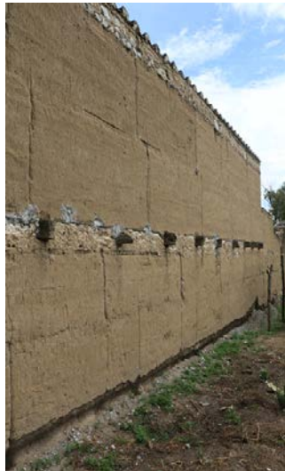
Figura 1. Muro tradicional de tapia de tierra en San Andrés Payuca, Puebla, México
