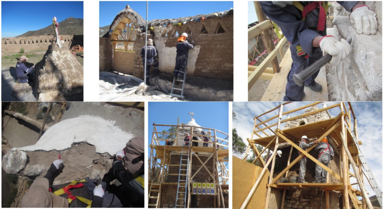
Figura 8. Fabricación de adobes y apagado de cal viva, liberación de revoques en el conjunto religioso, liberación y consolidación de la torre campanario, 2016
