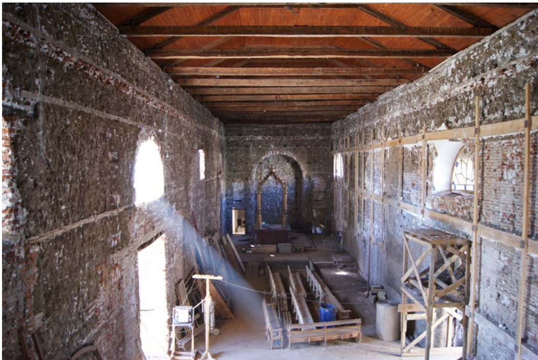
Figura 1: Vista interior de la nave iglesia liberada de los estucos, se aprecian las diferentes materialidades y llaves de madera de refuerzos
