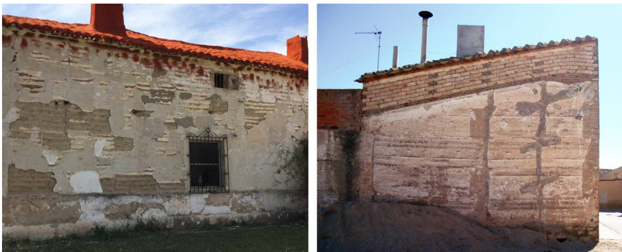
Figura 6. Imágenes de intervenciones comunes en coronaciones de muros de tapia. Iz: Muro de tapia en Fuensanta. Der: Muro de tapia en Minaya.
