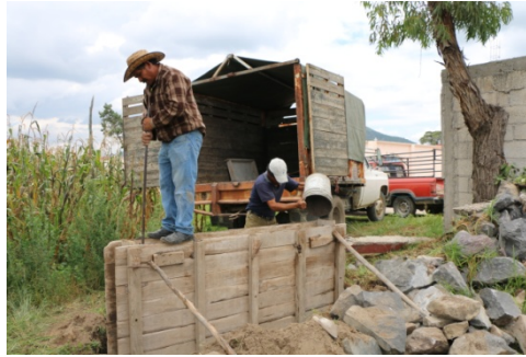
Figura 6. Procedimiento constructivo, encofrado de madera y apisonado
