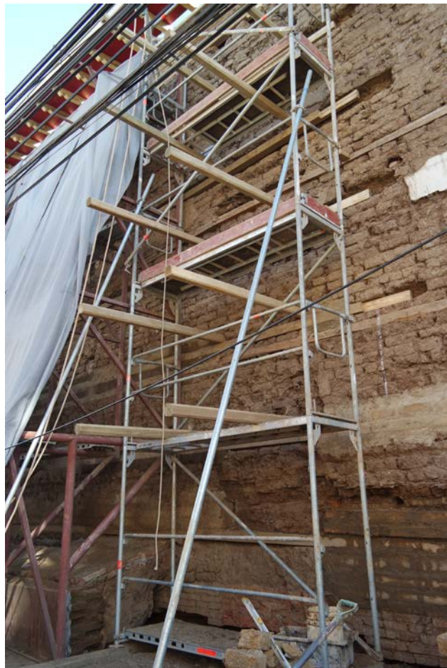
Figura 2: Vista exterior de la reconstrucción de los contrafuertes del muro sur con llaves de madera de pino 4x4” de pino impregnado
