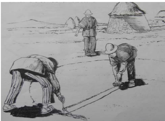
Figura 3—Se traza inicialmente un círculo de aproximadamente 2,40 m de radio externo
