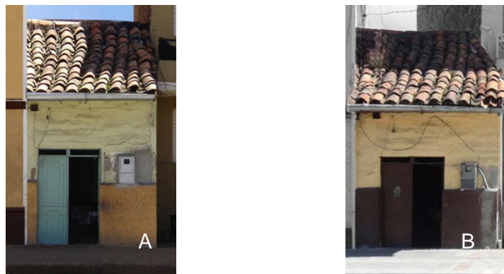
Figura 2: (A) referencia histórica del estado de la edificación 008 en el año 2006. Fuente: Aguirre 2006. (B) referencia histórica del estado de la edificación en el año 2013. Fuente: Opción de Restauración 2012 - 2013
