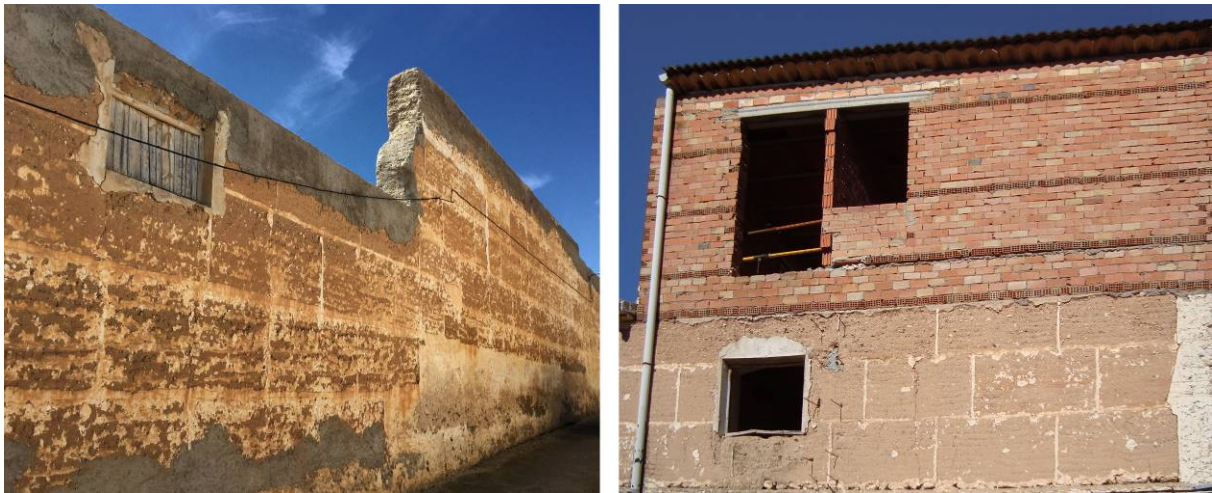
Figura 5. Imágenes de intervenciones comunes en coronaciones de muros de tapia. Iz: Muro de tapia en Fuensanta. Der: Muro de tapia en Minaya.
