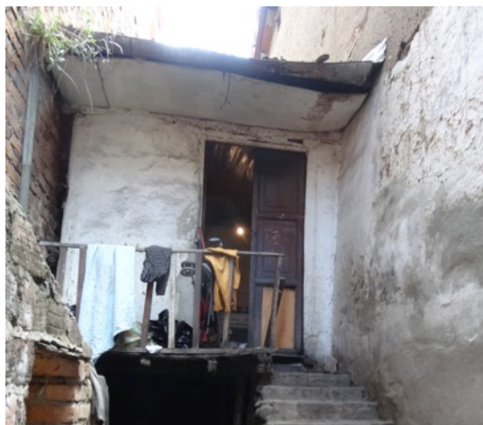
Figura 6. Deformación de las piezas de madera en cubierta y piso en la segunda crujía de la edificación 008. Fuente: Proyecto vliirCPM .
