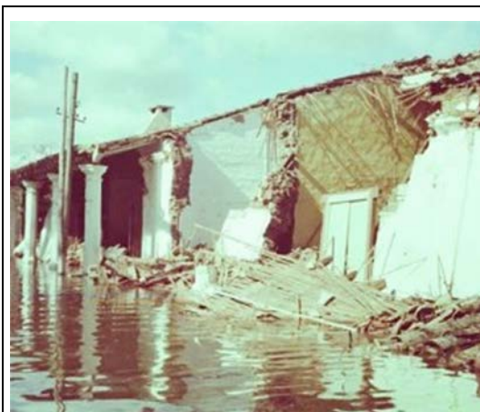
Figura 4: Desplome de muros de adobe en Pilar (Diario Ultima Hora, 2014)
