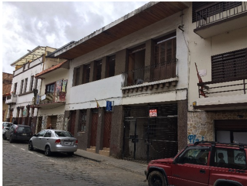
Figura 6. Casa Carvalho antes de la intervención
