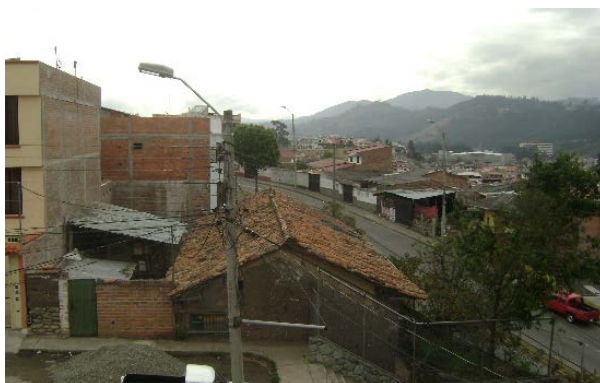
Figura 8. Vivienda Monay, antes de la intervención.
