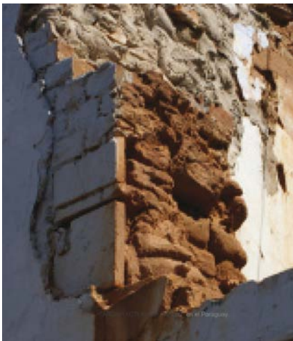
Figura 9: Detalle constructivo de un muro cáscara para una fachada “tapa” (Ríos, González, Gill, 2009)
