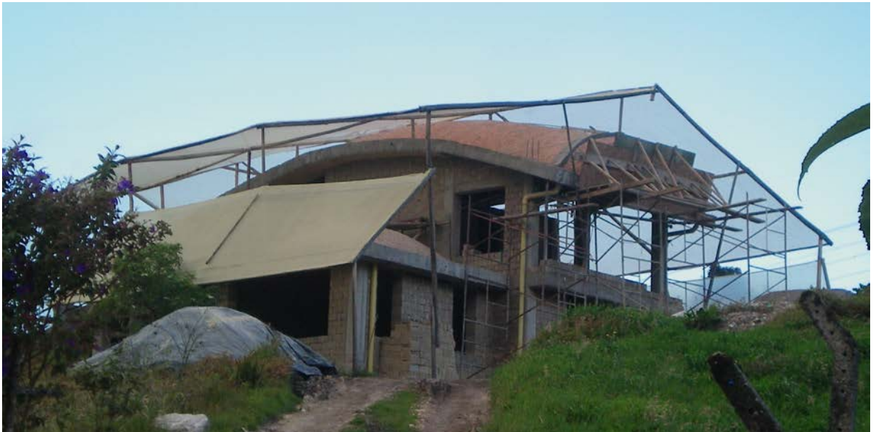
Figura 6. Carpa temporal en la obra de paramo /arquitectura para zonas húmedas en Colombia.
