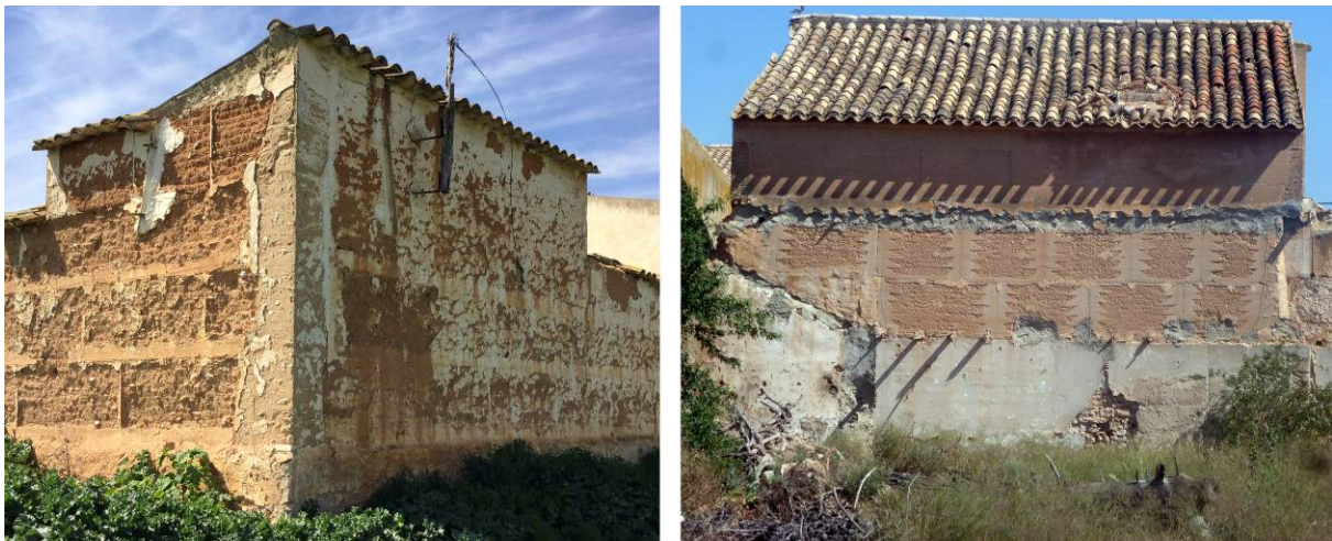
Figura 4. Imágenes de diversas variantes de tapia frecuentes en la comarca. Iz: tapia reforzada en las juntas y en las esquinas en Tarazona de la Mancha. Der: tapia reforzada con forma de cuñas en las juntas verticales en Barrax
