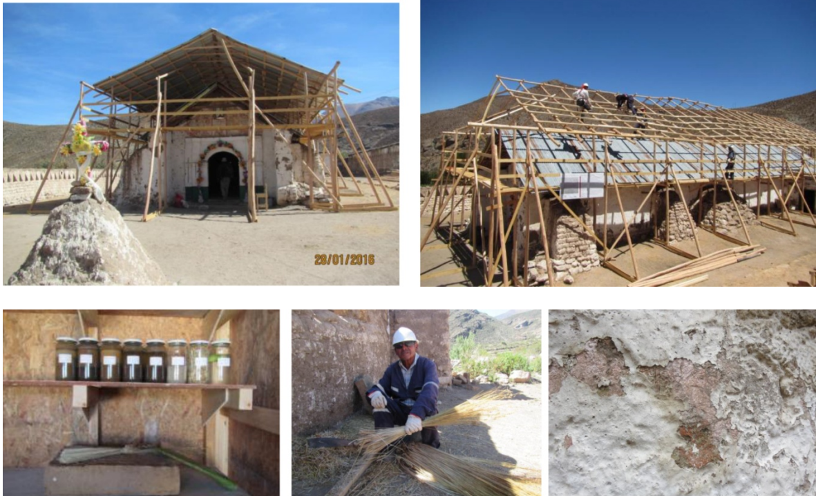
Figura 7. Instalación de sobrecubierta, Instalación de laboratorio en obra, acopio de materiales calas exploratorias, 2016
