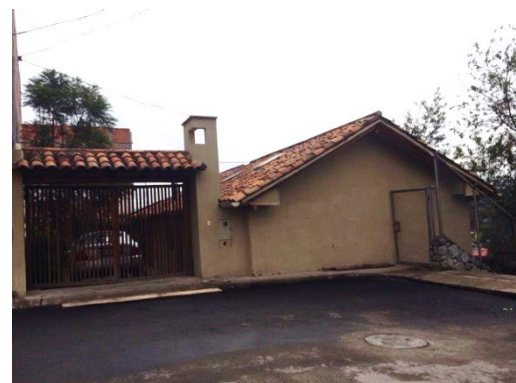
Figura 9. Vivienda Monay después de la intervención de conservación, 2014
