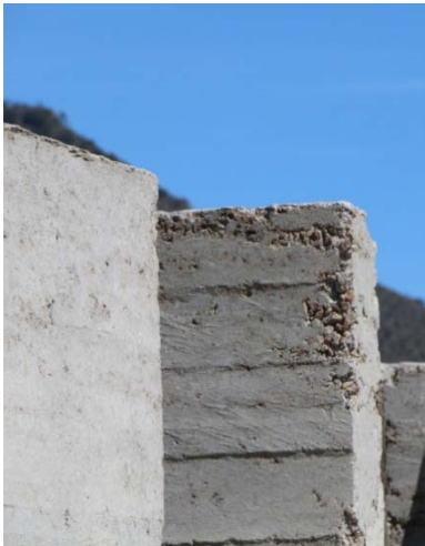
Figura 2. Muro de tapia de cal y piedra pómez. Tepeyahualco, México
