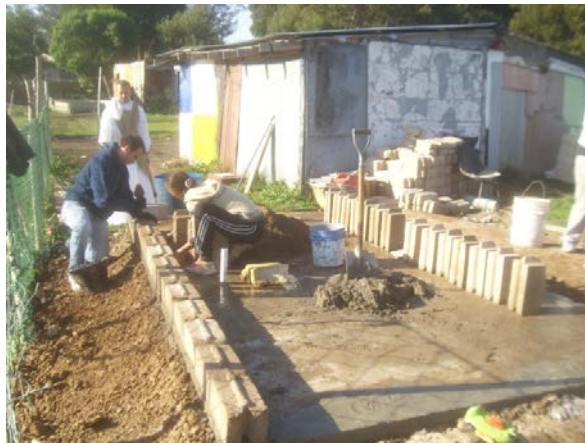
Figura 3. Inicio de la construcción de muros de BTC sobre platea de hormigón.
