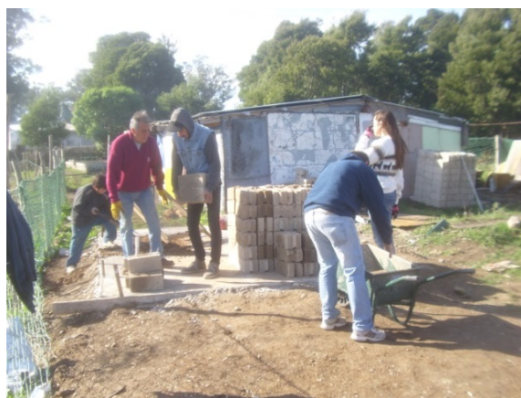
Figura 2. Traslado y acopio a pie de obra de los BTC para ampliar una vivienda existente
