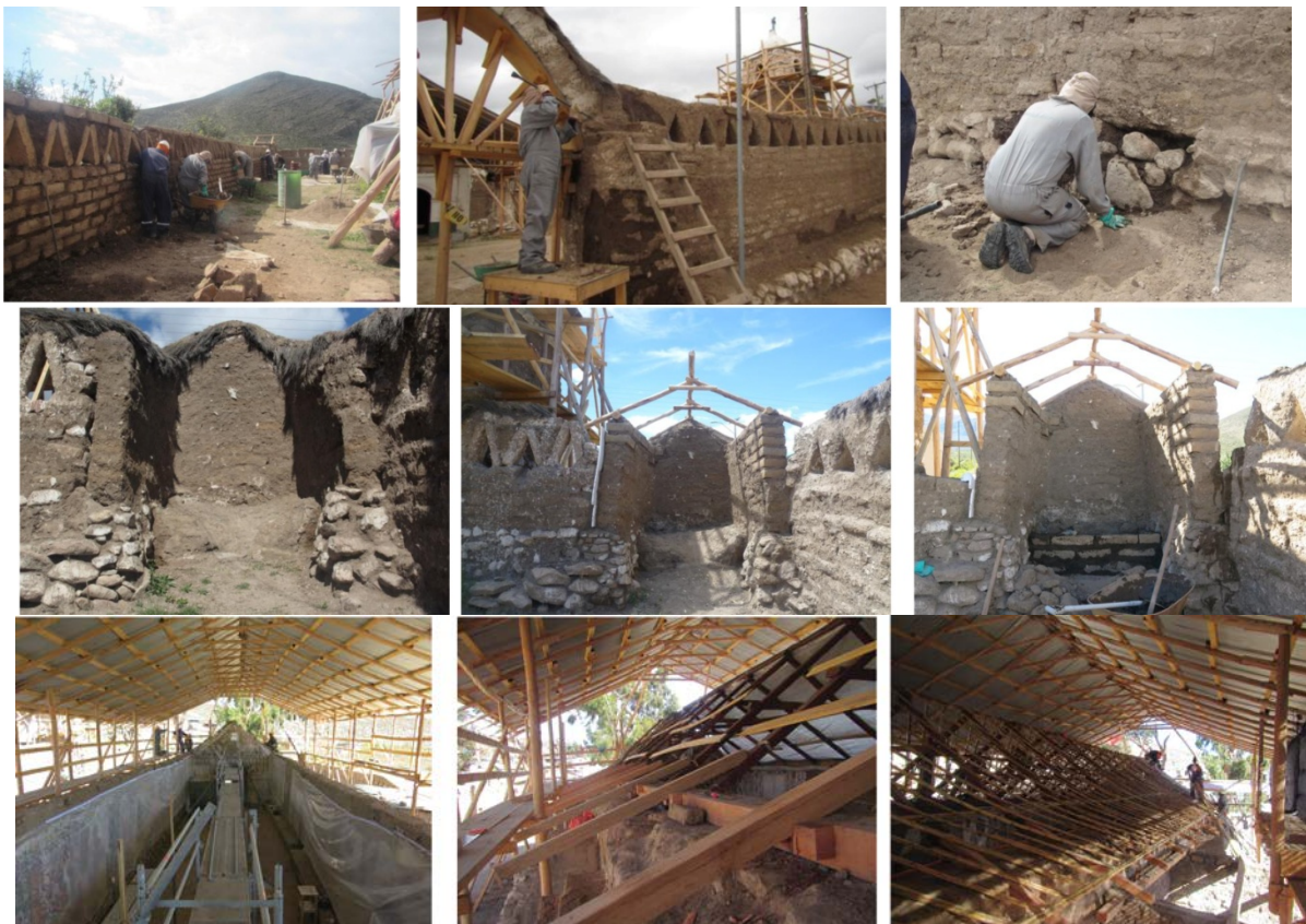
Figura 9. Consolidación barda perimetral del atrio, capillas posas y restitución de la cubierta, 2016
