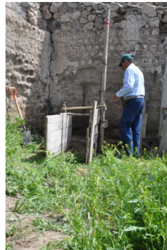
Figura 4. Encofrado empleado tradicionalmente en San Andrés Payuca, Puebla. Tapia de tierra
