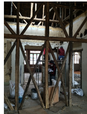
Figura 7. Casa Carvalho, conservación total. Restitución de las paredes de bahareque
