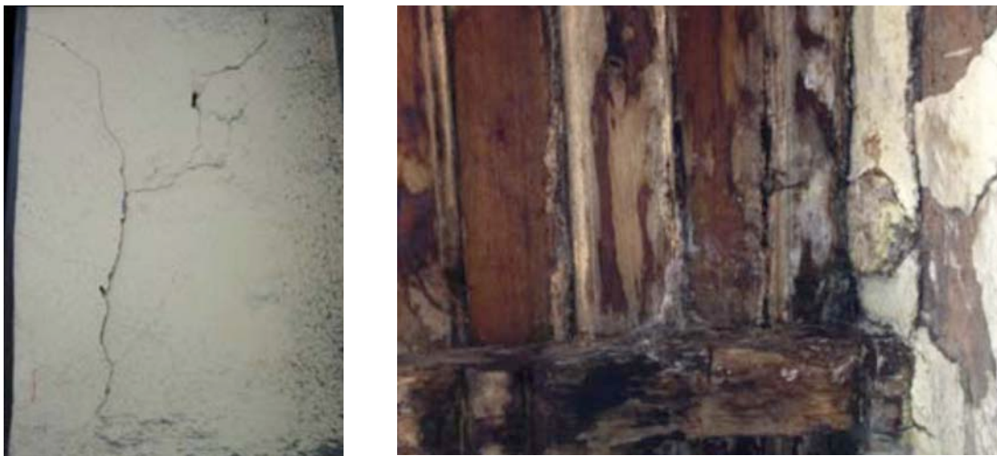
Figura 3: Fotografías de daños: fisuras en un muro frontal (izquierda) y alero y canecillo de madera con pudrición (derecha)
