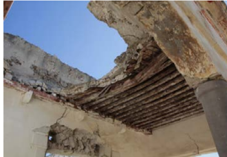
Figura 3. Techo de vigería y entortado de cal y piedra pómez en la Hacienda Pizarro, Puebla
