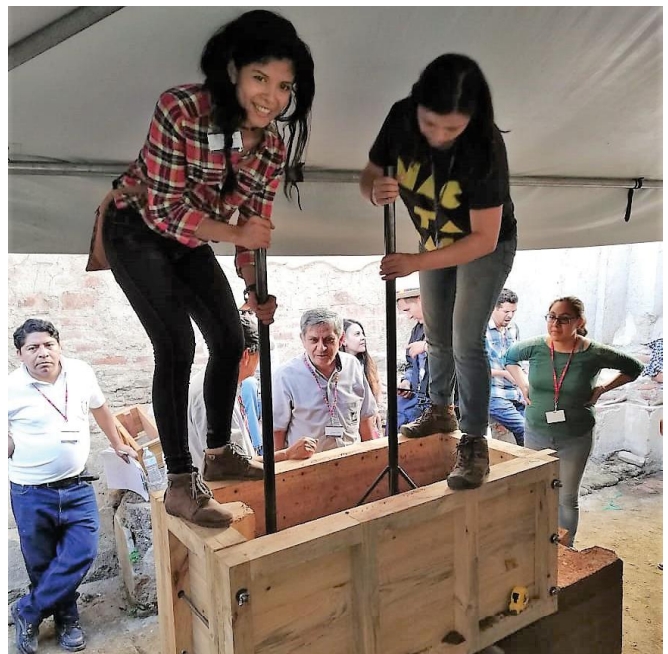
Fig 2. Participantes en los talleres del 18° SIACOT, elaborando un segmento de muro con la técnica de construcción con tierra TAPIAL. Interior de las ruinas del Templo Nuestra Señora del Carmen. Autor: Moisés Méndez, 2018
