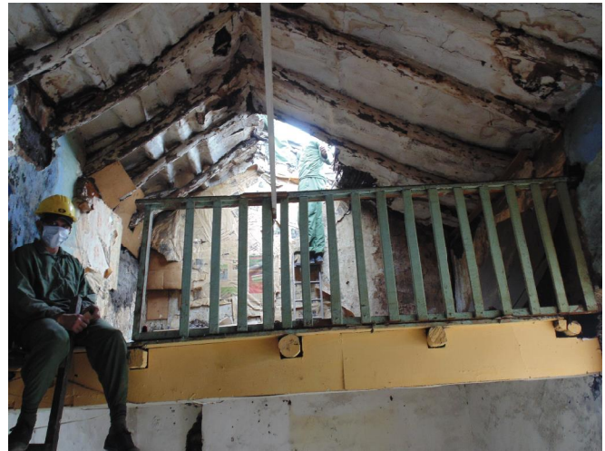
Fig 1: Edificación Naula durante la intervención
