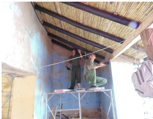
Fig 3: Reparación de muros de adobe - incorporación de cielo raso de carrizo
