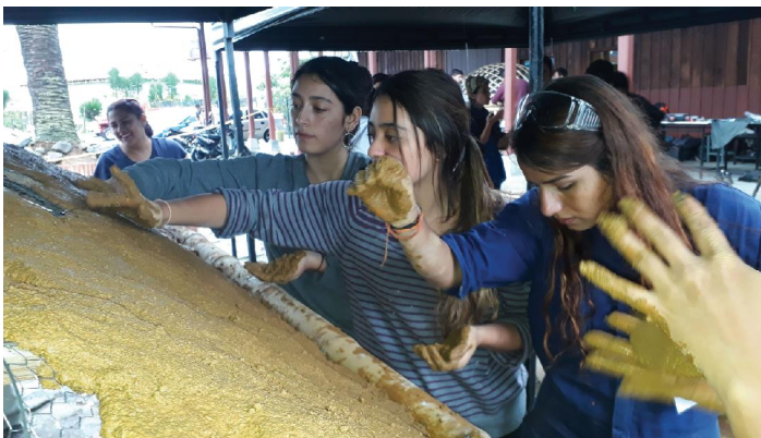
Fig 1. Estudiantes de arquitectura de la U Nal. de Manizales aplicando la tierra en las cubiertas de las bóvedas y cúpulas. Autor: Lucía E Garzón
