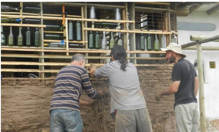
Fig 3: Panel de fajina es una técnica mixta
