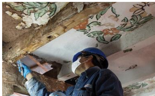
Fig 2: Personal de la DDC-C trabajando en la limpieza del cielo raso del sotocoro en Kuñotambo. Fotos: Alejandra Velez, para el J. Paul Getty
