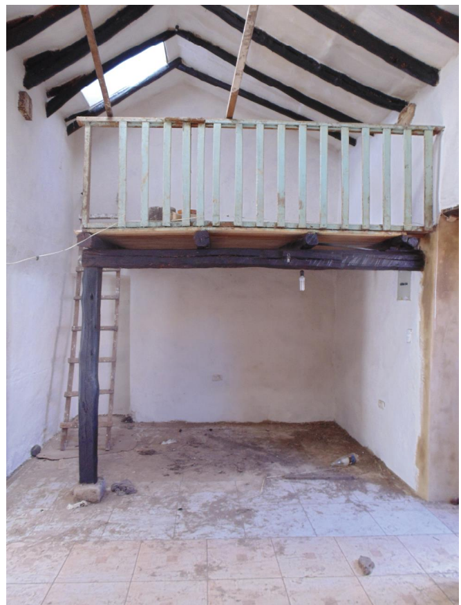
Fig 2: Edificación Naula posterior a la intervención
