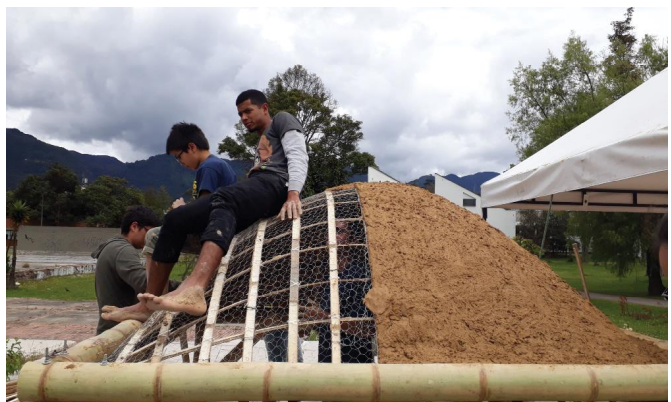
Fig 2. Estudiantes de arquitectura de la UAM de Ciudad de México participando en noviembre en las cubiertas de bóvedas y cúpulas. Autor: Lucía E Garzón.
