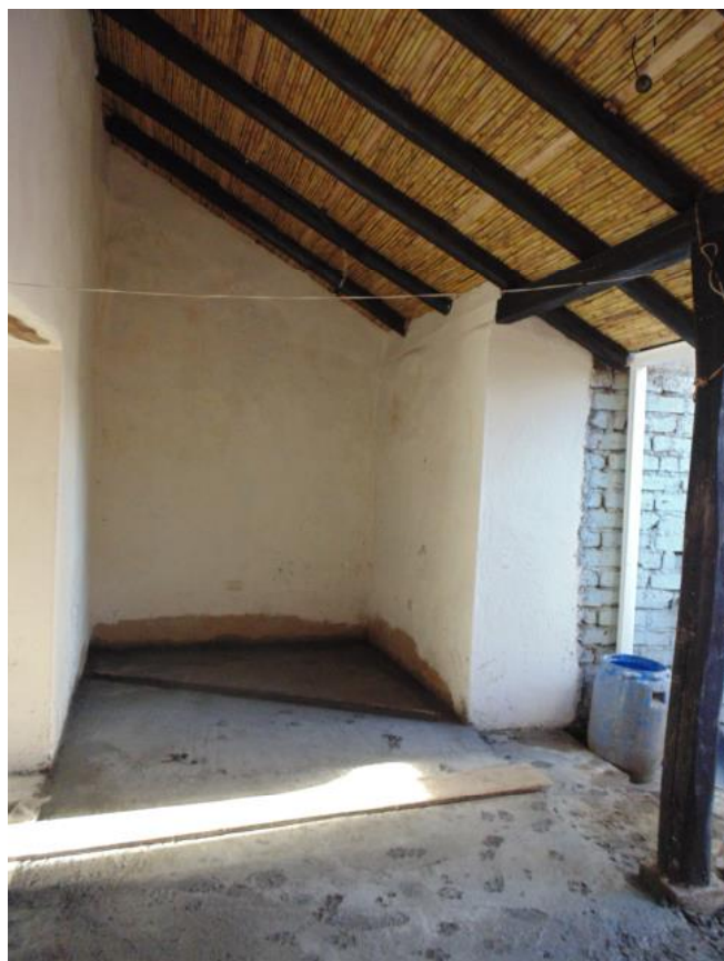
Fig 4: Obra concluida, reparación de sistemas tradicionales
