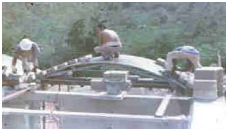
Figura 4: Construcción de techo abovedado con bloques de suelo cemento prensado
