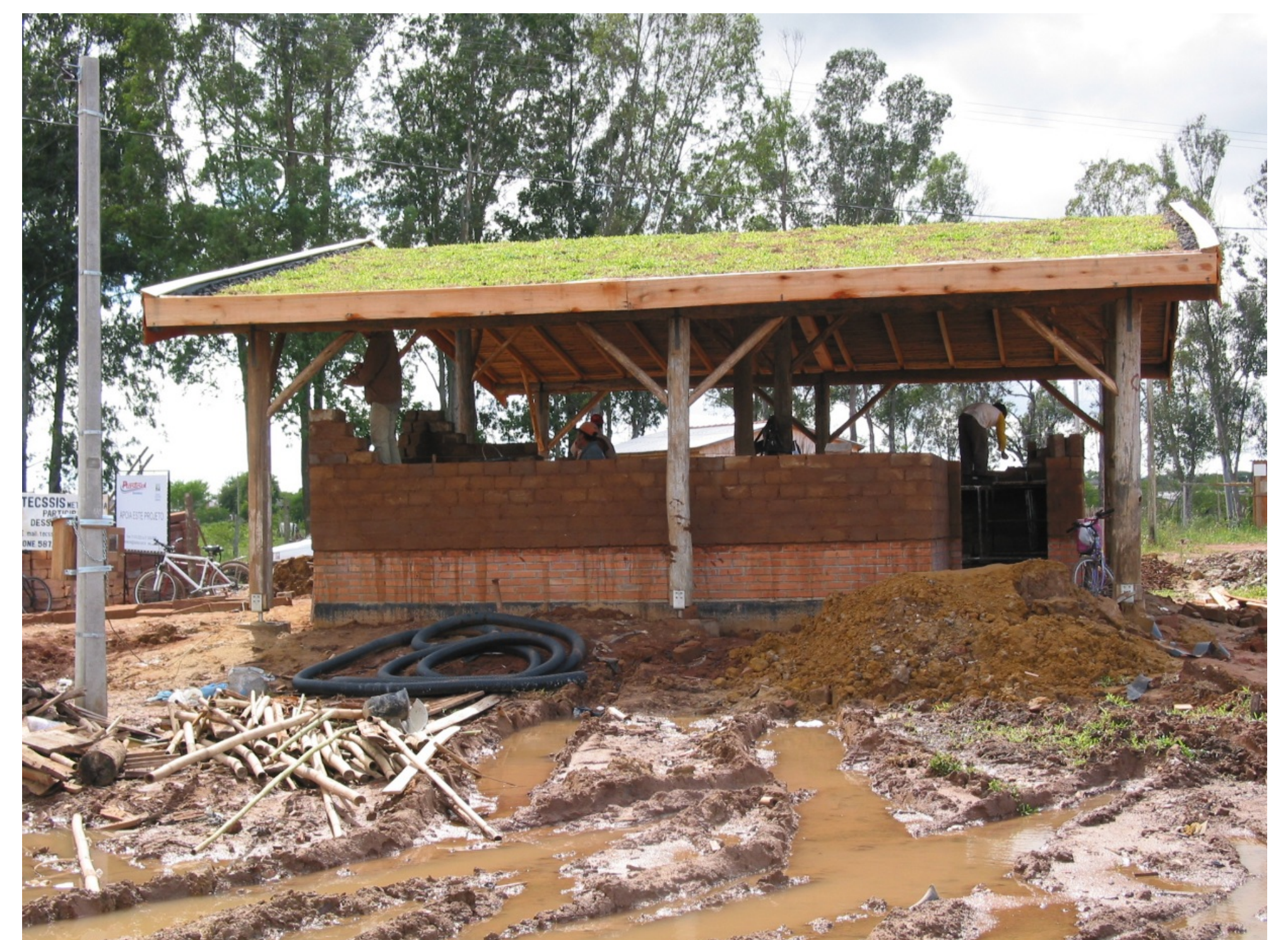
Primeiros 50 cm das paredes são de tijolos queimados
