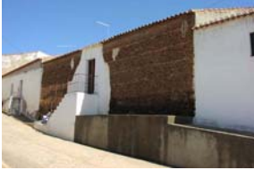
Fig. 1 – Superfícies de paredes de taipa em Sobral da Adiça (foto de Plano B)
