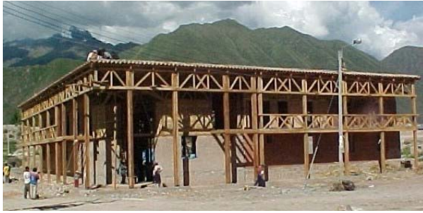
Fig. 1: Centro virtual de salud de Qotowincho construido con las tecnologías mejoradas de adobe, quincha prefabricada y madera, por la modalidad de "aprender construyendo"
