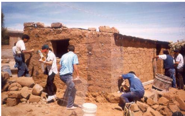
Fig. 9 - Colocação de malhas electrossoldadas em tiras verticais nas esquinas e tiras horizontais na zona superior da parede. In Técnicas para el Reforzamiento Sísmico de Viviendas de Adobe
