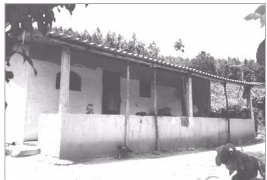
vista de fundos
