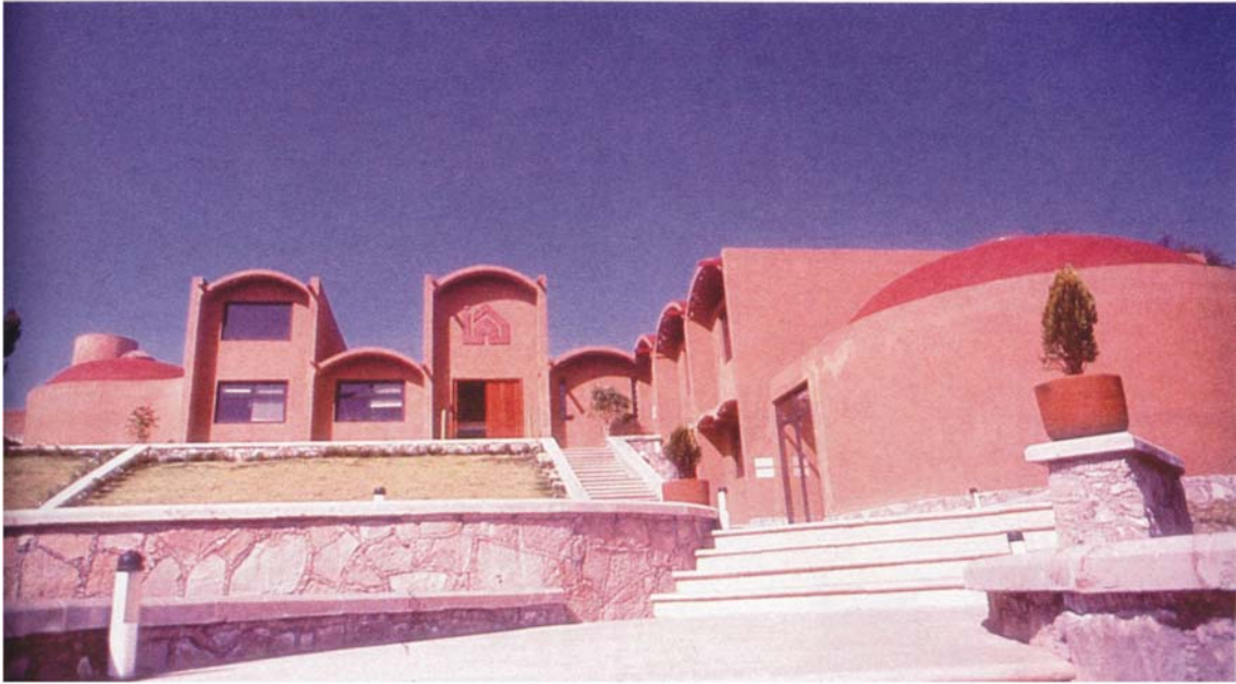
Figura 1. Vivienda en Zacatecas, realizada por Instituto Zacatecano de la vivienda.
