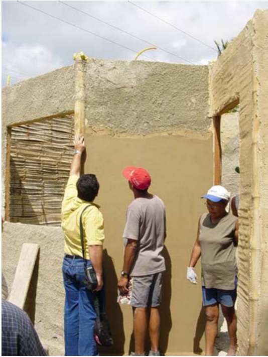
Fig. 3-Painel com 2ª camada
