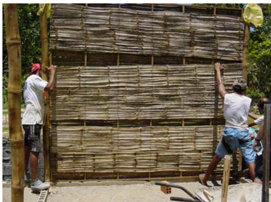
Fig. 1-Assentamento dos painéis de bambu na estrutura.
