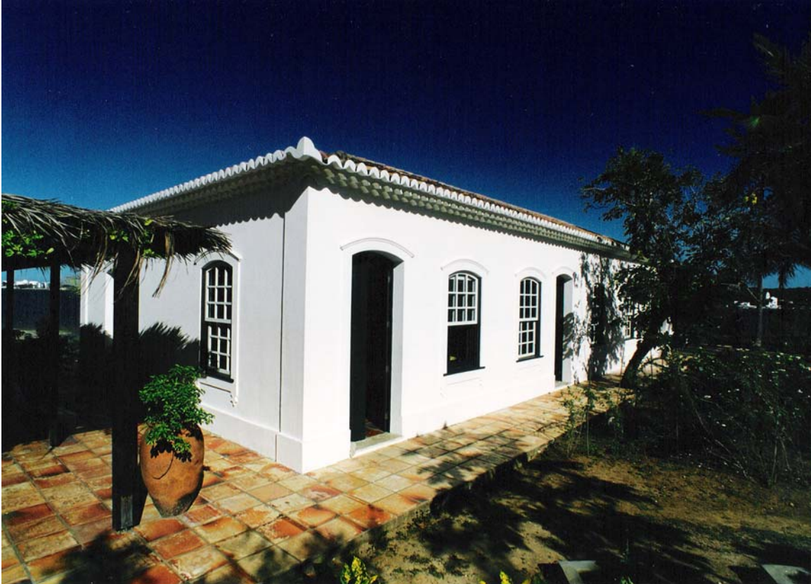
Fig.1 – Casa de propriedade da família Mariani, na Ilha das Vacas, Baía de Todos os Santos. Durante a restauração foi observado que as paredes divisórias eram de adobe estabilizado com cal.
