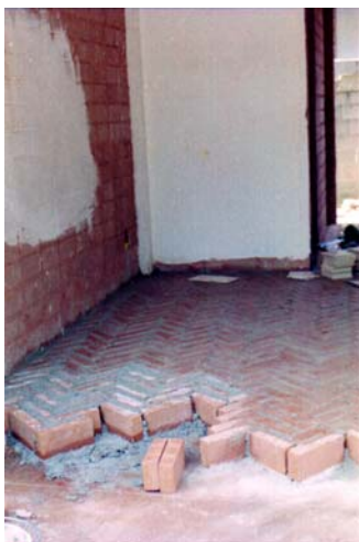
Figura 3 - Assentamento do Piso – Ilha Bela / São Paulo
