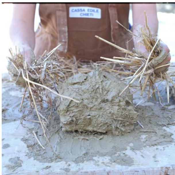
Fig. 2 – Cantiere di casa D’Arcangelo. Confezionamento del massone . Foto Mauro Bertagnin.
