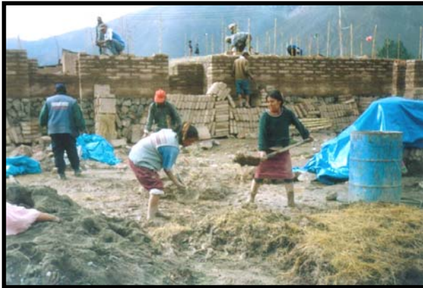
Fig. 2: Preparación del mortero (barro con paja) y construcción de los muros reforzados con caña, con participación de la comunidad
