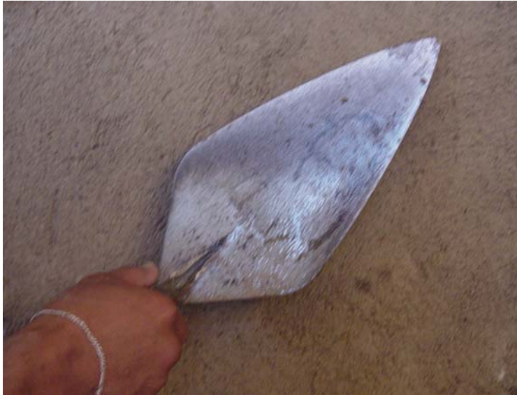
Foto No. 4 Textura del piso con la aplicación de una capa de pastina como acabado final.
