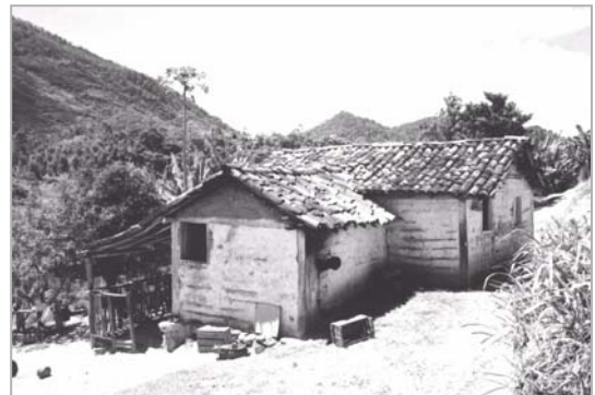
vista de fundos (acesso à cozinha)
