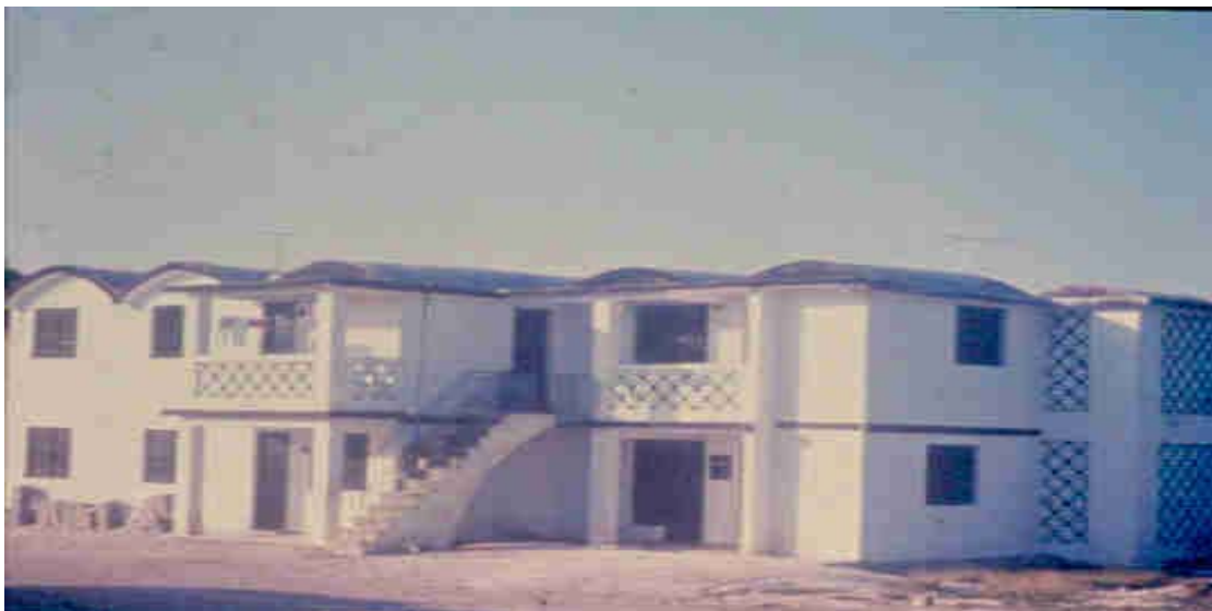
Figura 5: Conjunto de viviendas de Bajo Costo, en dos pisos de altura, de paredes y techos con elementos prensados de suelo cemento.
