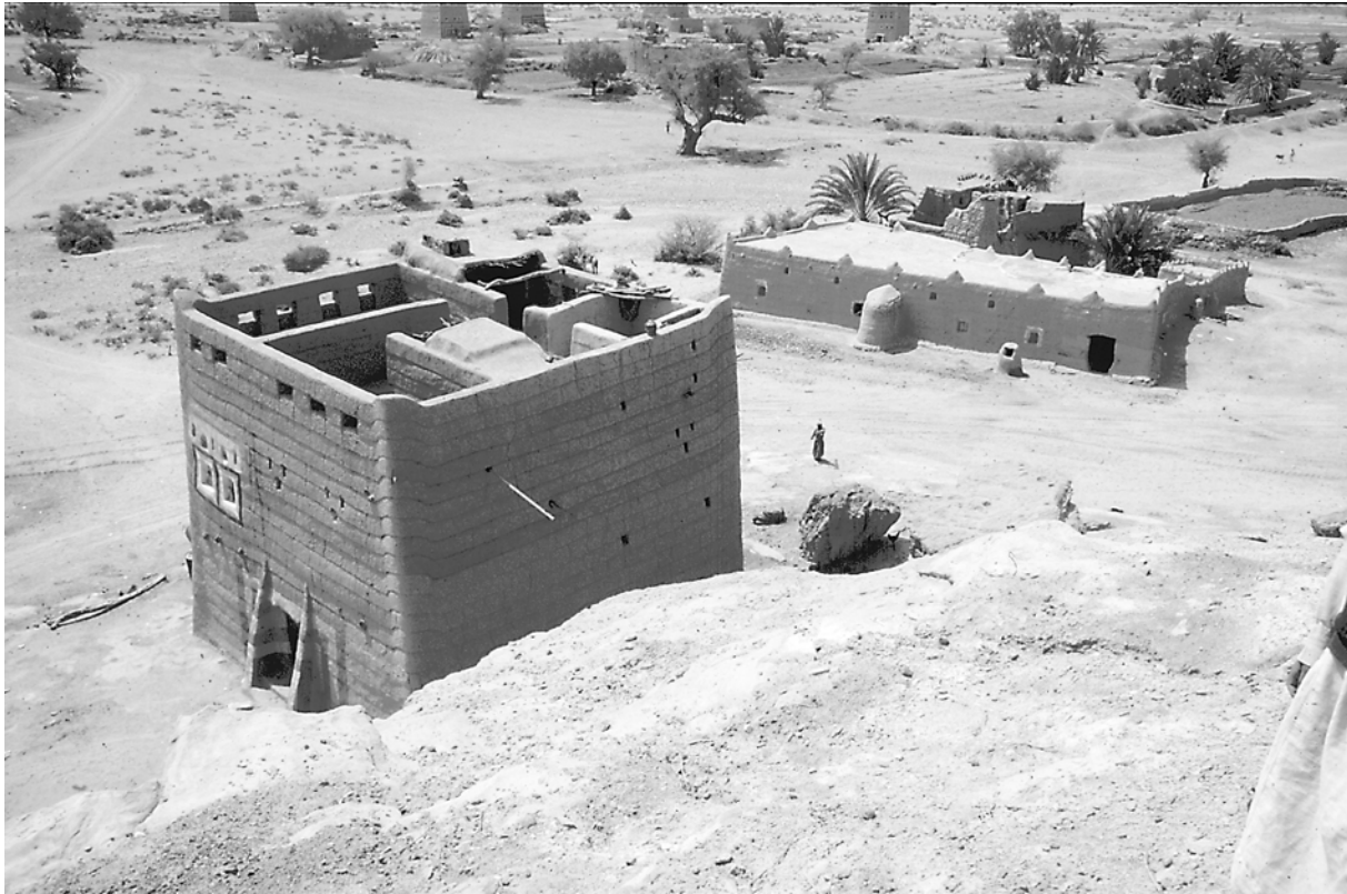
Fig. 3 – Casa rural em Khirab, Barat
