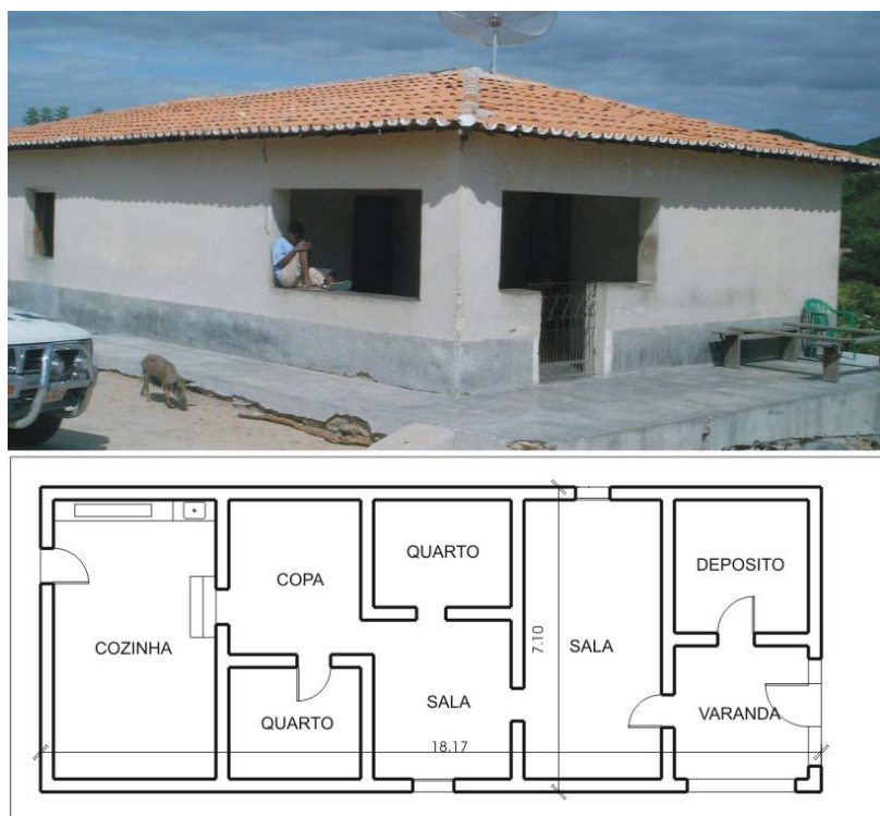
Figura 2. Vista e croqui da planta baixa de habitação de adobe, de melhor padrão, localizada na Comunidade Sítio Velho, Piauí, Brasil. Fotografia e desenho de Sandra de Alexandria (2005).
