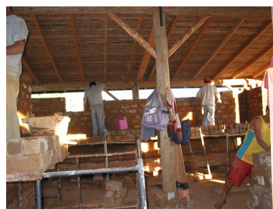
Construção das paredes
