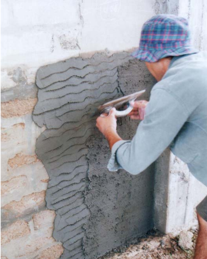
Fig. 2 – Prototipo de revoque de suelo-cemento sobre muro de BTC.
