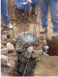
Fig. N° 1 Vaciado realizado en forma no continua
