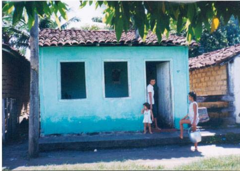
Fig. 3 Casario Construção de adobe em Vale Verde – Município de Porto Seguro / Bahia (Fotografia da autora – 1985)
