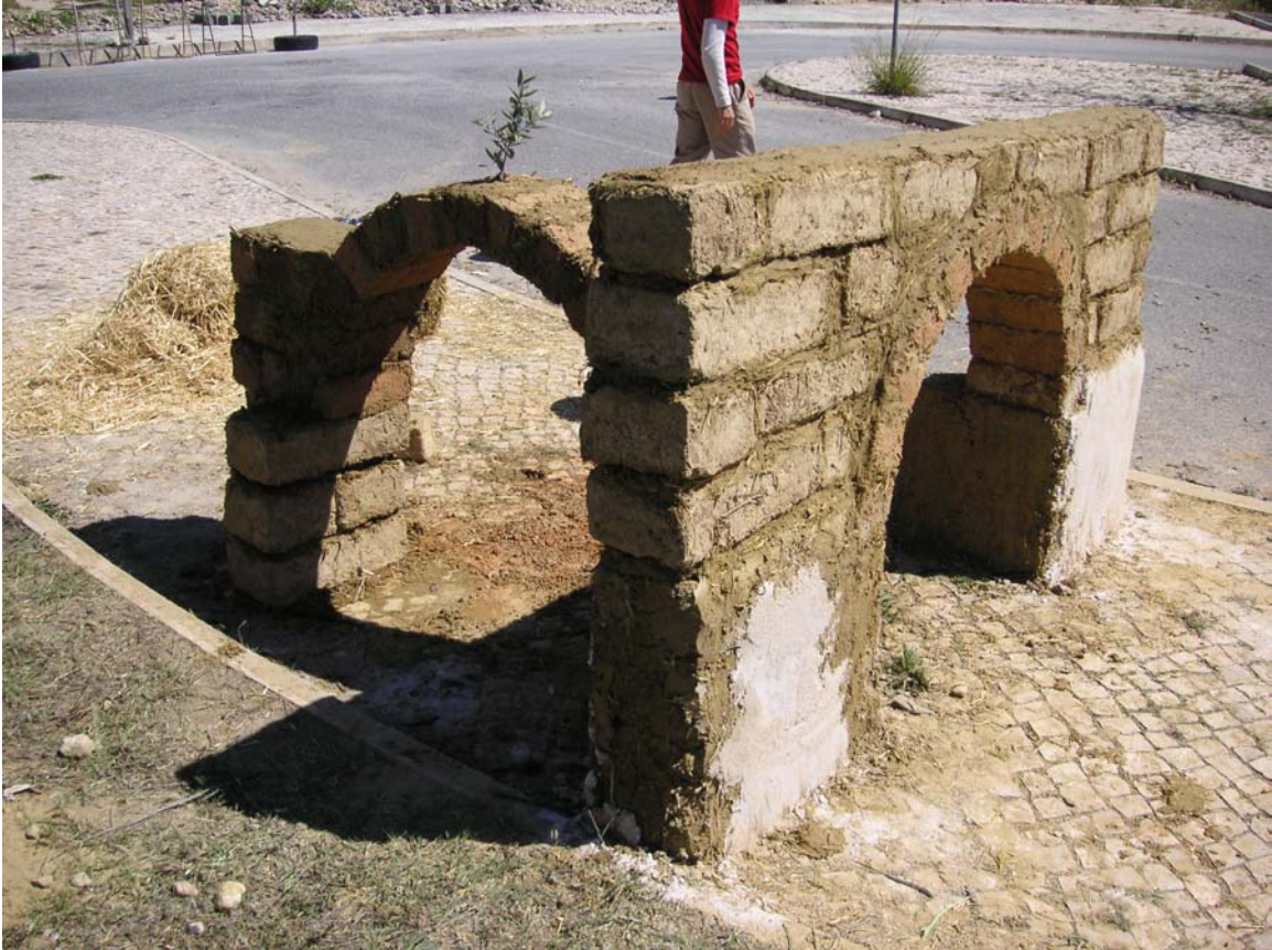
Fig. 3 – Aplicações de sistemas de revestimento em suporte recente de adobe (Workshop “Construção com Terra Crua”)
