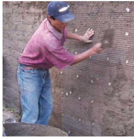
Fig. 8 - Colocação da malha electrossoldada na parte exterior da edificação. In Elementos Técnicos y estrategia institucional para la disminución del riesgo y de la dimensión de futuros desastres - Proyecto de reconstrucción con inclusión de la gestión de riesgo. Perú
