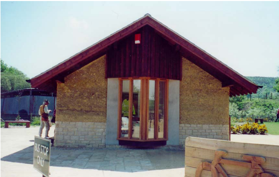
Fig. 2 – Edifício recente com superfície de taipa à vista
