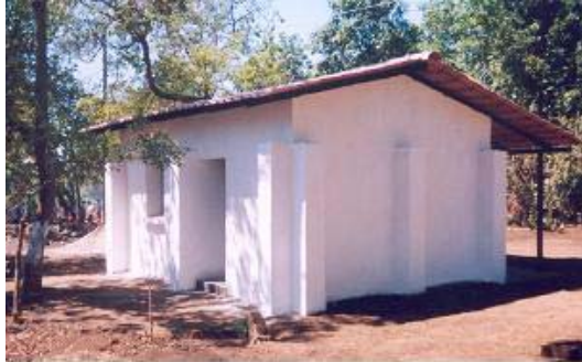
Figura 1: Modelo de Adobe Sismo resistente
