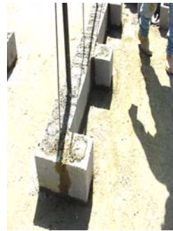
Fig. N° 2 Construcción de losa de piso sobre fundación
