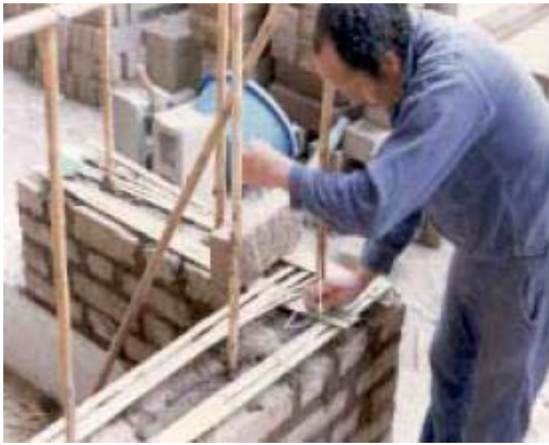
Fig. 7 - Colocação do reforço vertical e horizontal na edificação com canas de bambu, Peru. In Construcciones de Adobe Resistentes a los Terremotos
