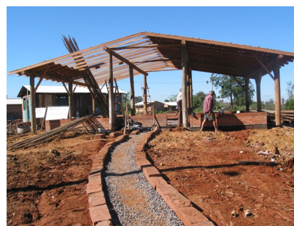
Construção do telhado
