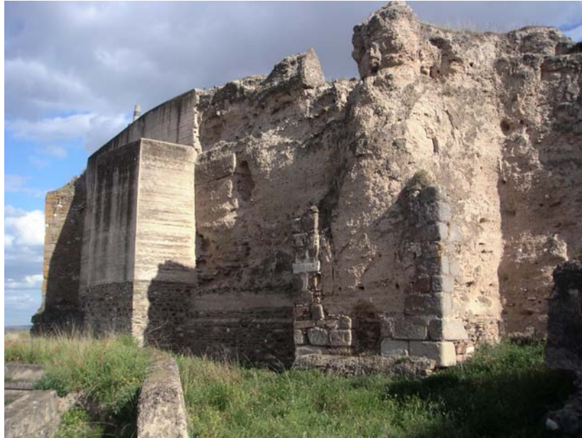
Fig. 1 – Torre de taipa com silhares romanos, no troço Norte da muralha islâmica de Juromenha.
