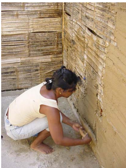
Fig. 2 - Revestimento com argamassa primeira camada.
