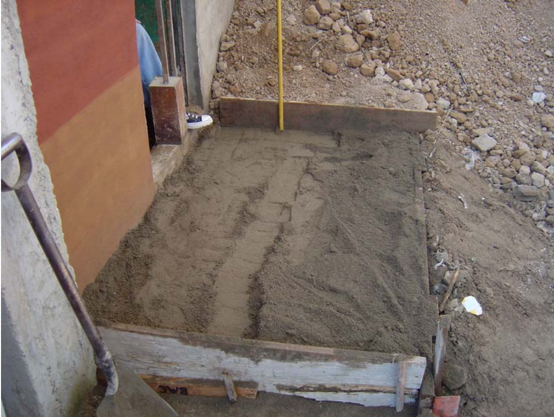
Fig.4 – Prototipo de contrapiso de suelo cemento compactado en dos capas.
