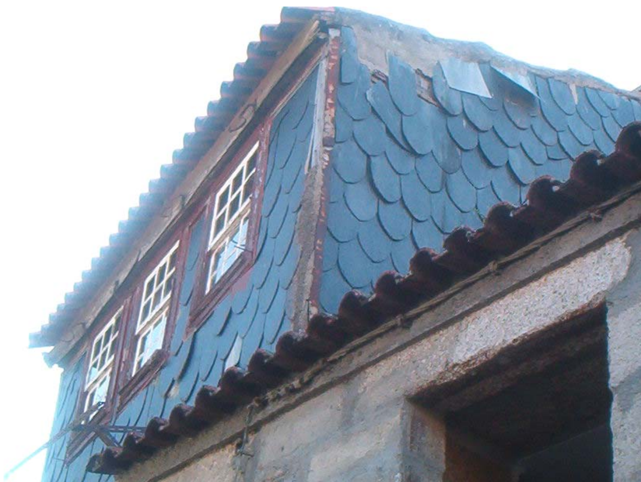
Fig.2 – Tabique (técnica mista) na cidade de Guarda, em Portugal Foto do autor Geraldo Bezerra Araújo (maio de 2004)
