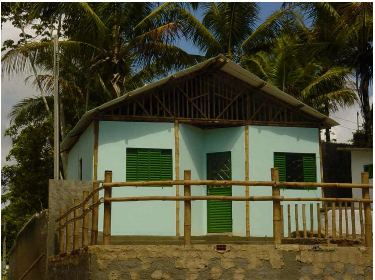
Fig. 4-Casa executada em painéis de bambu.
