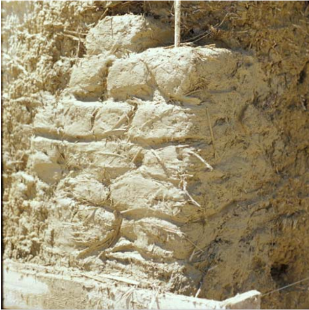
Fig. 3 – Cantiere di casa D'Arcangelo. Fase di consolidamento e ripristino murario dell'angolo. Foto Mauro Bertagnin.
