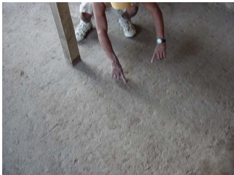
Foto No. 3 Textura del piso sin acabado final
