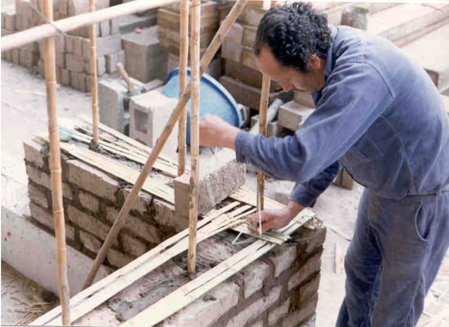
Fig. 2 – Refuerzo interior de caña
