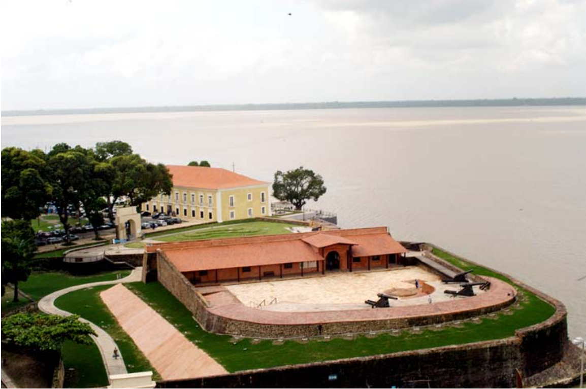
Fig.2 – Fortaleza do Santo Cristo ou do Castelo, na Cidade de Belém, Pará. Encontrou-se nela, durante o restauro, paredes de taipa de pilão estabilizadas com cal (século XVII ou XVIII). O Edifício ao fundo era o Hospital Militar projetado pelo famoso Capitão Antônio Landi, no Século XVIII. É construído de tipa de pilão e de sopapo. Foto: SECULT-PA.
