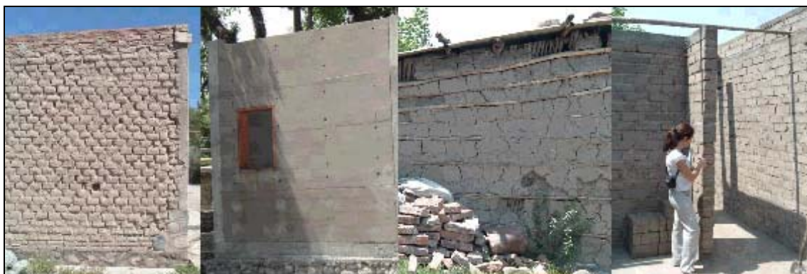
Fig.2- Muros con tecnologías de tierra: adobe en Amaicha del Valle, tapial en Famaillá, quincha y BTC en Monteros.
