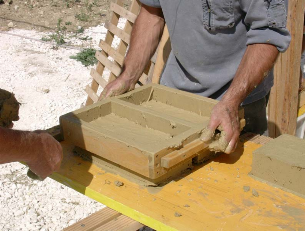
Fig. 5 – Cantiere di Borgocapo. Produzione dell'adobe: scasseratura. Foto Gaia Bollini.
