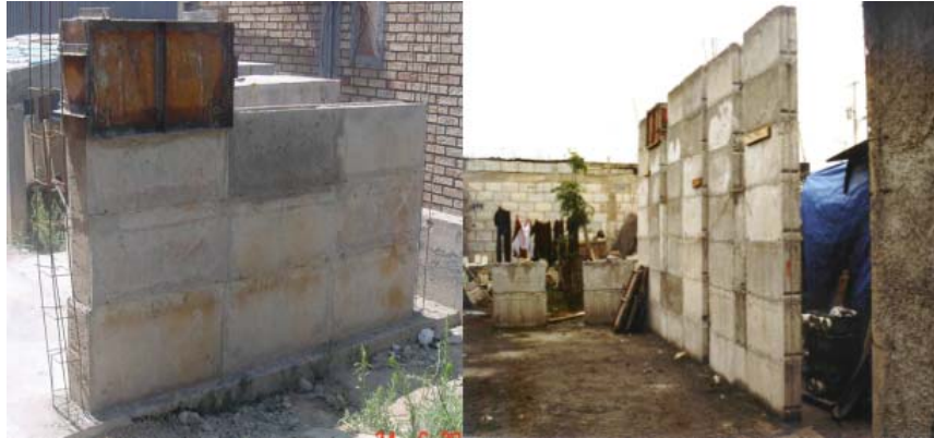
Figura 4 Muro tierra-concreto construido a escala piloto (izquierdo) y en una colonia de la periferia de la región sureste de Coahuila (derecho).
