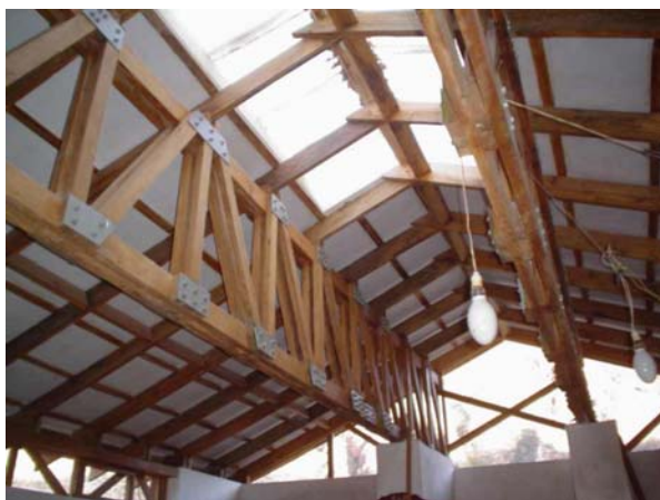
Fig : Estructura de madera del techo del taller
