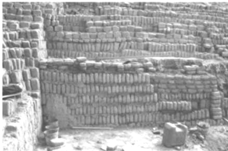
FIGURA 4 Procedimiento final y acabado con la técnica de restauración por celdas
