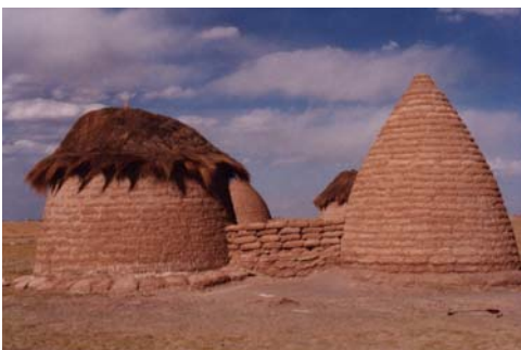
Figura 4. Construcción de viviendas de la cultura Uru Chipaya, en la zona sur de la región andina
