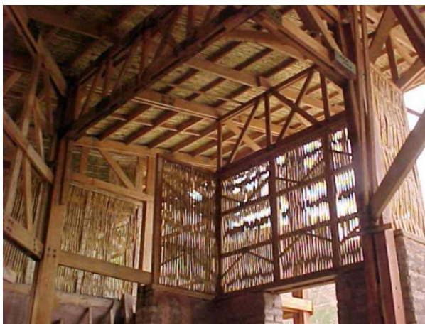
Fig. 3 : Estructura del hall principal de madera con paneles de quincha prefabricada
