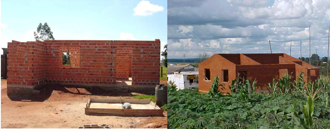
Fig.1 – Vista das habitações: sistema de vedação em tijolo cerâmico alveolar (Hab. 1) e sistema de vedação em adobe (Hab. 2). Fotos: Habis/EESC/USP.
