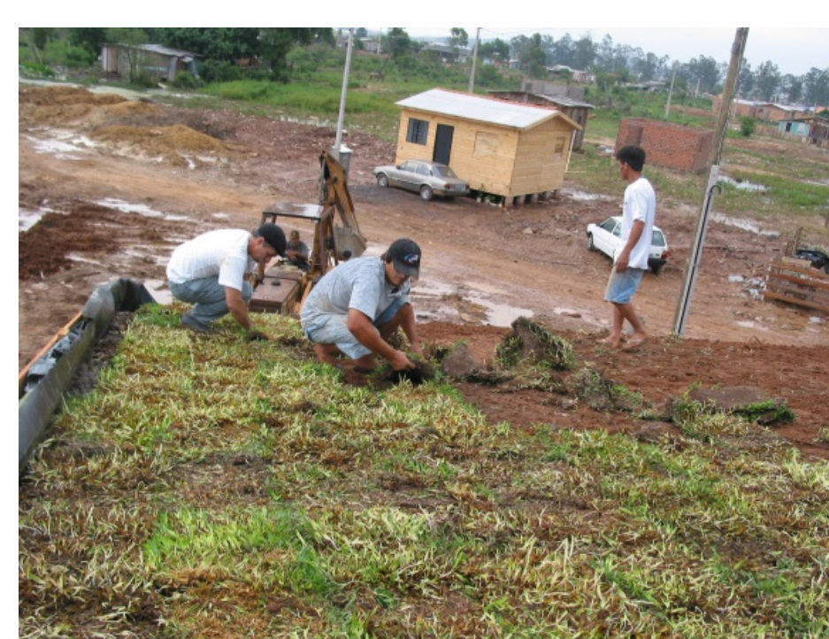
Colocação das leivas
