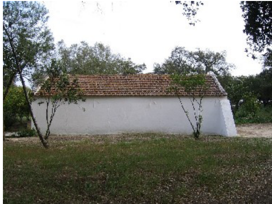
Fig. 13 - Utilização de contrafortes numa habitação na Atalaia
