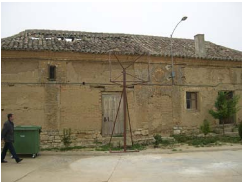
Fig.2 – Estado actual del edificio, fachada principal. Como consecuencia de la división del edificio en dos mitades se ha cegado la entrada original, situada en el centro del alzado, y se han abierto huecos nuevos; a la derecha para el uso de vivienda, a la izquierda para almacén. El Proyecto recuperará su estado original. (Fotografía de los autores)
