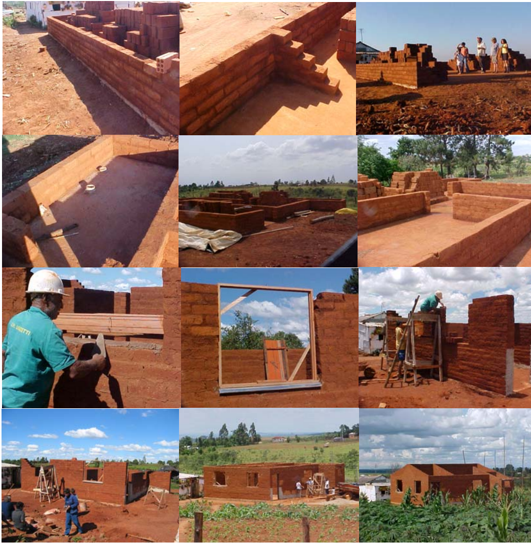
Figura 4: Fotos da seqüência de elevação da parede em adobe
