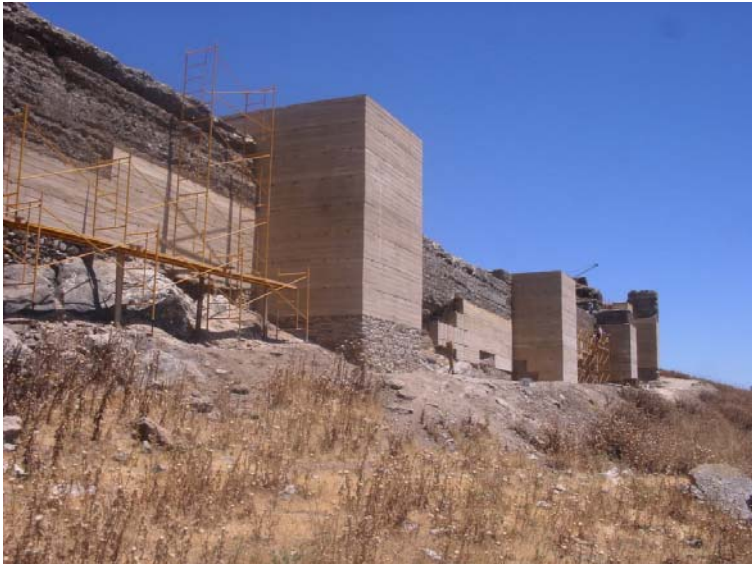
Figura 4 - Restituição volumétrica da taipa.
