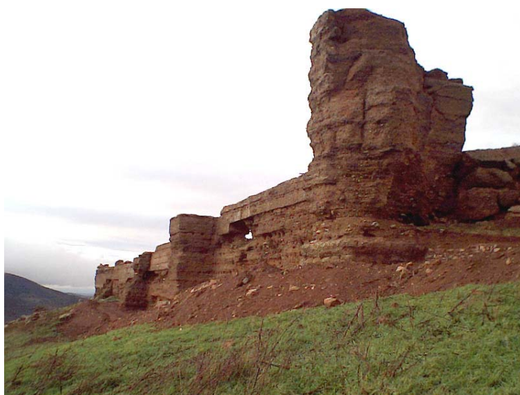
Figura 2 - Aspecto da muralha, no início das obras.
