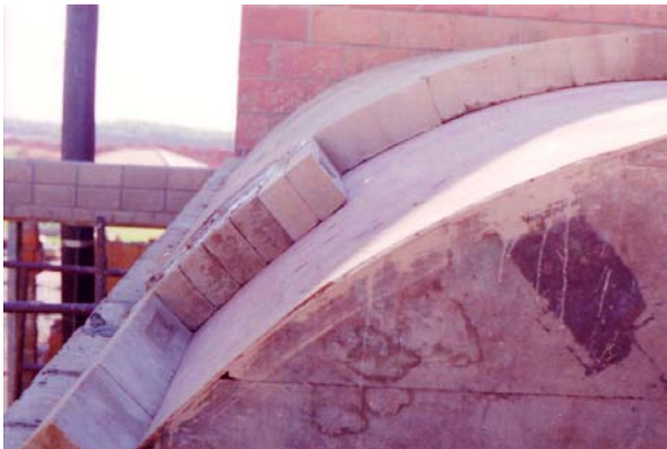
Figura 2 - Assentamento dos Tijolos de Cobertura – Guapiaçu / São Paulo
