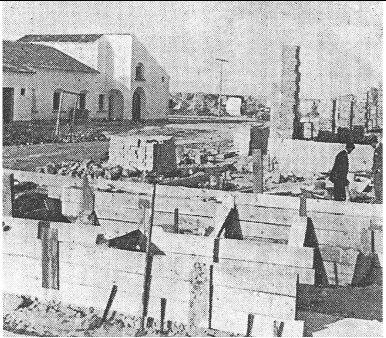
Fig. 2 Tapias en Villanueva de la Cañada (Cámara, 1941)
