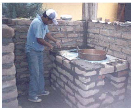
Figura 4: Unidades Alternativas para la Cocción y Horneado en Construcción en Tucumán, Argentina . Diseño y Fotografía de los autores.
