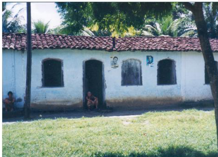
Fig. 2 Praça São João Paulista – Casario Trancoso – Município de Porto Seguro / Bahia (Fotografia da autora – 1985)
