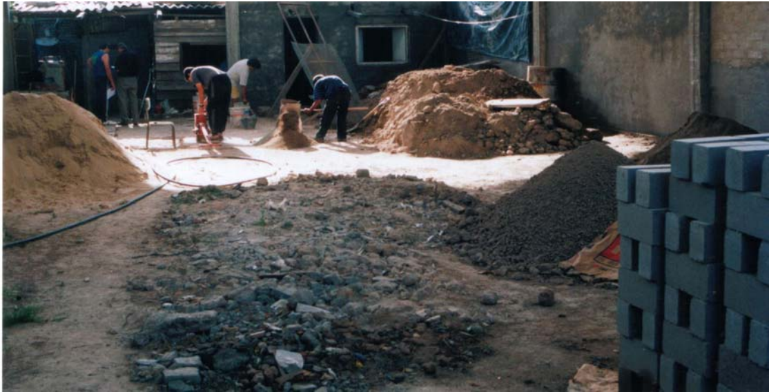
Fig. 1 – Montaje del emprendimiento y fabricación de los bloques.
