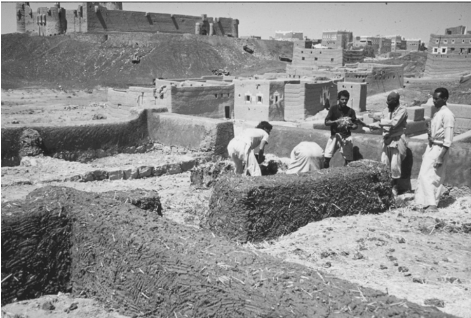
Fig.4 – Operários afeitando o primeiro estrato de parede em zabur em Sa'da, Yemen. Notem-se as intersecções e arranques de futuras paredes
