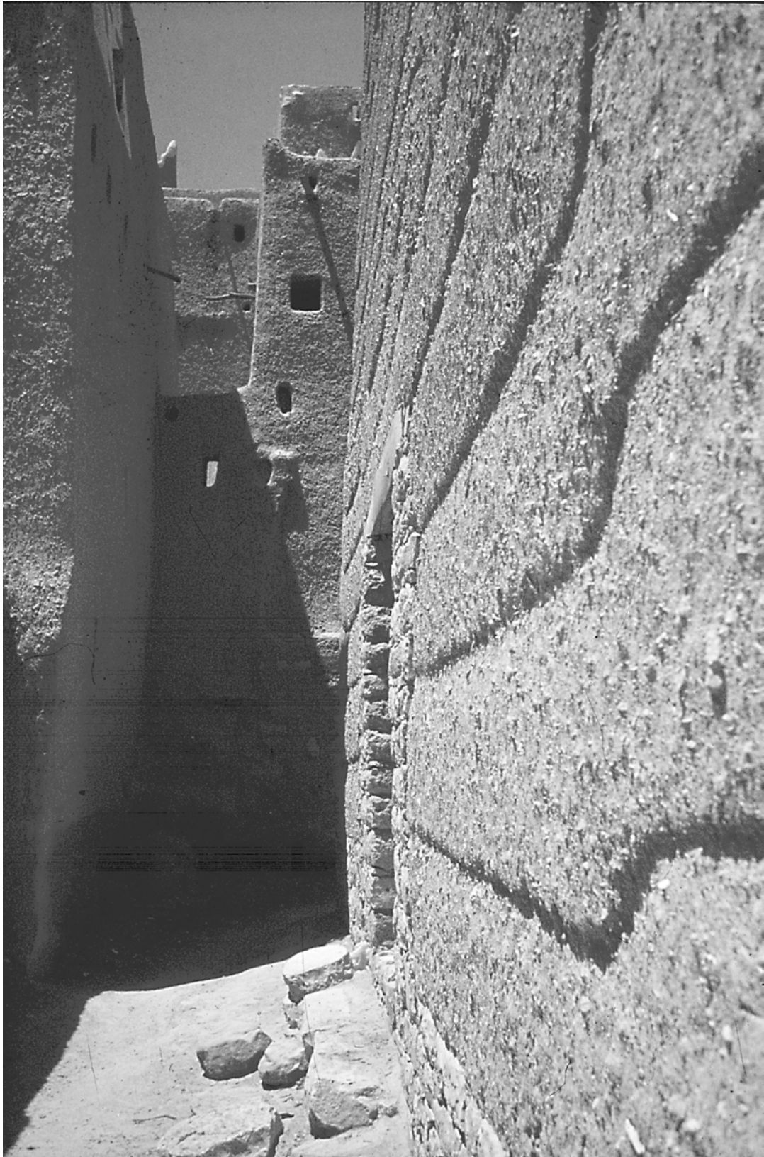
Fig.2 – Parede em Zabur, Sa'da. Note-se o avanço de cada estrato sobre o de baixo e os cantos levantados
