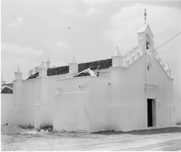
Fig. 1 – Fachada e lado Norte da Igreja
