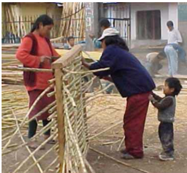
Fig. 3 Fabricación de un panel de quincha (trenzado de tiras de bambú en un bastidor de madera)
