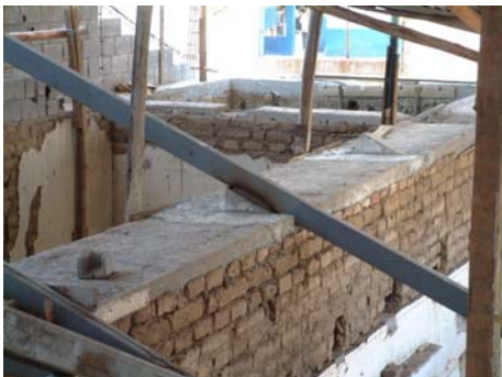
Fotografía 3. Ejemplo típico de cabeza de muro, se puede ver además como se cimienta la cubierta en ella y la forma de nivelación del muro con adobes nuevos.
