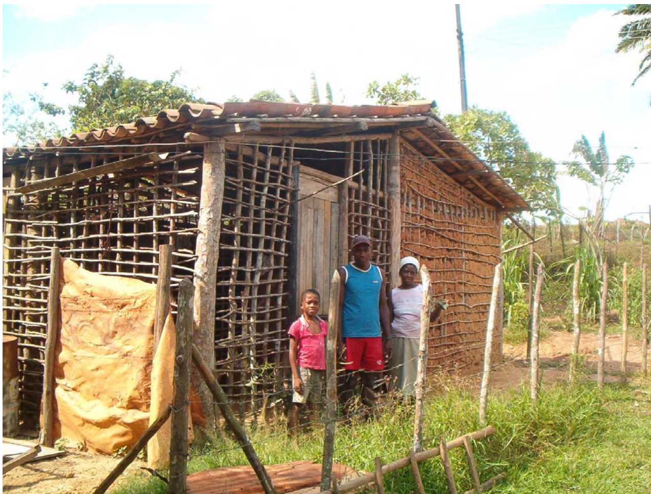
Fig.3 – Taipa de mão (técnica mista) na cidade de São Sebastião do Passe na Bahia, Brasil Foto do autor Geraldo Bezerra Araújo (novembro de 2004)
