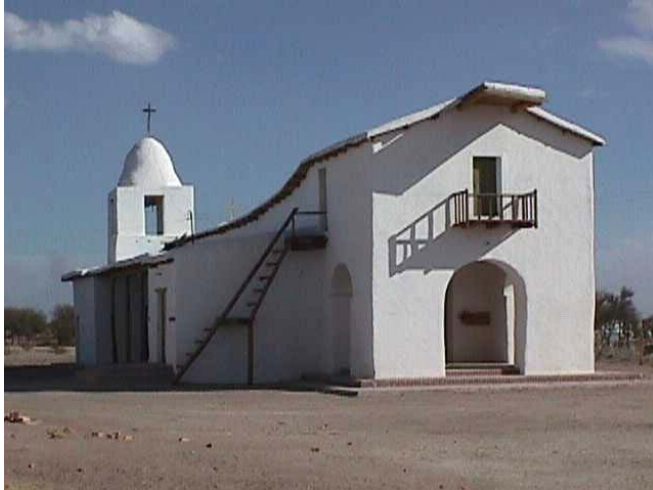
FIG. 1 - CAPILLA DEL ROSARIO DE GUANACACHE Lavalle - Mendoza – Argentina Vista y Planta (Foto y Dibujo de los autores)
