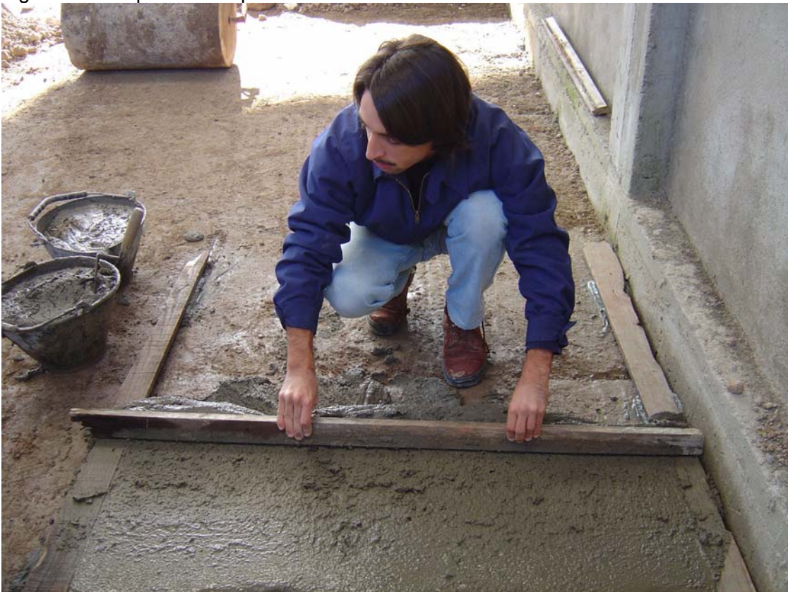
Fig.3 – Prototipo de carpeta alisada de suelo cemento. Ejecución del autor.
