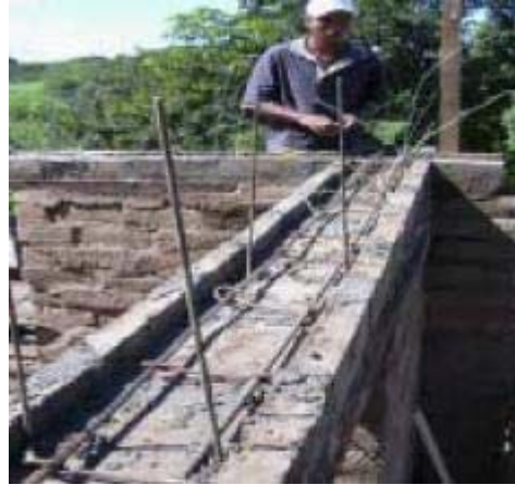
Fig. 12 - Construção de uma viga de bordadura em betão armado, em El Salvador. In Construcciones de Adobe Resistentes a los Terremotos
