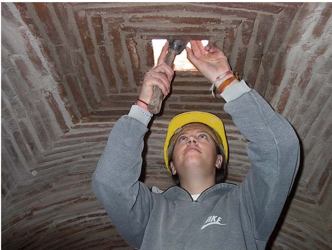
Figura 1 – Aulas práticas: fechamento de uma abóbada por uma aluna
