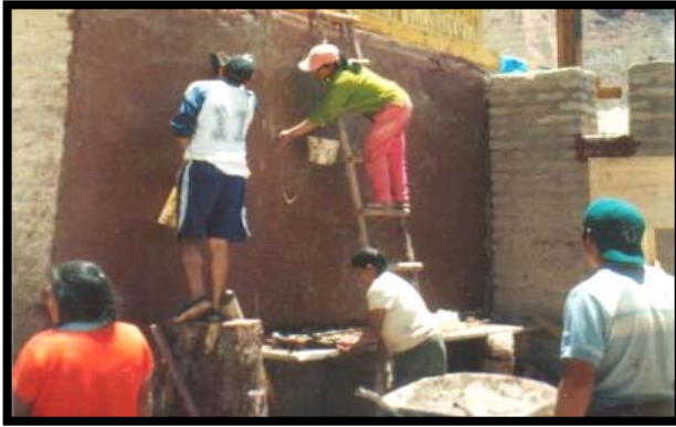
Fig. 4: Revestimiento del muro con barro y gigantón (cactus)
