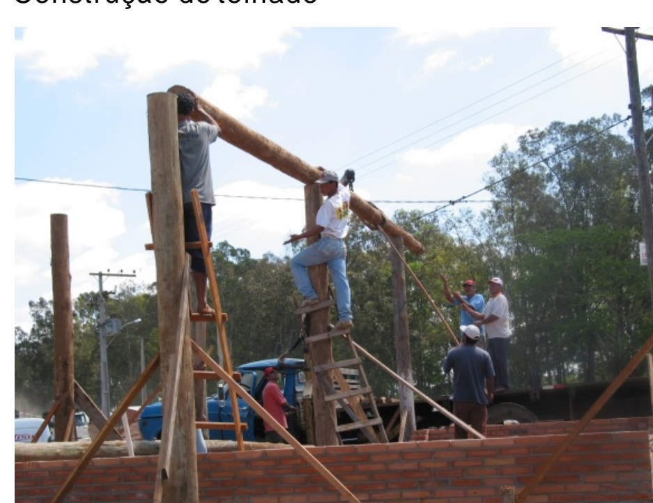
Montagem da estrutura do telhado
