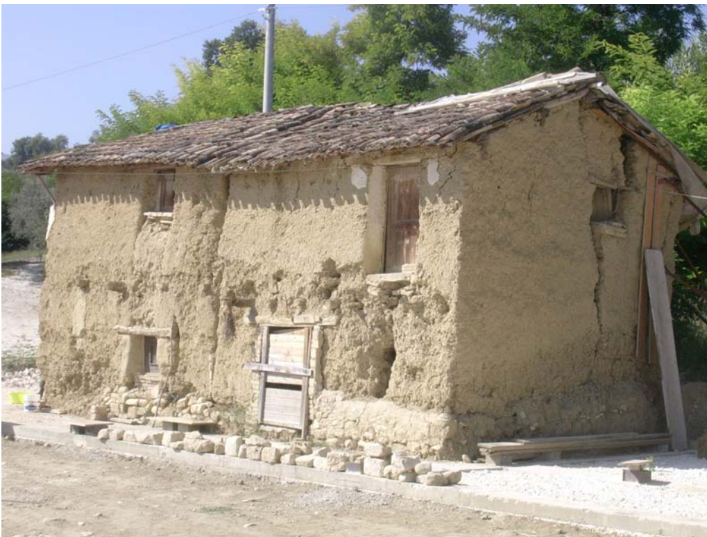
Fig. 4 – Cantiere di Borgocapo. Stato di fatto. Foto Gaia Bollini.
