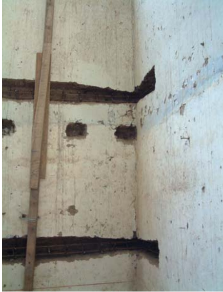
Fotografía 4. Ejemplo de llave de amarre entre muros, la fotografía muestra el momento en que está hecha la incisión en el muro (nótese la forma cónica) con la armadura de acero correspondiente, es decir previo al encofrado y la fundición con hormigón.
