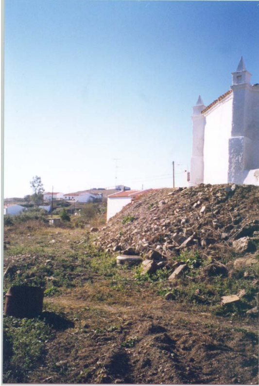
Fig. 2 – Aterro constituído por entulho em torno da parede fundeira
