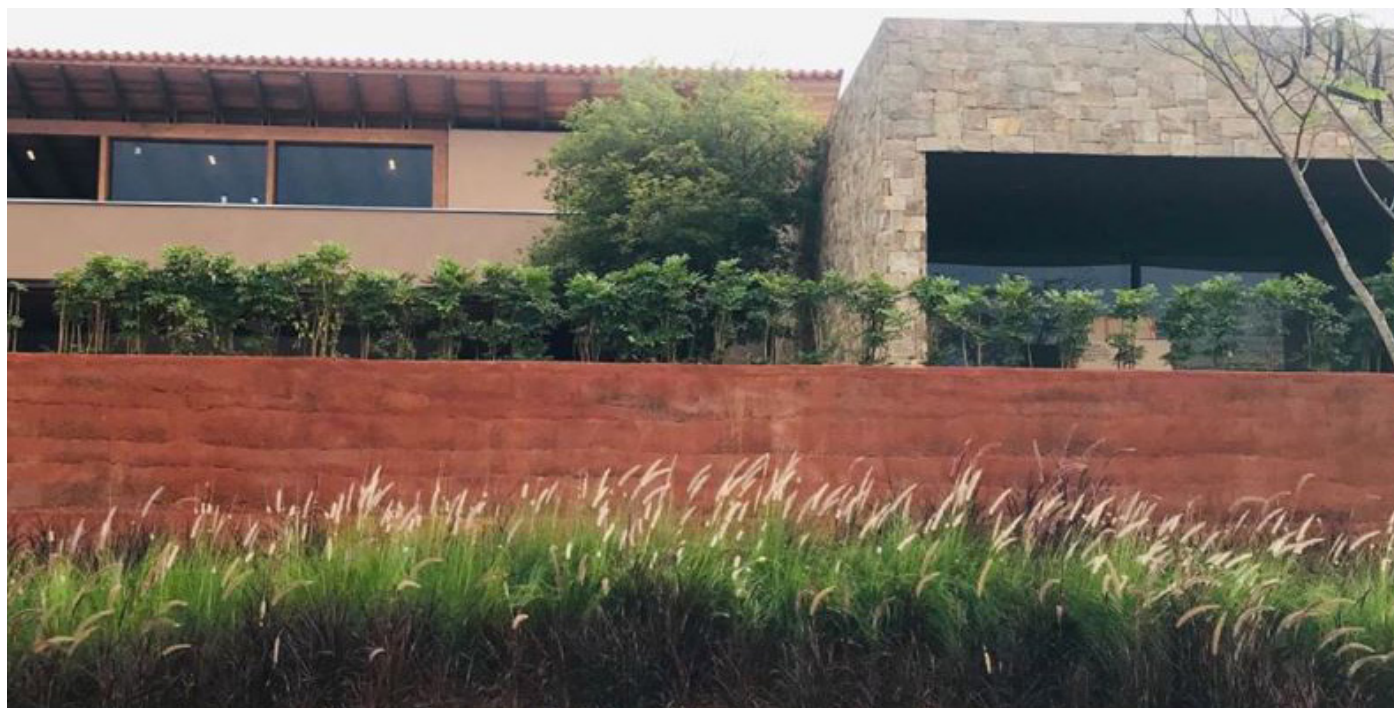
Fig 1. Muro concluído Autor: Eduardo Salmar
