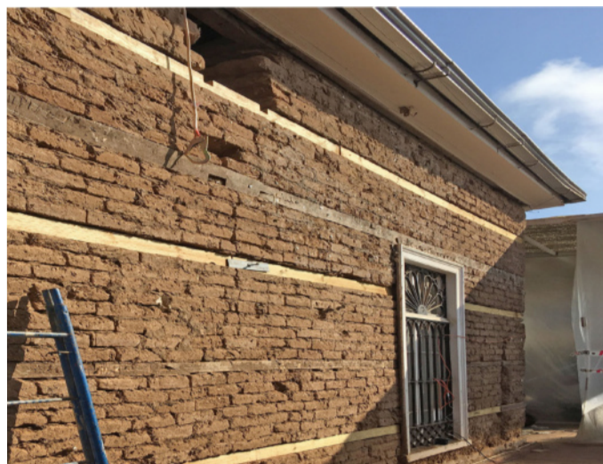
Fig 3. Vista de refuerzos horizontales y preparación de calzadura. Autora: Natalia Jorquera
