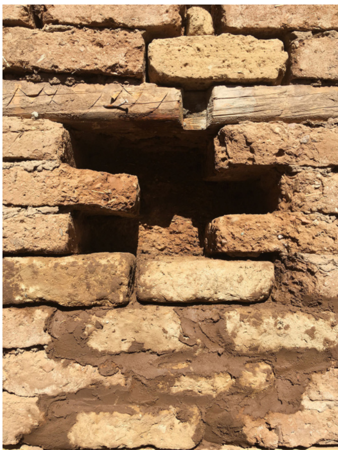
Fig 4. Detalle de calzadura. Autora: Natalia Jorquera
