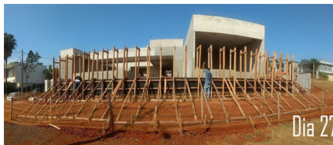
Fig 3. 27º dia de trabalho com a compactação do muro Autor: Eduardo Salmar
