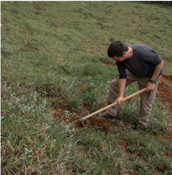
PASO 1. Retirar la capa superficial (horizonte A) con una azada y reservar.
