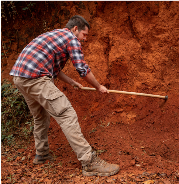
PASO 2. Retirar la capa superficial de aproximadamente 5 cm de espesor y desecharla.
