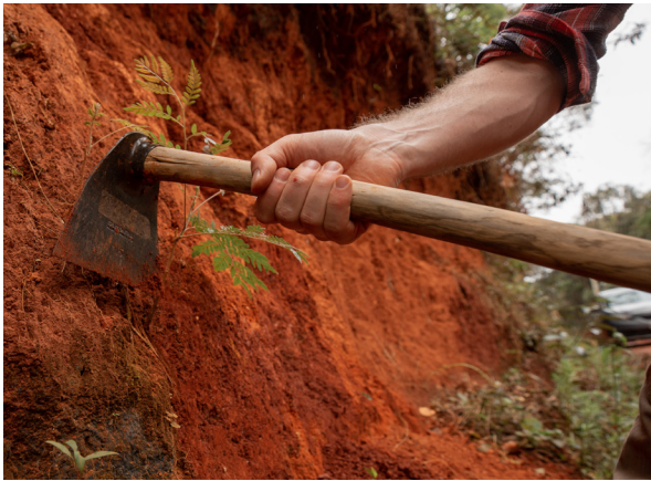
PASO 1. Realizar una limpieza superficial del barranco.
