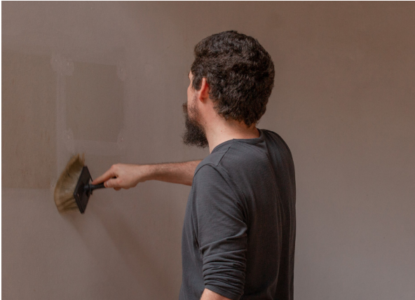
ETAPA 1. Limpar o substrato (parede).
