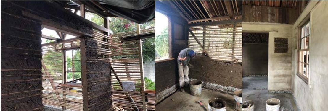
Figura 6. Proceso de estructura horizontal en caña de castilla y relleno de barro con pasto y trozos de teja
