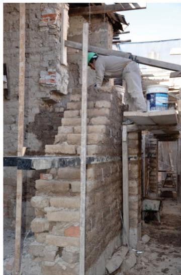
Figura 10. Restitución de muro
