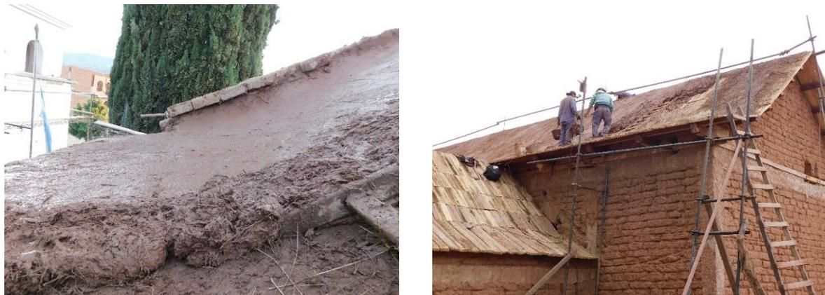
Figuras 11 y 12. Proceso de ejecución de la capa de base
