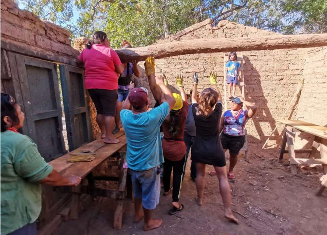
Figura 5. Organización de las mujeres integrantes de las familias, la Colectiva y voluntarias para la liberación del tirante inferior de la estructura de madera de la cubierta de una vivienda tradicional de adobe (Crédito: Colectiva Bioreconstruye, 2021)
