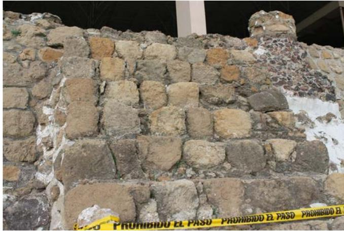
Figura 5. Durante el periodo formativo era fuerte la presencia del tepetate para la edificación de escalinatas, que en algunos casos eran cubiertas con un revestimiento de piedra (crédito: L. Guerrero, 2020)
