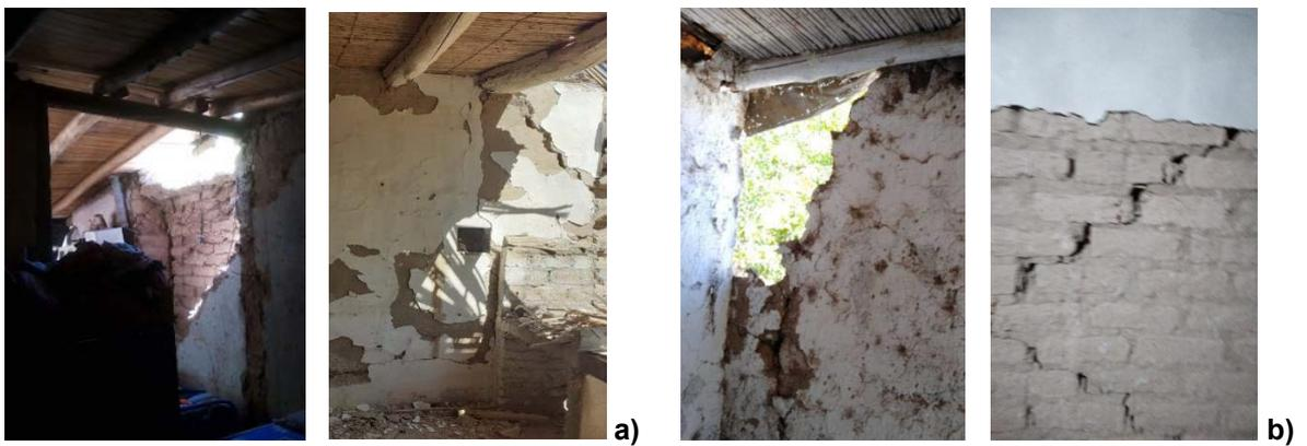
Figura 5. Deformaciones y fisuras de muros. Área Suroeste del Departamento Pocito. a) a 25 km del epicentro del terremoto; b) a 24 km del epicentro del terremoto
