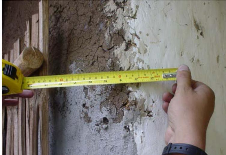
Figura 1. Grietas en los revestimientos de los muros aplicados con mezcla de tierra muy arcillosa sin arena
