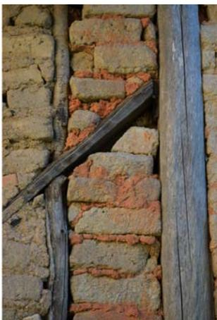
Figura 1. Muro entramado con adobe en Cepeda (Salamanca)
