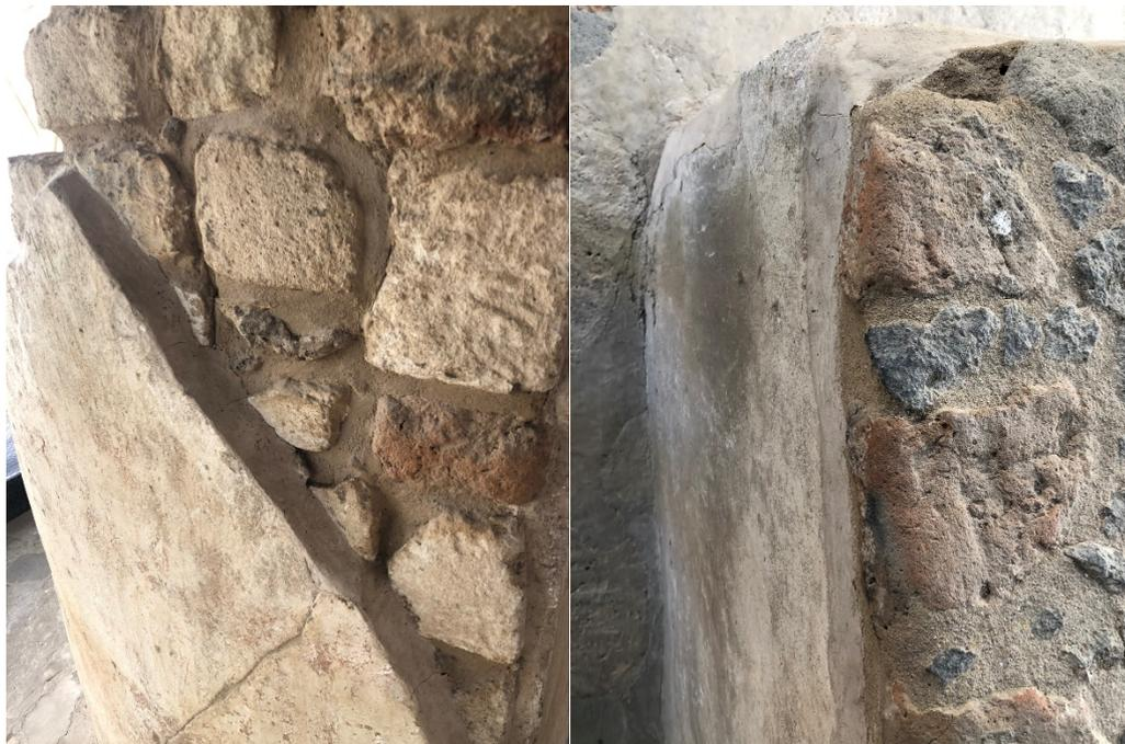
Figura 7. Columnas y altares fueron construidos con pequeños bloques de tepetate y revocados con una capa gruesa de enlucido de cal y arena (crédito: E. Avila, 2019)
