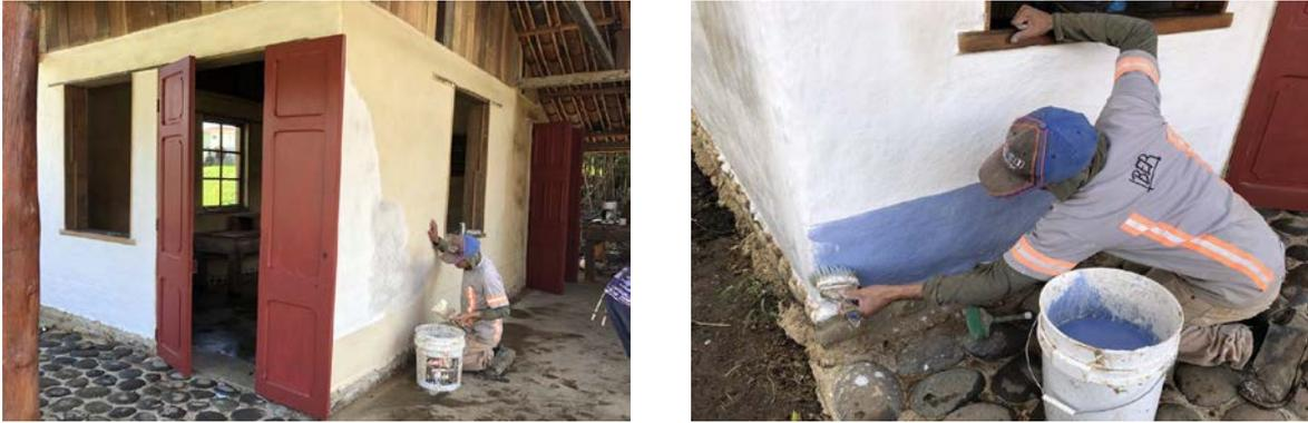
Figura 8. Proceso de encalado luego del secado del revoco final y franja tradicional con pintura de cal
