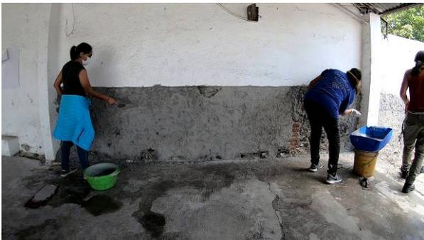
Figura 5. Aplicación de revoque base de cal-arena
