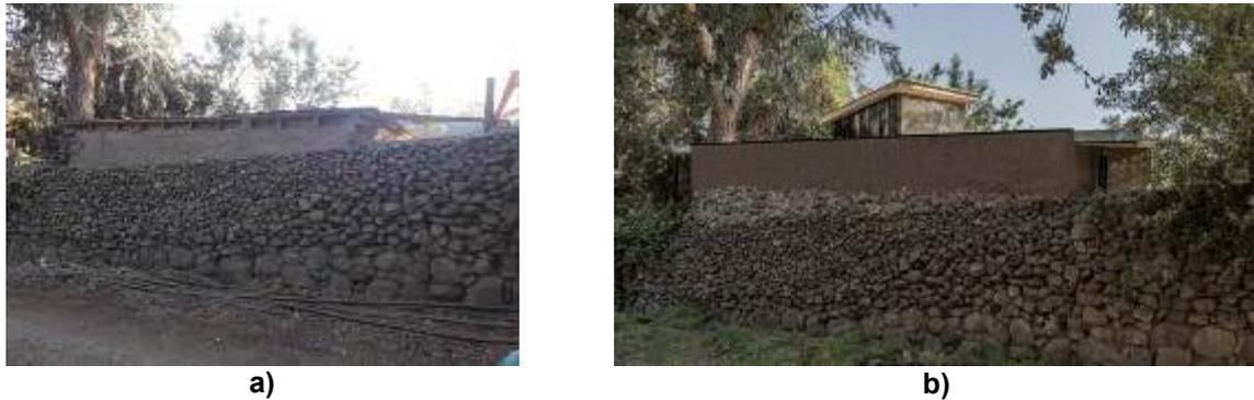
Figura 4: a) pirca desde el exterior, en estado original; b) diseño final de la pirca nivelada y nueva cubierta (crédito: Tomás Munita)
