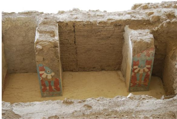
Figura 6. Los adobes, morteros de pega y revestimientos de base que se emplearon en los muros de Cacaxtla se elaboraron con tepetate triturado y posteriormente hidratado (crédito: L. Guerrero, 2020)
