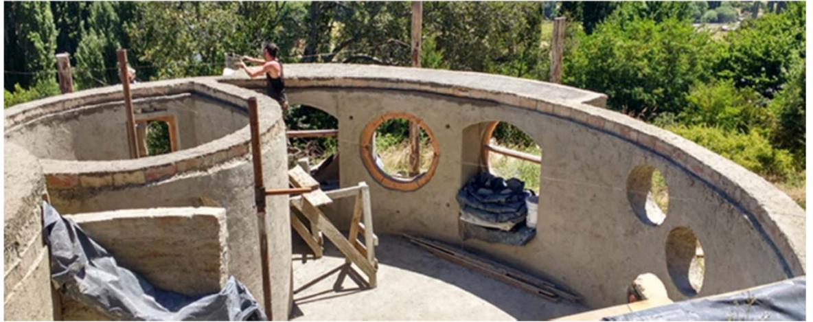
Figura 5. Construcción de paredes curvas con técnica de adobe "enuacalado" | Fuente: "Debarro Arquitectura"
