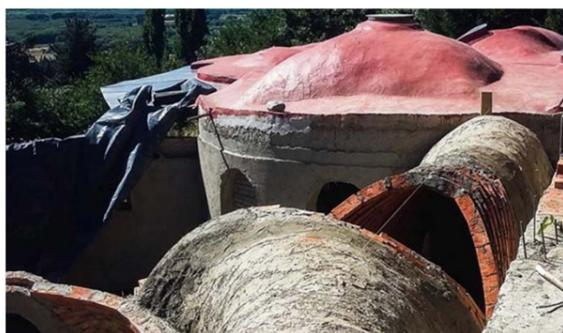
Figura 7. Construcción de techos abovedados sobre pared de adobe "enuacalado" | Fuente: "Debarro Arquitectura"
