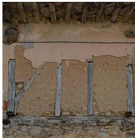
Figura 2. Muro entramado con tapialete en Valdazo (Burgos)
