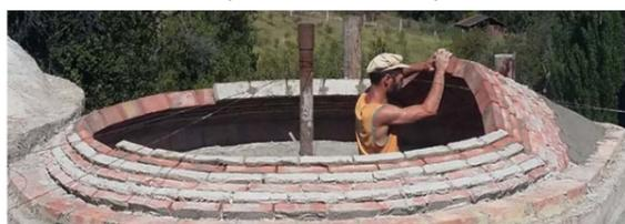
Figura 8. Construcción de una bóveda de adobe e ladrillo sin cimbra | Fuente: "Debarro Arquitectura"
