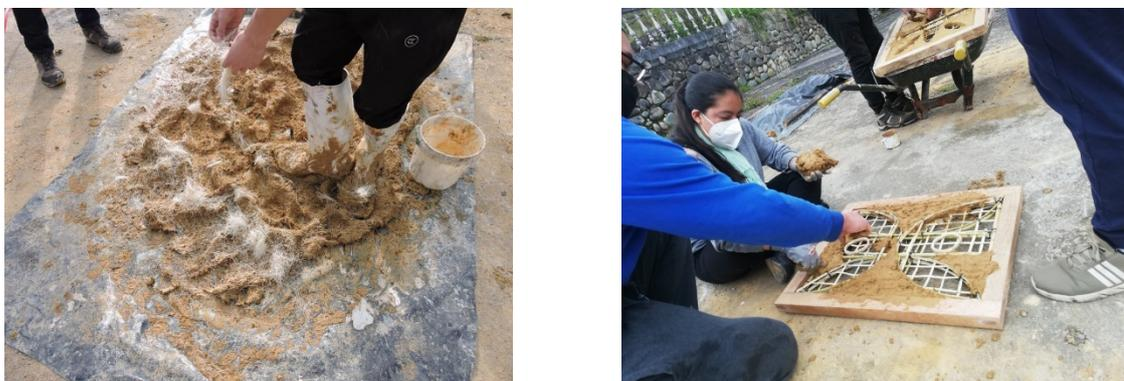
Figura 4. Preparación y colocación del barro (crédito: M. Pesantes 2021)
