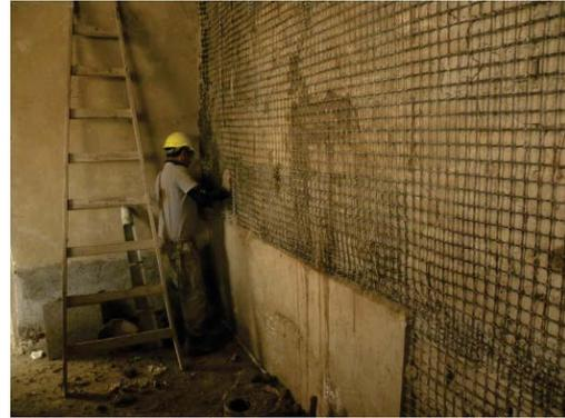
Figura 5. Atando los conectores de la malla
