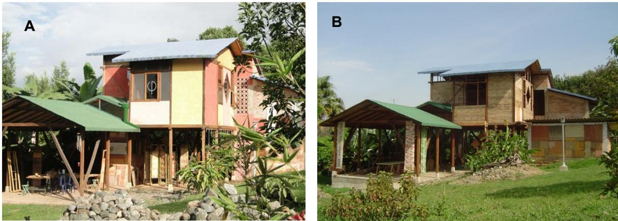
Figura 9. Sede Taller, un lugar para la investigación, experimentación y producción de los ecoacabados desde 2007: A) técnica de construcción mixta con madera y esterilla de guadua; B) uso de los revestimientos con pigmentados terrosos
