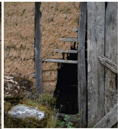
Figura 3. Muro emparrillado en Corullón (León)
