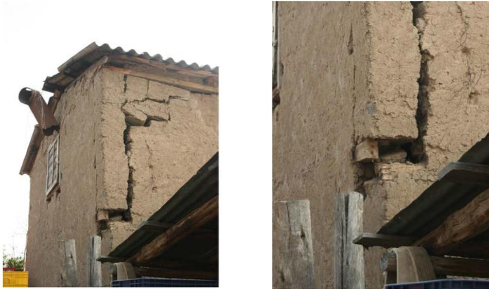
Figura 7. Daño de horno en Panguesillo, asociado al vínculo deficiente entre los elementos de refuerzo horizontales de madera
