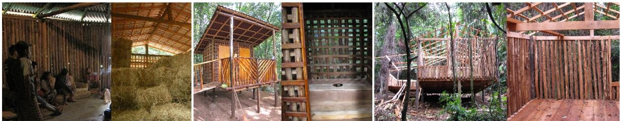
Figura 8. Reprodução do banheiro seco e alteração do espaçamento da estrutura secundária para a aplicação do barreamento com feno, Tekoa Yvy Porã, 2021 (fotos da autora)
