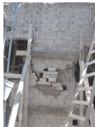
Figura 2. Estado de los muro en planta baja
