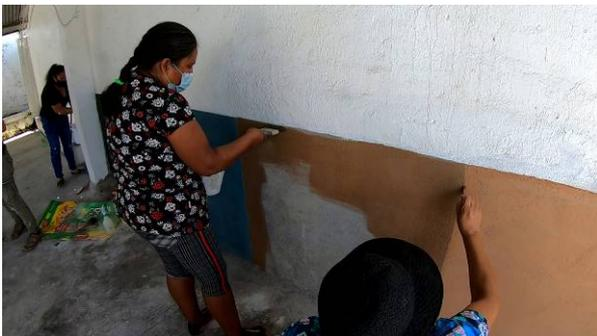
Figura 7. Aplicación de pintura a la cal
