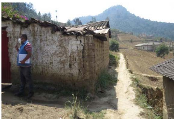
Fig. 4. Vivienda de adobe con grieta en una de sus paredes. Fuente: Méndez, 2020
