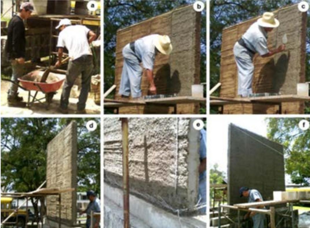
Figura 6. Aplicación de revestimiento primario (crédito: Chic, 2014)
