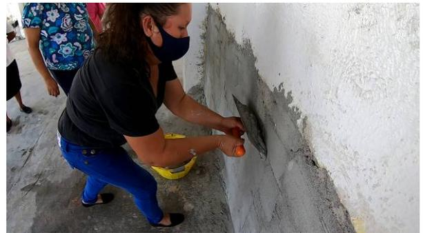
Figura 6. Aplicación de revoque fino de cal-arena
