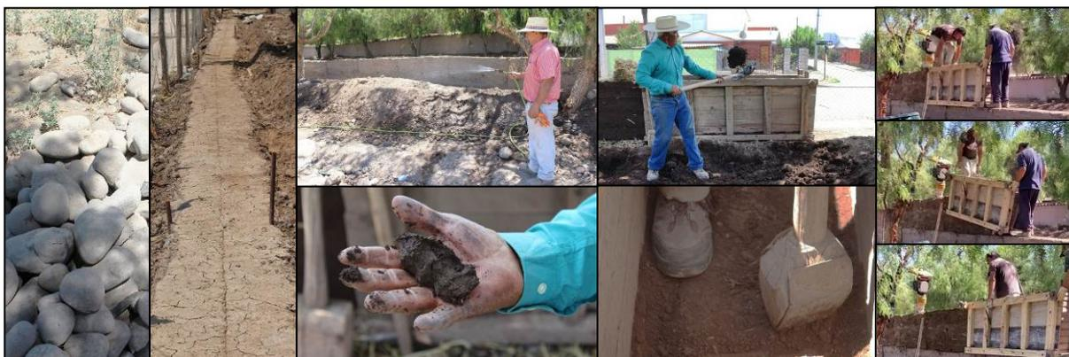
Figura 4. Proceso constructivo de las tapias
