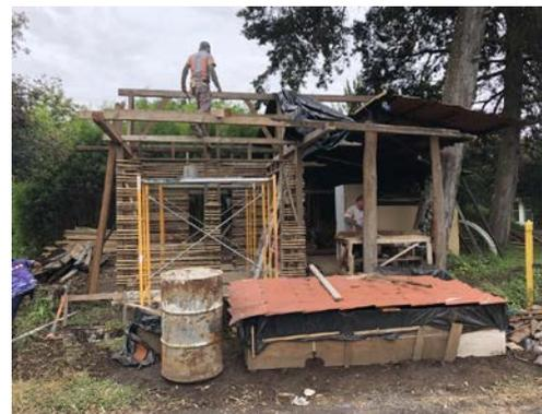
Figura 5. Levantamiento de estructura primaria en madera reciclada
