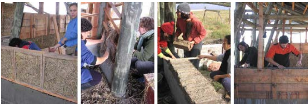
Fig. 1: Técnicas de muros utilizados en el Prototipo: paneles de tierra alivianada, fajina, adobes y tierra alivianada en encofrados – mayo de 2006
