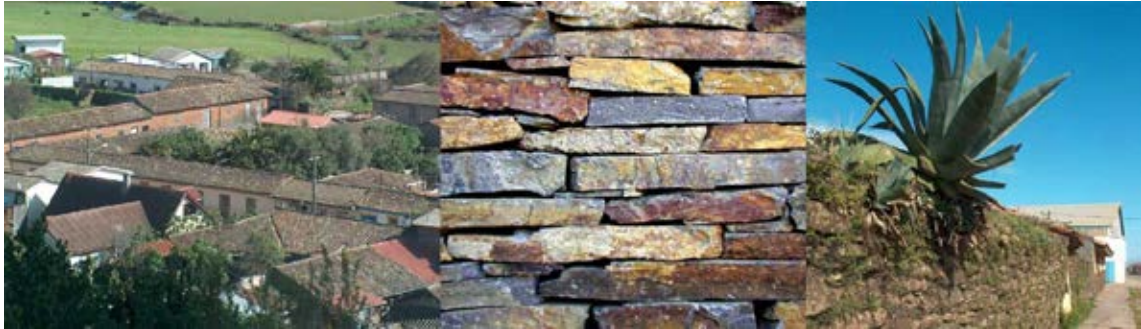
(Fig. 3) Vista desde Cerro El Calvario - Mampostería en Piedra Laja - Muro Jardín
