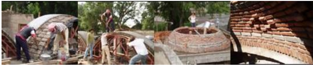
(Fig. 3) Construcción Techos de bóvedas y cúpulas
