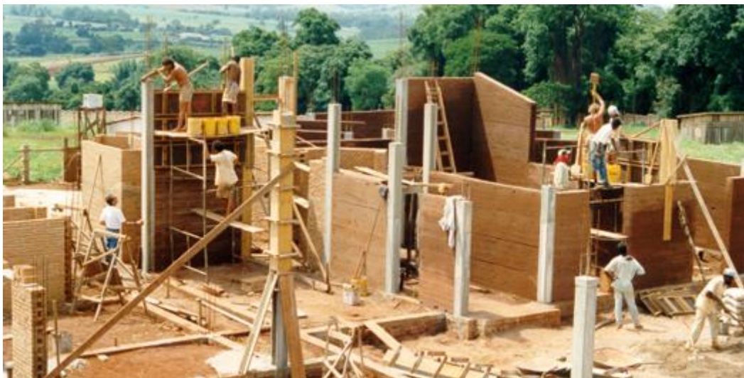
Figura 4 – Vista geral da obra
