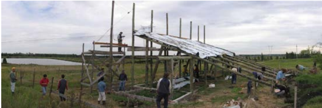
Fig. 3: Avance de la construcción de la etapa 1 (zona de alojamiento) - abril de 2006
