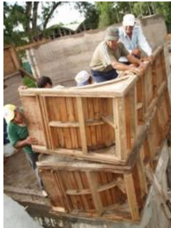
(Fig.4) Ubicación de moldes altura entrepiso
