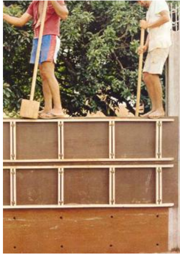
Figura 3 – Compactação do solo-cimento nos moldes
