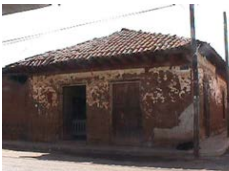
Fig. 11: Vivienda de adobe con techo inclinado a cuatro aguas y cubierta de teja de barro. (Armani, 2002)
