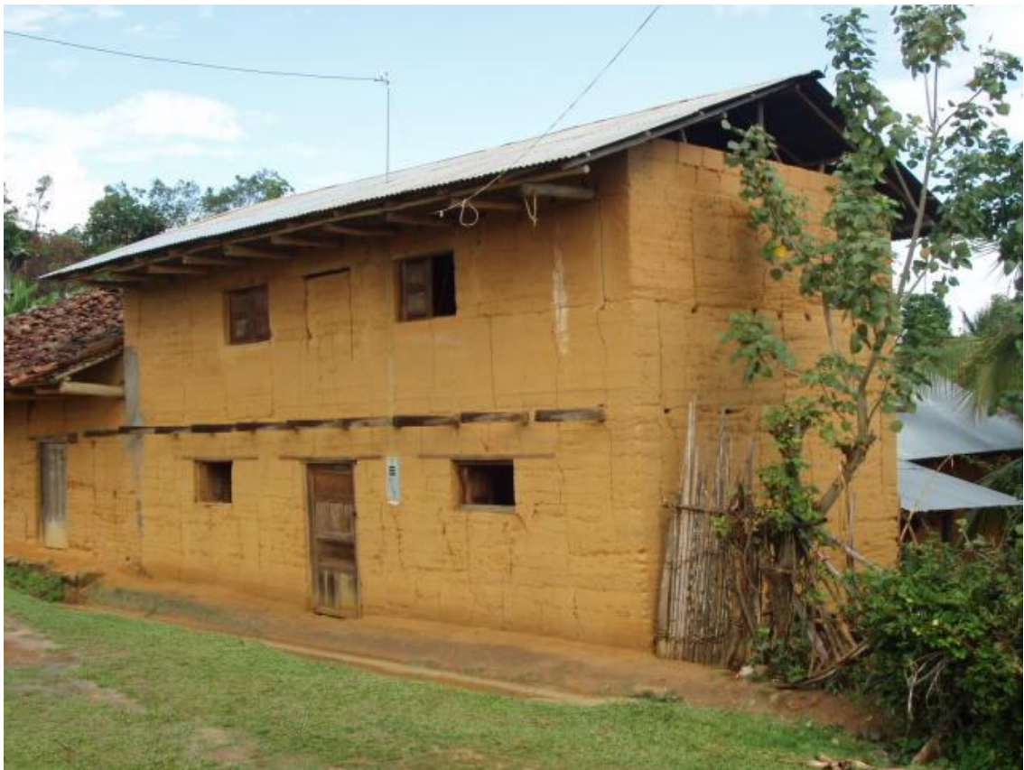
Foto 3. Vivienda de dos pisos cuyo techo original fue cambiado antes del sismo edificado hace más de 30 años y, ubicado en una ladera de Lamas. Nótese que el estado de conservación post sismo es bastante bueno.
