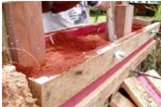
Figura 3: forma e apiloamento de terra na “Casa de Gravura”
