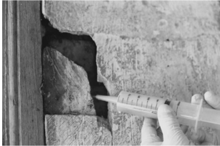
Figura 2: consolidación e higienización de los adobes Fuente: Alexandre Mascarenhas
