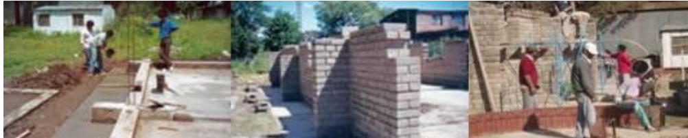
(Fig. 5) Elevación muros de BTC y BaTc-I
