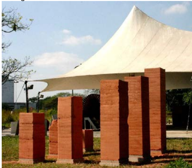
Figura 04 – O produto final do workshop, as colunas de taipa de pilão prontas. Foto: Reginaldo Ronconi.
