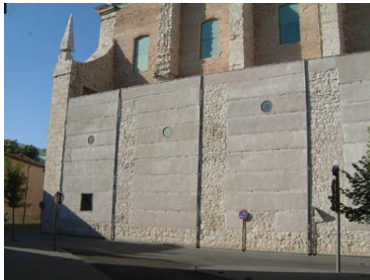
Imagen 2. Lateral de la antigua iglesia de San Agustín restaurada para su utilización como Archivo Municipal de Valladolid. En la imagen se puede apreciar la construcción de esta fachada: zócalo de mampostería, machones de mampostería y tapias entre verdugadas de ladrillo revocados en color gris.
