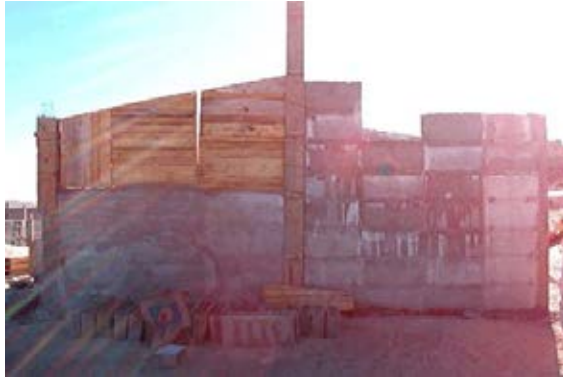
Figura 4. Muro de tarima aplicado en la construcción de una vivienda en Ciudad Juárez, Chihuahua
