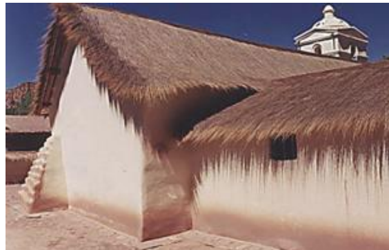
(Fig.4) Cubierta de paja, Iglesia de Susques
