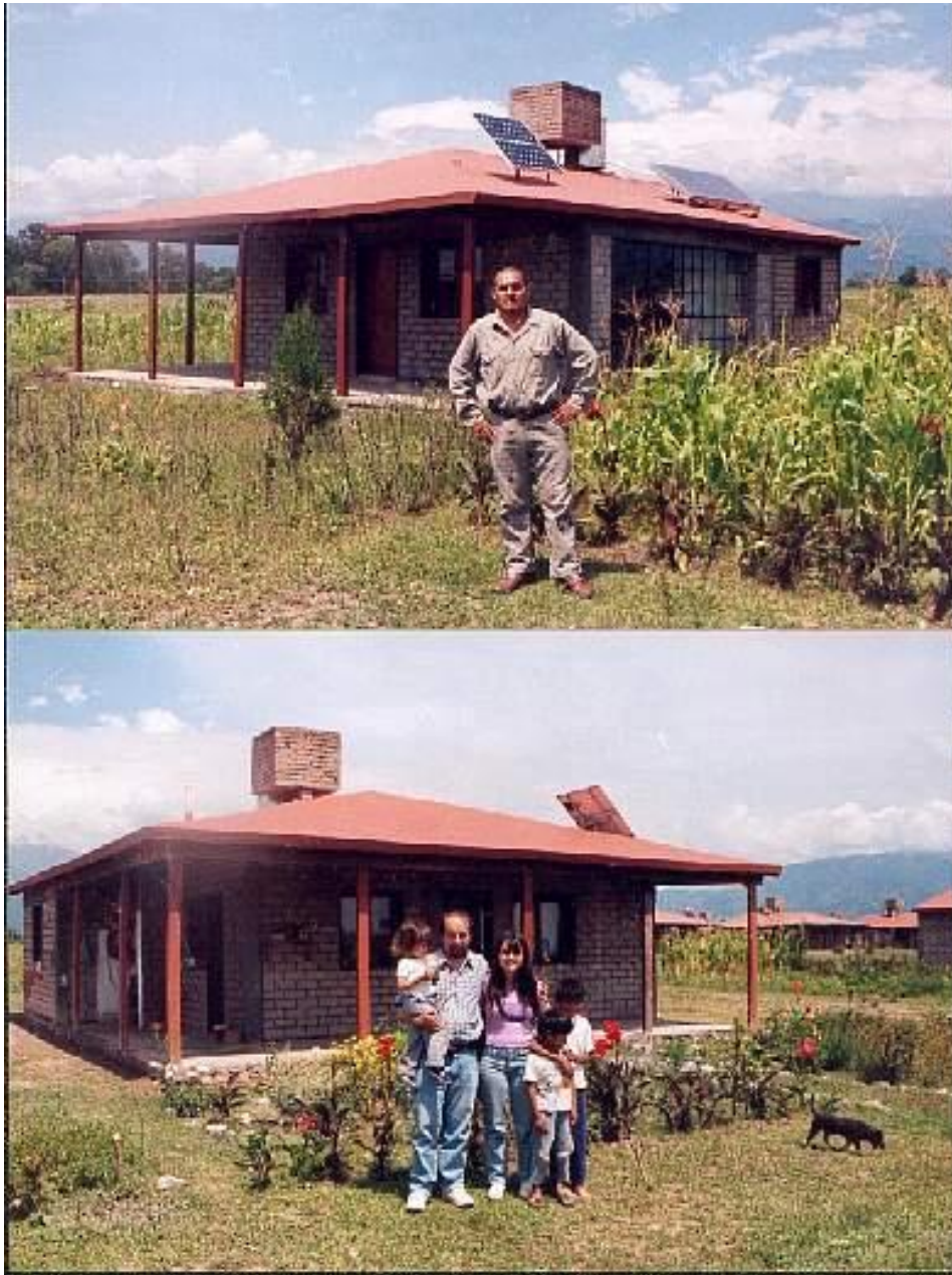
Fig. 2: Vistas de una de las viviendas terminadas (Barrio Ecosol – 1999)
