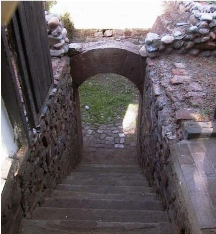
Acceso a la cava.
