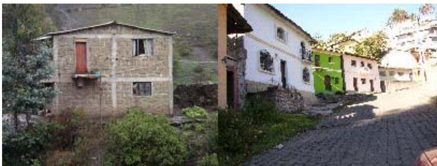
Fig.5: Vivienda auto construida en la zona andina del Ecuador
