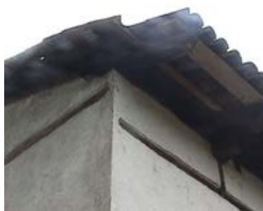
Fig. 8: En edificaciones antiguas de mayor altura y espesor de muros, se observa el empleo de refuerzos horizontales ubicados en forma discontinuos.
