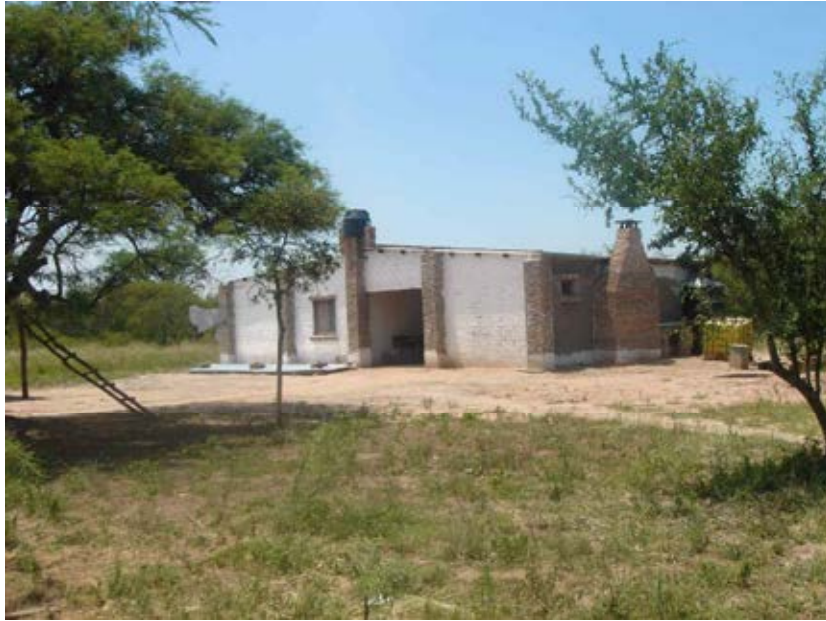
Fig.1 - Una de las viviendas con muros de BTC habitada por una familia integrante de la aldea.
