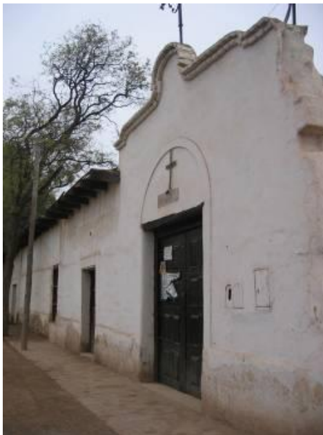
FIGURA N°3- fachada de la casa junto con la capilla, marcada armonía entre ambas, claro ejemplo colonial.
