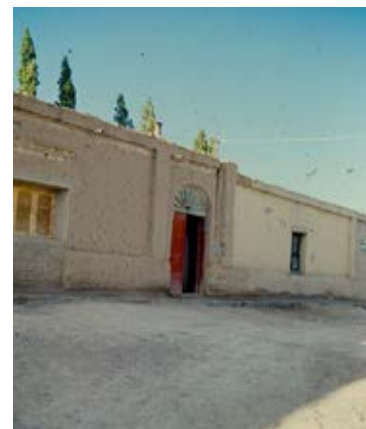
(Fig. 2) Fachada continua en donde se puede observar el acceso principal.
