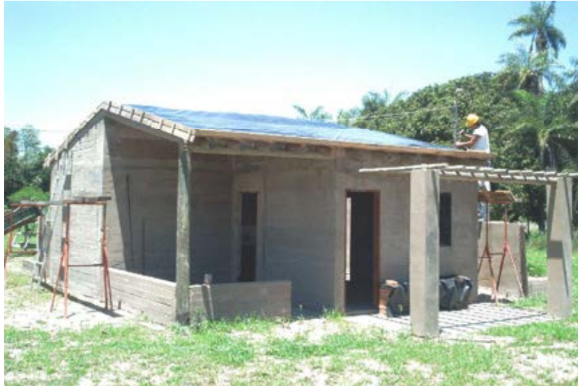
Fig. 4 – Prototipo de suelo-cemento en construcción
