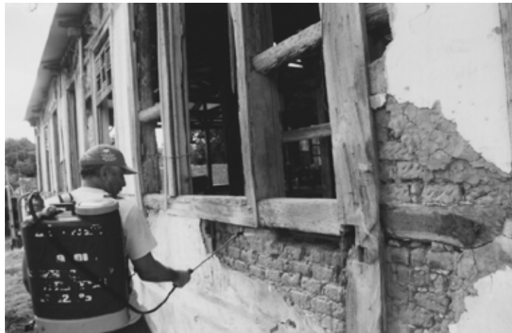
Figura 3: aplicación de Primal AC33 en los adobes Fuente: Alexandre Mascarenhas
