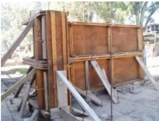
(Fig. 2) Ensamblado de moldes
