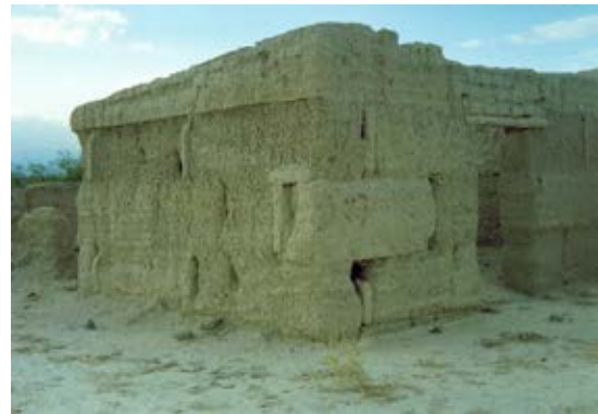
(Fig.1) Sistema constructivo. Combinación tapia- adobe
