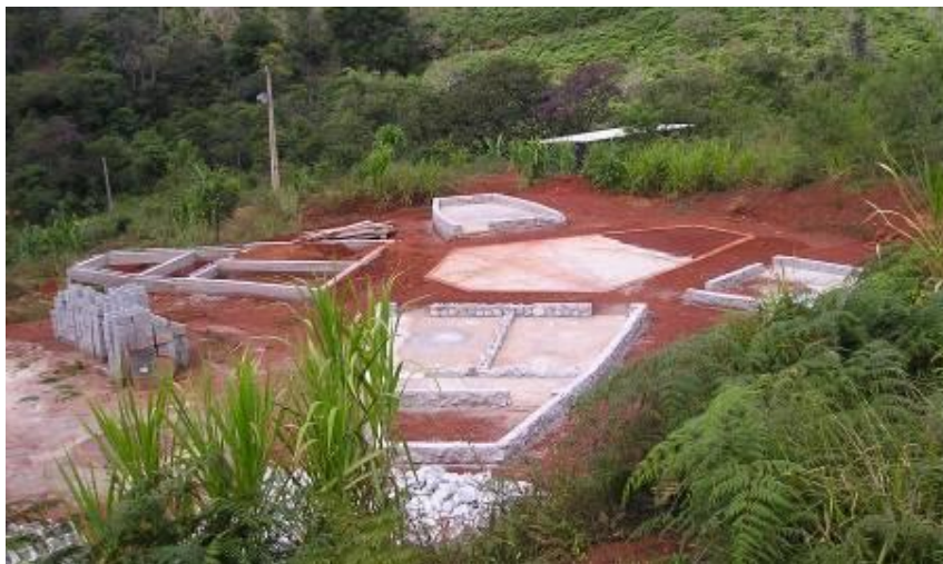
(Fig. 1) Vista geral do perímetro da casa, com os muros de cantaria prontos para receberem os tijolos de solo-cal.
