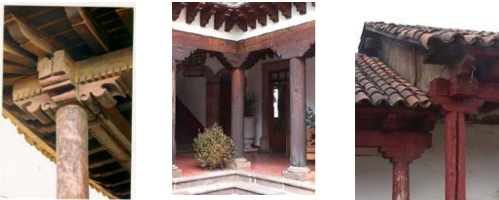
Fig. 6: Detalle de columnas y viguerías de madera de pórticos y galerías. (Armani, 2000)
