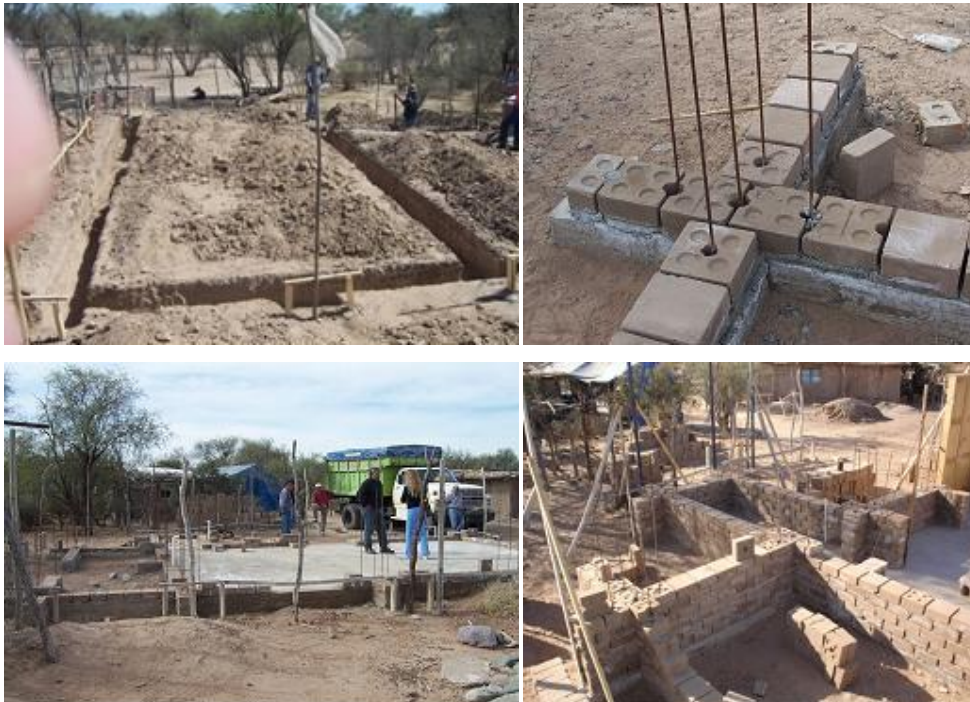
Fig 2 Imágenes del Proceso Constructivo
