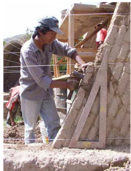
Angulo de inclinación bóveda núbica
