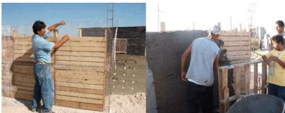
Figura 3. Aplicación del sistemas autoconstructivo para muro de tarima
