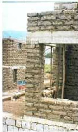
Fig.13: Nótese la esquina de 30 x 30 ¿resistirá a empuje lateral?
