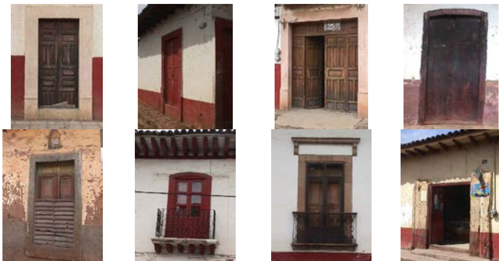
Fig. 13: Mosaico de imágenes de aberturas en viviendas de adobe de la región de estudio. Los marcos en piedra se emplean para proporcionar mayor jerarquía a la vivienda, generalmente éstas se encuentran en los centros de población. (Armani, 2002)
