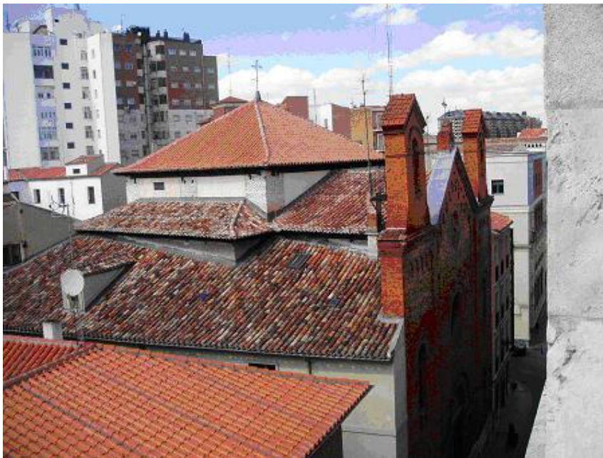
Fig. 1.- Vista exterior de la Iglesia de Jesús Nazareno y de la casa de Hermandad anexionada contra el lado del Evangelio. Emerge la cubierta de la cúpula del crucero y se observa la nueva fachada de ladrillo construida después del corte que se dio a la nave principal como consecuencia de la nueva alineación de la calle.
