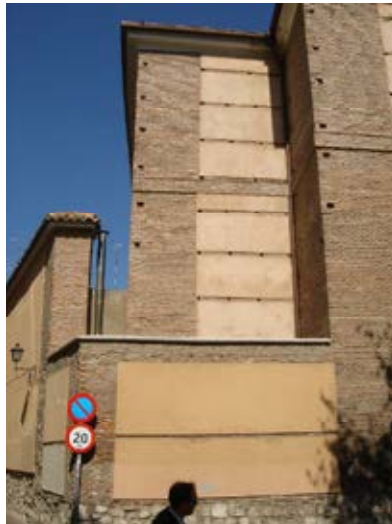
Imagen 3. Muros del convento de San Quirce con zócalo de mampostería, machones y verdugadas de ladrillo y tapias revocadas.
