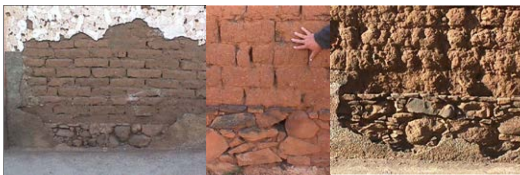
Fig. 5: Sistema de construcción tradicional de los sobrecimientos de piedra volcánica que varían entre los 30 y 50 cm. (Armani, 2002)
