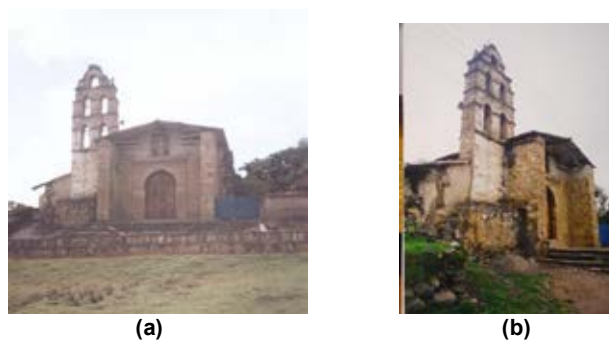
Fig. 2. (a) y (b) Fachada actual de la iglesia de Tausa
