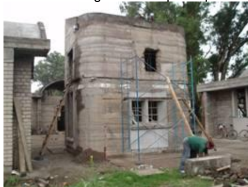
(Fig.1) Vista general de torre de servicios
