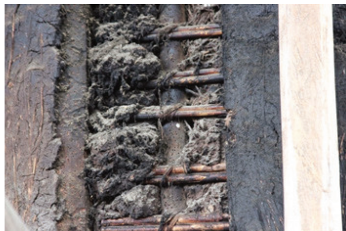
Fig 4. Estructuras de bahareque de los muros de la Quinta San José Autor: Fausto Cardoso, 2021
