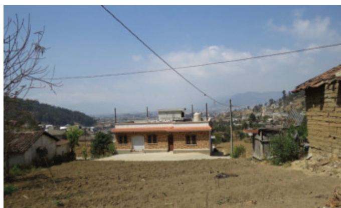
Fig. 1 Impacto de la arquitectura de remesas en la Aldea Paxtocá, Totonicapán, Guatemala. Autor: Moisés Méndez (2021)
