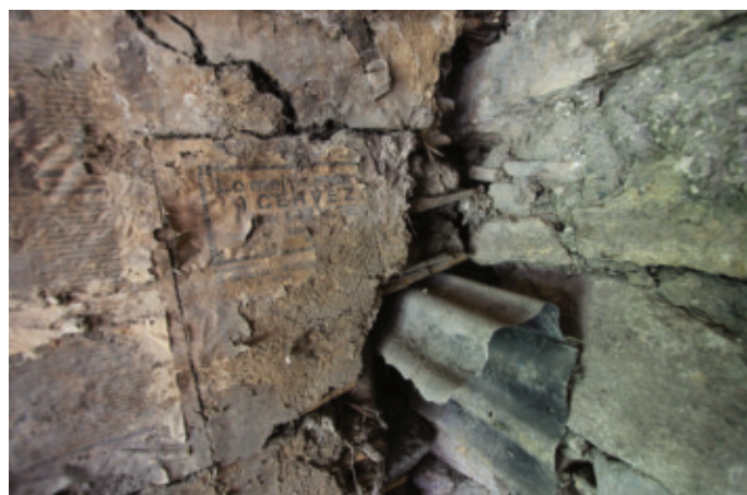
Fig 3. Revestimiento de muros de la Quinta San José Autor: Fausto Cardoso, 2021
