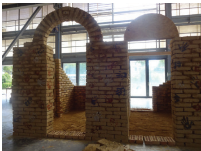
Fig 5.- Construcción del prototipo “Orejas/J03”. Ejecución de los arcos de adobe y apoyo de la cimbra de madera en los muros. Estado intermedio. Autora: Eva García Baños
