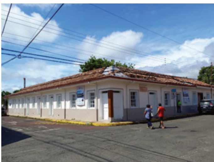
Fig.1.- Edificación privada de adobe y bajareque en restauración. Liberia, Costa Rica. Autora: Magda Castellano
