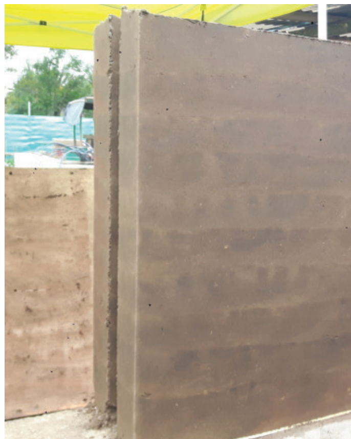
Fig 2. Muro interior, sin calicostrar Autor: Patricio Cevallos
