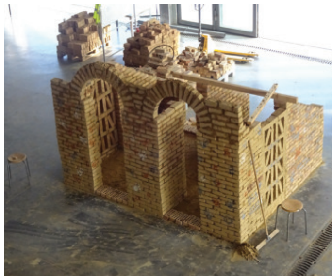
Fig 5.- Construcción del prototipo “Orejas/J03”. Imagen general del proceso constructivo en el que se aprecian las celosías de ventilación en las fachadas laterales. Autora: Angele keserwany
