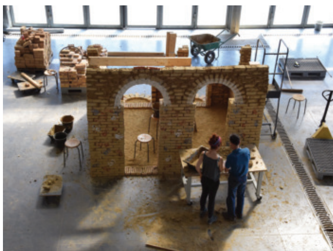
Fig 3.- Construcción del prototipo “Orejas/J03”. Análisis, replanteo y construcción del forjado de madera. Autora: Audrey Carbonnelle
