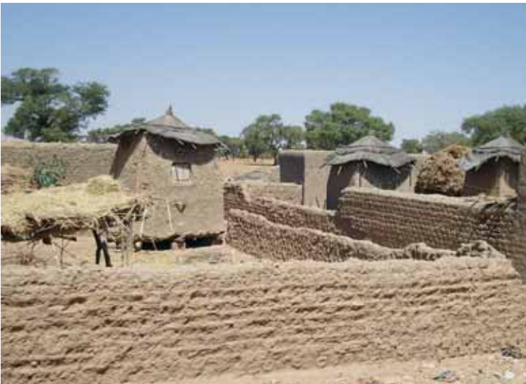
Los techos de fibras mantienen estable la temperatura y humedad al interior de los graneros. Sevaré, Mali.
