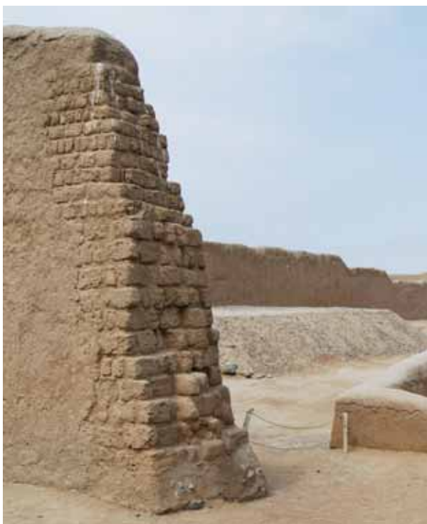
En la construcción de Chan Chan, Perú, de hace más de 1000 años, no se emplearon fibras para reforzar los adobes sino grava y piedras de hasta 4 o 5cm de diámetro.
