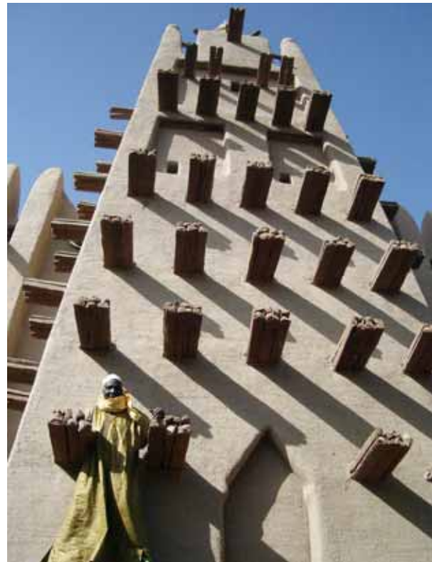
Andamiaje fijo de las fachadas para darles mantenimiento. Mezquita de Mopti, Mali.
