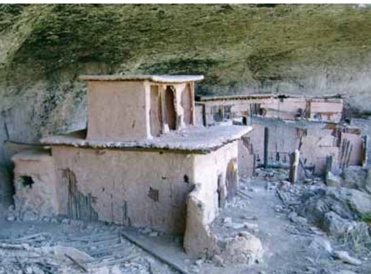
Las Casas en Acantilado de la Cueva del Maguey en Durango, tienen sistemas prehispánicos de techos en los que los morillos soportan una cama de rajás de troncos sobre la que se asienta el lodo que conformaba entrepisos y techos.
