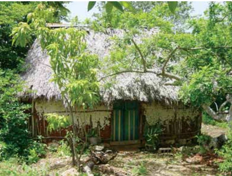
Una lechada delgada de cal garantiza la protección de muros y revoques de tierra por varias décadas. Ek' Balam, Yucatán.
