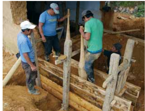
En la construcción tradicional de muros de tapia, la tierra requiere la presencia de áridos que propicien la densificación. El exceso de arcilla dificulta compactar al incrementarse la humedad del sistema. Chuquiribamba, Ecuador.
