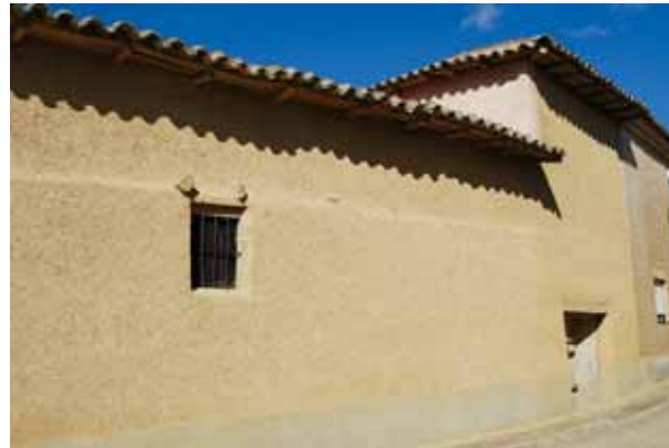
En Cuenca de Campos, España, se utiliza gran cantidad de paja de trigo finamente picada para estabilizar revoques que puedan conservarse a la intemperie, a pesar de las extremas condiciones climáticas regionales.
