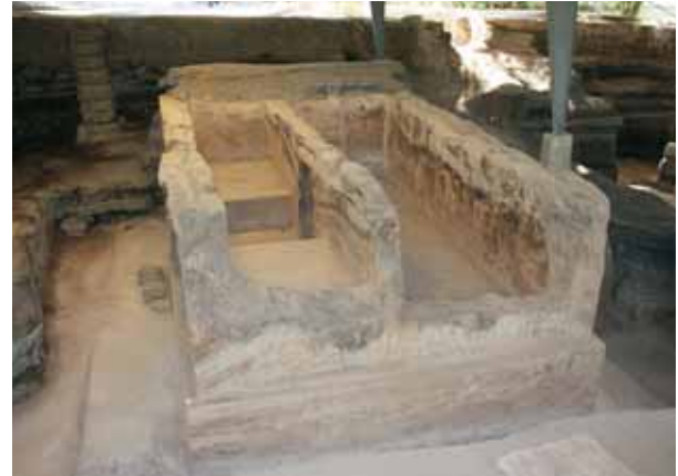
En las ruinas de Joya de Cerén, El Salvador, diversos muros parecen ser de tapia pero sus núcleos presentan fisuras, grumos y vacíos que evidencian que originalmente la mezcla estaba demasiado húmeda como para ser compactada, por lo que es más probable que se hubiera edificado con la técnica de tierra amasada.
