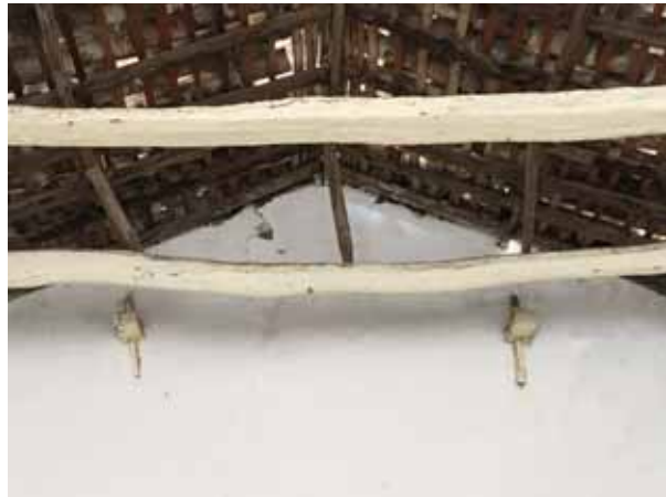
Los pasadores de madera que atraviesan las cabezas de las vigas de arriba hacia abajo, limitan el posible movimiento de los muros en caso de sismo, sin rigidizar al sistema constructivo. Tepeacoacuilco, Guerrero.
