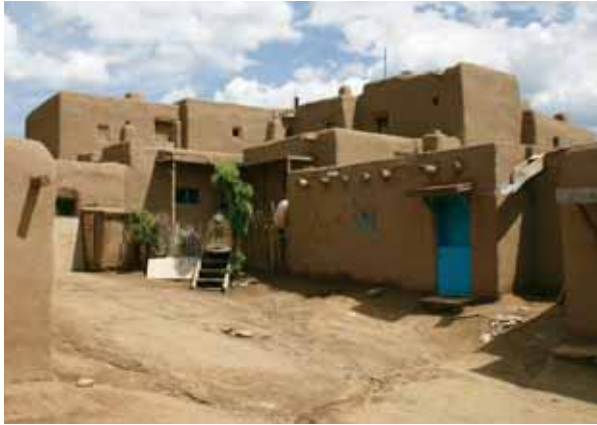
En la arquitectura indígena del suroeste de Estados Unidos se acostumbra dejar expuestos los cabezales de los morillos que soportan el terrado de los techos. Taos, Nuevo México.
