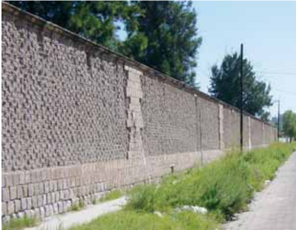
Los dentellones de los refuerzos de piedra se intercalan en las hiladas de los adobes para evitar fallas verticales. Centro Cultural Bicentenario, Durango.
