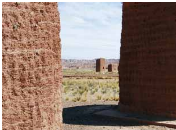
Los monumentos funerarios prehispánicos llamados chullpas , se construyeron mediante capas superpuestas de cúmulos de tierra arcillosa y la paja del pasto andino llamado ichu . Chacarilla, Bolivia.
