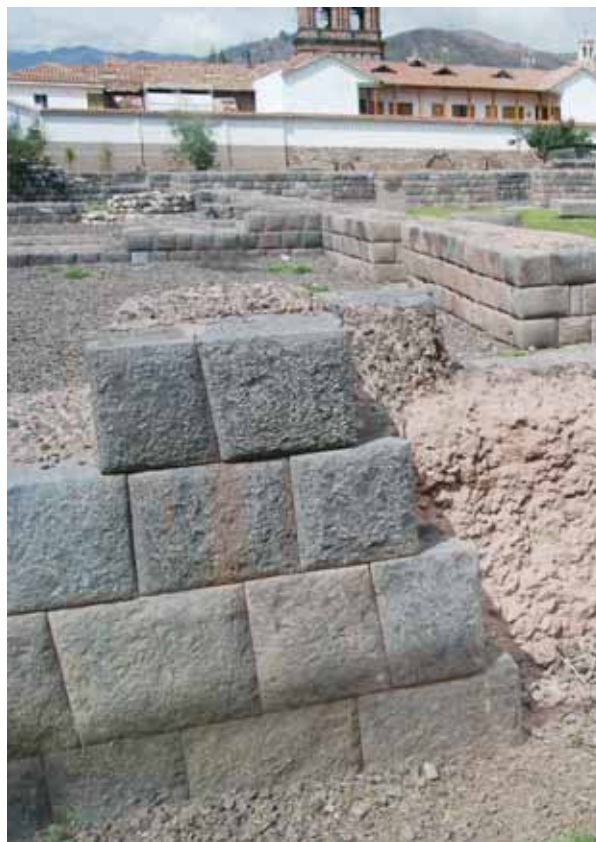
Parte del éxito de los sorprendentes aparejos de piedra de origen inca deviene del uso de la tierra como soporte estructural del núcleo de los muros. Cusco, Perú.
