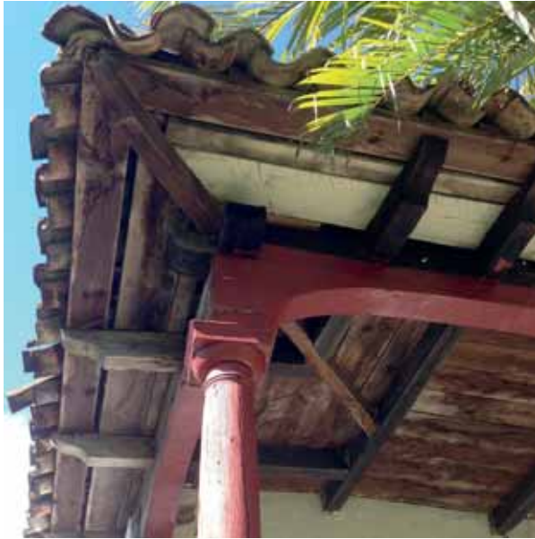
Columnas de madera del pórtico de una hacienda en Comitán, Chiapas.
