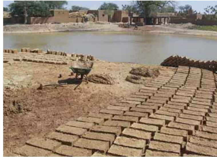
Se acostumbra dejar reposar la tierra humedecida durante varios días, antes de hacer adobes. Mopti, Mali.
