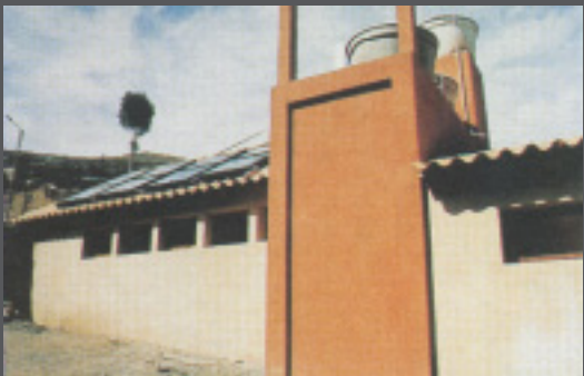
Lavanderías y servicios higiénicos construidos con adobe en Potosí, Bolivia
