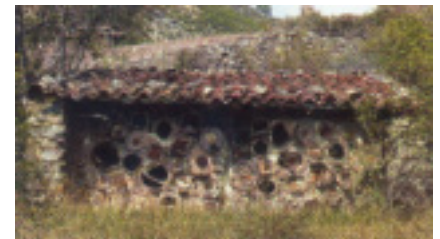
Casa en la Comunidad de Madrid (Foto superior) Casa en la Comunidad de Madrid (Foto intermedia) Colmenar en La Rioja (Foto inferior)
