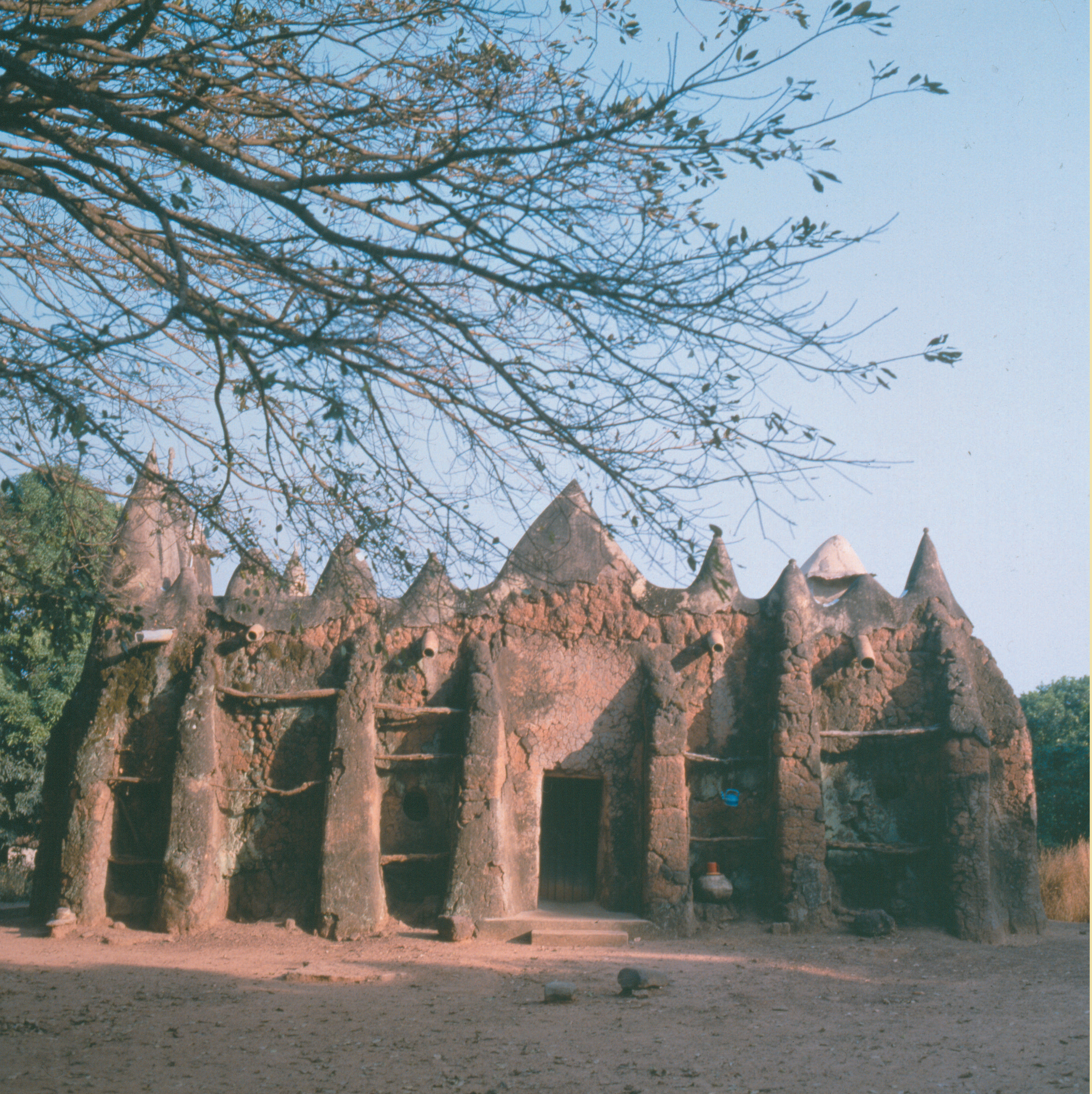
MEZQUITA DE TIPO SAHELO - SOUNDANAIS DE LA CIUDAD DE MAHANDIANA CONSTRUIDO EN ADOBE Y TAPIA PISADA
