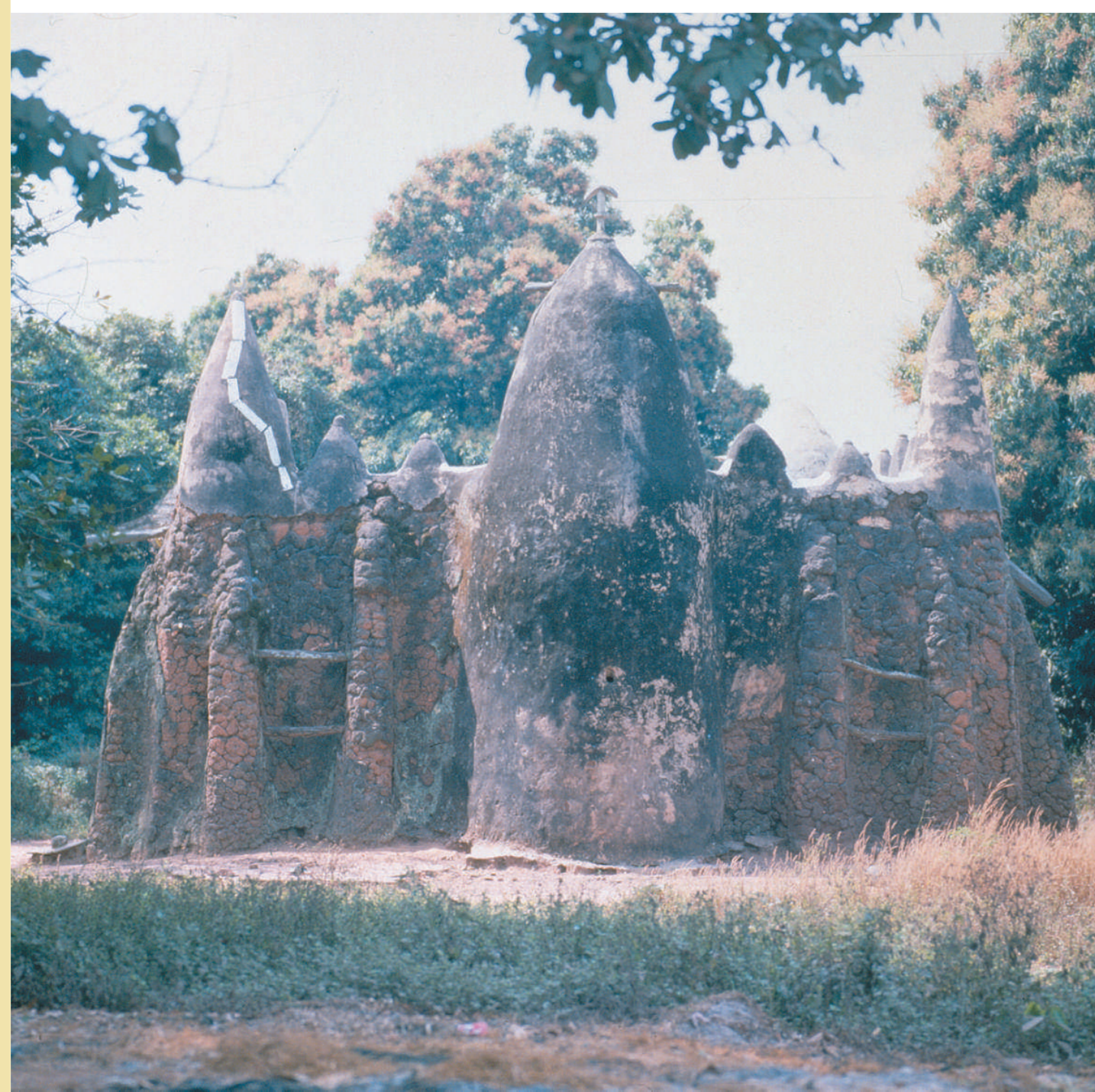
Mezquita de tipo Sahelo- soudanais de la Ciudad de Borón construida completamente en adobe
