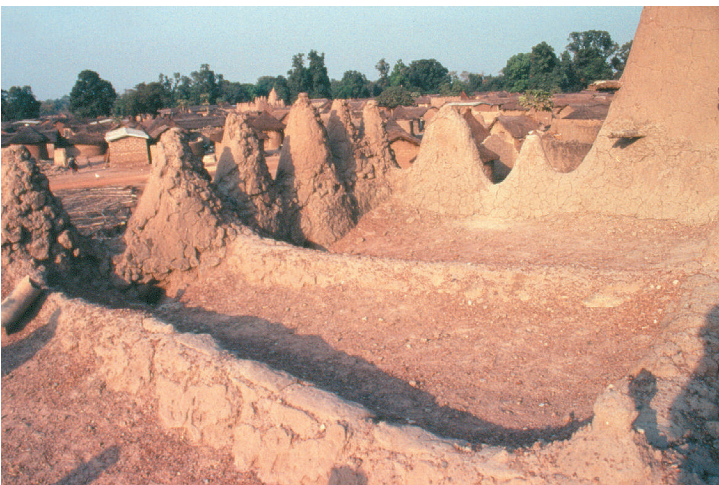
Detalle de la construcción en tierra en donde se destacan los Minarettes
