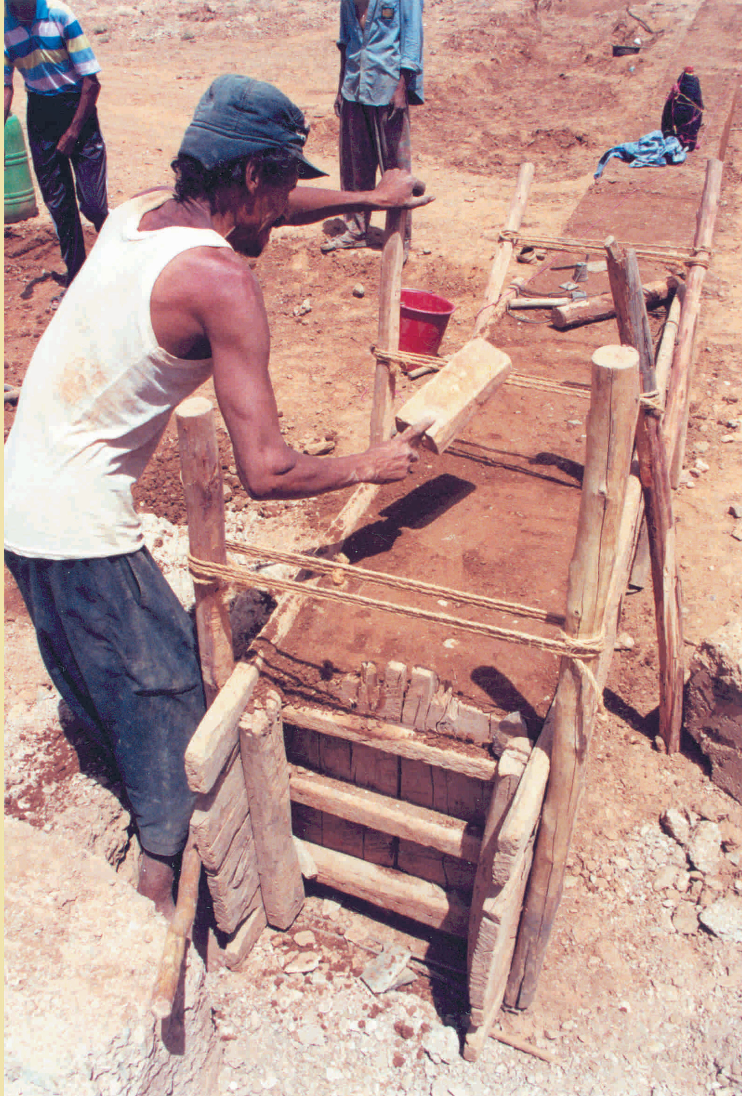
Construcción de un muro de tapial en la región de Tafraoute
