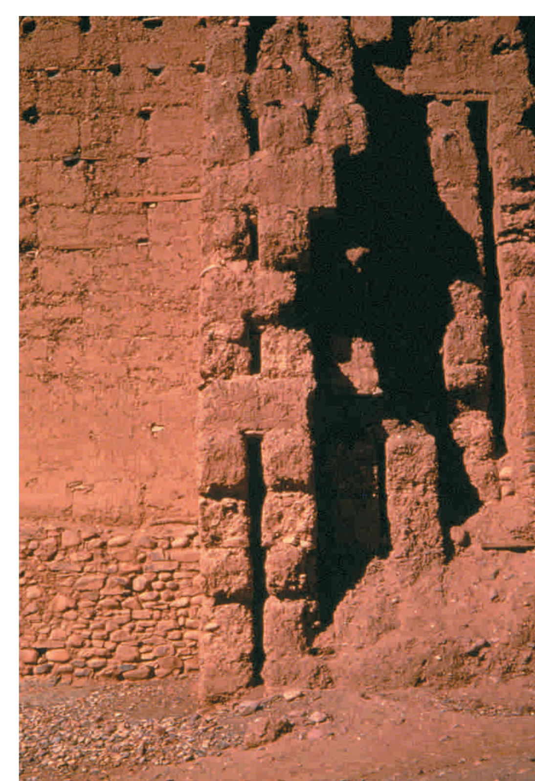
Fábrica de sogas y tizón en el interior de una torre
