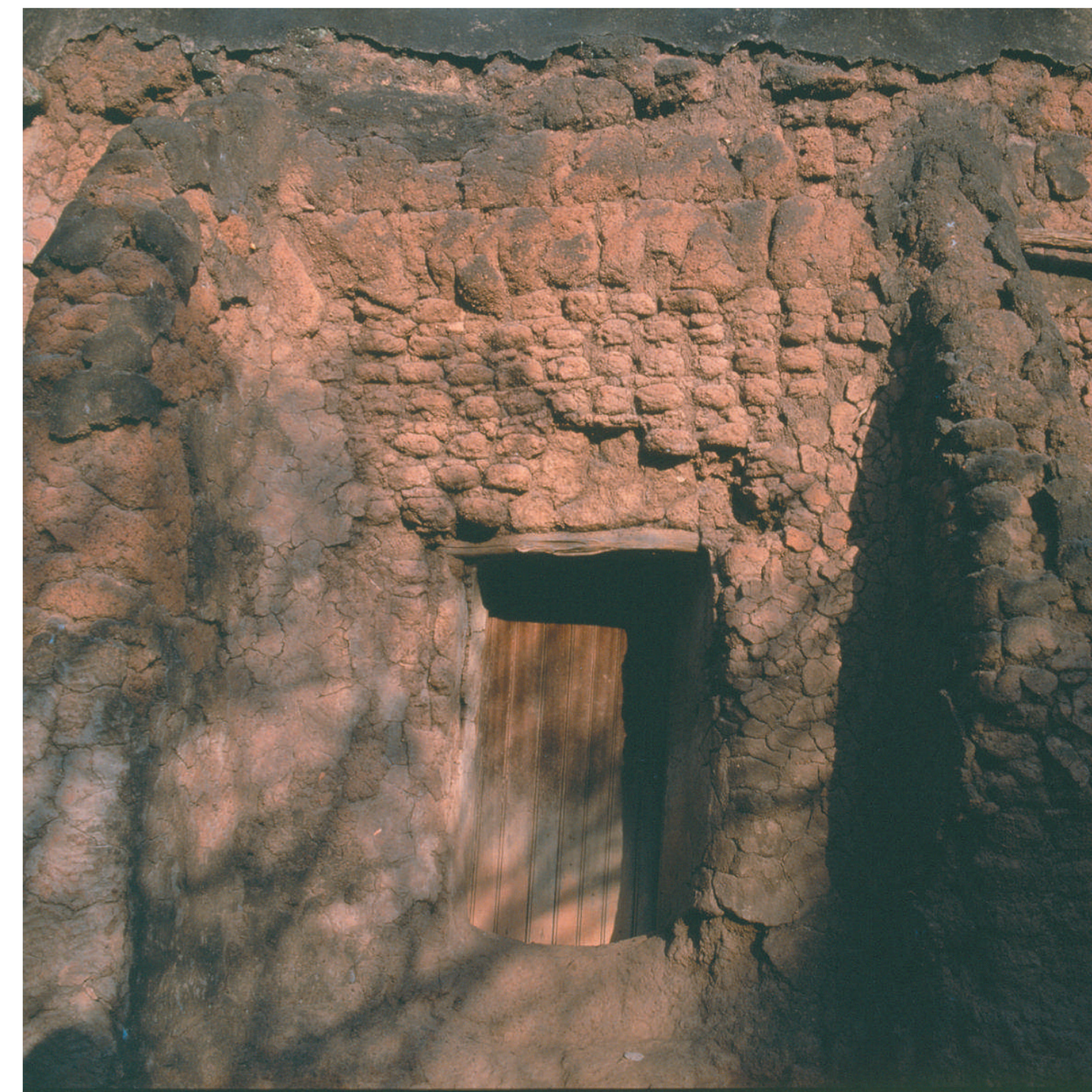
Mezquita de tipo Sahelo- soudanais de la Ciudad de Borón construida completamente en adobe
