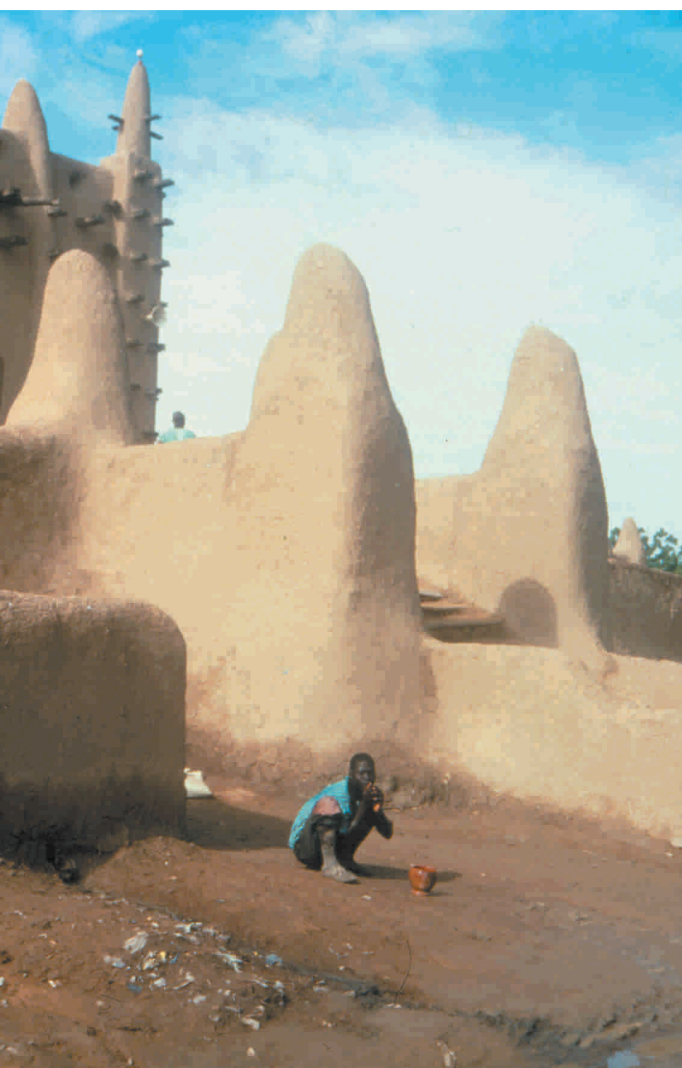
Detalle de pináculos junto a las escaleras de acceso
