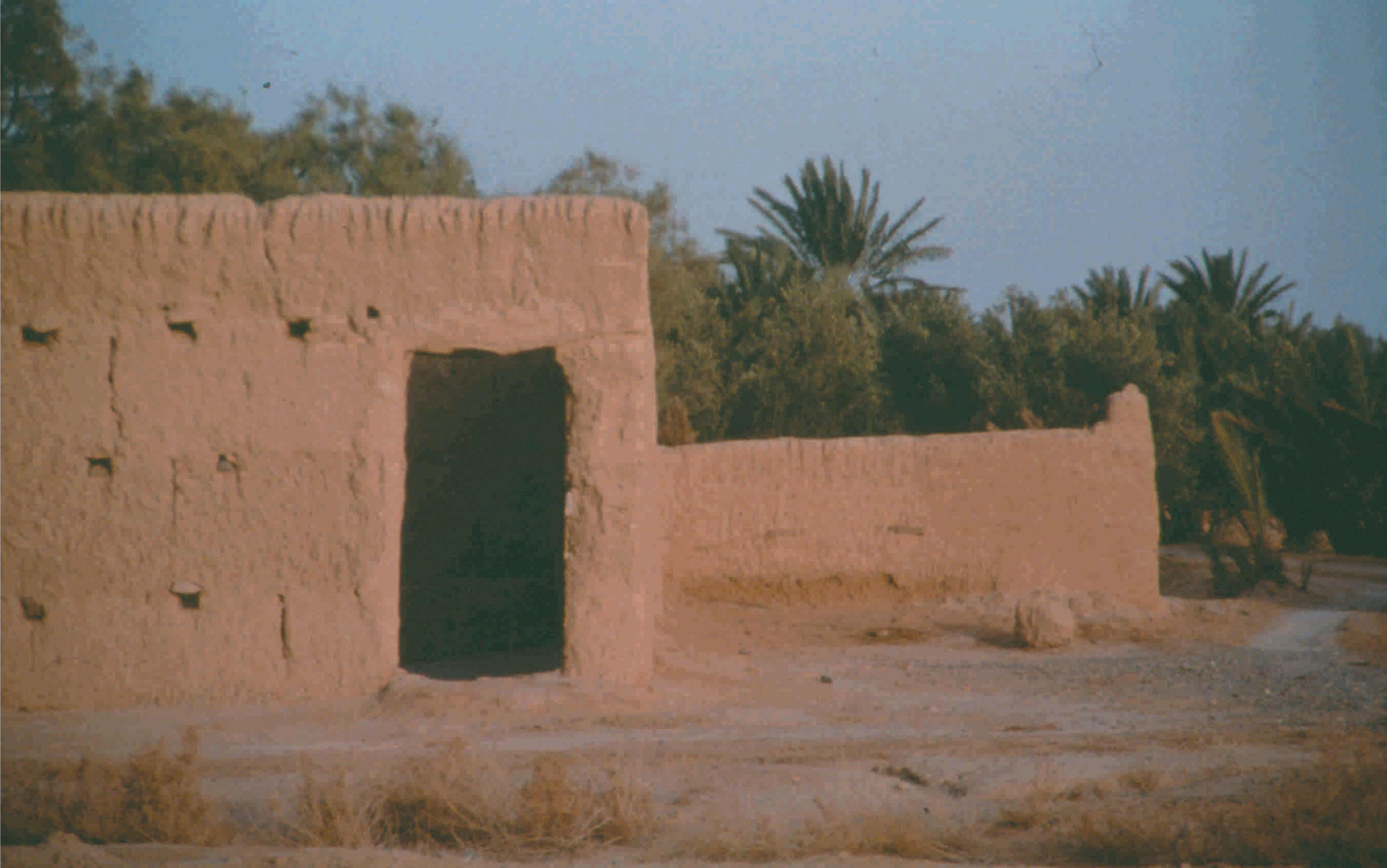
Muro de tapia en Rissani
